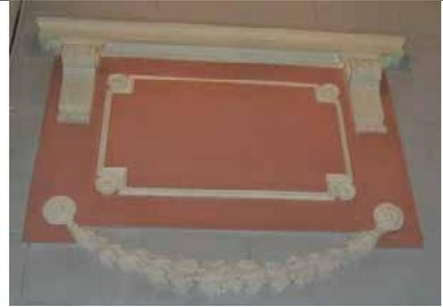
оформление стен лестничной клетки в уровне 3-го этажа - штукатурные зеркала с вынутыми углами с розетками в профилированных рамах, с лопатками между ними, оформленными фигурными филенками; горизонтальные профилированные тяги и раскрепованный профилированный карниз;
