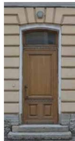
исторические заполнения дверных проемов – конфигурация и конструкция (одностворчатые, глухие, с остекленной фрамугой с лучковым завершением), материал (дерево), оформление (фигарейные филенки в профилированных рамах: по две внизу и по одной в верхней части; разделены горизонтальной вставкой с резным поясом орнамента гильош с розетками; между дверным полотном и фрамугой – резной фриз с поясом орнамента «Волна Витрувия»);
