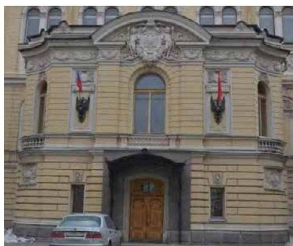
цоколя – гранитные плиты с выколоткой, с профилированным лепным карнизом с валиком в завершении; материал и характер отделки фасада – окрашенная штукатурка (линейный и квадратный русты, гладкая);
