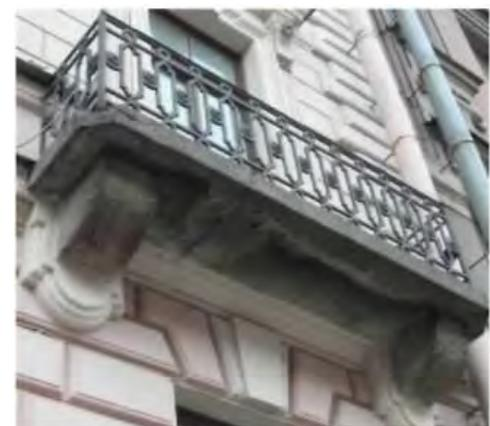
балконы с гранитной плитой на гранитных кронштейнах и пристенной частью полуциркульного завершения – количество (два), габариты, местоположение, ограждение – материал (металл), техника исполнения (литье), рисунок (фигурные секции с розетками);
