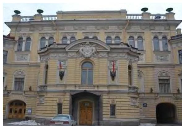
материал и характер отделки цоколя – гранитные плиты с профилированным лепным карнизом с валиком в завершении, известняк (воротный проезд);
