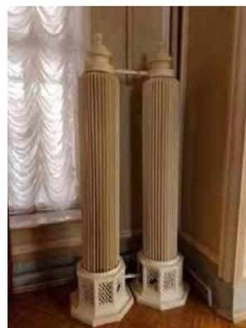
4 ед., обогревательные приборы, настенные, подвесные: корпус круглого сечения, состоит из пластин металлических, радиально расположенных. Подвешены на металлических крюках. Чугуннолитейный и механический завод Ф.К.Сан-Галли.
