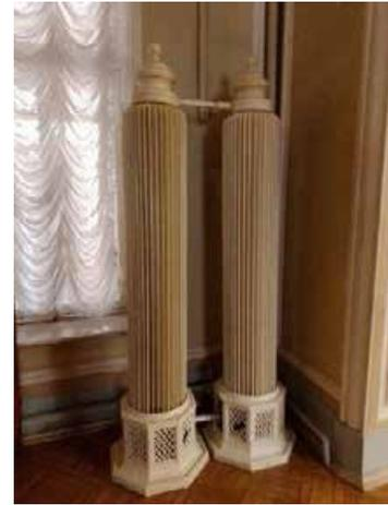
4 ед., обогревательные приборы, настенные, подвесные: корпус круглого сечения, состоит из пластин металлических, радиально расположенных. Подвешены на металлических крюках. Чугуннолитейный и механический завод Ф.К.Сан-Галли.
