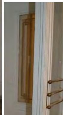
с закругленными углами, декорированными узкими вертикальными филенчатыми лопатками, с нащельником с каннелюрами, тамбур завершен тягой, гладким фризом и профилированным карнизом;
