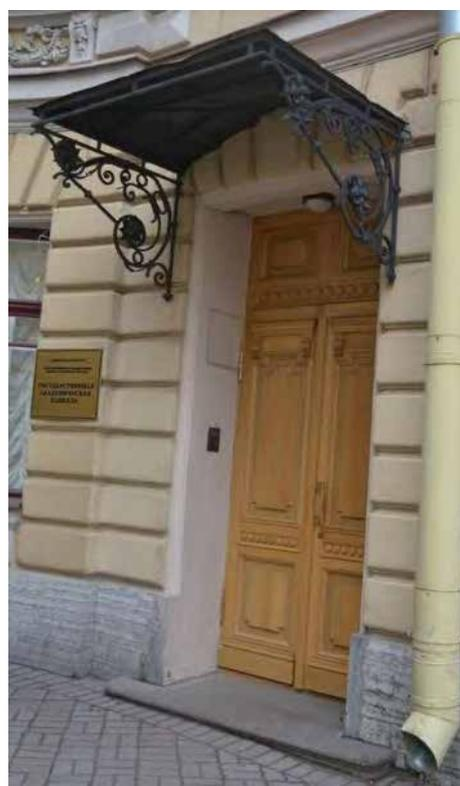
исторический дверной проем южного крыла – местоположение (в юго-западном углу), конфигурация (с лучковым завершением), габариты, оформление (всерный руст, гранитная ступень с закругленными углами – перед входом);
