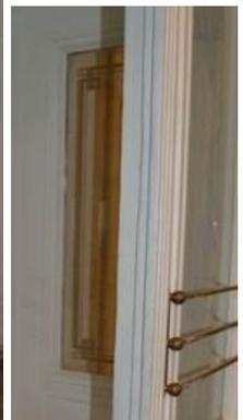
с закругленными углами, декорированными узкими вертикальными филенчатыми лопатками, с нащельником с каннелюрами, тамбур завершен тягой, гладким фризом и профилированным карнизом;
