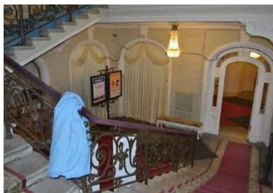
оформление стен – с разделкой уплощенным линейным и квадратным рустом, в завершении – гладкий фриз, горизонтальный пояс с выносом, оформленный профилированными тягами;
