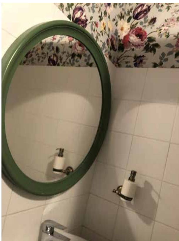
Фото 15. Санузел (помещение № 3 (1-Н))
