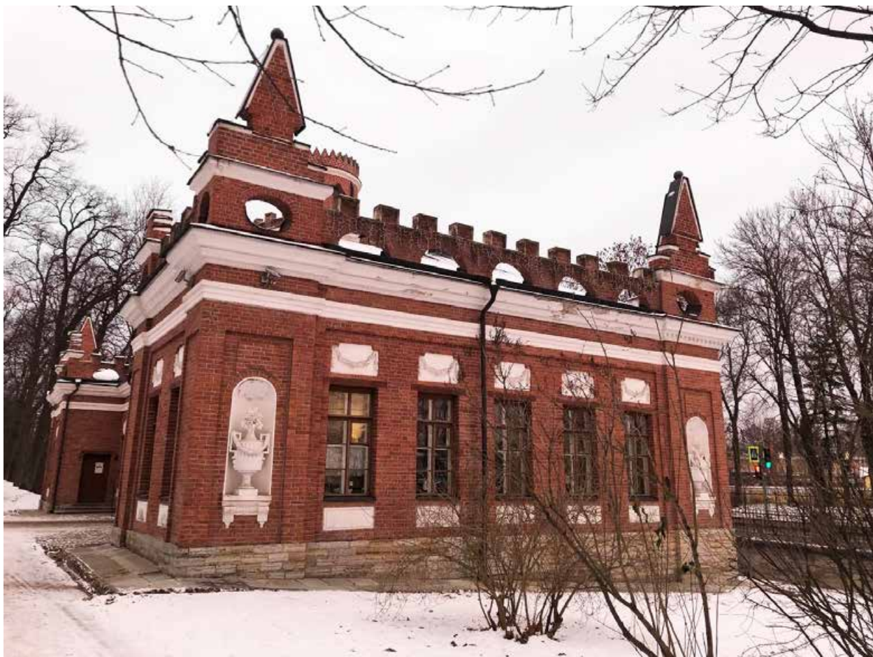
Фото 7. Вид на юго-восточный фасад.
