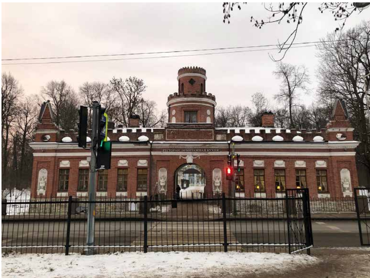
Фото 3. Вид на северо-восточный фасад.
