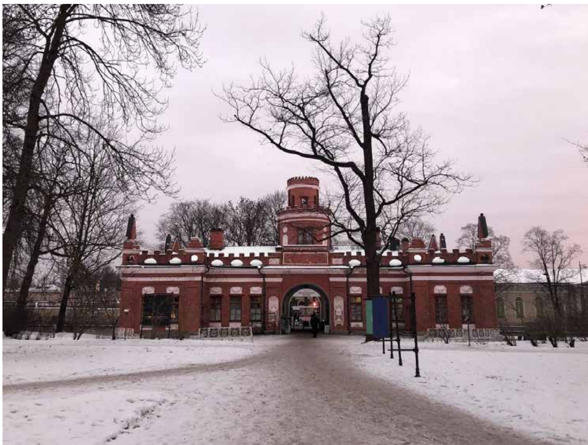
Фото 5. Вид на юго-западный фасад.
