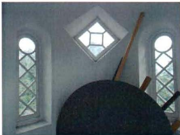
6. Оконные проемы в круглой башне
