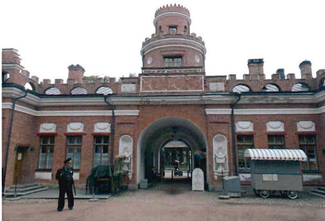
2. Вид со стороны южного фасада здания.
