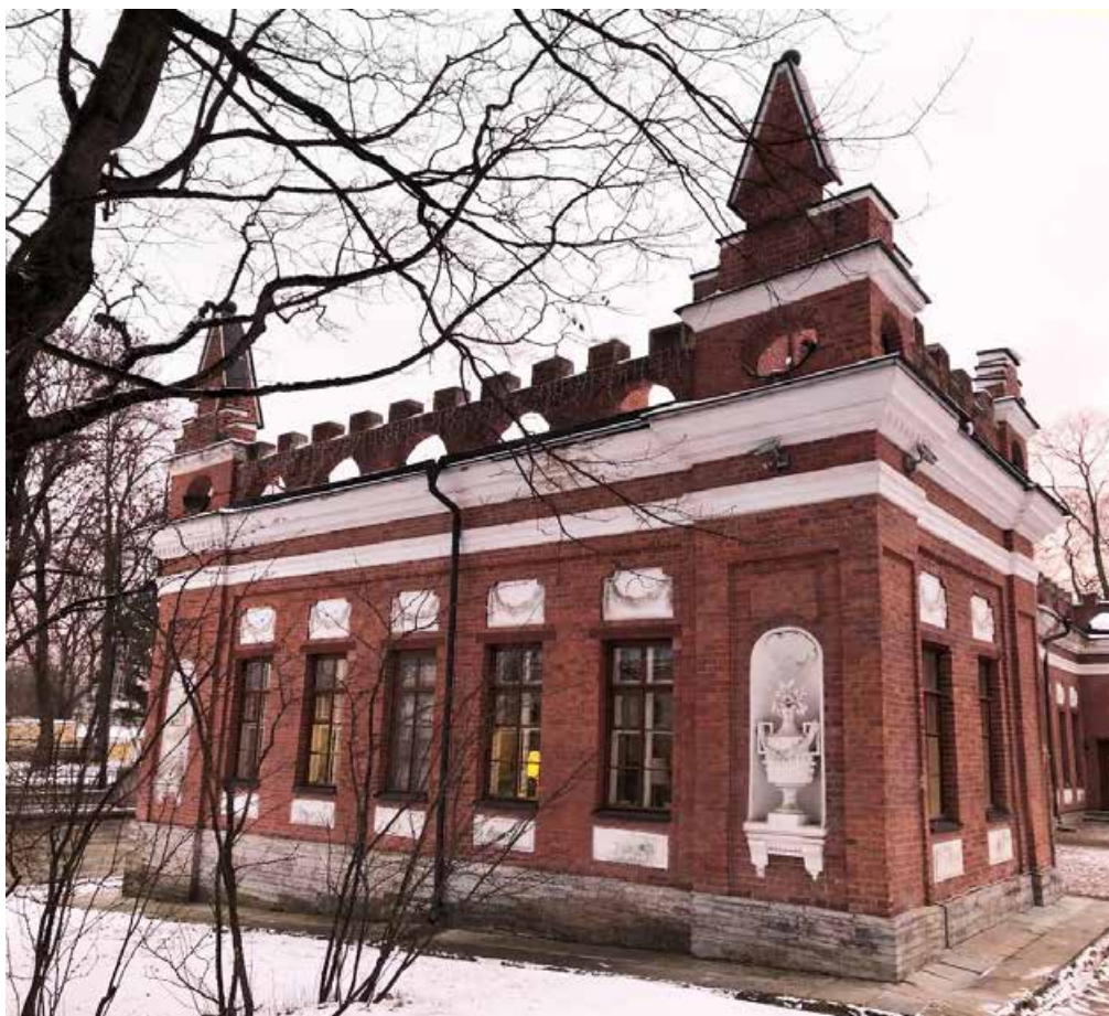
Фото 6. Вид на северо-западный фасад.
