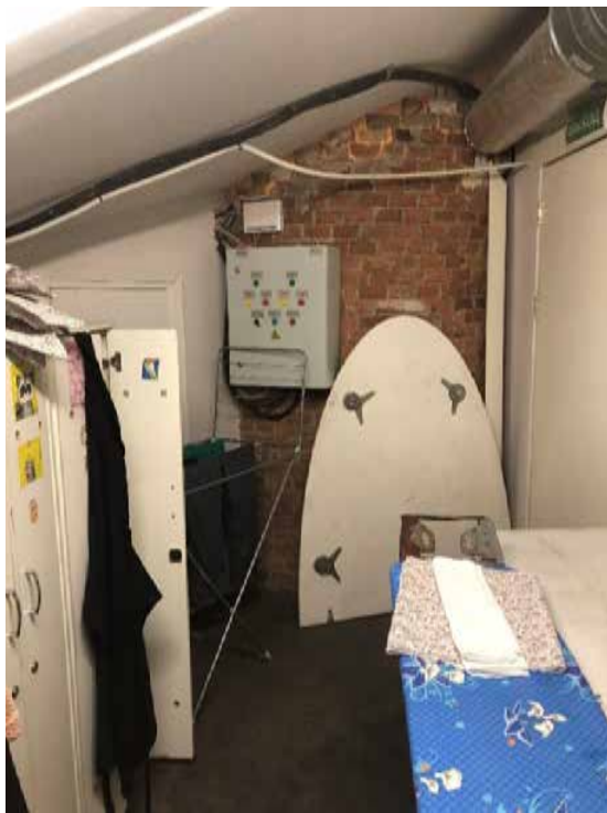
Фото 32. Помещение у башни-надстройки с северо-западной части.
