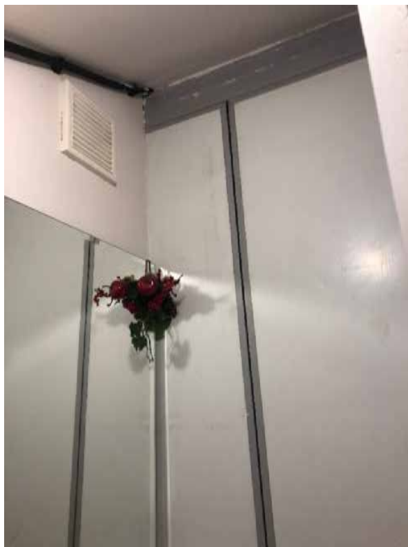
Фото 29. Северная часть помещения.
