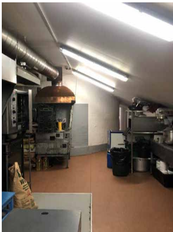
Фото 28. Вид на юго-восток из северо-западной части помещения.
