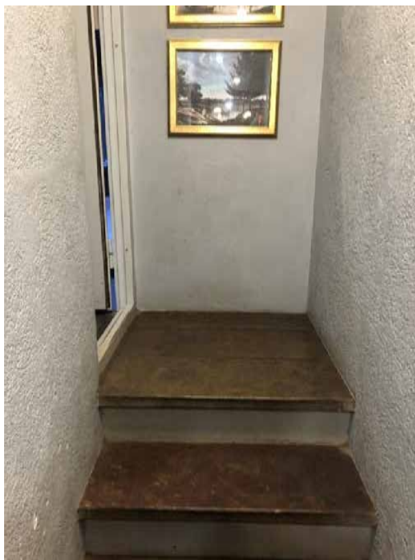
Фото 10. Лестница, ведущая в 1-й уровень мезонина-надстройки (2-Н).
