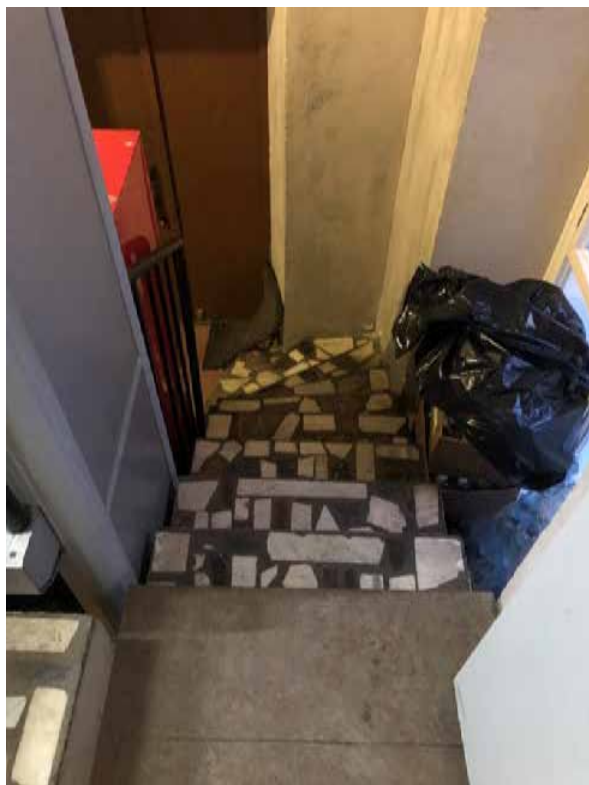
Фото 11. Лестница (вид на помещение № 4 (2-Н)).
