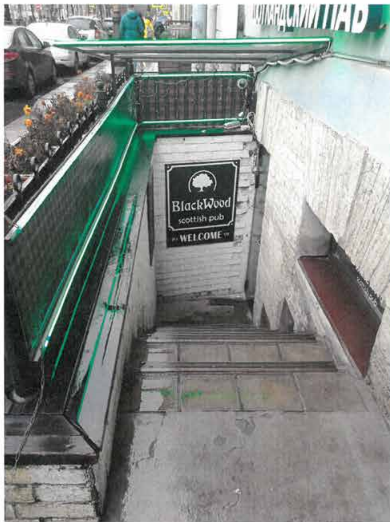
7. Объект культурного наследия регионального значения «Дом И.В.Кошанского (А.М.Сомова). Здесь с 1927г. по 1940 г. жил и работал выдающийся ленинградский зодчий Ной Абрамович Троцкий.» Санкт-Петербург, ул.Большая Конюшенная, д.15, лит.А. Вид с севера на ступени приямка, ведущего в «Шотландский паб».
