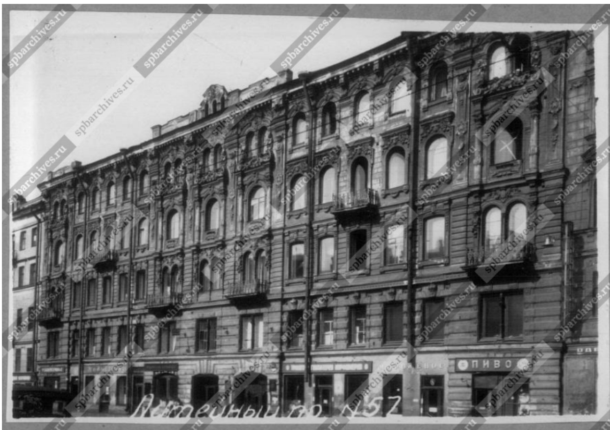
32. Вид фасада дома №57 на Литейном проспекте (бывший доходный дом И.И.Антонова, архитектор М.А.Макаров, 1871 г.), 1949 г. – ЦГАКФФД СПб – Фотодокумент Гр 71985
