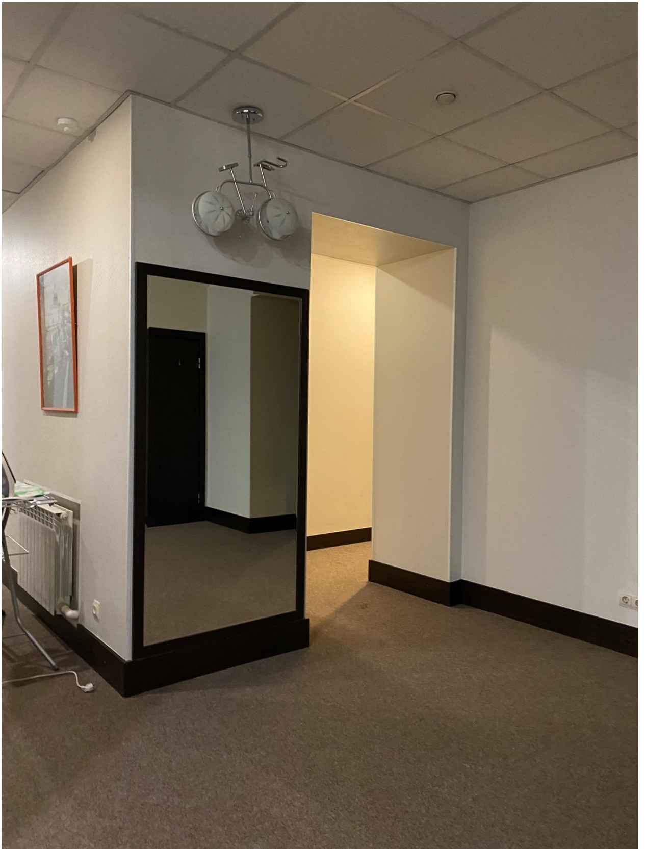
Фото 18. Вид на помещение квартиры № 10 объекта культурного наследия.
