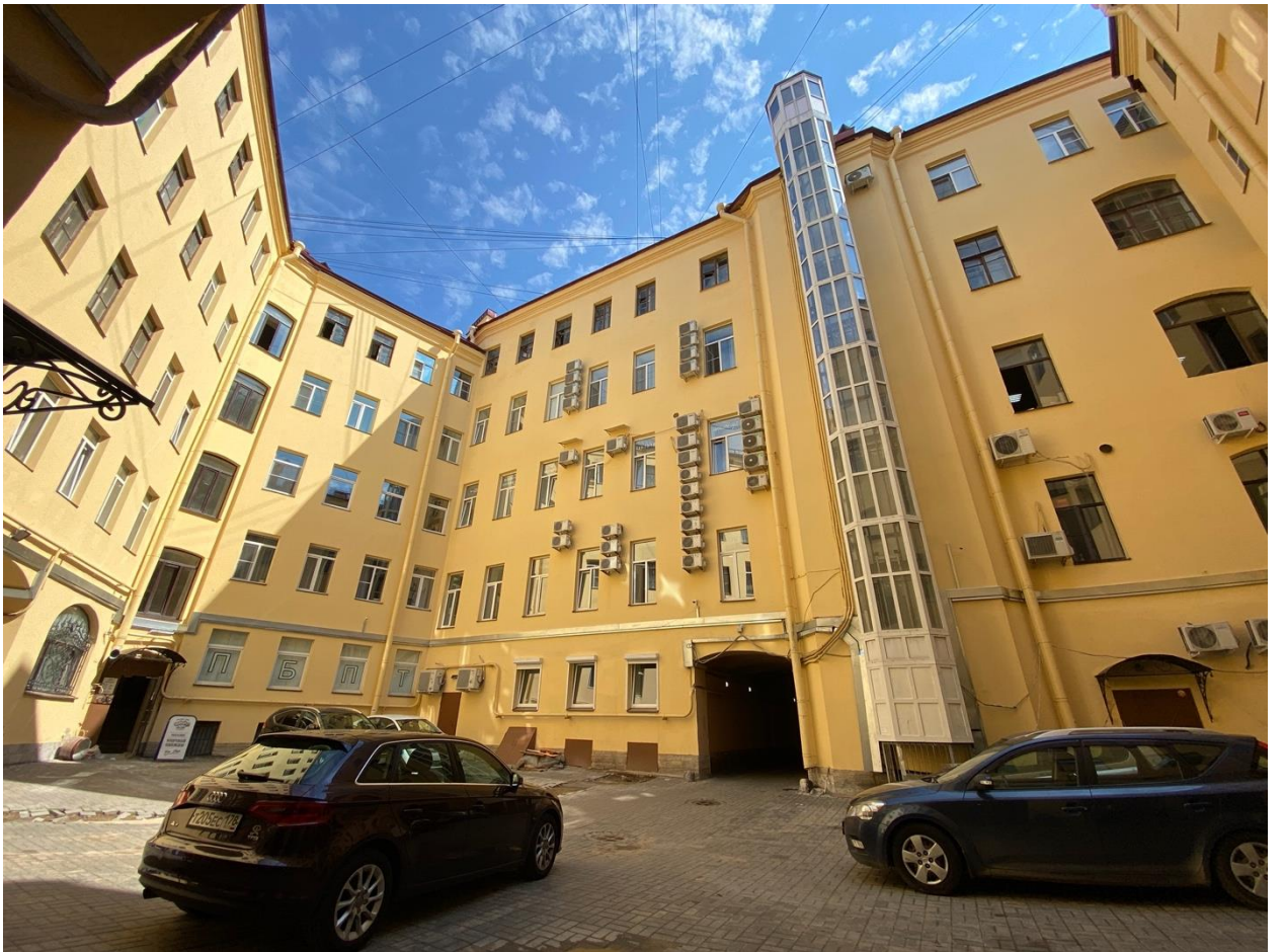
Фото 8. Вид на часть дворовых фасадов объекта культурного наследия.
