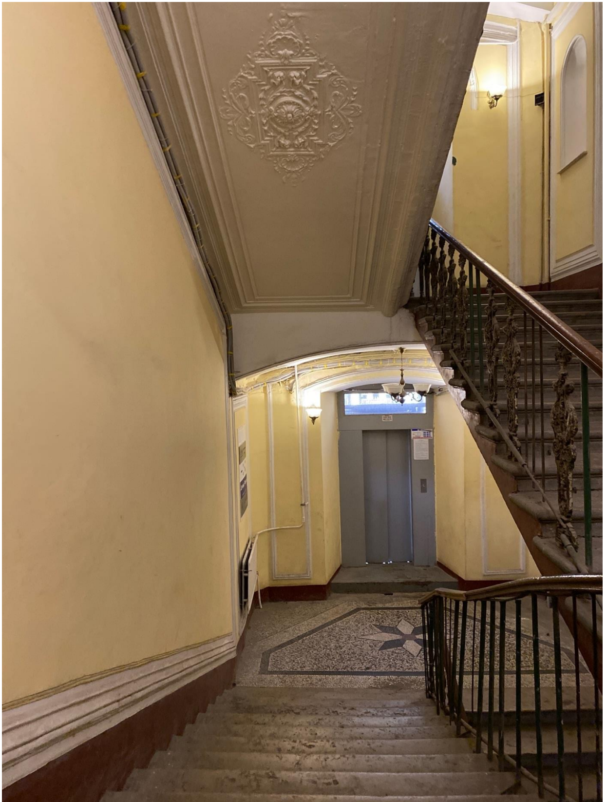
Фото 13. Вид на парадную лестницу объекта культурного наследия.
