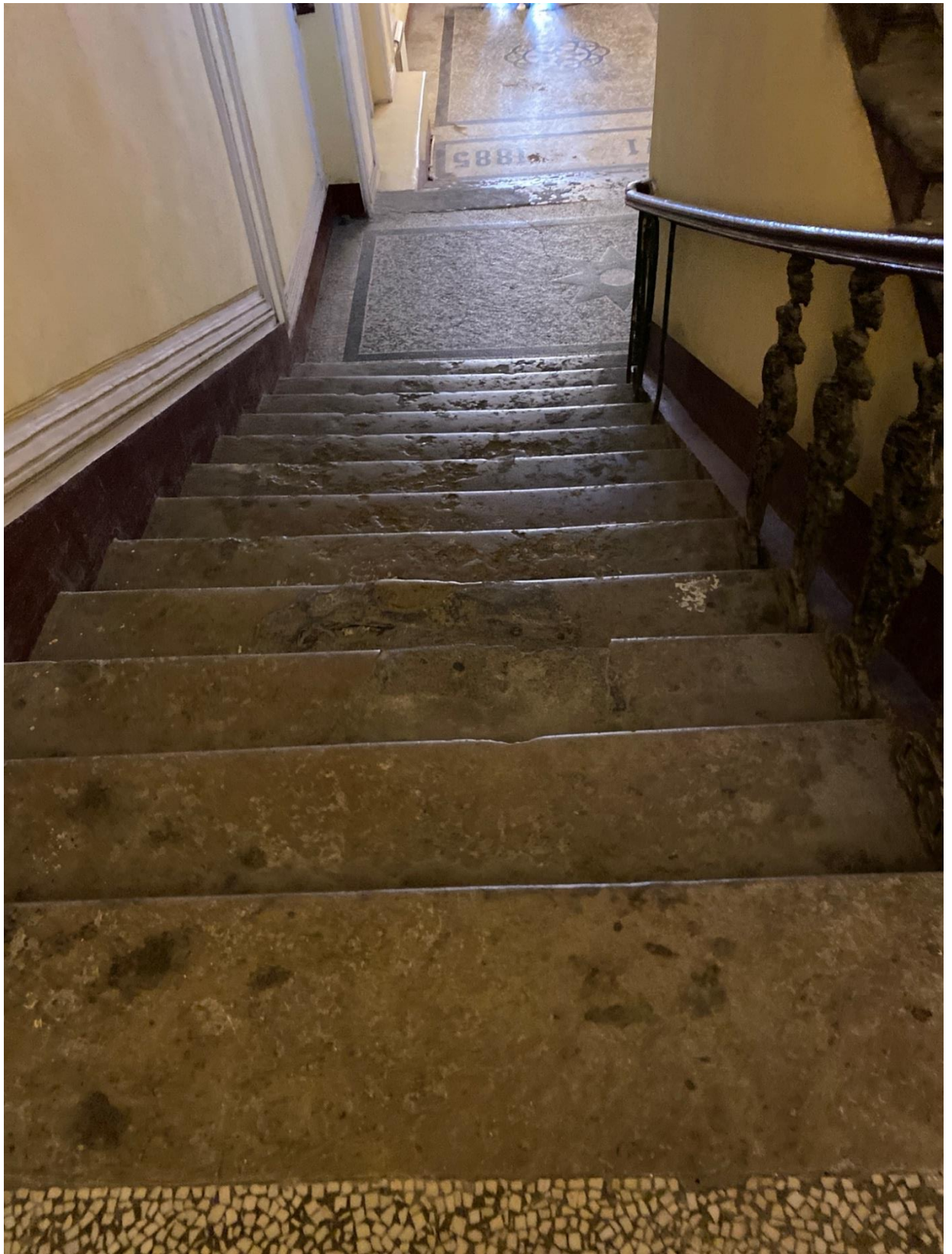
Фото 11. Вид на парадную лестницу объекта культурного наследия.
