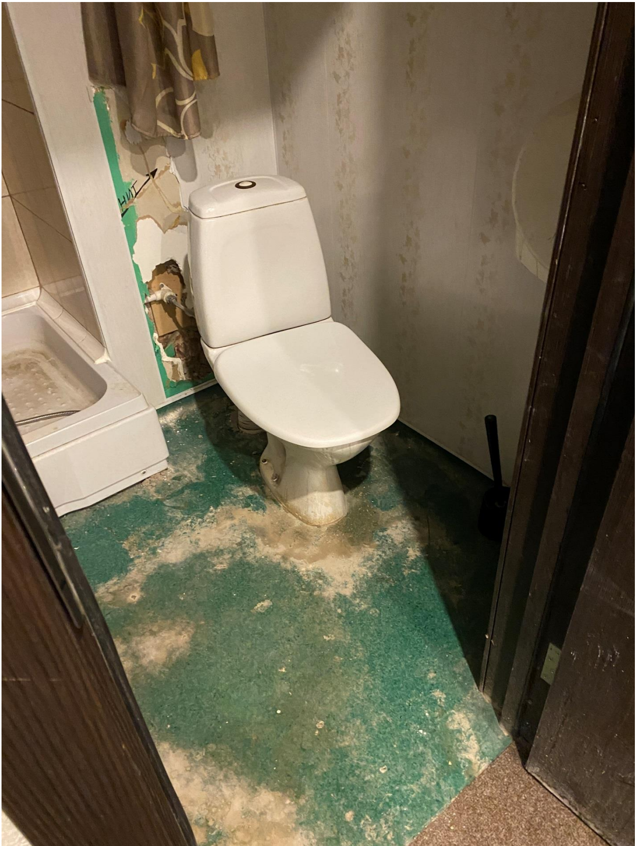
Фото 60. Вид на помещение квартиры № 10 объекта культурного наследия.
