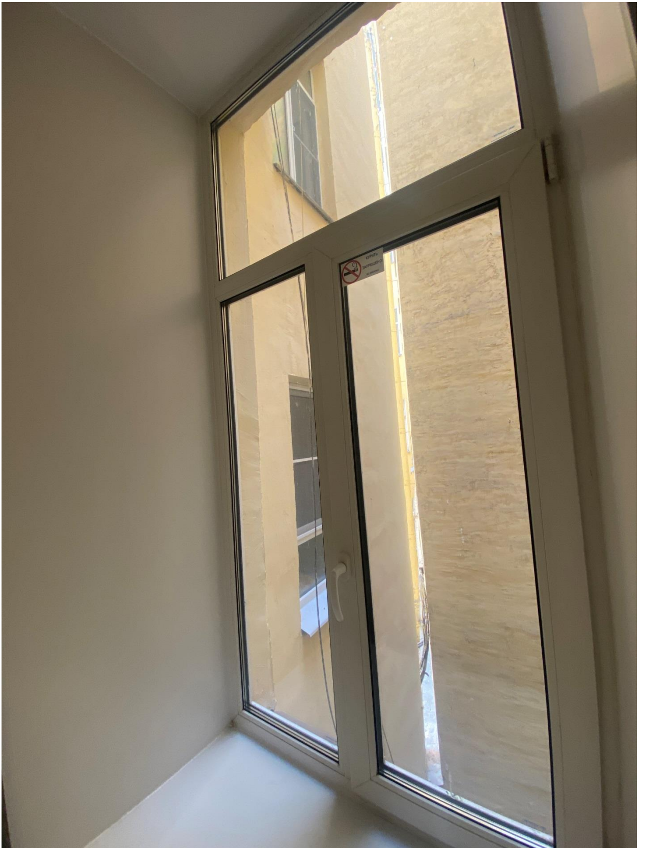
Фото 41. Вид на оконное заполнение квартиры № 10 объекта культурного наследия.
