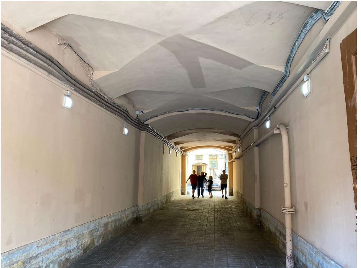
Фото 6. Вид на арочный проезд, расположенный на лицевом фасаде (с Литейного проспекта), объекта культурного наследия.
