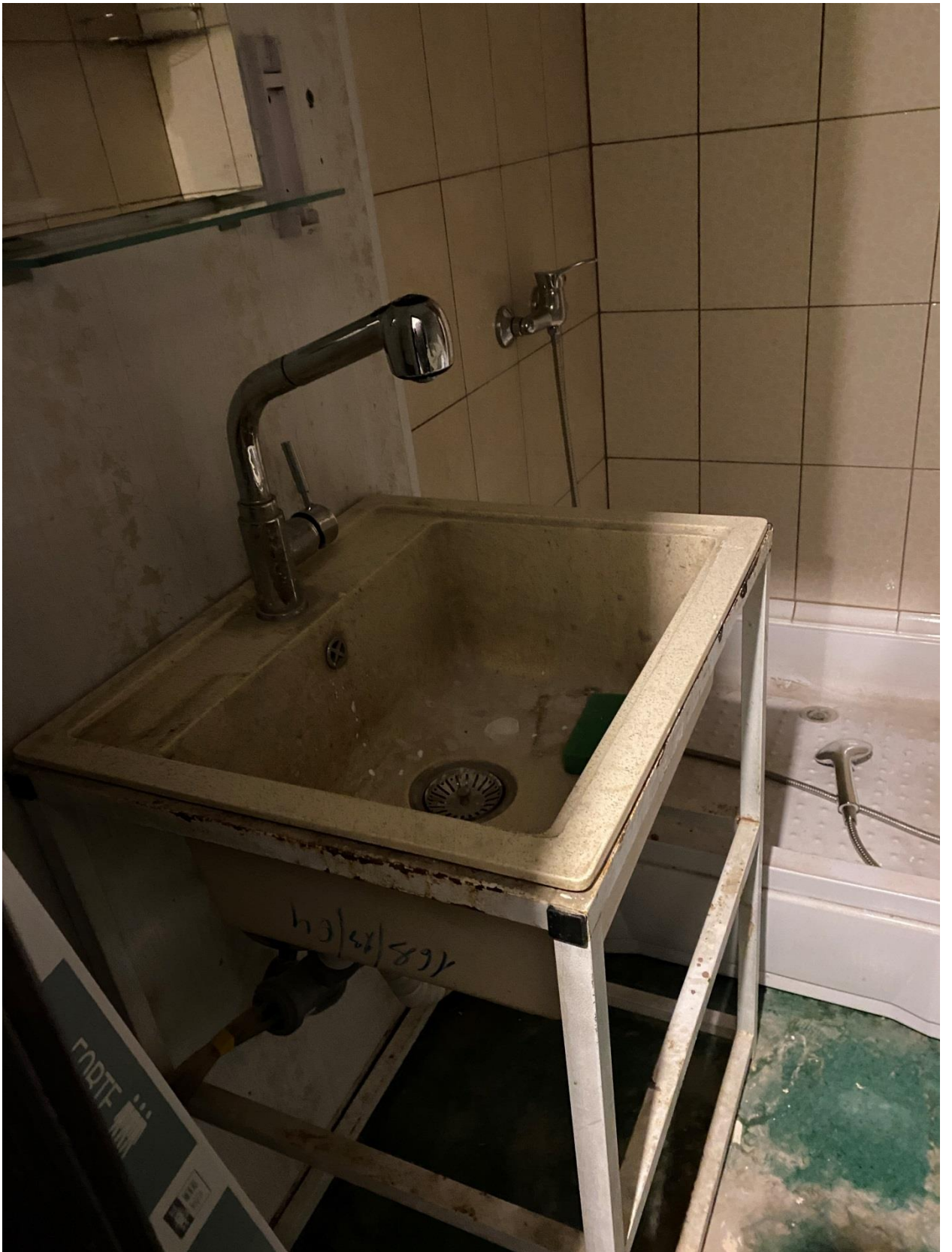
Фото 62. Вид на помещение квартиры № 10 объекта культурного наследия.
