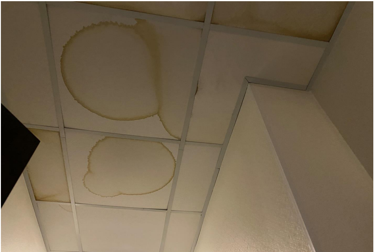
Фото 53. Вид на помещение квартиры № 10 объекта культурного наследия.
