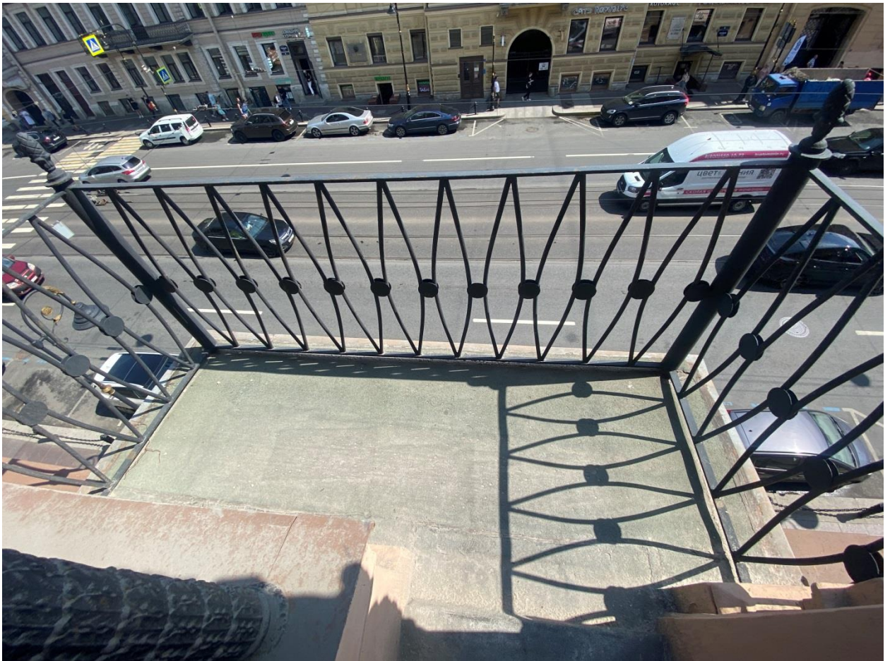
Фото 59. Вид на помещение квартиры № 10 объекта культурного наследия.
