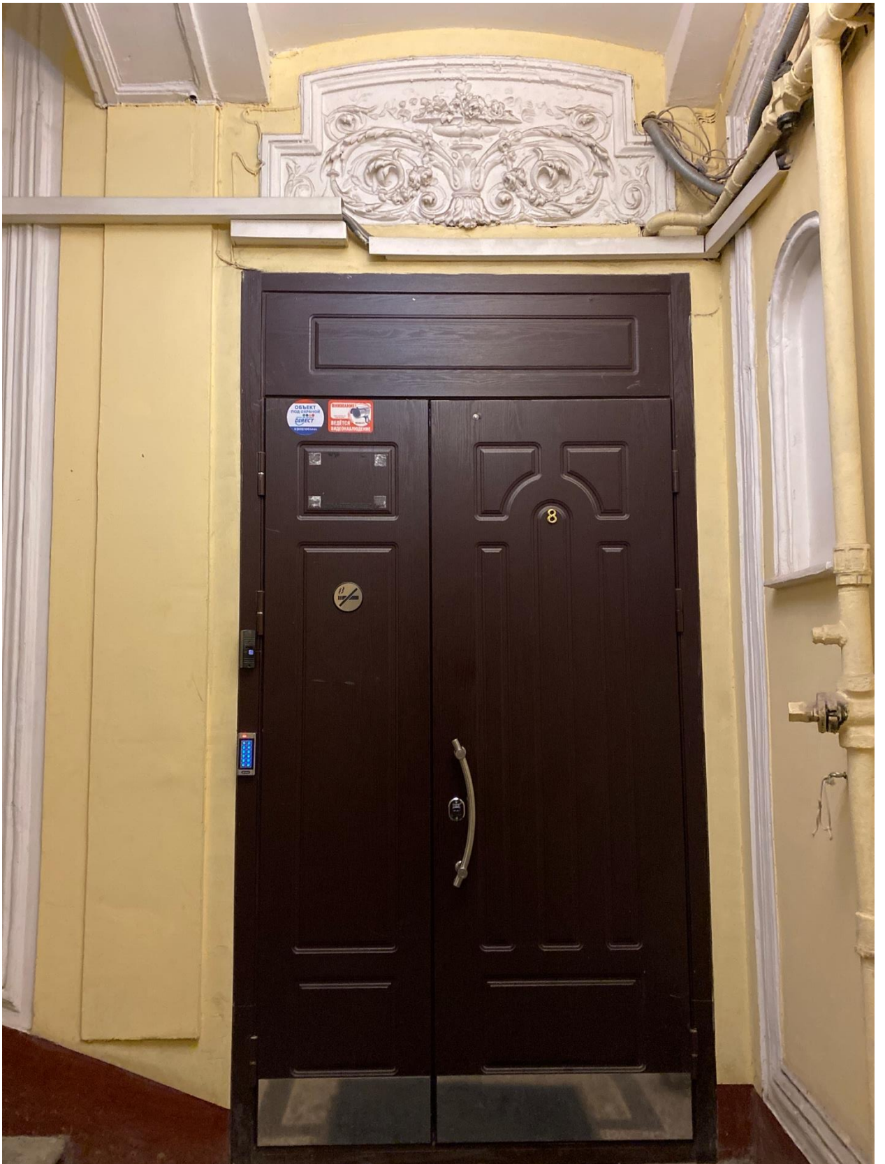
Фото 14. Вид на входную дверь квартиры № 8 объекта культурного наследия.
