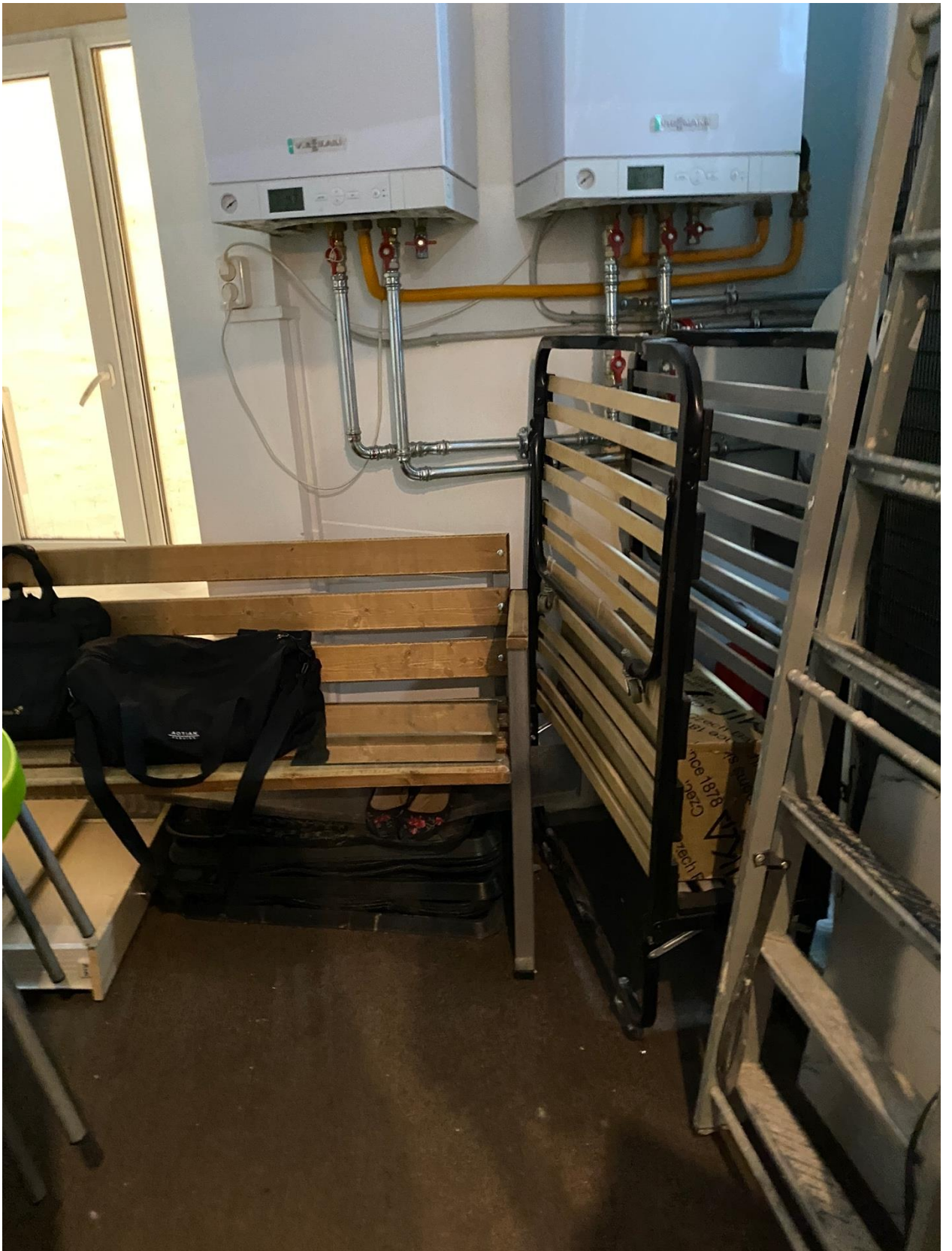
Фото 27. Вид на помещение квартиры № 8 объекта культурного наследия.
