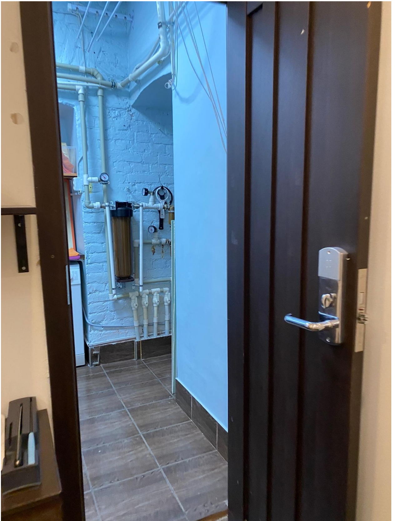
Фото 21. Вид на помещение квартиры № 8 объекта культурного наследия.
