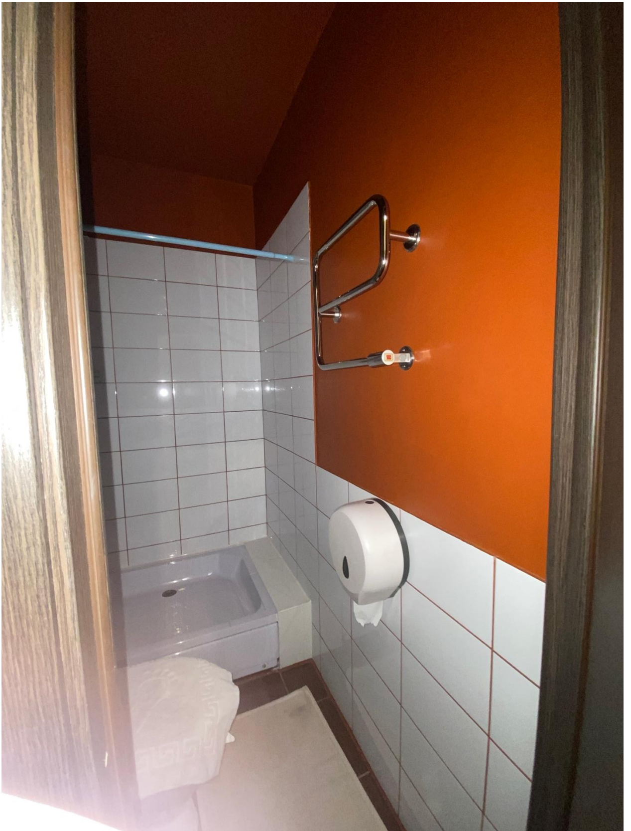
Фото 64. Вид на помещение квартиры № 8 объекта культурного наследия.
