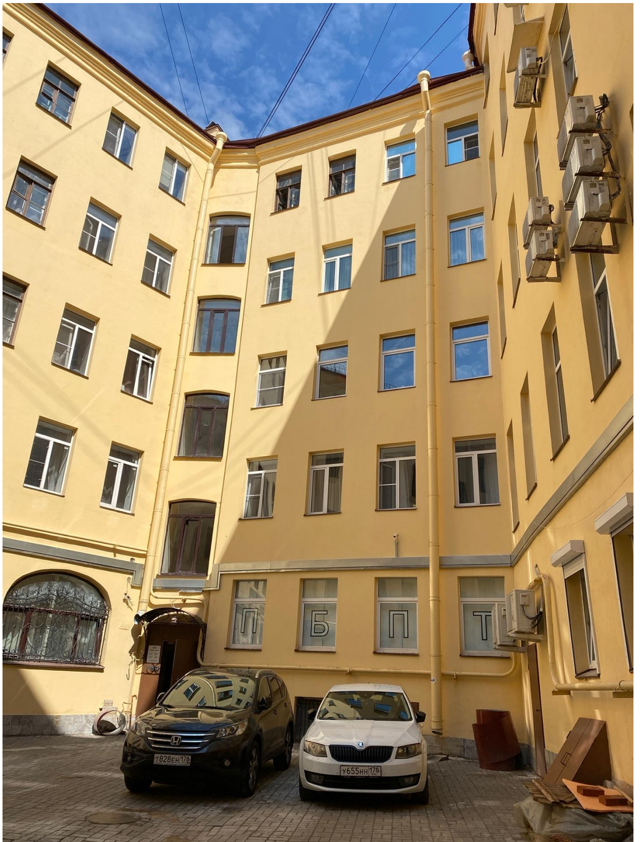
Фото 7. Вид на часть дворовых фасадов объекта культурного наследия.
