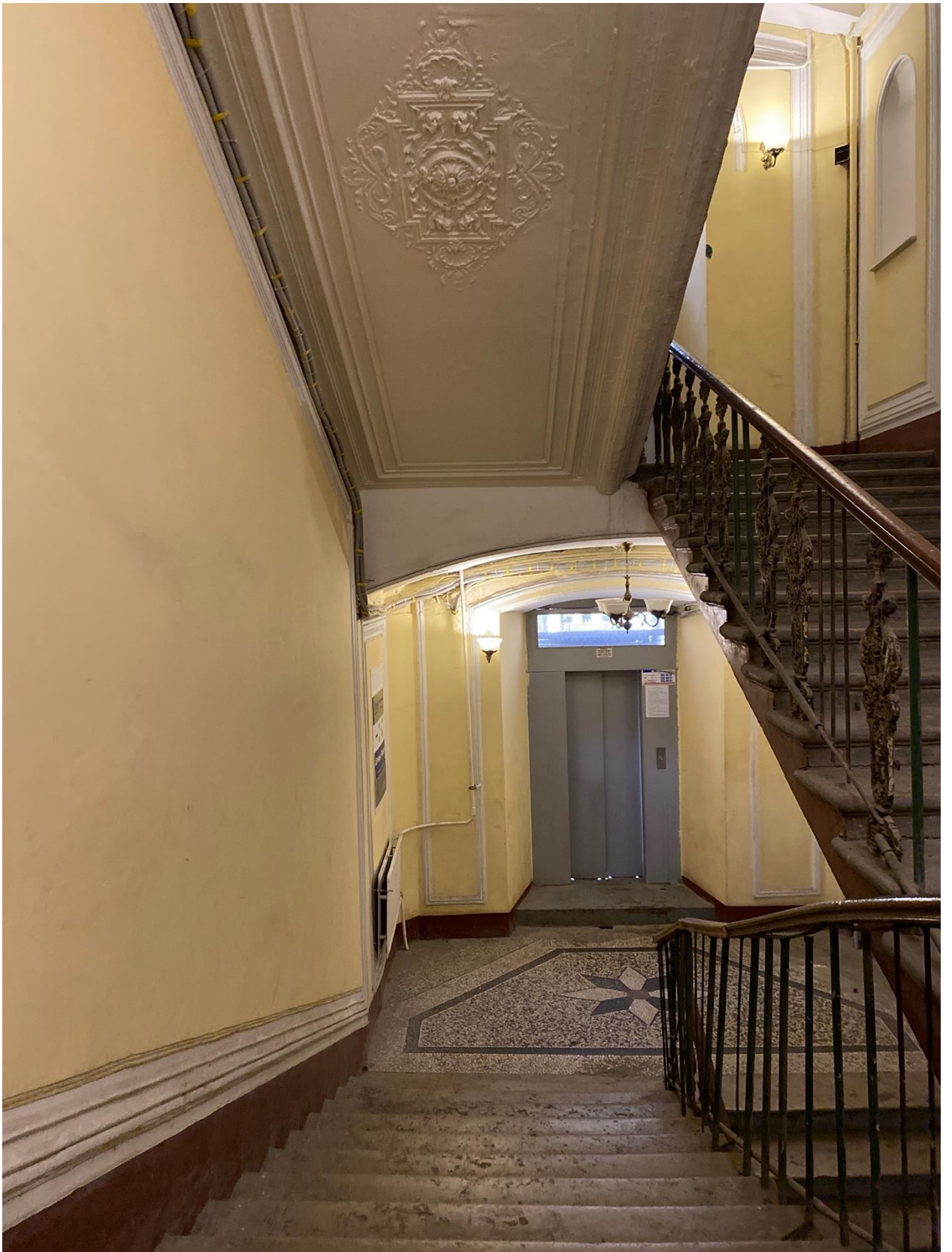
Фото 13. Вид на парадную лестницу объекта культурного наследия.
