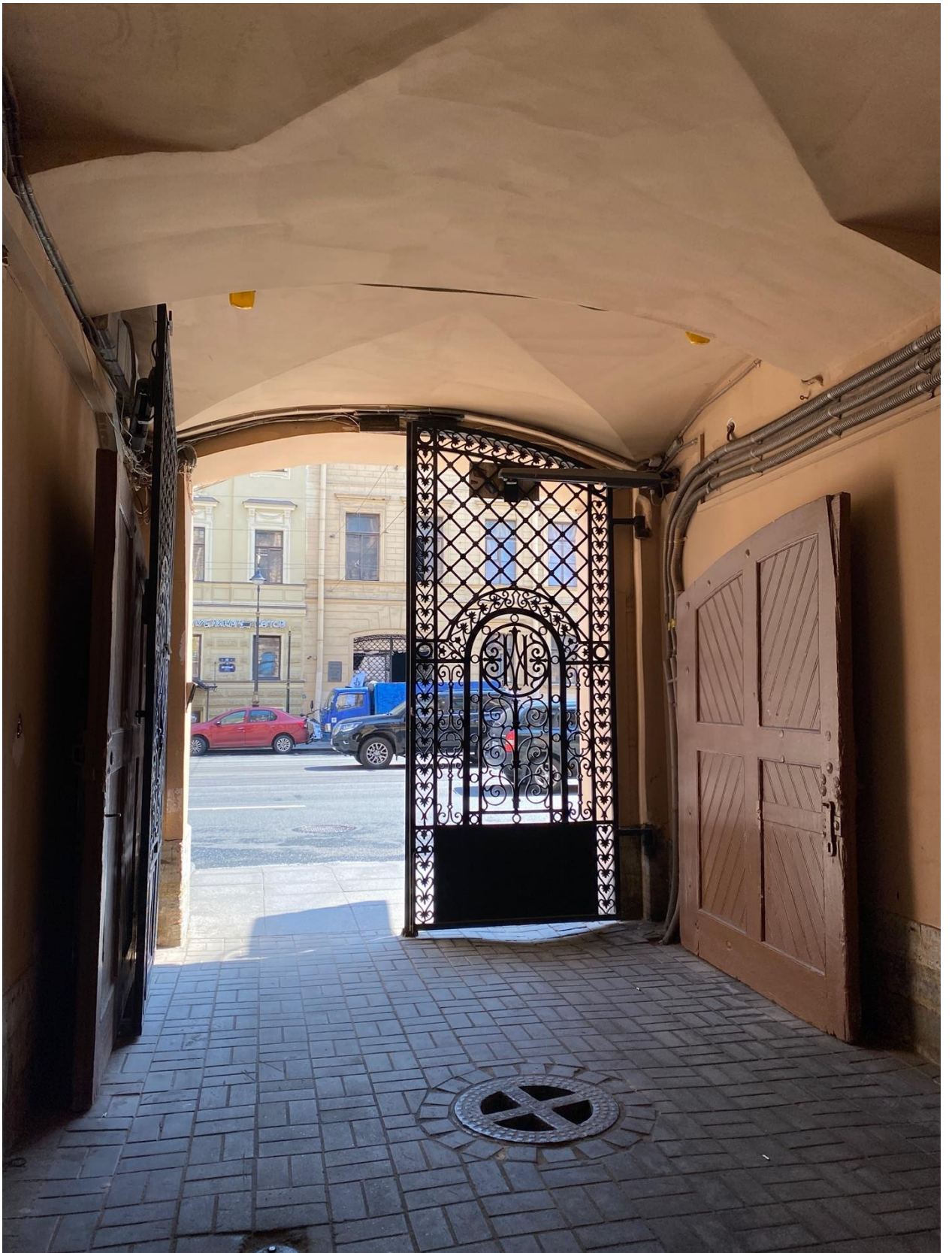
Фото 9. Вид на воротное заполнение из арки объекта культурного наследия.
