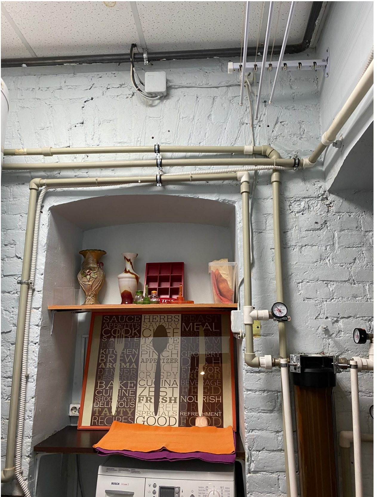
Фото 23. Вид на помещение квартиры № 8 объекта культурного наследия.
