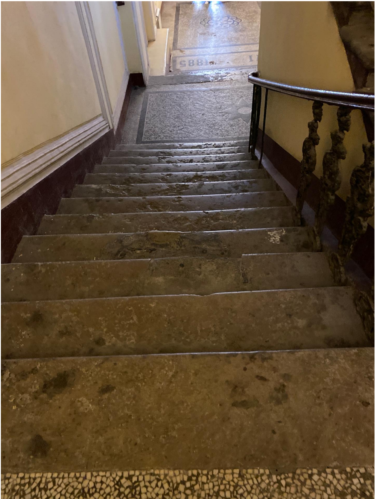
Фото 11. Вид на парадную лестницу объекта культурного наследия.
