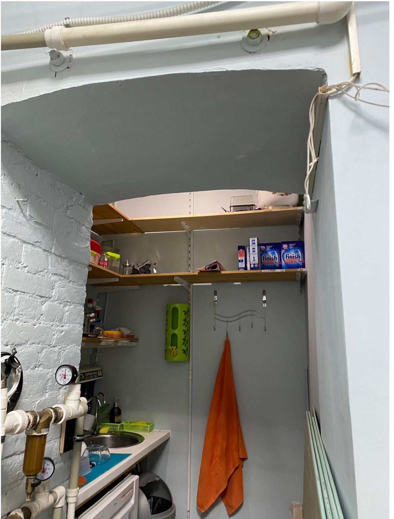
Фото 24. Вид на помещение квартиры № 8 объекта культурного наследия.
