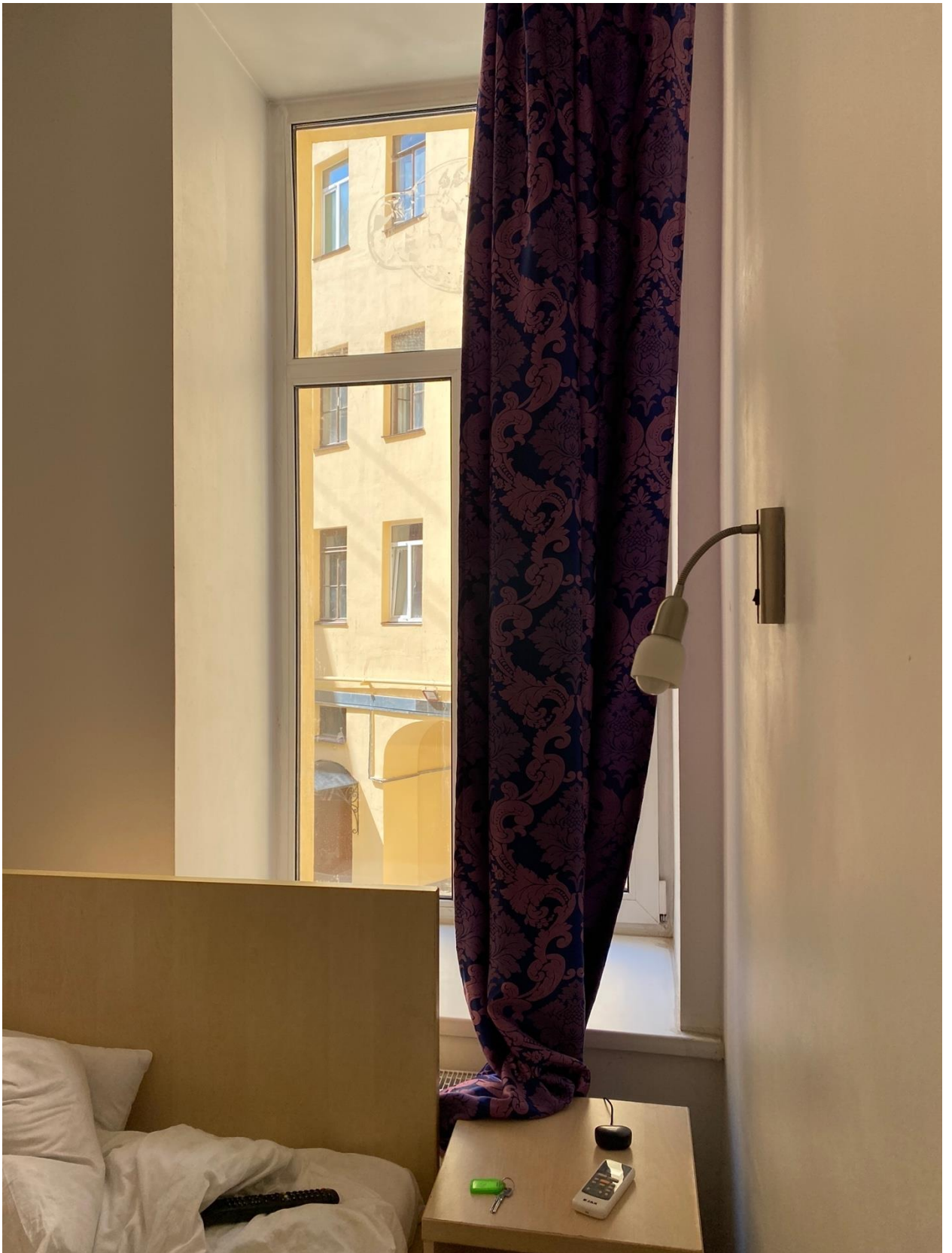
Фото 34. Вид на оконное заполнение в части квартиры № 8 объекта культурного наследия.
