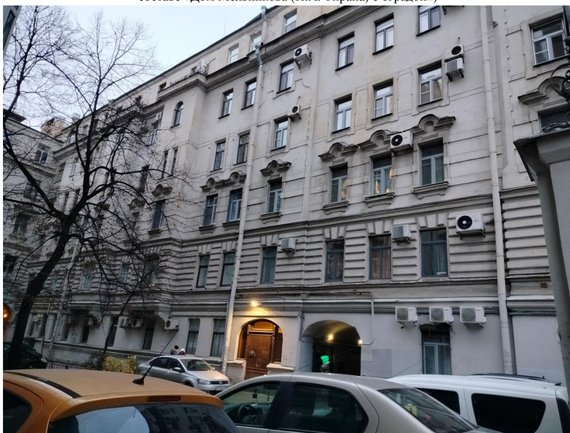
Фото 2. Фрагмент фасада курдонера выявленного объекта культурного наследия «Дом Мельникова (Н.А. Тирана)» (в составе «Дом Мельникова (Н.А. Тирана) с оградой»)
