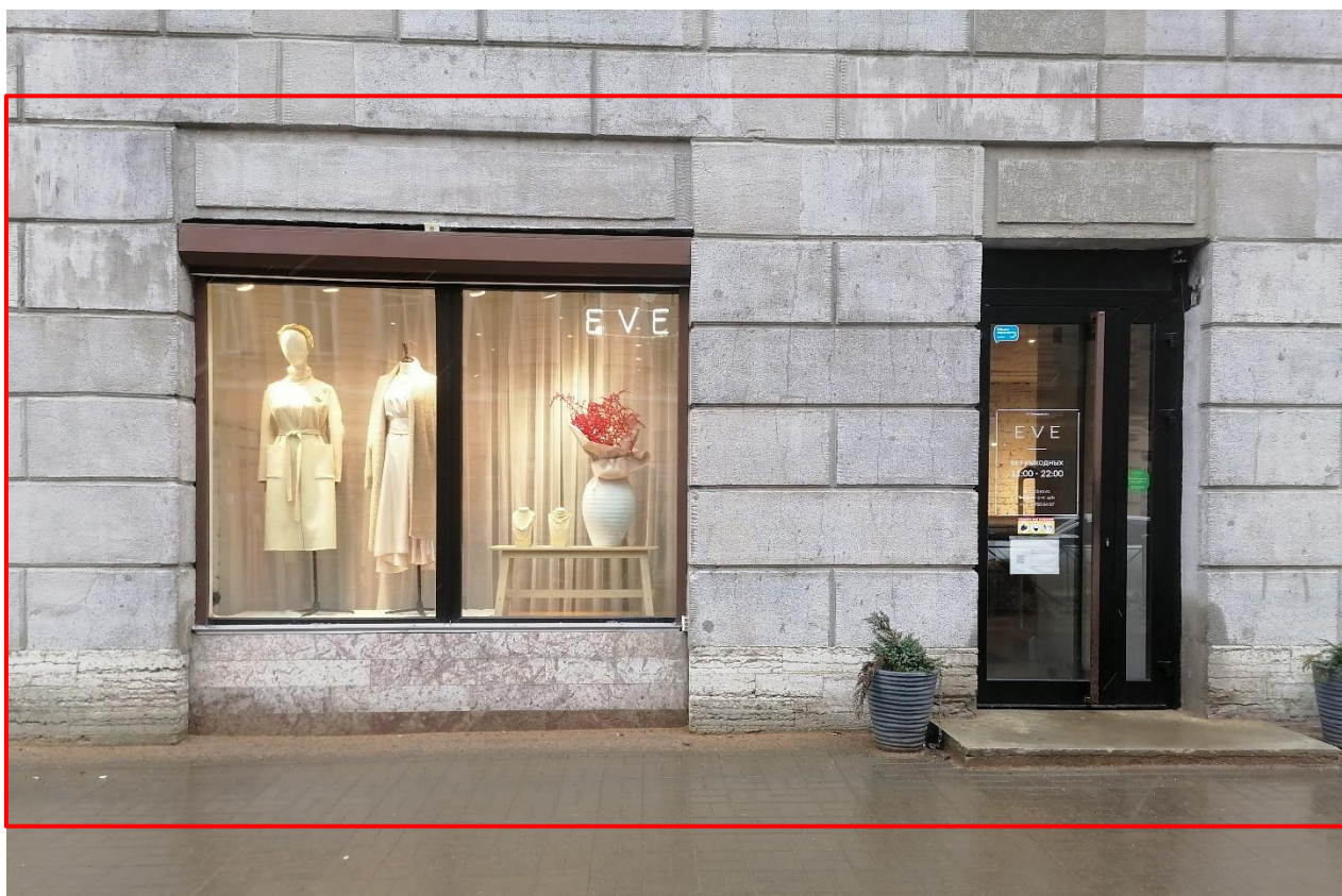
Фото 12. Фрагмент фасада здания по ул. Маяковского с указанием помещения 24-Н. 1-ый этаж, световые оси 9-10-11. Магазин “EVE”. 02.03.2022г.
