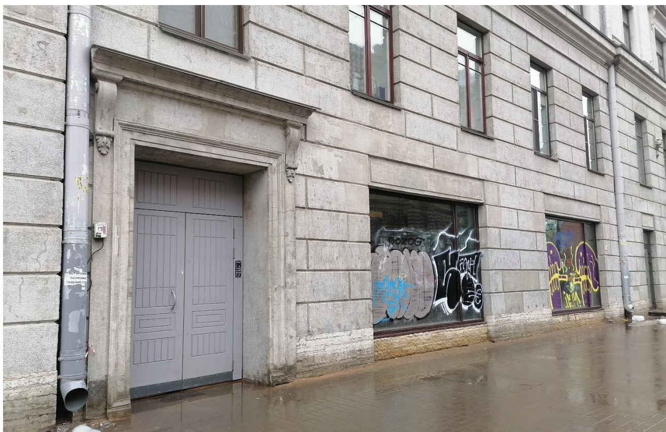
Фото 7. Фрагмент фасада здания по ул. Маяковского. 1-ый этаж, световые оси 3-4-5-6-7. 02.03.2022г.
