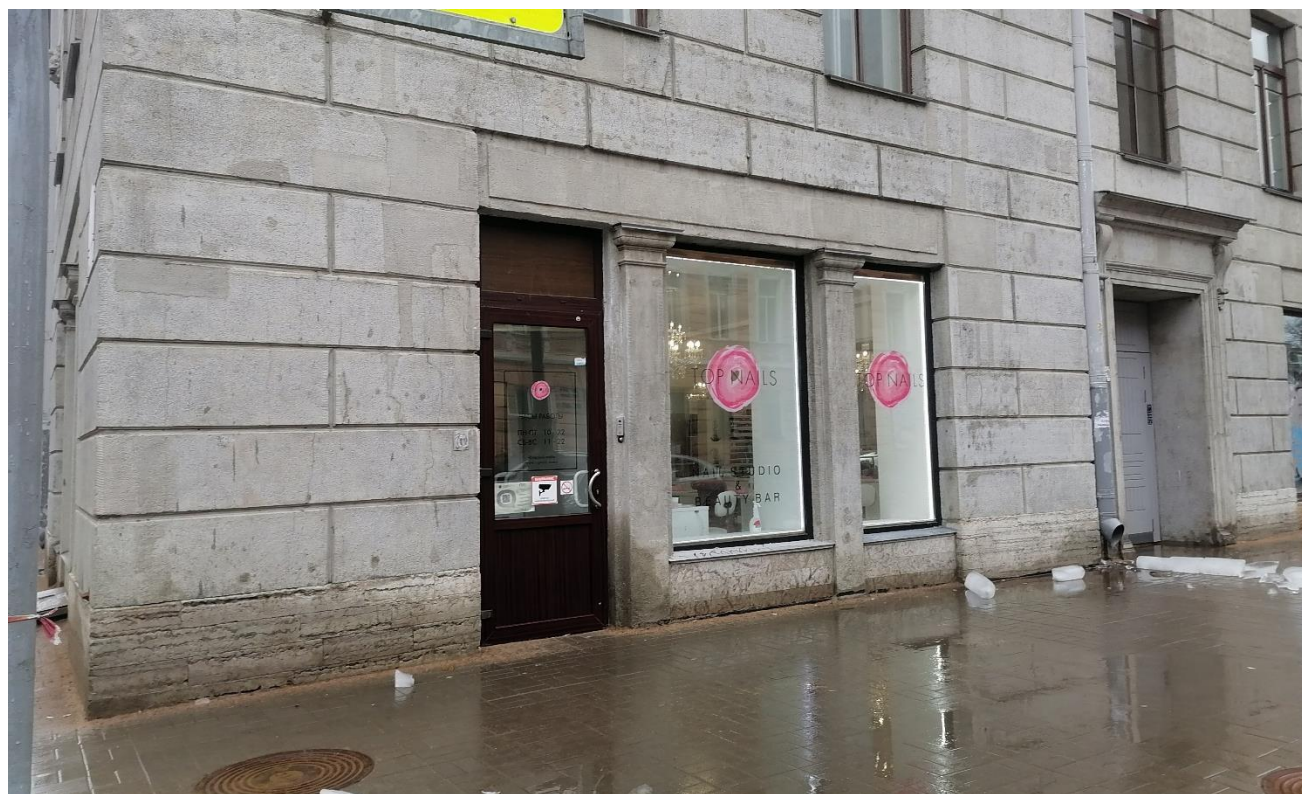
Фото 6. Фрагмент фасада здания по ул. Маяковского. 1-ый этаж, световые оси 1-2-3. 02.03.2022г.
