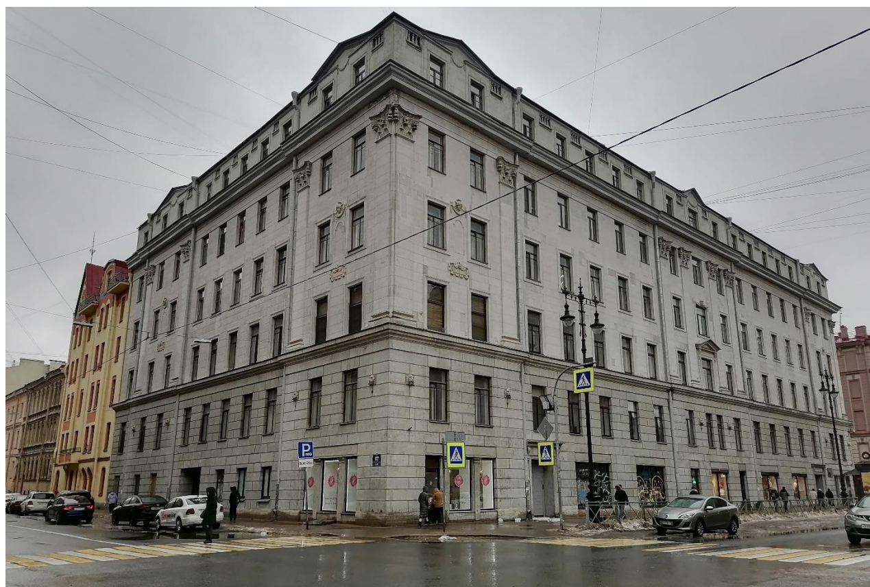
Фото 2. Общий вид на здание с перекрестка ул. Маяковского и Баскова переулка. 02.03.2022г.
