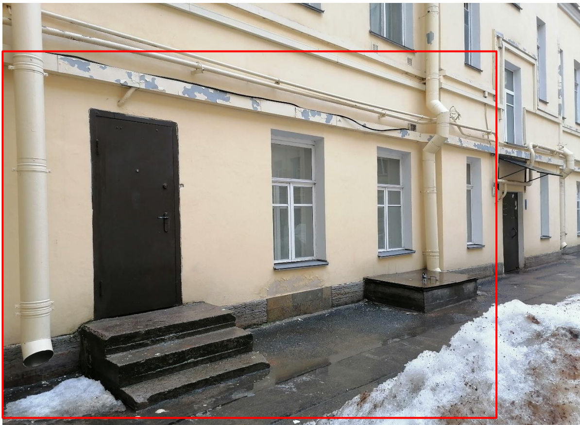
Фото 16. Фрагмент дворового фасада с указанием помещения 24-Н. Служебный вход и в приямок в подвал. Магазин "EVE".02.03.2022г.
