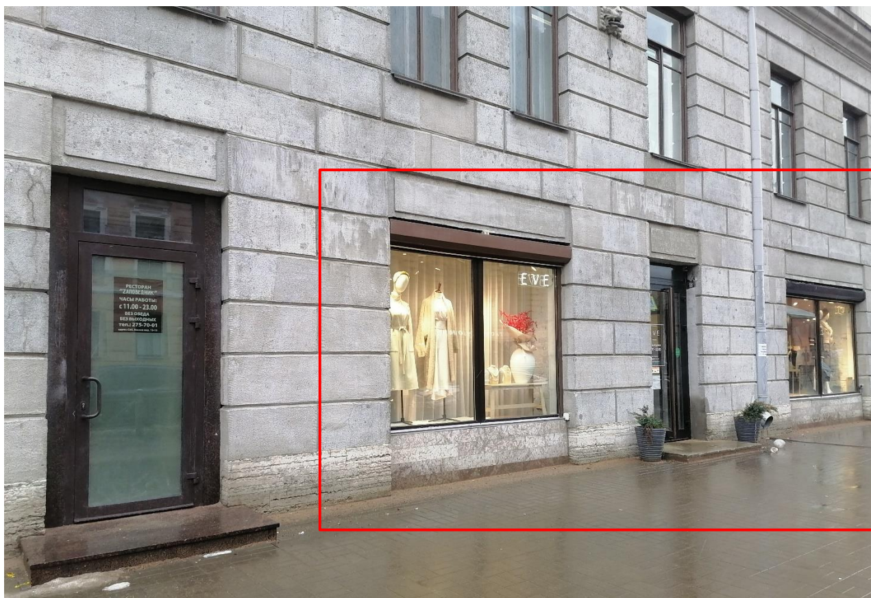
Фото 8. Фрагмент фасада здания по ул. Маяковского с указанием помещения 24-Н. 1-ый этаж, световые оси 8-9-10-11. 02.03.2022г.
