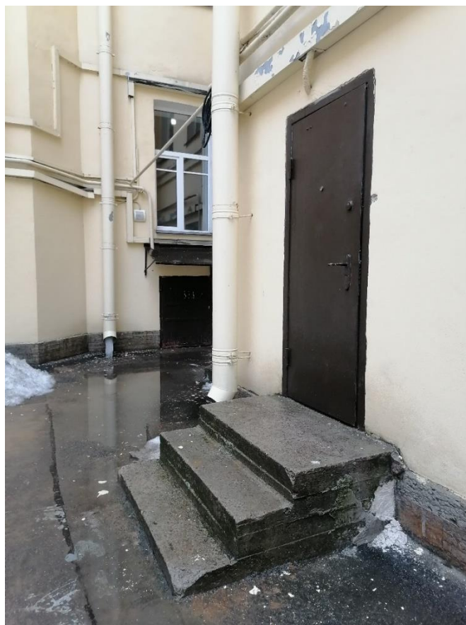
Фото 17. Фрагмент дворового фасада. Служебный вход в помещение 24-Н. Магазин "EVE".02.03.2022г.
