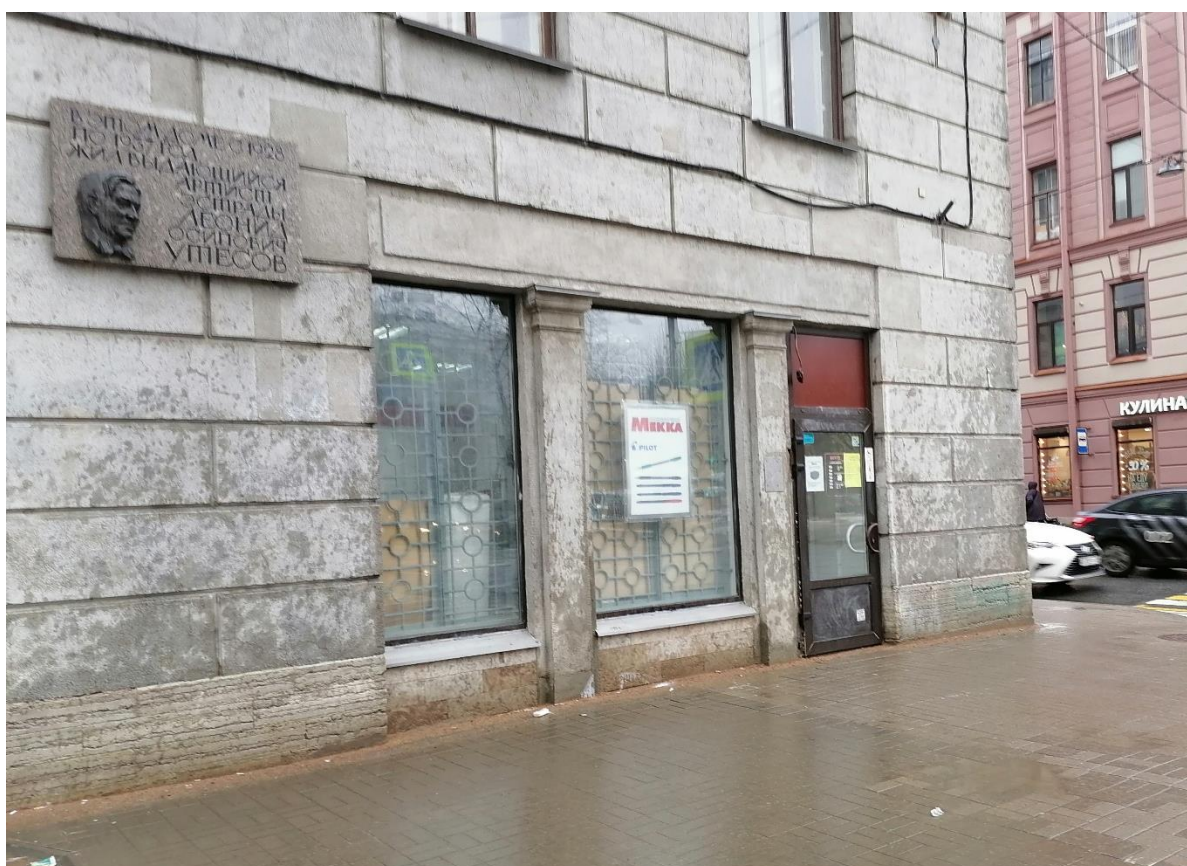
Фото 11. Фрагмент фасада здания по ул. Маяковского. 1-ый этаж, световые оси 17-18. 02.03.2022г.
