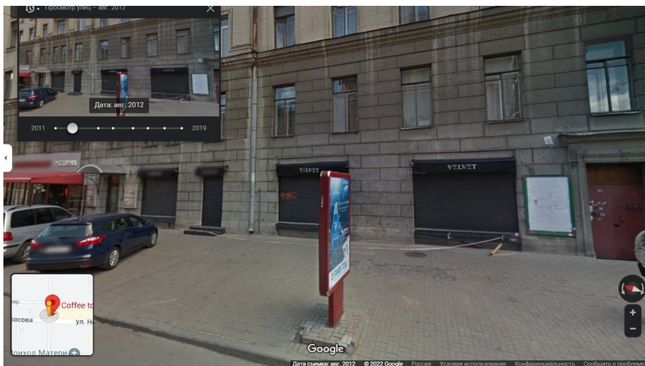
Фрагмент фасада по ул. Маяковского жилого дома по адресу: Санкт-Петербург. Басков пер. 13-15. Из панорамы Google Планета Земля. Август 2012г.
