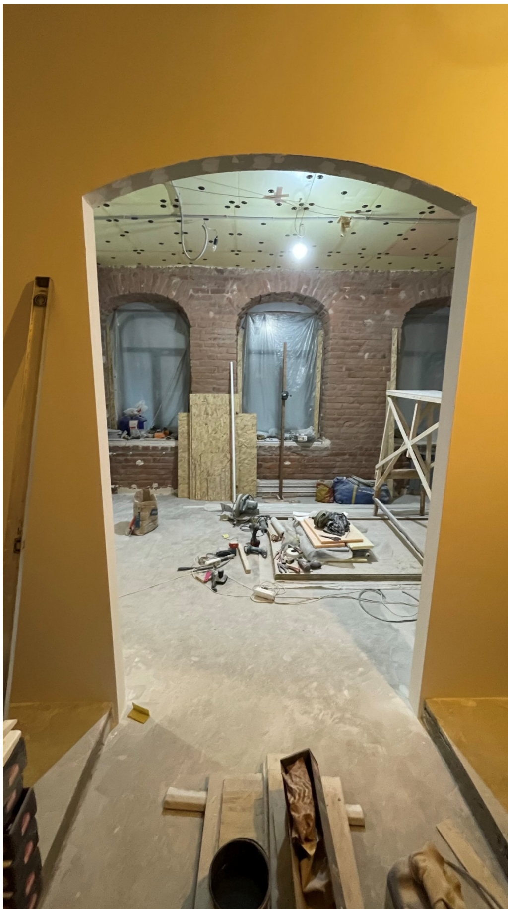
15. Фрагмент интерьера кухни (помещение №5/7.0);
