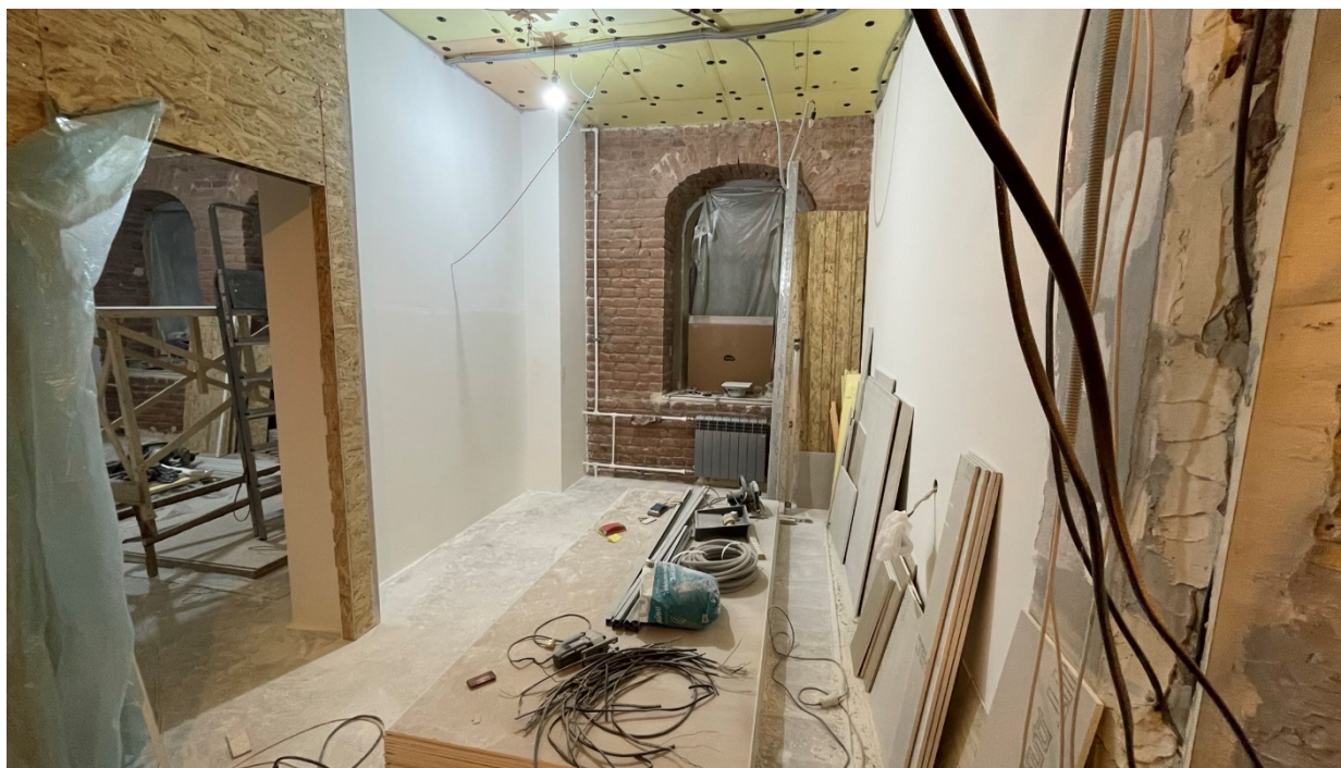
5. Фрагмент интерьера комнаты (помещение №2/11.0);
