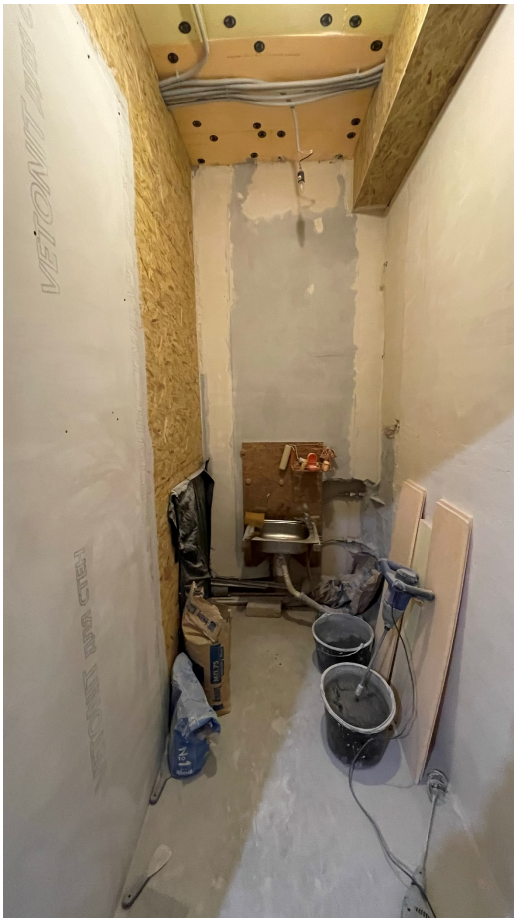
20.Фрагмент интерьера гардеробной (помещение №7/3.1);
