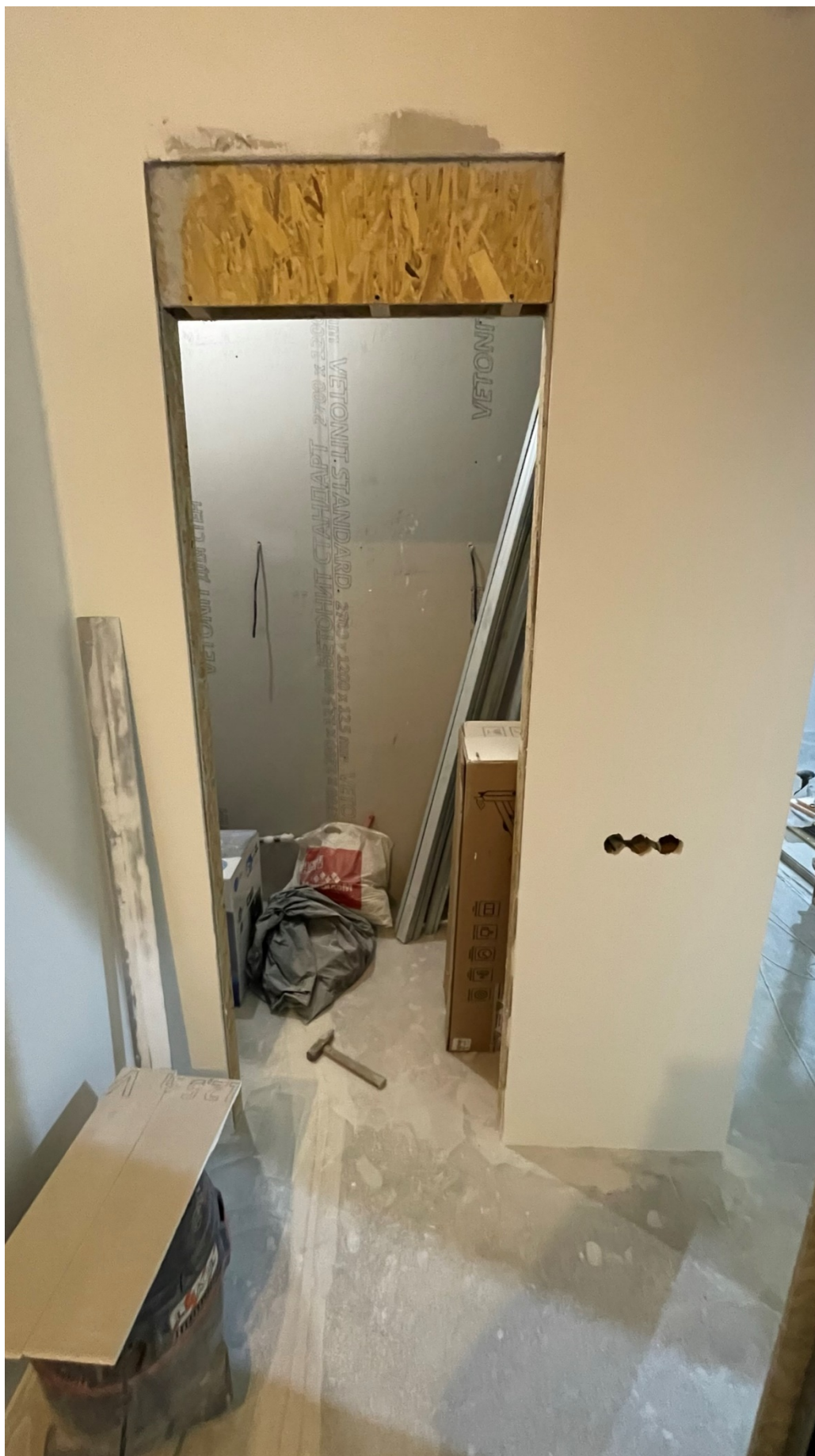
7. Фрагмент интерьера коридора (помещение №1/6.8);
