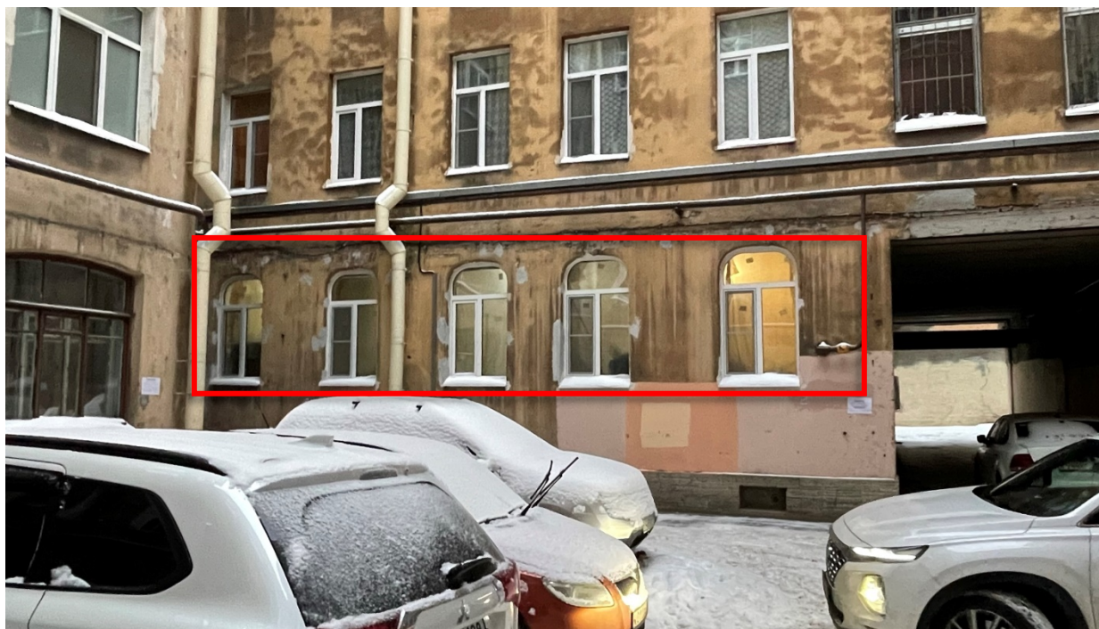
1. Вид на дворовой фасад здания и окна квартиры;
