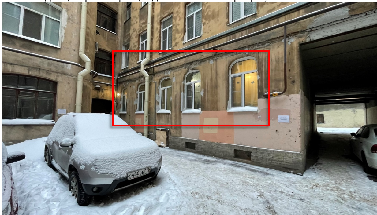
2. Вид на дворовой фасад здания и окна квартиры;
