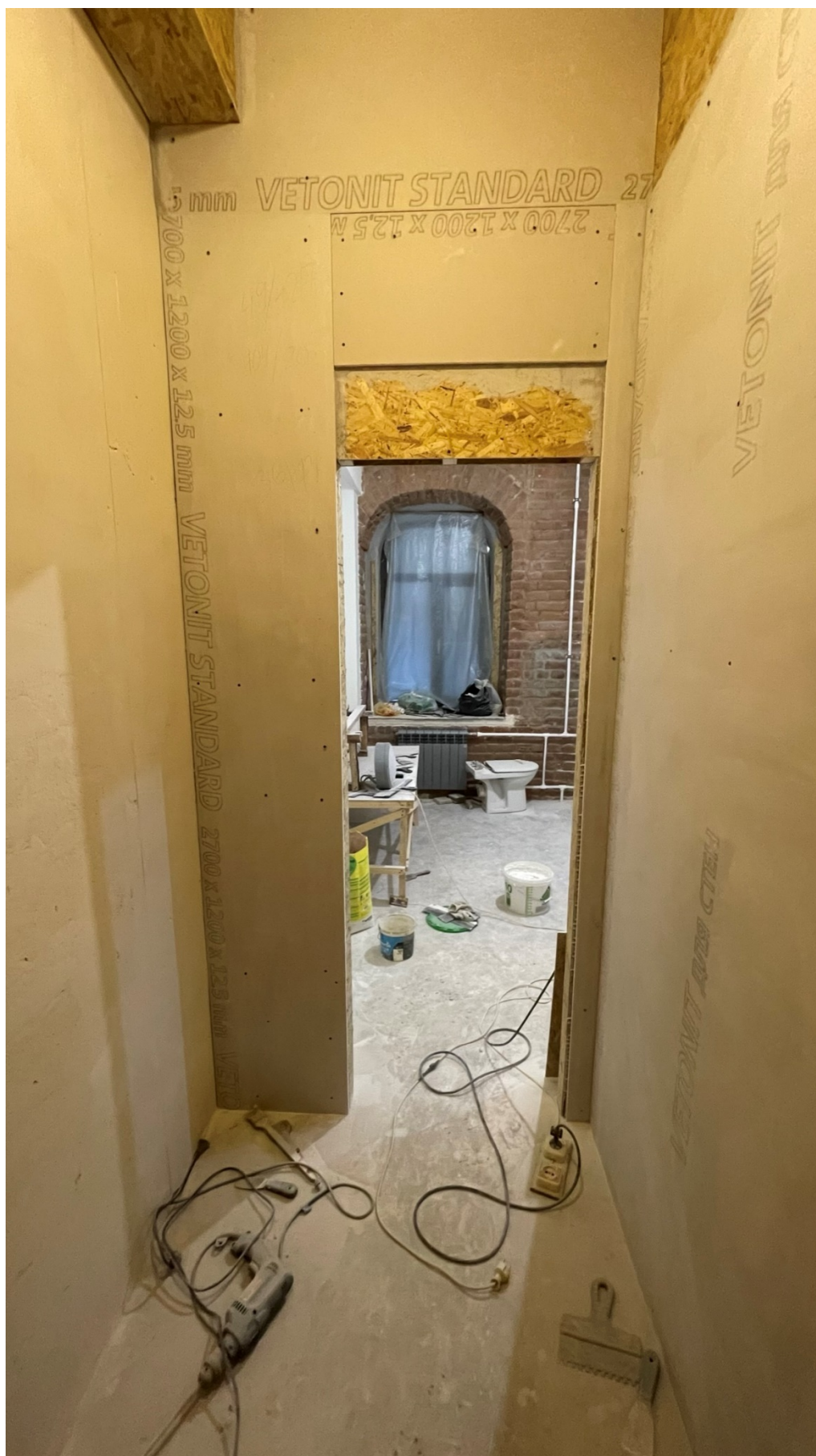
21. Фрагмент интерьера гардеробной (помещение №7/3.1).
