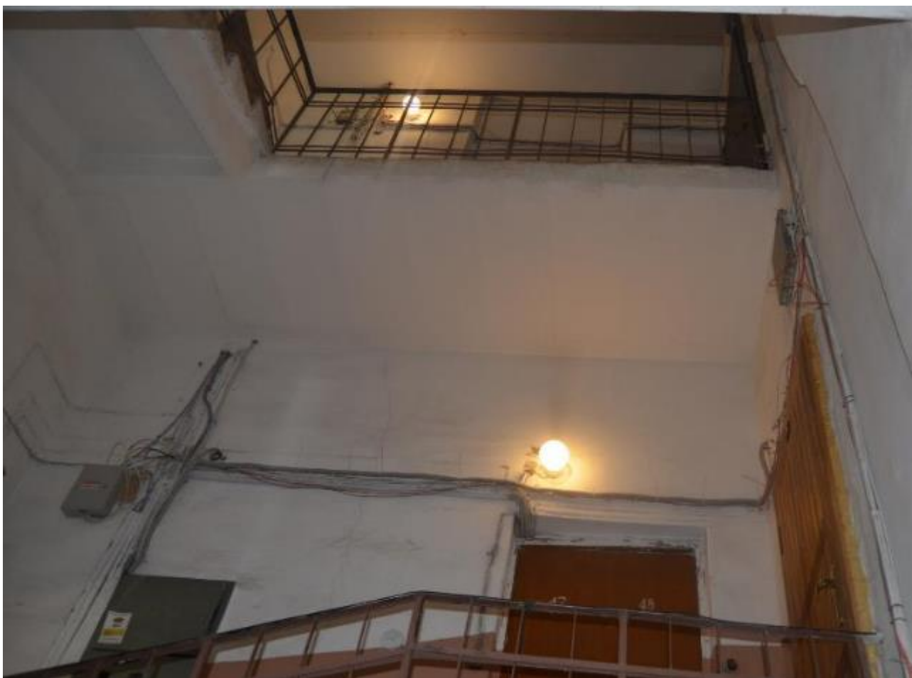
61. Выявленный объект культурного наследия «Дом Косиковского (А.М.Тупикова)». Черная лестница в центральной части северного дворового фасада (ЛК 4). Вид с юго-запада. Съемка 26.04.2021
