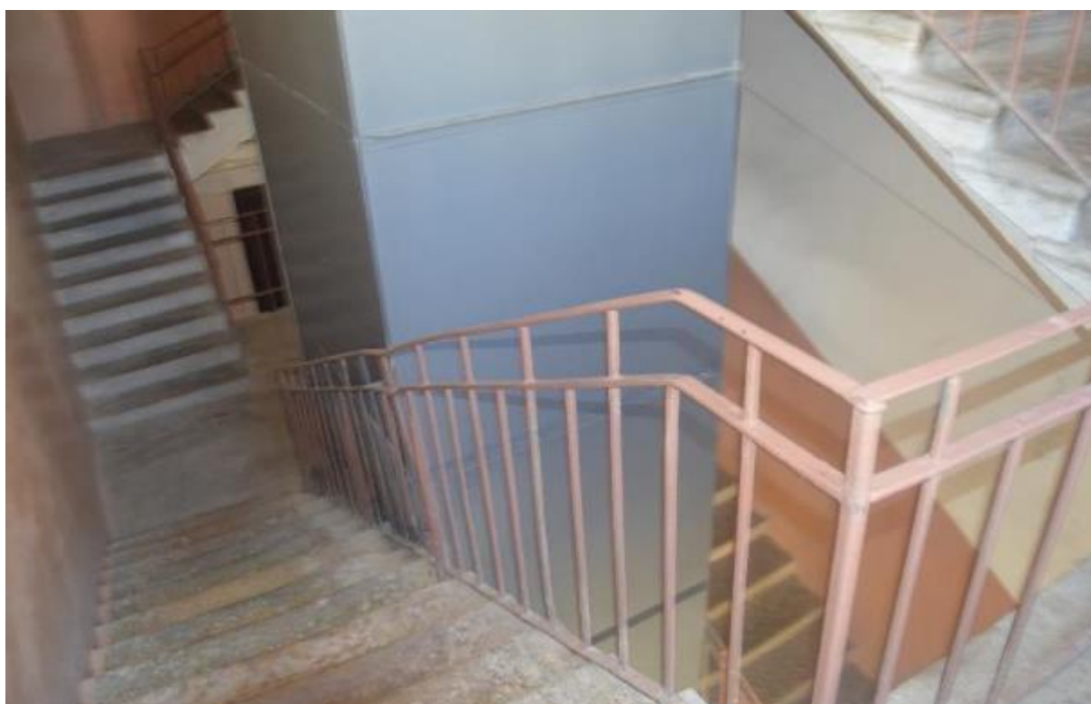
60. Выявленный объект культурного наследия «Дом Косиковского (А.М.Тупикова)». Черная лестница в центральной части северного дворового фасада (ЛК 4). Вид с юго-запада. Съемка 26.04.2021
