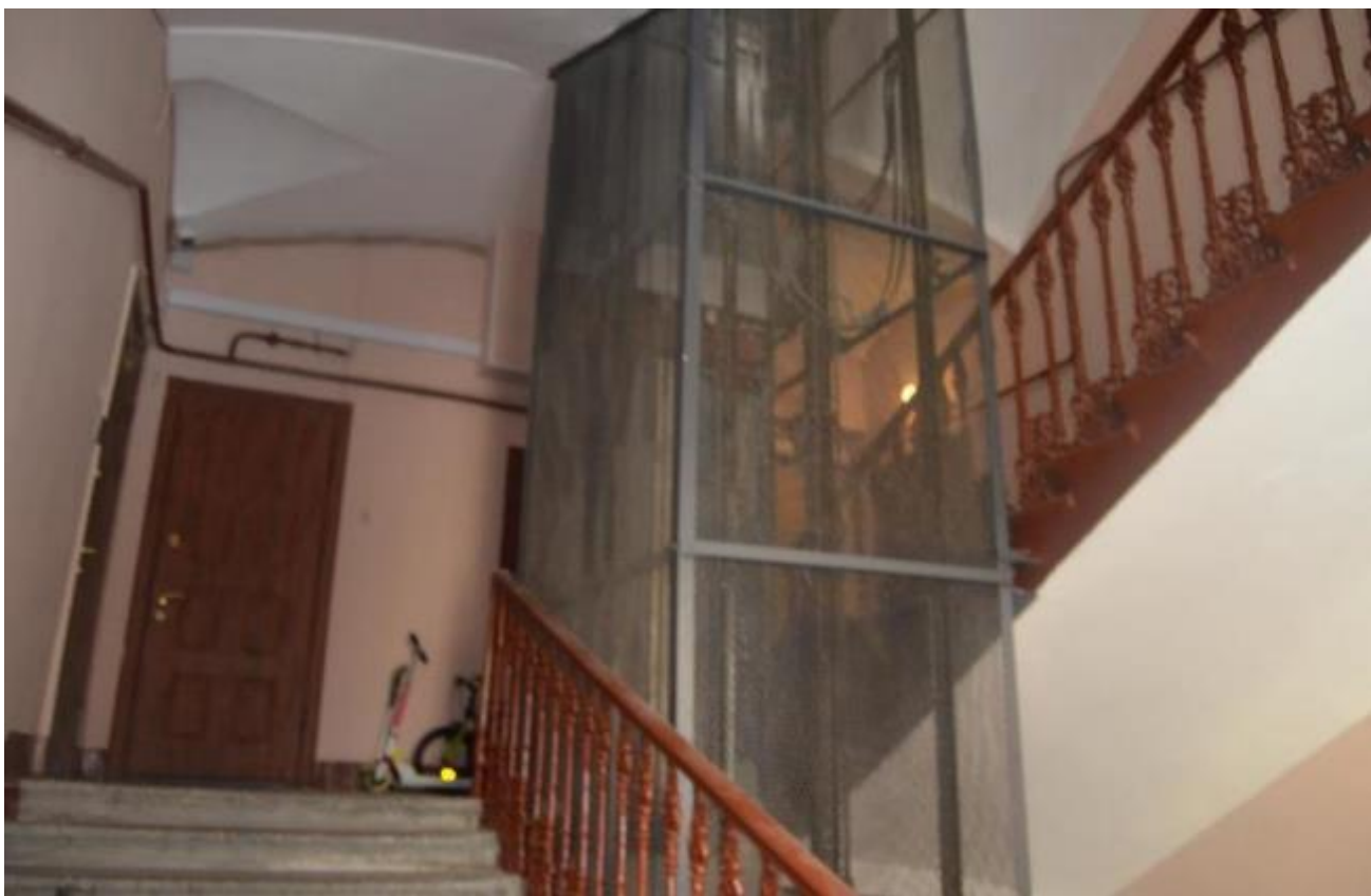
44. Выявленный объект культурного наследия «Дом Косиковского (А.М.Тупикова)». Парадная лестница восточного лицевого фасада (ЛК 1) в уровне второго этажа. Вид с запада. Съемка 26.04.2021
