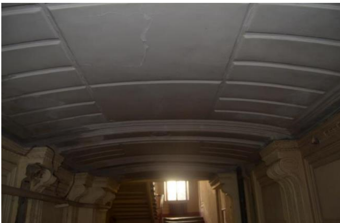
48. Выявленный объект культурного наследия «Дом Косиковского (А.М.Тупикова)». Парадная лестница южного лицевого фасада (ЛК 5). Оформление потолка вестибюля. Вид с юга. Съемка 26.04.2021
