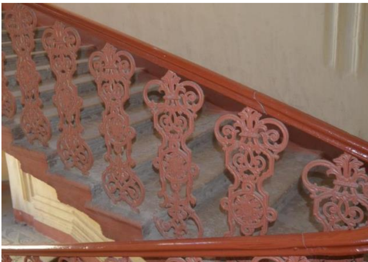
55. Выявленный объект культурного наследия «Дом Косиковского (А.М.Тупикова)». Парадная лестница южного лицевого фасада (ЛК 5). Историческое ограждение лестницы. Вид с востока. Съемка 26.04.2021
