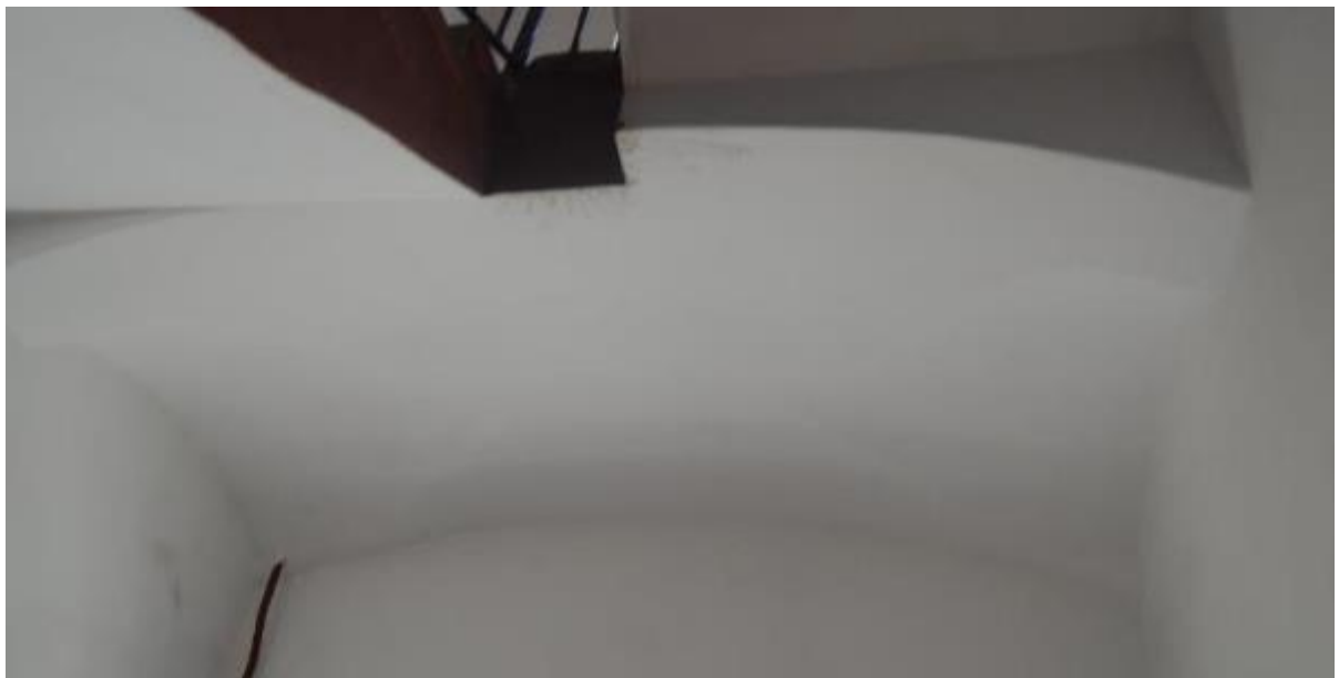
57. Выявленный объект культурного наследия «Дом Косиковского (А.М.Тупикова)». Черная лестница западного дворового фасада (ЛК 2). Конструкция площадок Вид с востока и с запада. Съемка 26.04.2021
