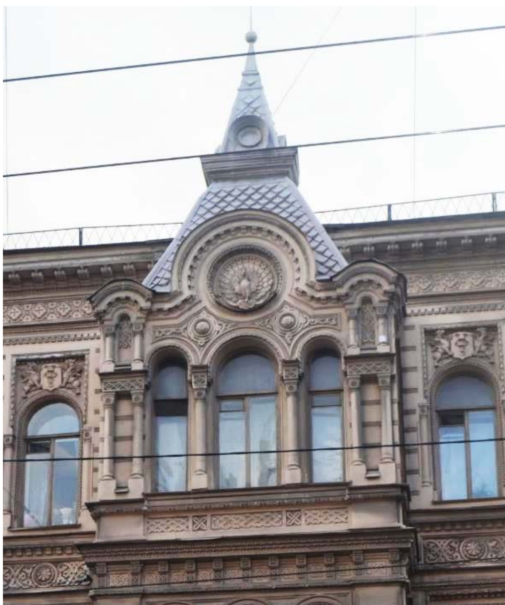
12. Выявленный объект культурного наследия «Дом Косиковского (А.М.Тупикова)». Оформление второго яруса и завершения эркеров восточного лицевого фасада. Вид с востока. Съемка 26.04.2021
