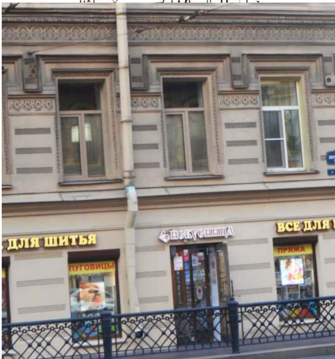
6. Выявленный объект культурного наследия «Дом Косиковского (А.М.Тупикова)». Оформление первого и второго этажей восточного лицевого фасада. Вид с востока. Съемка 26.04.2021
