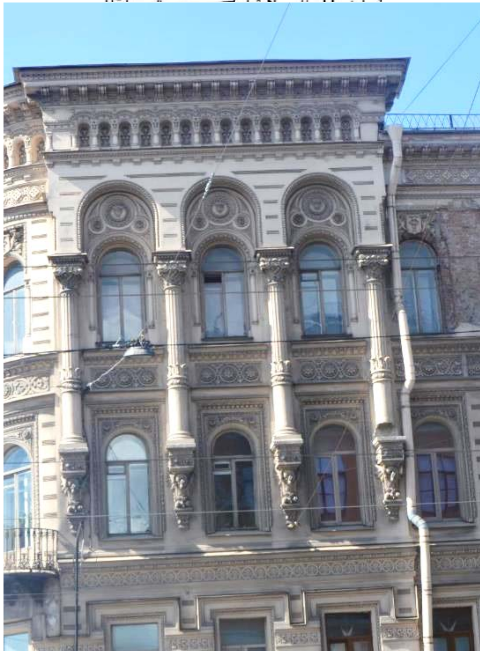
5. Выявленный объект культурного наследия «Дом Косиковского (А.М.Тупикова)». Оформление крайних южных осей восточного лицевого фасада. Вид с востока. Съемка 26.04.2021
