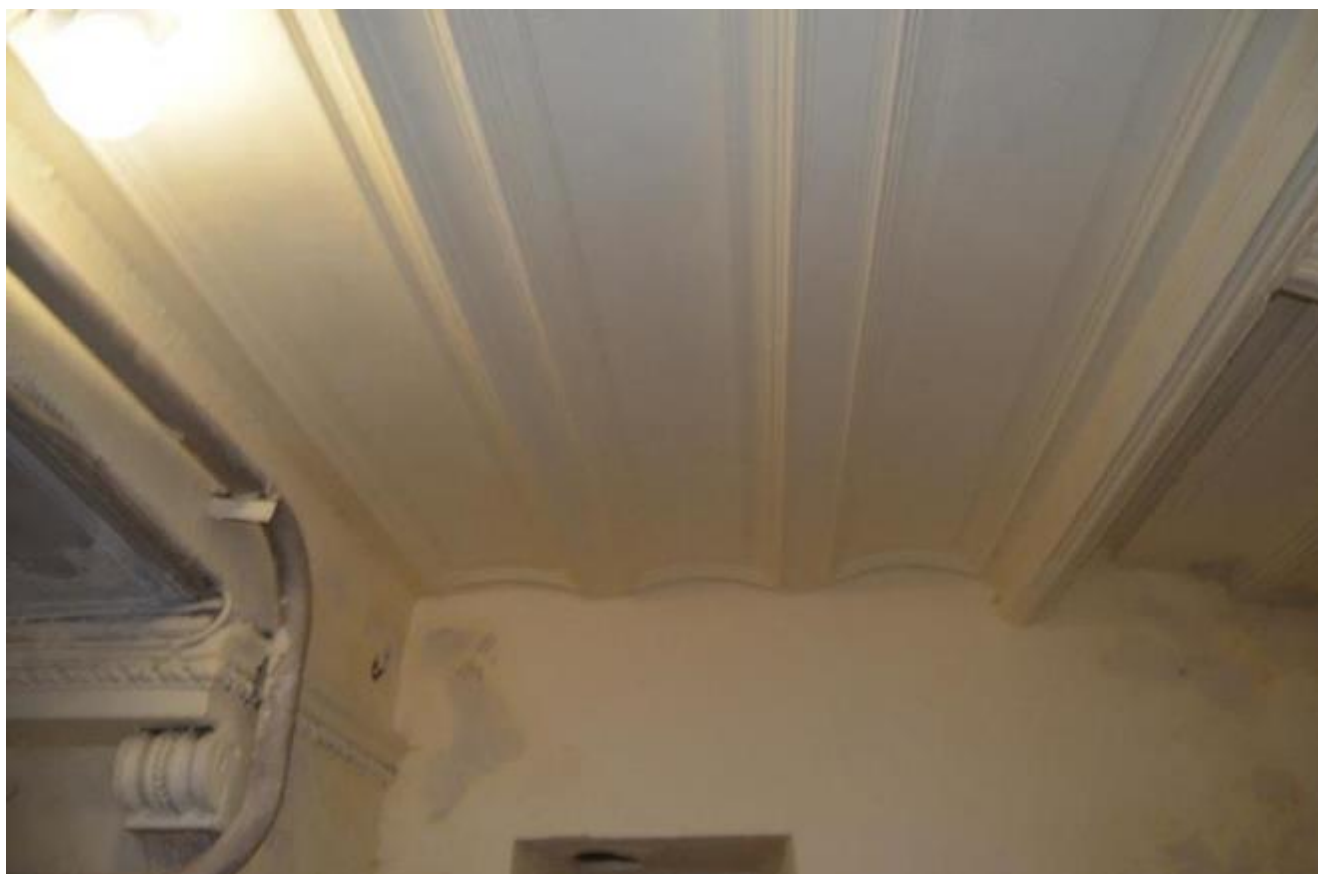
50. Выявленный объект культурного наследия «Дом Косиковского (А.М.Тупикова)». Парадная лестница южного лицевого фасада (ЛК 5). Оформление подшивки площадки в уровне первого этажа. Вид с запада. Съемка 26.04.2021
