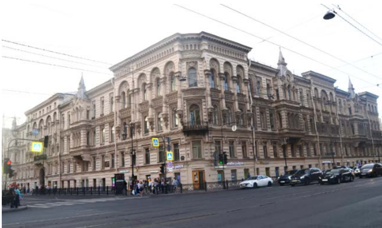
1. Выявленный объект культурного наследия «Дом Косиковского (А.М.Тупикова)». Лицевые (южный и восточный) фасады. Общий вид. Вид с юго-востока. Съемка 26.04.2021
