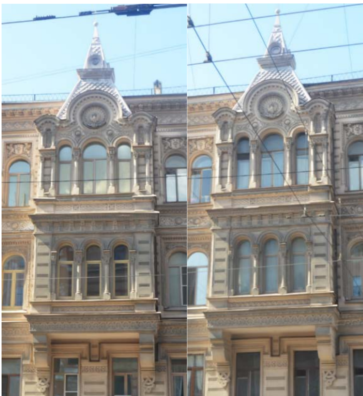
3. Выявленный объект культурного наследия «Дом Косиковского (А.М.Тупикова)». Эркеры восточного лицевого фасада. Вид с востока. Съемка 26.04.2021
