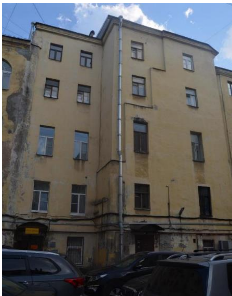
41. Выявленный объект культурного наследия «Дом Косиковского (А.М.Тупикова)». Центральная часть северного дворового фасада. Вид с севера. Съемка 26.04.2021
