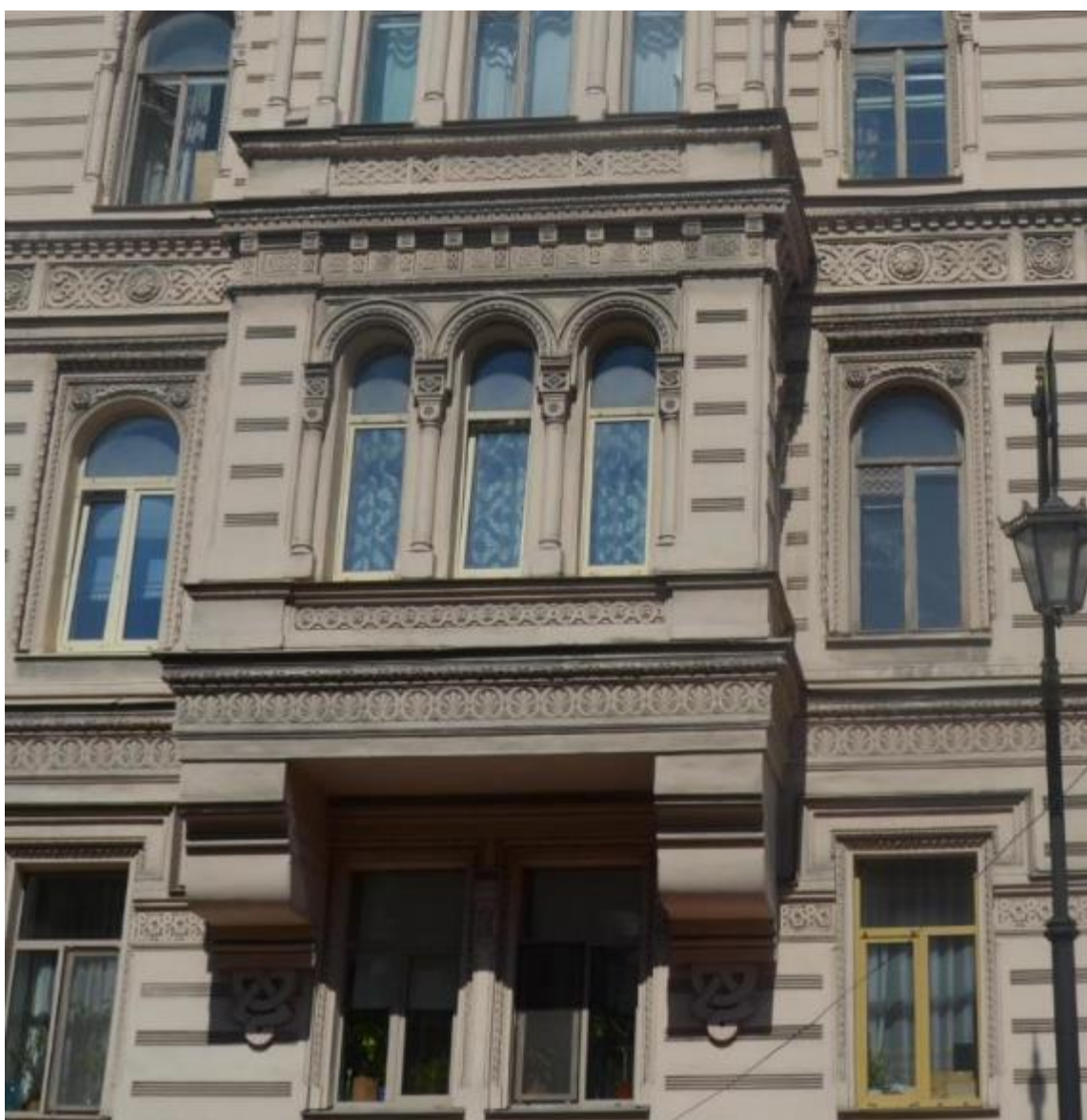
25. Выявленный объект культурного наследия «Дом Косиковского (А.М.Тупикова)». Оформление первого яруса эркеров южного лицевого фасада. Вид с юга. Съемка 26.04.2021
