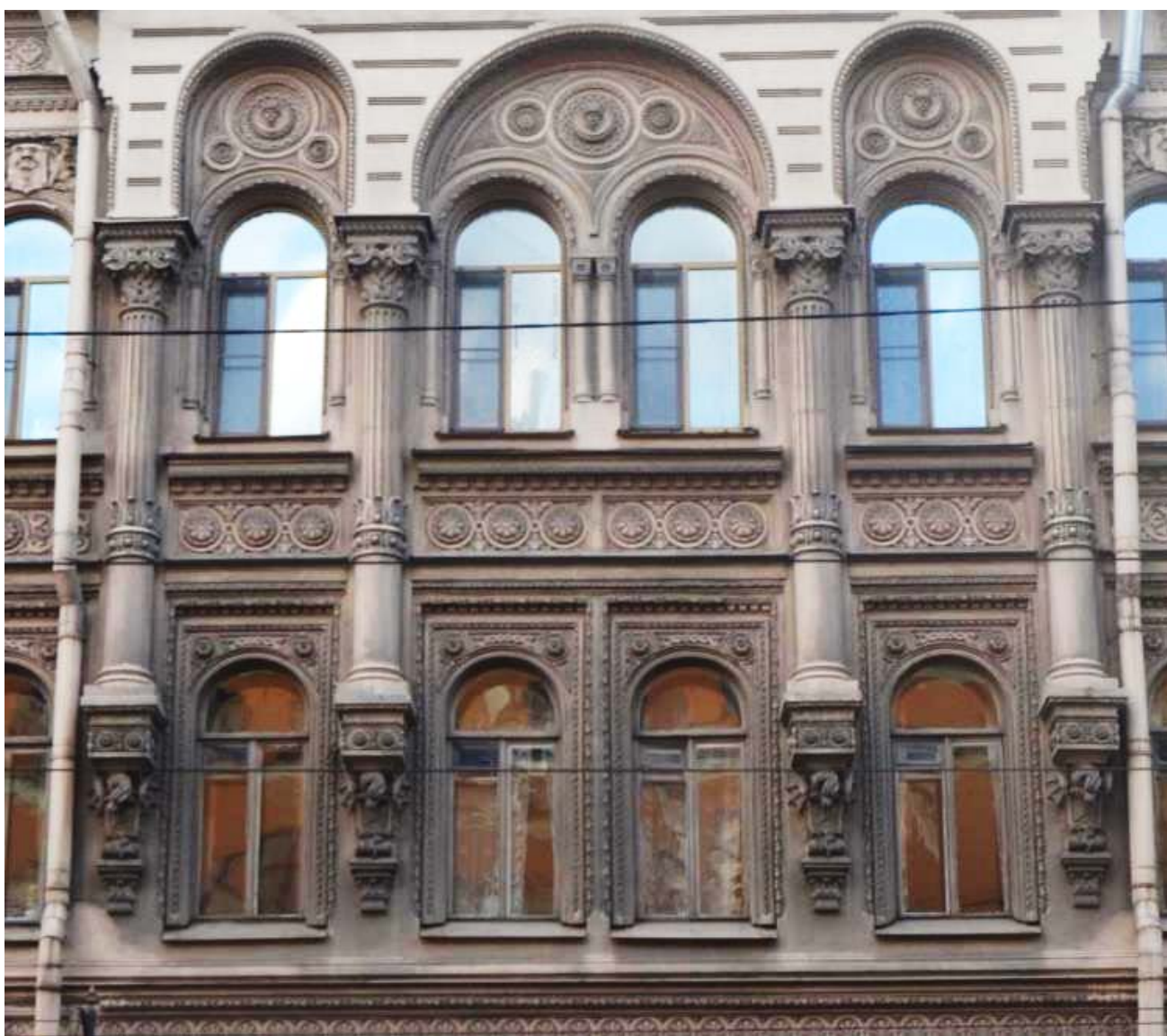
9. Выявленный объект культурного наследия «Дом Косиковского (А.М.Тупикова)». Оформление третьего и четвертого этажей по центральным и крайним осям восточного лицевого фасада. Вид с востока. Съемка 26.04.2021
