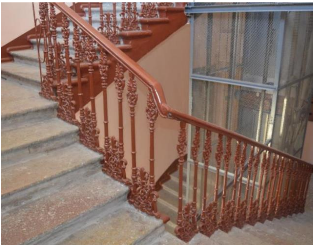
46. Выявленный объект культурного наследия «Дом Косиковского (А.М.Тупикова)». Парадная лестница восточного лицевого фасада (ЛК 1). Историческое ограждение лестницы. Вид с северо-востока. Съемка 26.04.2021
