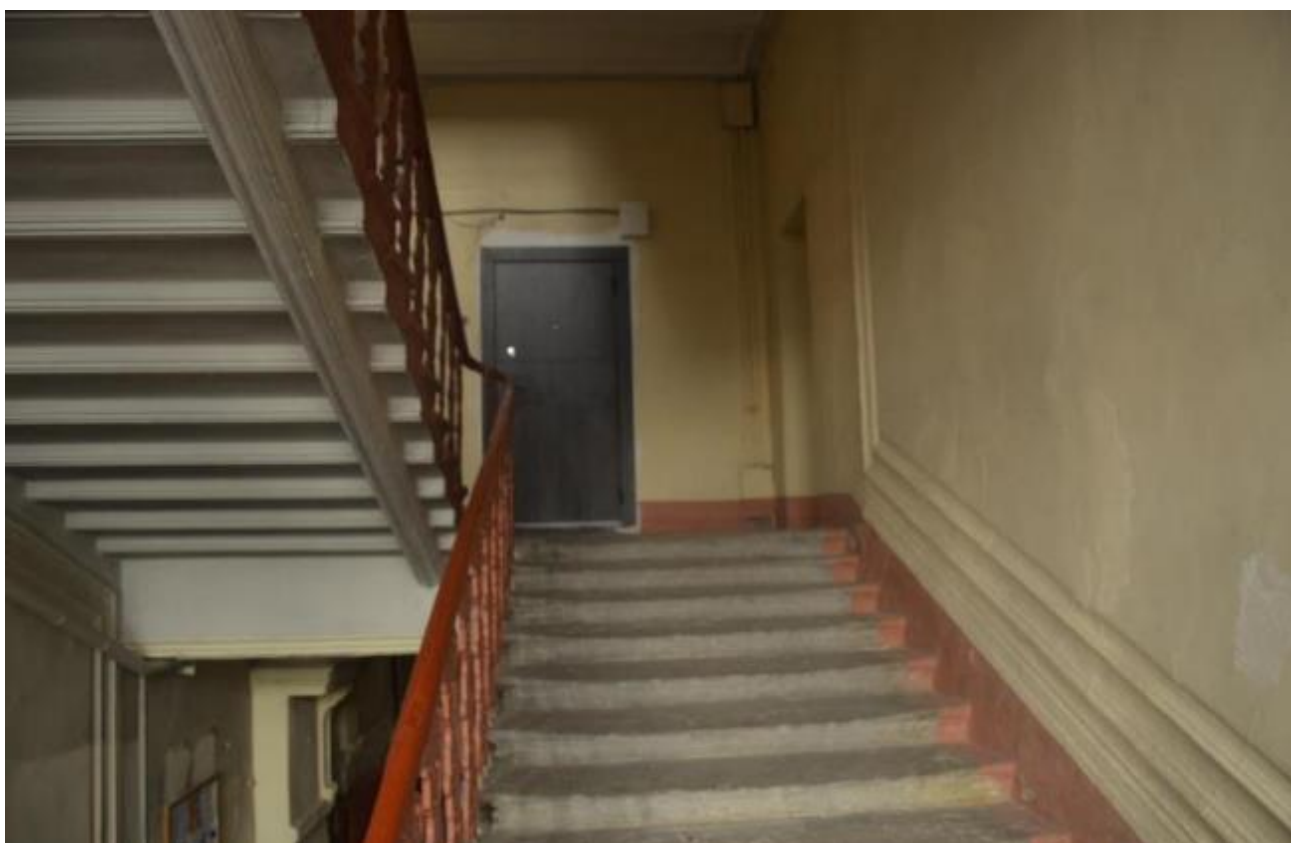
51. Выявленный объект культурного наследия «Дом Косиковского (А.М.Тупикова)». Парадная лестница южного лицевого фасада (ЛК 5). Конструкция лестничных маршей. Вид с запада. Съемка 26.04.2021
