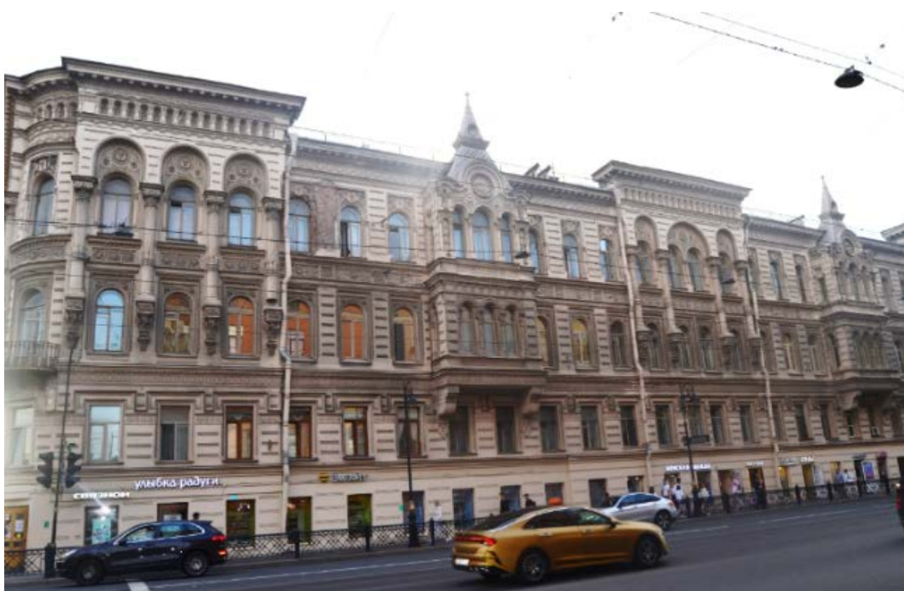
2. Выявленный объект культурного наследия «Дом Косиковского (А.М.Тупикова)». Восточный лицевой фасад по Литейному пр. Общий вид. Вид с востока. Съемка 26.04.2021
