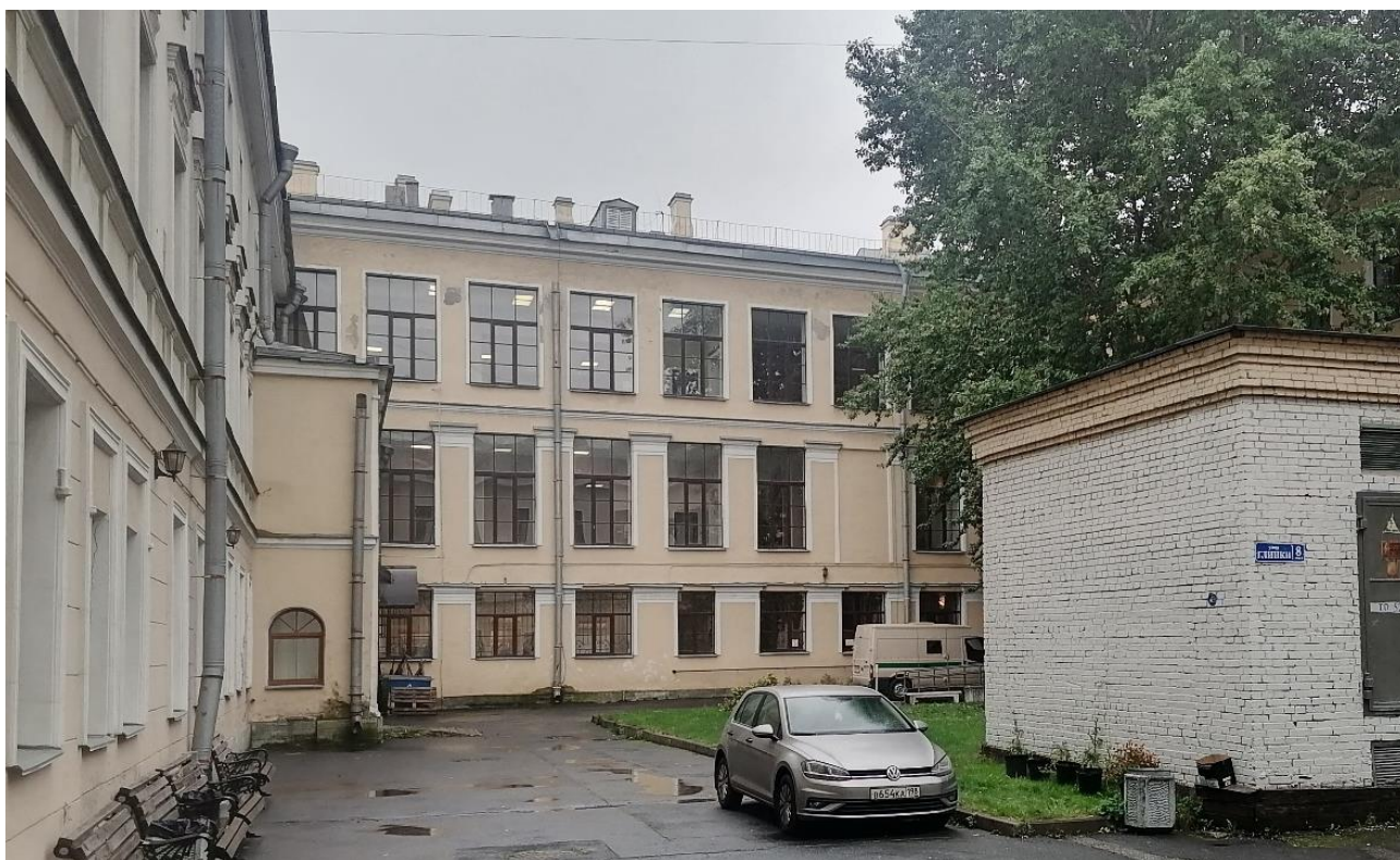
Фото 5. Здание детского отделения городской поликлиники №27. Южный фасад со стороны двора. Общий вид. 12.10.2022г.
