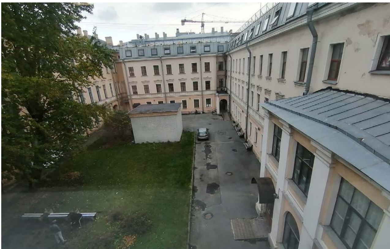
Фото 7. «Здание статс - секретариата Царства Польского» по адресу: г. Санкт-Петербург, ул. Глинки, д. 8, лит. А (ул. Римского-Корсаково, д.35). Дворовая территория. 12.10.2022г.
