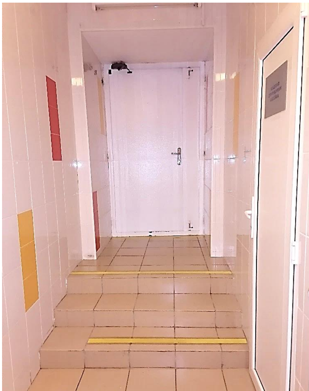
Фото 38. Здание детского отделения городской поликлиники №27. Коридор перед комплексом лечебного бассейна на первом этаже. Пом.30 (1-Н). 12.10.2022г.
