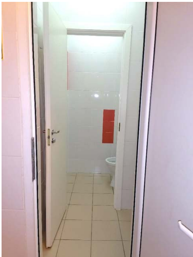
Фото 40. Здание детского отделения городской поликлиники №27. Санитарные комнаты Пом.31,34 (1-Н). 12.10.2022г.
