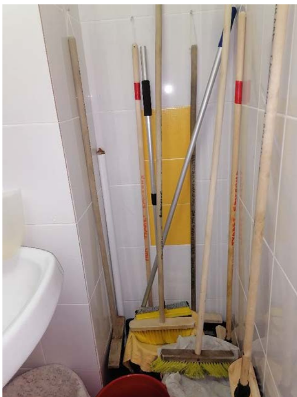
Фото 44. Здание детского отделения городской поликлиники №27. Санитарные комнаты Пом.32 (1-Н). 12.10.2022г.
