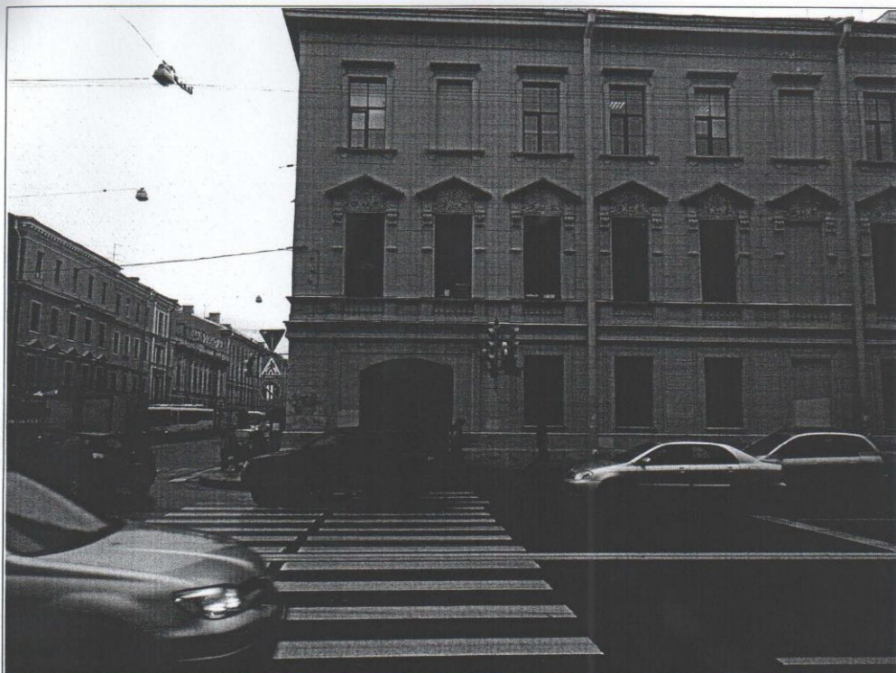
Фрагмент лицевого фасада по пр. Римского-Корсакова. Съемка 04.10.2012. В.Ю.Белая
