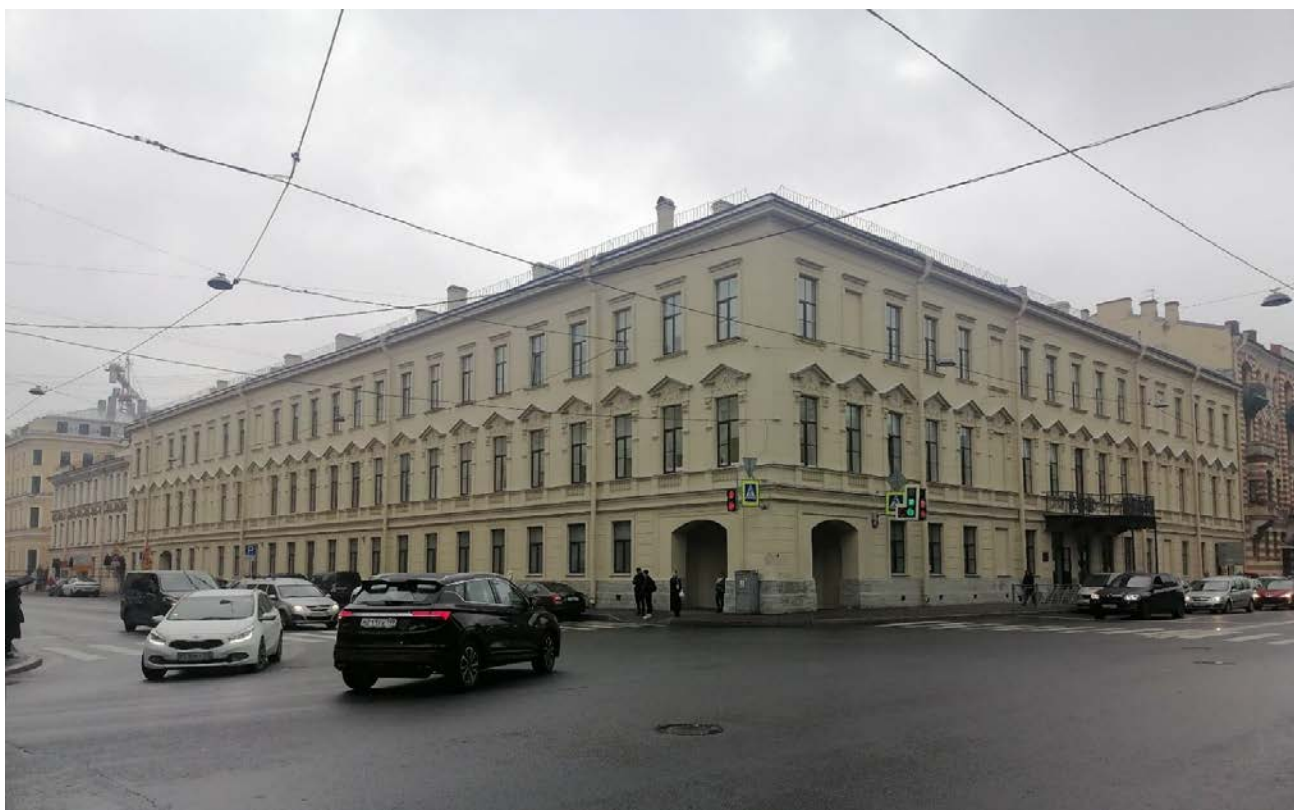
Фото 1. «Здание статс - секретариата Царства Польского» по адресу: г. Санкт-Петербург, ул. Глинки, д. 8, лит. А (ул. Римского-Корсаково, д.35). Общий вид на перекрестке улиц Глинки и Римского Корсаково детского отделения городской поликлиники №27. 12.10.2022г.
