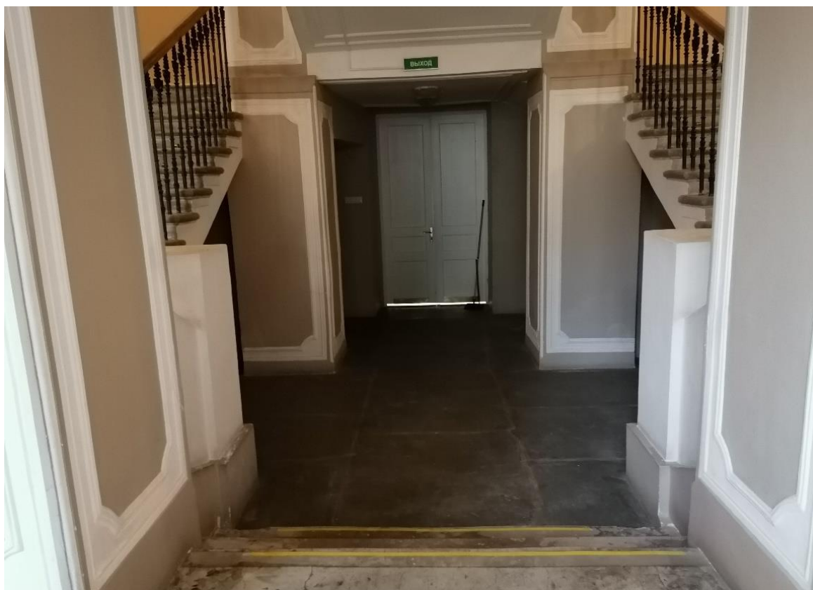
Фото 28. Здание детского отделения городской поликлиники №27. Центральная лестница, первый этаж. 5ЛК, III. 12.10.2022г.
