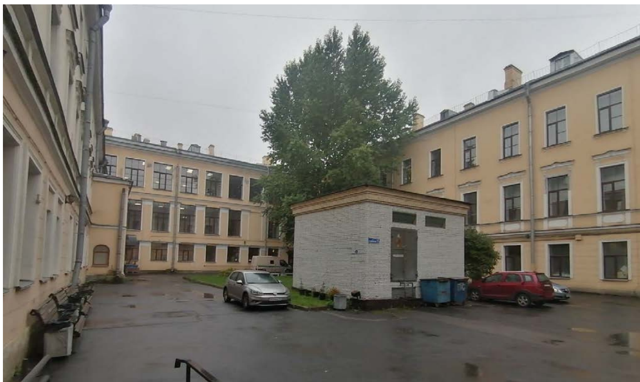
Фото 3. «Здание статс - секретариата Царства Польского» по адресу: г. Санкт-Петербург, ул. Глинки, д. 8, лит. А (ул. Римского-Корсаково, д.35). Общий вид с стороны двора на здание детского отделения городской поликлиники №27. 12.10.2022г.
