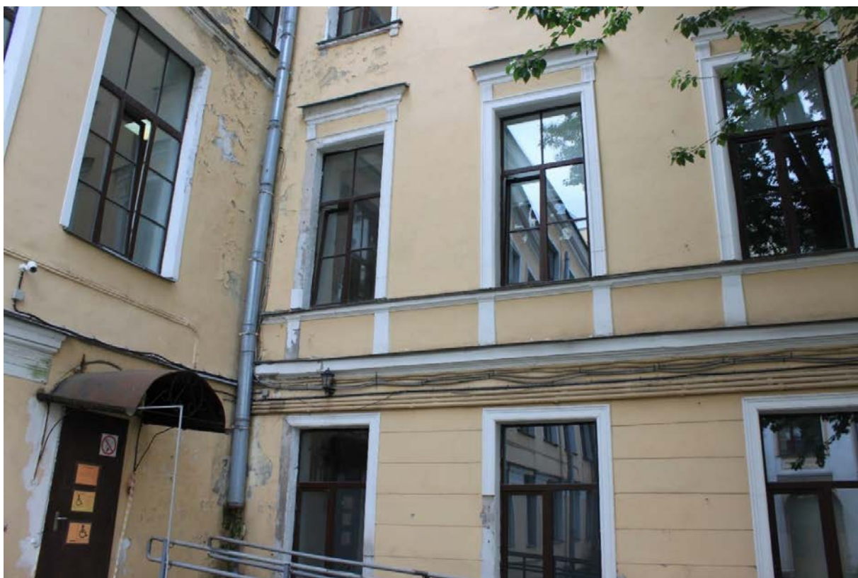
Фото 19. Здание детского отделения городской поликлиники №27. Фрагмент западного фасада со стороны двора – первый и второй этажи. 12.10.2022г.
