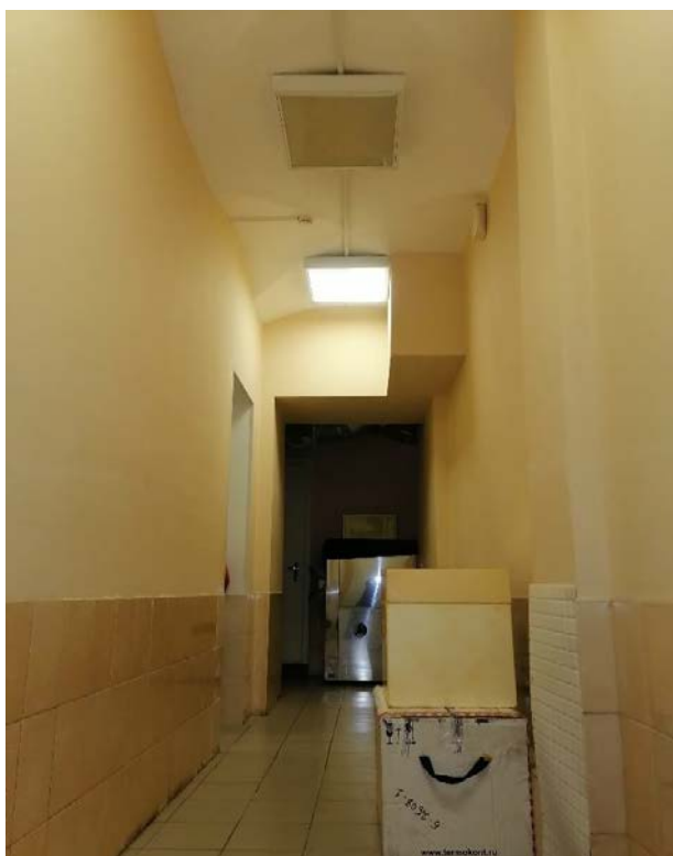
Фото 46. Здание детского отделения городской поликлиники №27. Коридор первого этажа. 6ЛК, II. 12.10.2022г.
