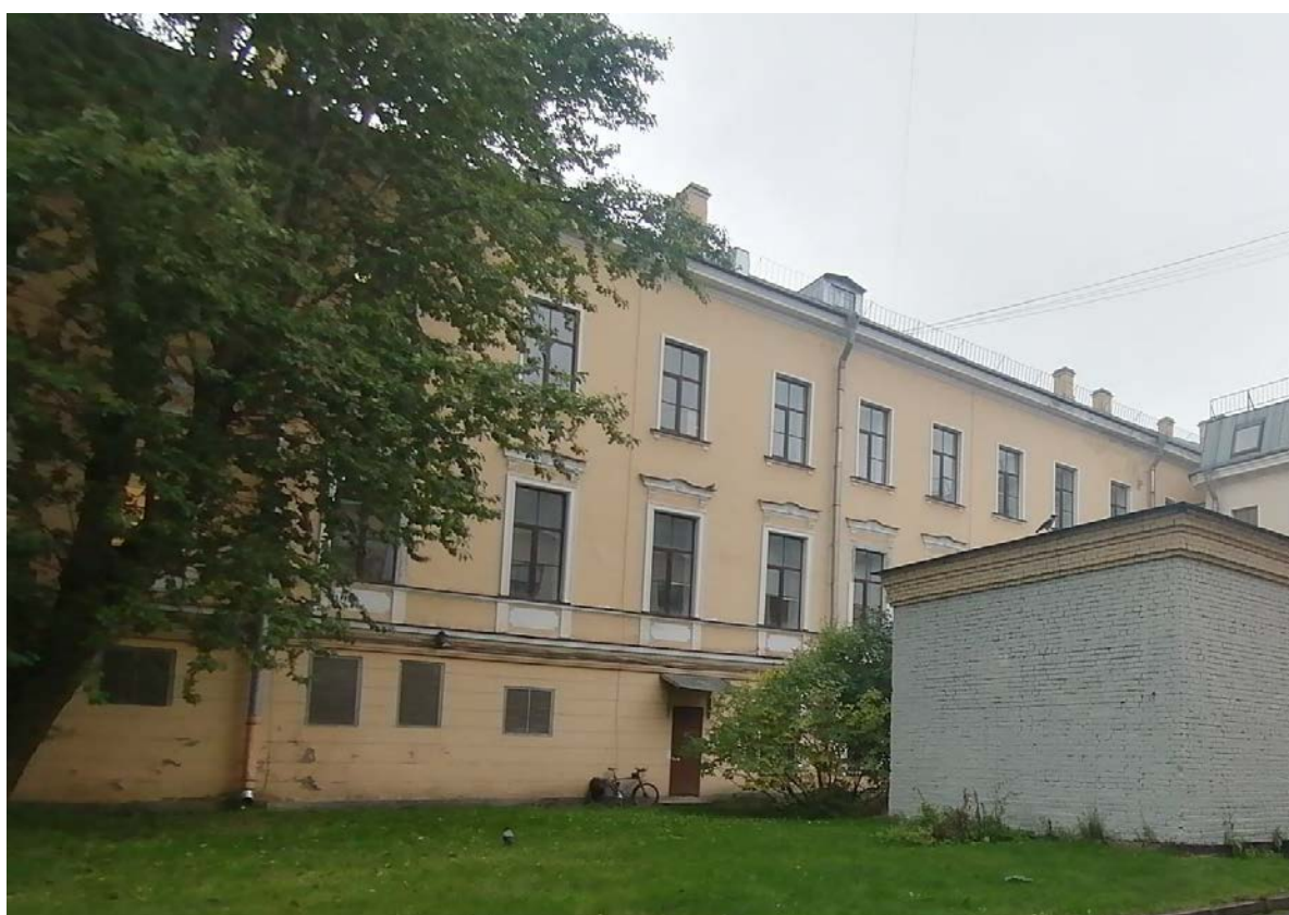
Фото 18. Здание детского отделения городской поликлиники №27. Западный фасад со стороны двора (у северной части здания). 12.10.2022г.
