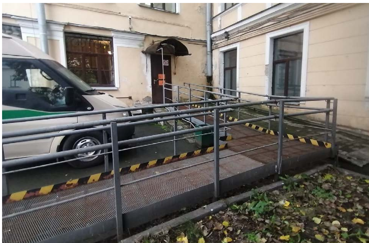
Фото 16. Здание детского отделения городской поликлиники №27. Фрагмент южного фасада со стороны двора – первый этаж, служебный вход и пандус в примыкании частей. 12.10.2022г.
