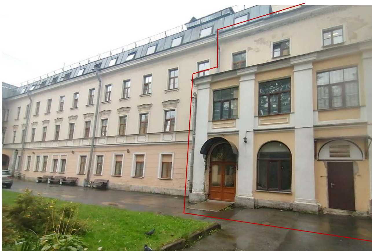
Фото 6. «Здание статс - секретариата Царства Польского» по адресу: г. Санкт-Петербург, ул. Глинки, д. 8, лит. А (ул. Римского-Корсаково, д.35). Восточный фасад со стороны двора. Общий вид. Примыкание части здания детского отделения городской поликлиники №27 к части здания, где размещается пенсионный фонд. 12.10.2022г.
