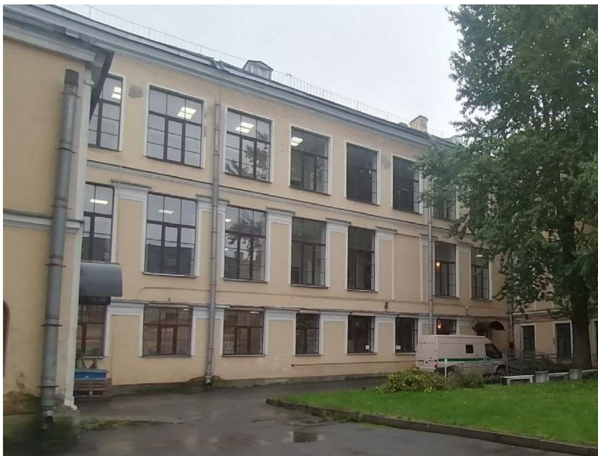
Фото 14. Здание детского отделения городской поликлиники №27. Южный фасад со стороны двора. 12.10.2022г.
