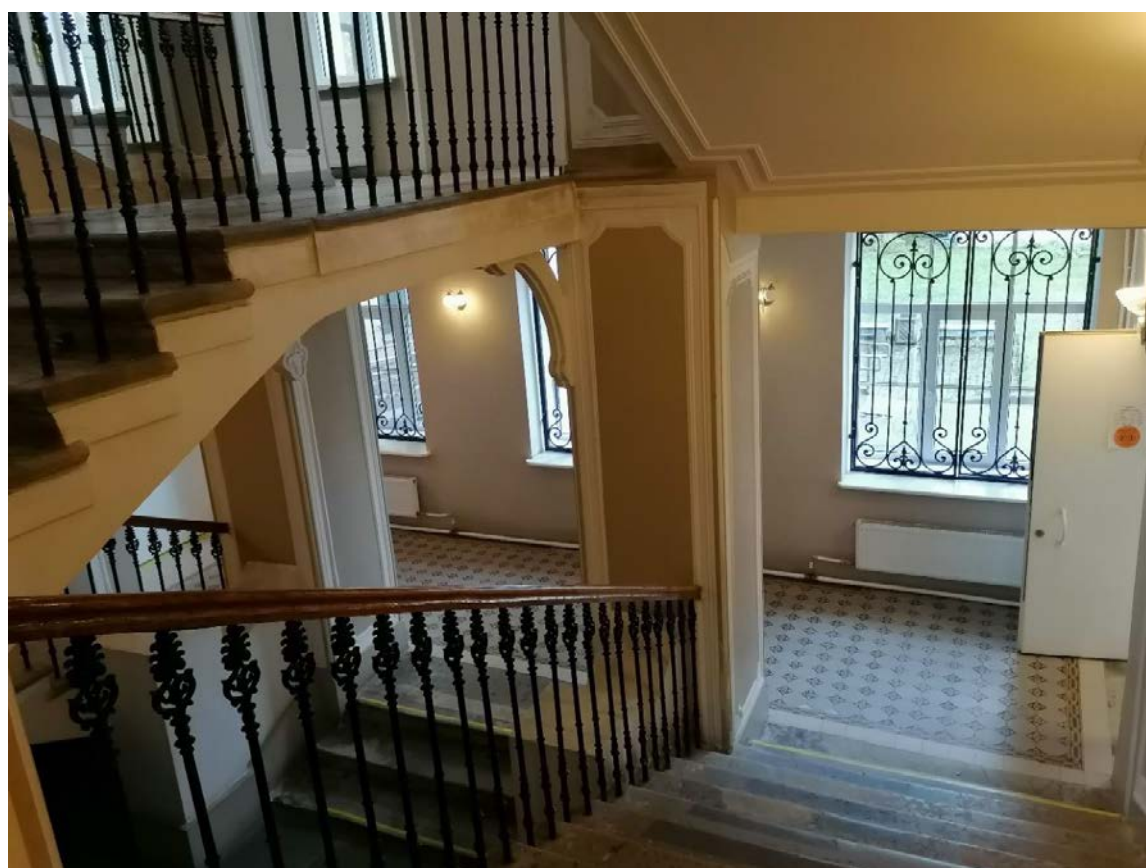
Фото 29. Здание детского отделения городской поликлиники №27. Центральная лестница, лестничные марши с первого этажа на второй этаж. 5ЛК, III. 12.10.2022г.
