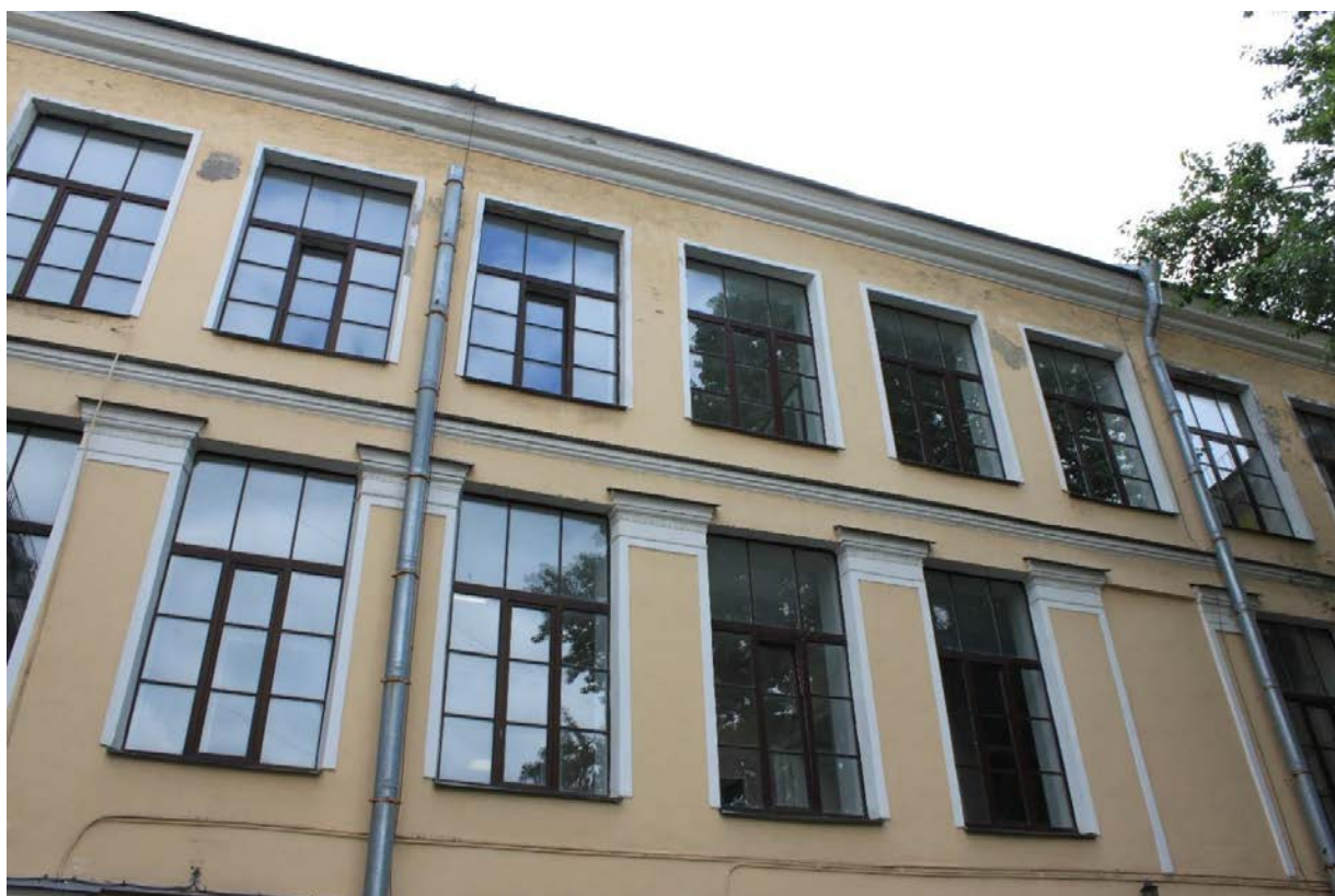
Фото 15. Здание детского отделения городской поликлиники №27. Фрагмент южного фасада со стороны двора – второй и третий этажи. 12.10.2022г.
