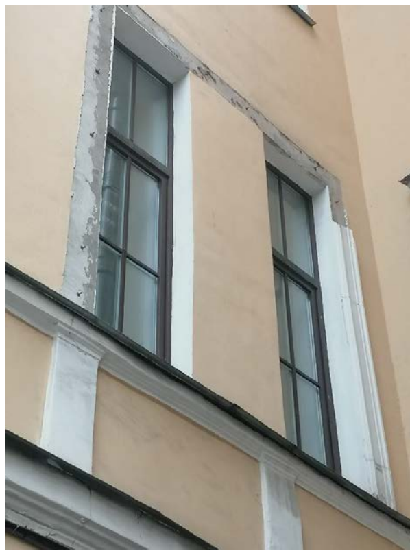
Фото 25. Здание детского отделения городской поликлиники №27. Состояние отделки оконных проемов второго этажа в примыкании к части здания пенсионного фонда. 12.10.2022г.
