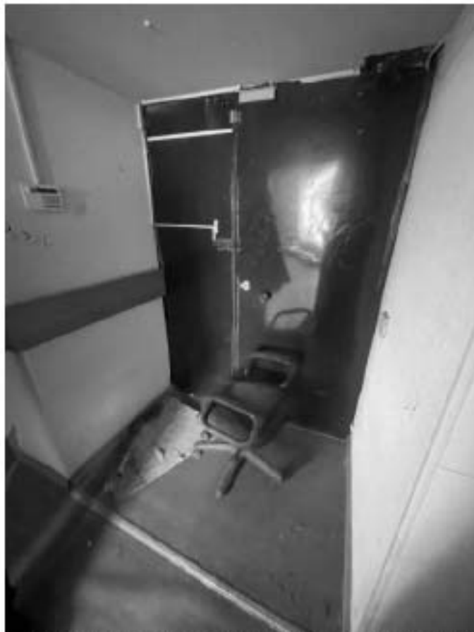
Фото 18 Интерьер части пом. 1-Н выявленного объекта культурного наследия «Дом Б.Е. Фурмана», по адресу: Санкт-Петербург, ул. Смольчкова, д. 15-17, лит. А
