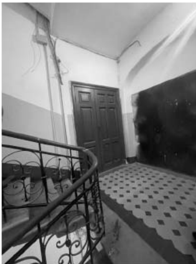
Фото 5 Интерьер части пом. 1-Н выявленного объекта культурного наследия «Дом Б.В.Фурмана», по адресу: Санкт-Петербург, ул. Смольячкова, д. 15-17, лит. А
