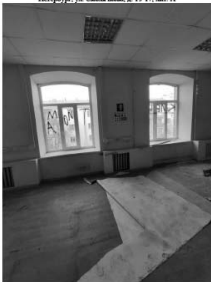
Фото 16 Интерьер части пом. 1-Н выявленного объекта культурного наследия «Дом Б.Е. Фурмана», по адресу: Санкт-Петербург, ул. Смольчкова, д. 15-17, лит. А
