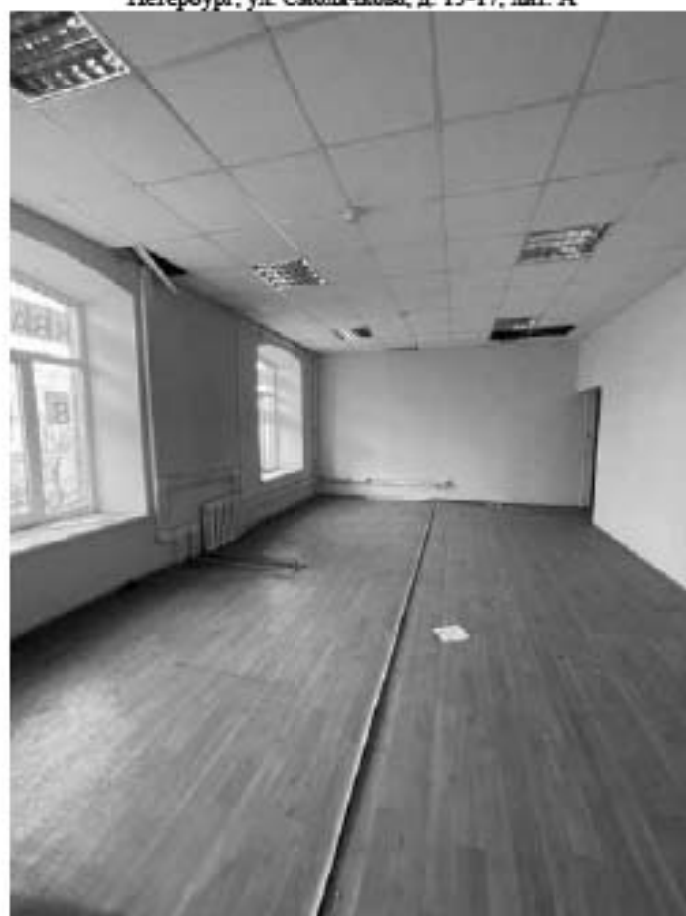
Фото 10 Интерьер части пом. 1-Н выявленного объекта культурного наследия «Дом Б.Е. Фурмана», по адресу: Санкт-Петербург, ул. Смольчкова, д. 15-17, лит. А
