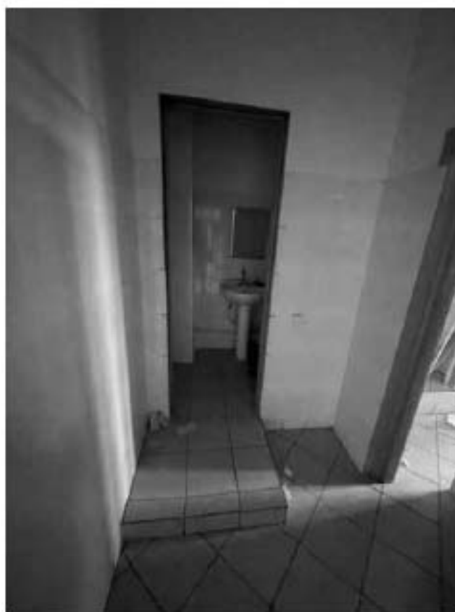
Фото 8 Интерьер части пом. 1-Н выявленного объекта культурного наследия «Дом Б.Е. Фурмана», по адресу: Санкт-Петербург, ул. Смольчкова, д. 15-17, лит. А
