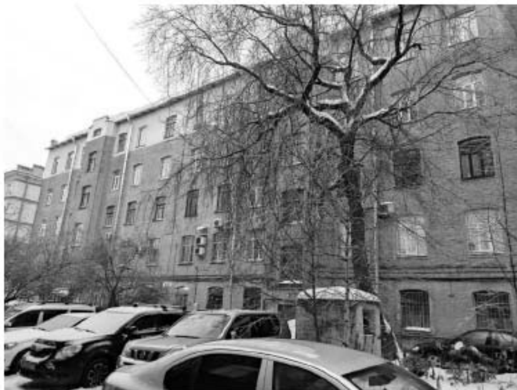
Фото 3 Фрагмент дворового фасада выявленного объекта культурного наследия «Дом Б.Е.Фурмана», по адресу: Санкт-Петербург, ул. Смольячкова, д. 15-17, лит. А
