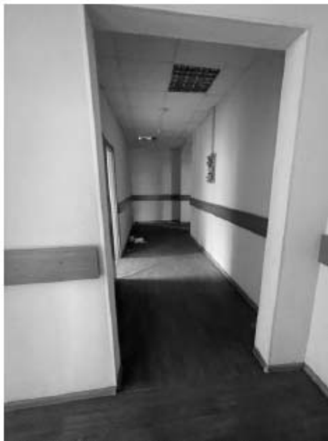
Фото 21 Интерьер части пом. 1-Н выявленного объекта культурного наследия «Дом Б.Е. Фурмана», по адресу: Санкт-Петербург, ул. Смольчкова, д. 15-17, лит. А
