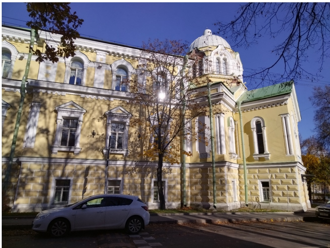
5. Фрагмент лицевого фасада. Вид с ул. Малой. Дата съемки: 09.10.2022
