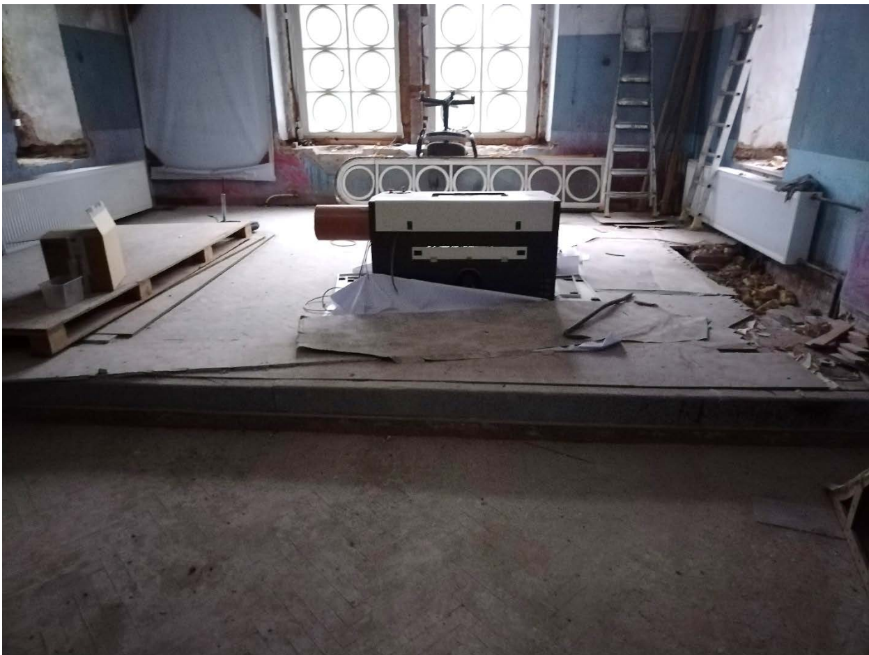
17. Церковный зал. Позднее покрытие пола. Алтарь. Дата съемки: 03.10.2022
