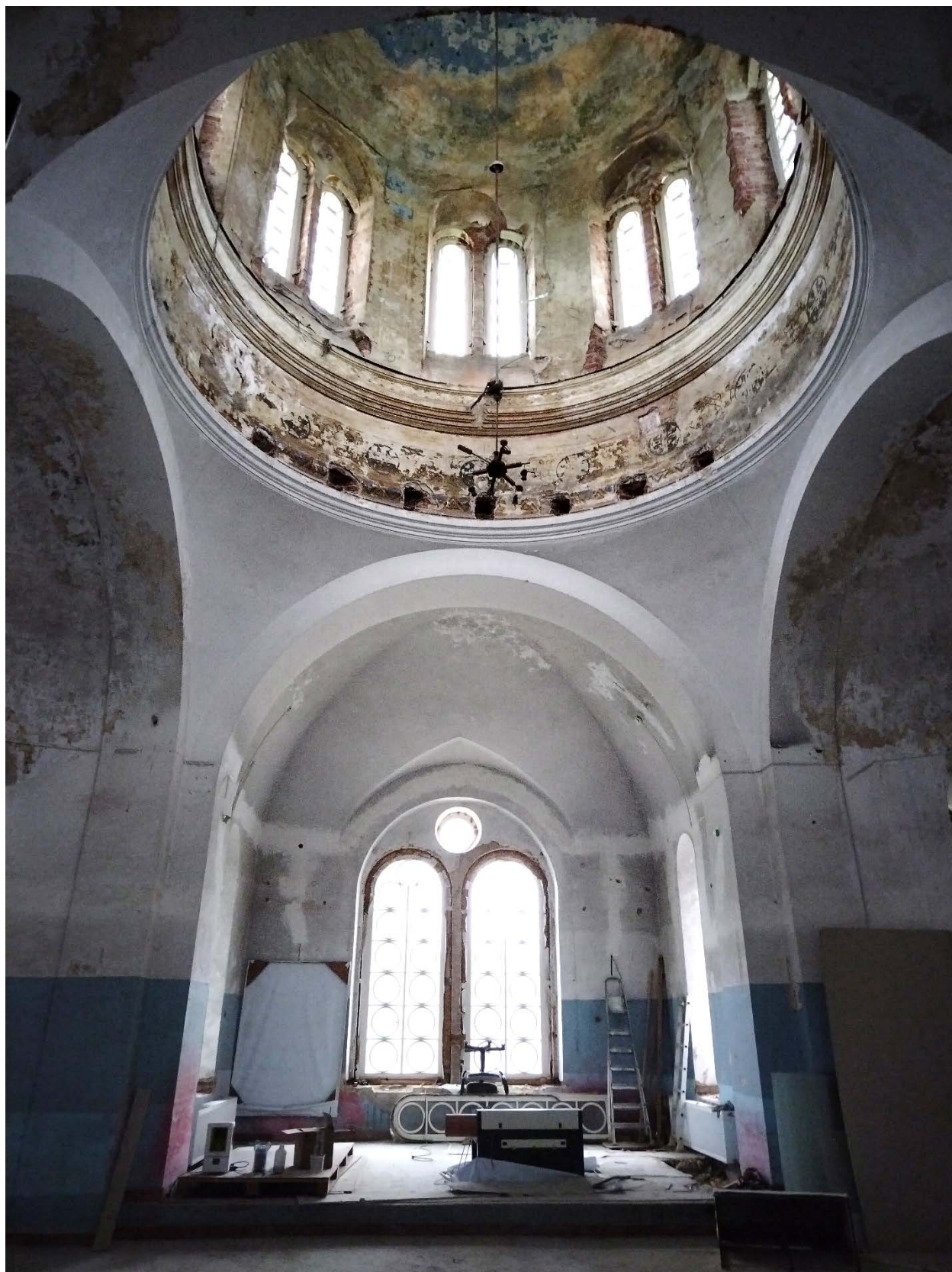
1. Церковный зал. Вид на алтарную часть и подкупольное пространство. Дата съемки: 03.10.2022
