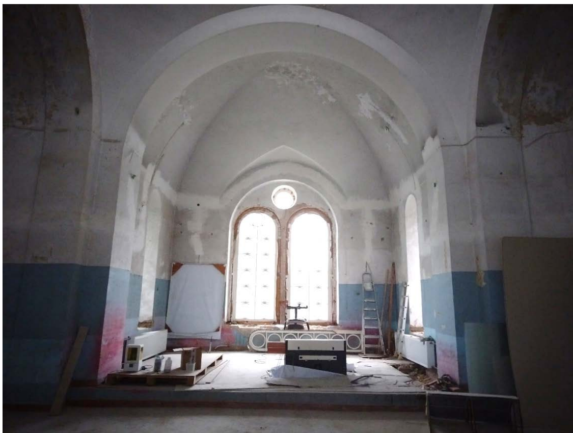
5. Церковный зал. Вид на алтарную часть. Дата съемки: 03.10.2022
