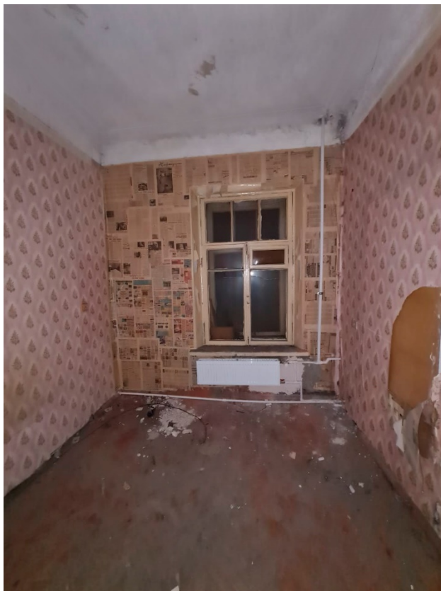
6. Выявленный объект культурного наследия «Дом М.Д. Усова» по адресу: г. Санкт-Петербург, ул. Смоленская, д. 1, лит. Д. Квартира 9 (помещение 3/15,2)
