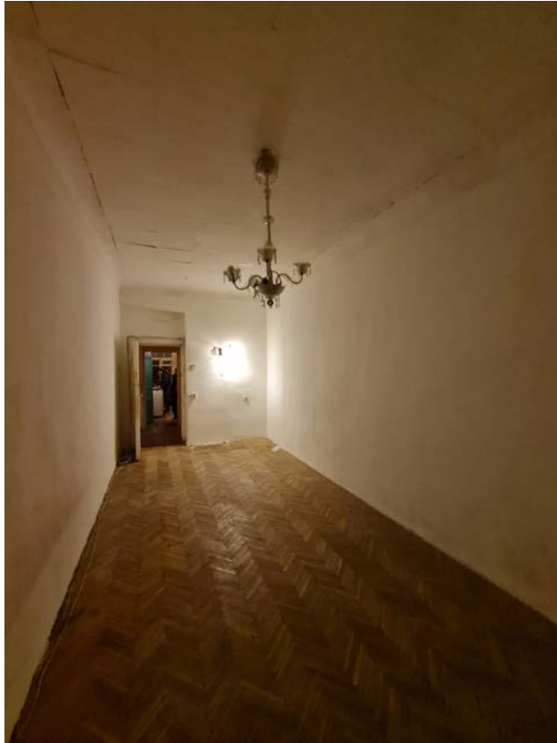
13. Выявленный объект культурного наследия «Дом М.Д. Усова» по адресу: г. Санкт-Петербург, ул. Смоленская, д. 1, лит. Д. Квартира 9 (помещение 7/20,1)
