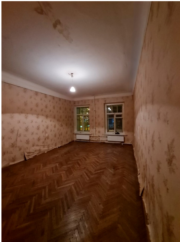
15. Выявленный объект культурного наследия «Дом М.Д. Усова» по адресу: г. Санкт-Петербург, ул. Смоленская, д. 1, лит. Д. Квартира 9 (помещение 8/27,1)
