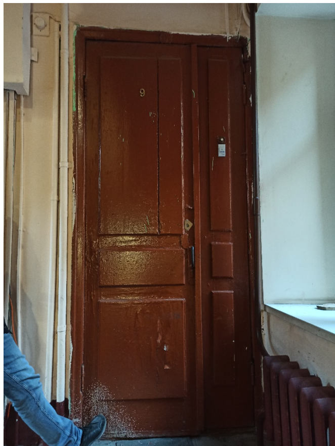
4. Выявленный объект культурного наследия «Дом М.Д. Усова» по адресу: г. Санкт-Петербург, ул. Смоленская, д. 1, лит. Д. Вход в квартиру 9.
