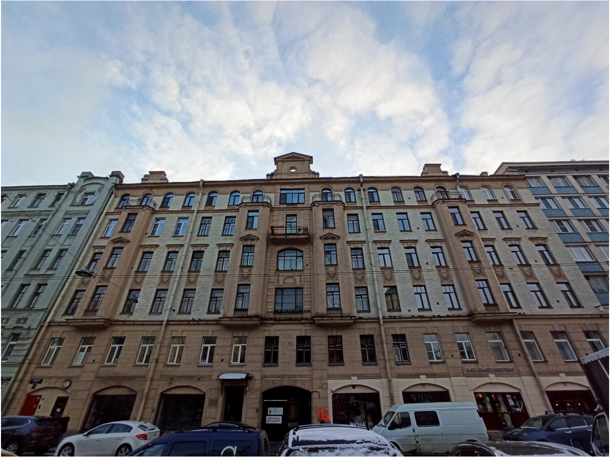
1. Выявленный объект культурного наследия «Дом М.Д. Усова» по адресу: г. Санкт-Петербург, ул. Смоленская, д. 1, лит. Д. Главный фасад.
