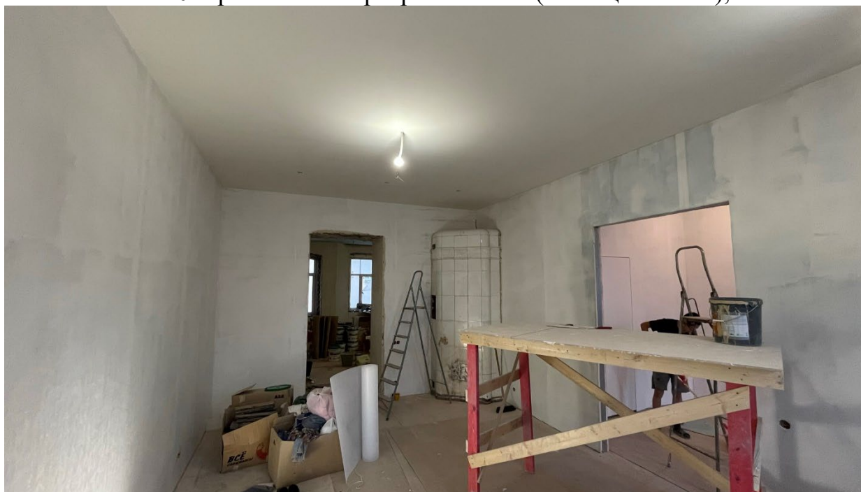
21.Фрагмент интерьера комнаты (помещение №2);
