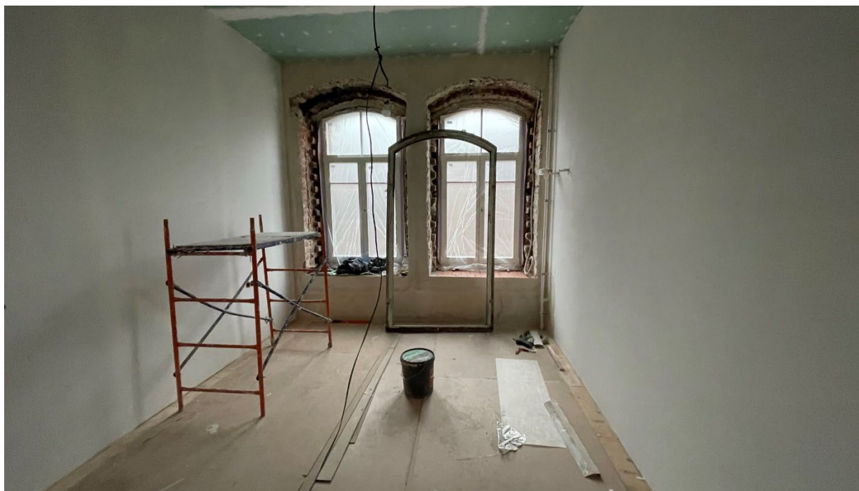
10.Фрагмент интерьера комнаты (помещение №1);
