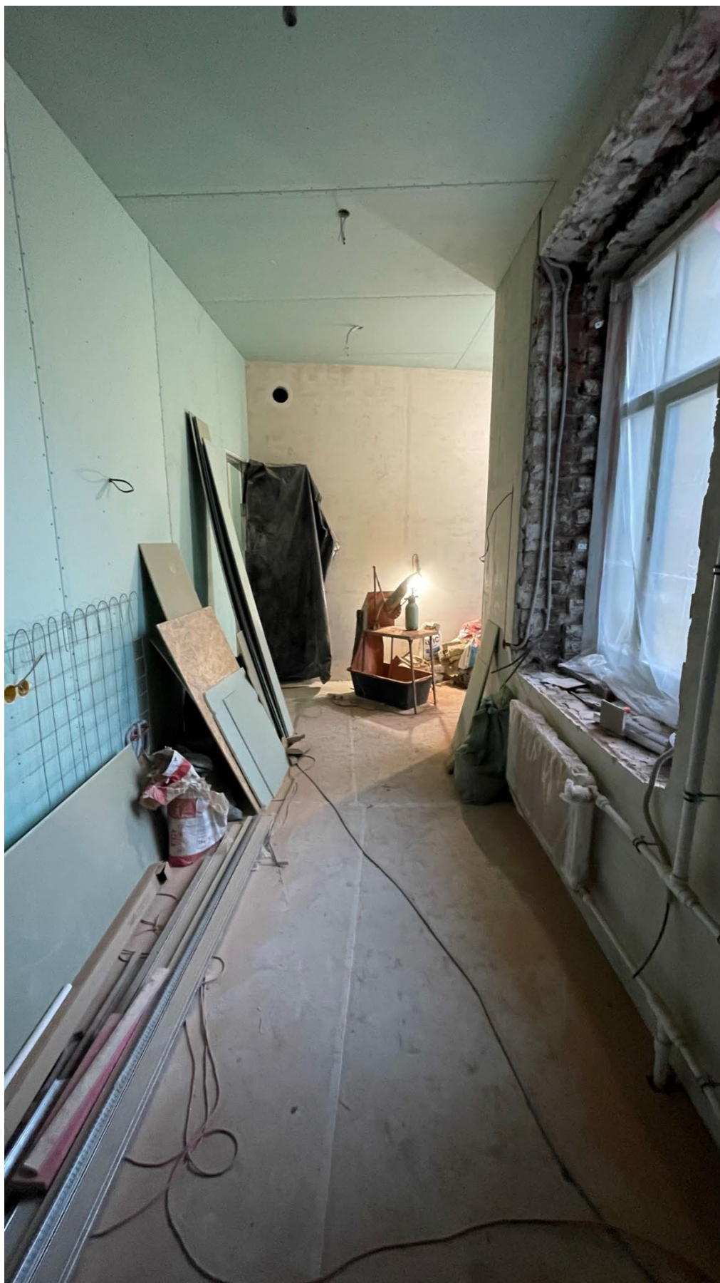
24. Фрагмент интерьера кухни (помещение №5);
