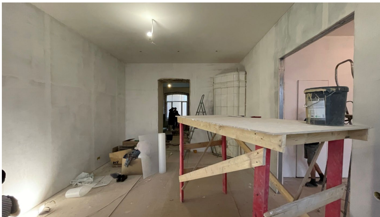
20.Фрагмент интерьера комнаты (помещение №2);
