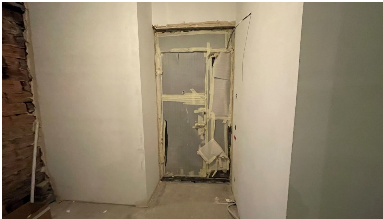
4. Вид на входную дверь в квартире №19;
