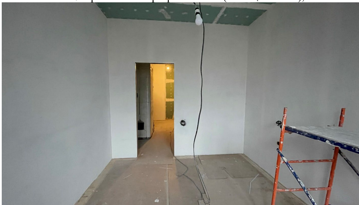
11.Фрагмент интерьера комнаты (помещение №1);
