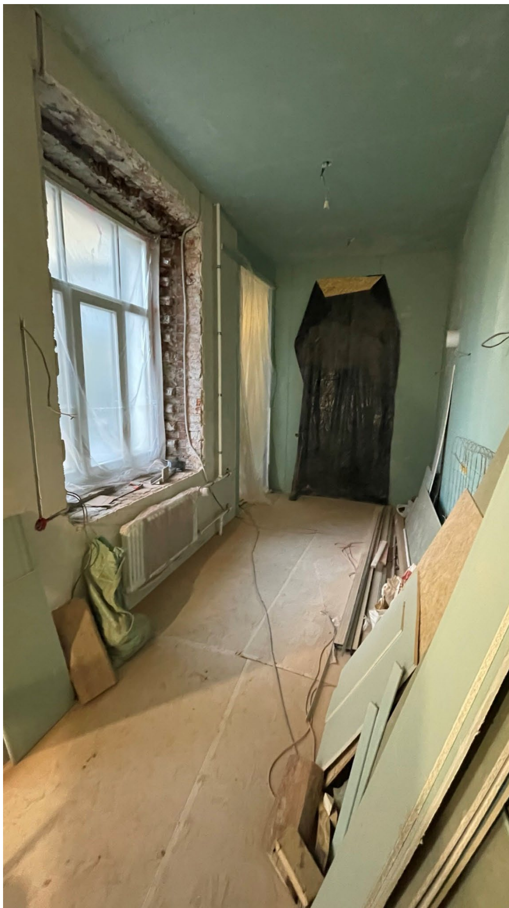
25. Фрагмент интерьера кухни (помещение №5);
