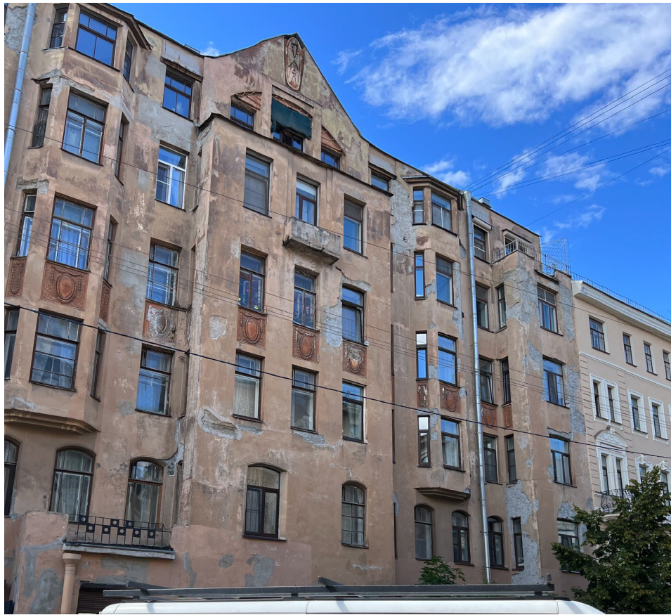
Фото 1. Фасад 1-10. Общий вид
