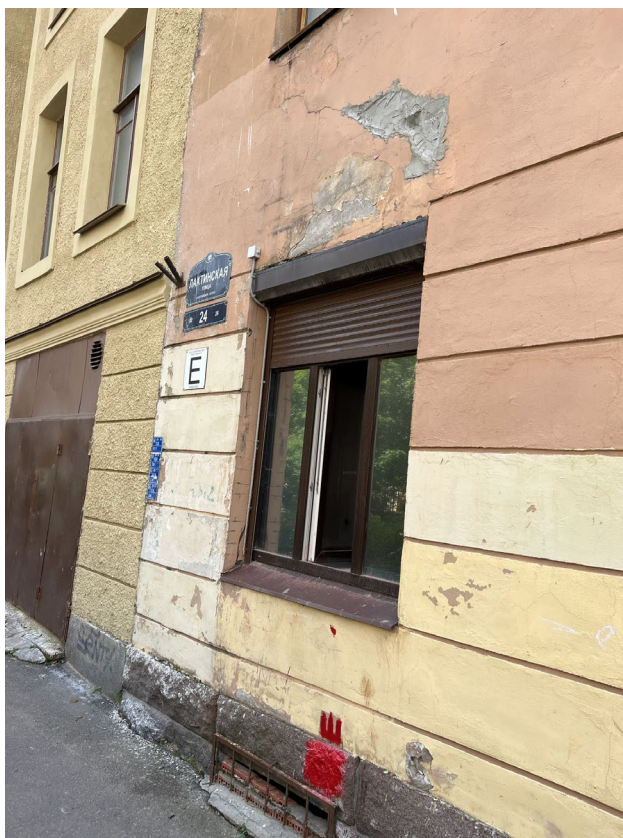
Фото 5. Фасад 1-10. Следы многочисленных красочных слоев, загрязнение гранитного цоколя лакокрасочными материалами
