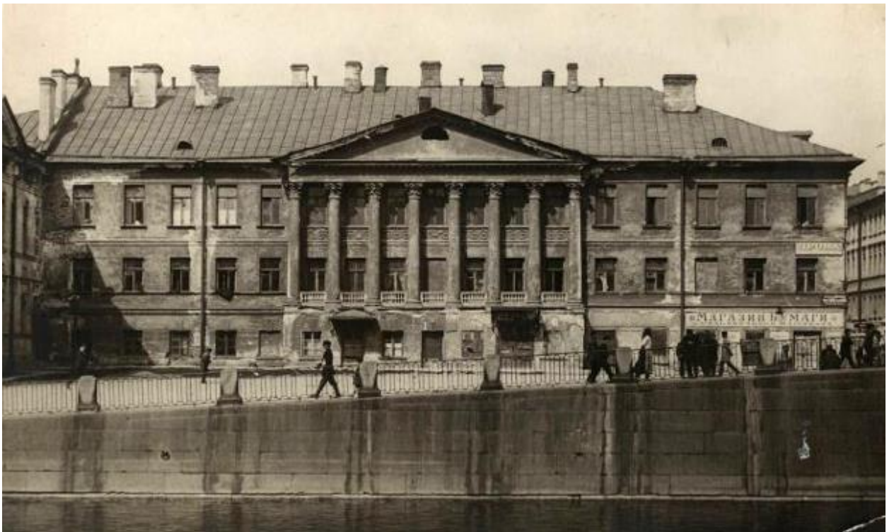
2. Дом Яковлевых (Евментьева А.Ф.). Гороховая ул., д. 57, лит. А. Фото 1940 г. (21).
