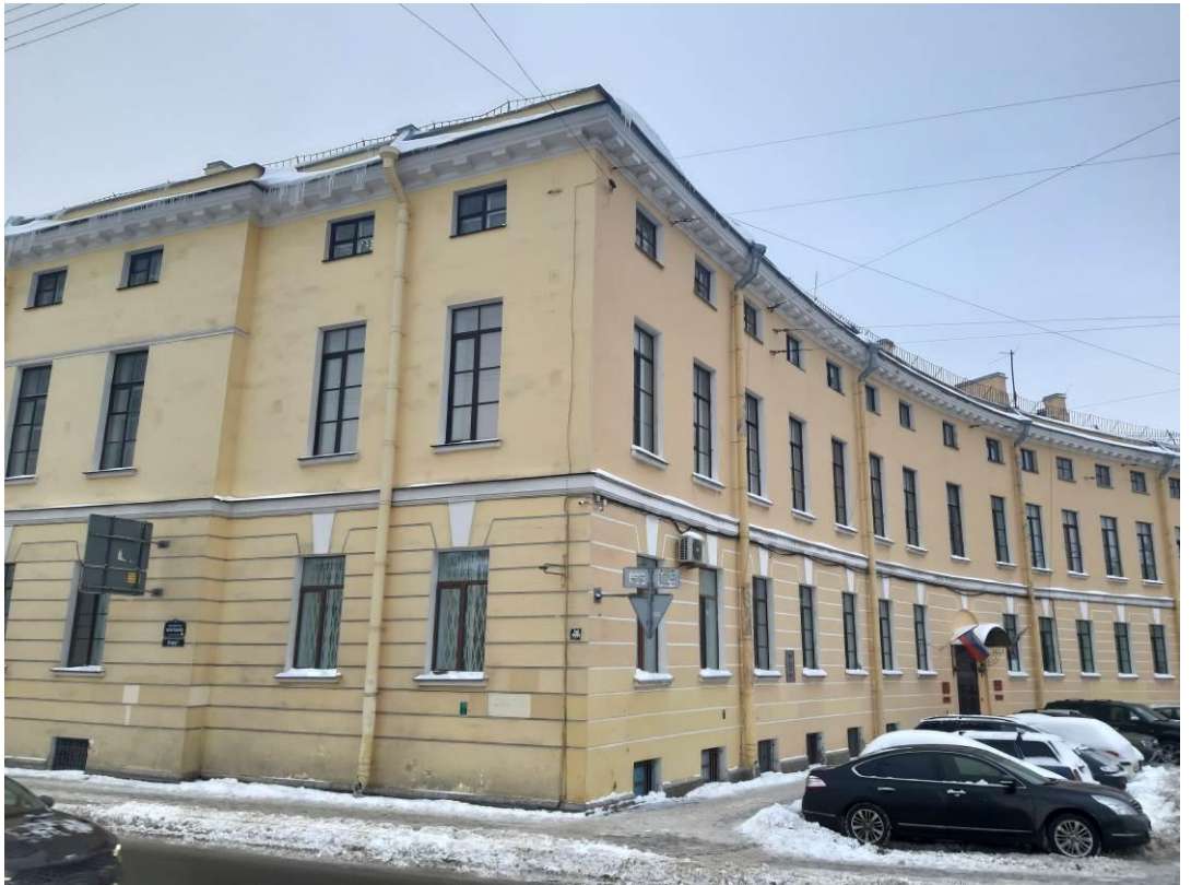
9. Казармы местных войск. Главный корпус. Наб. реки Фонтанки, д. 90, корп. 1, лит. А. Фото мест установки оборудования и кабельных трасс. Штиглиц М.С. 15.12.2022.
