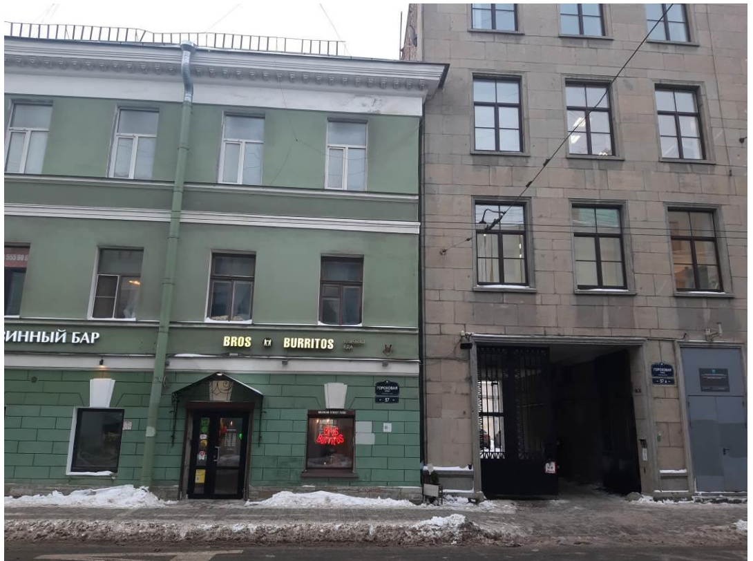
5. Дом Яковлевых (Евментьева А.Ф.). Гороховая ул., д. 57, лит. А. Фото мест установки оборудования и кабельных трасс. Штиглиц М.С. 15.12.2022.
