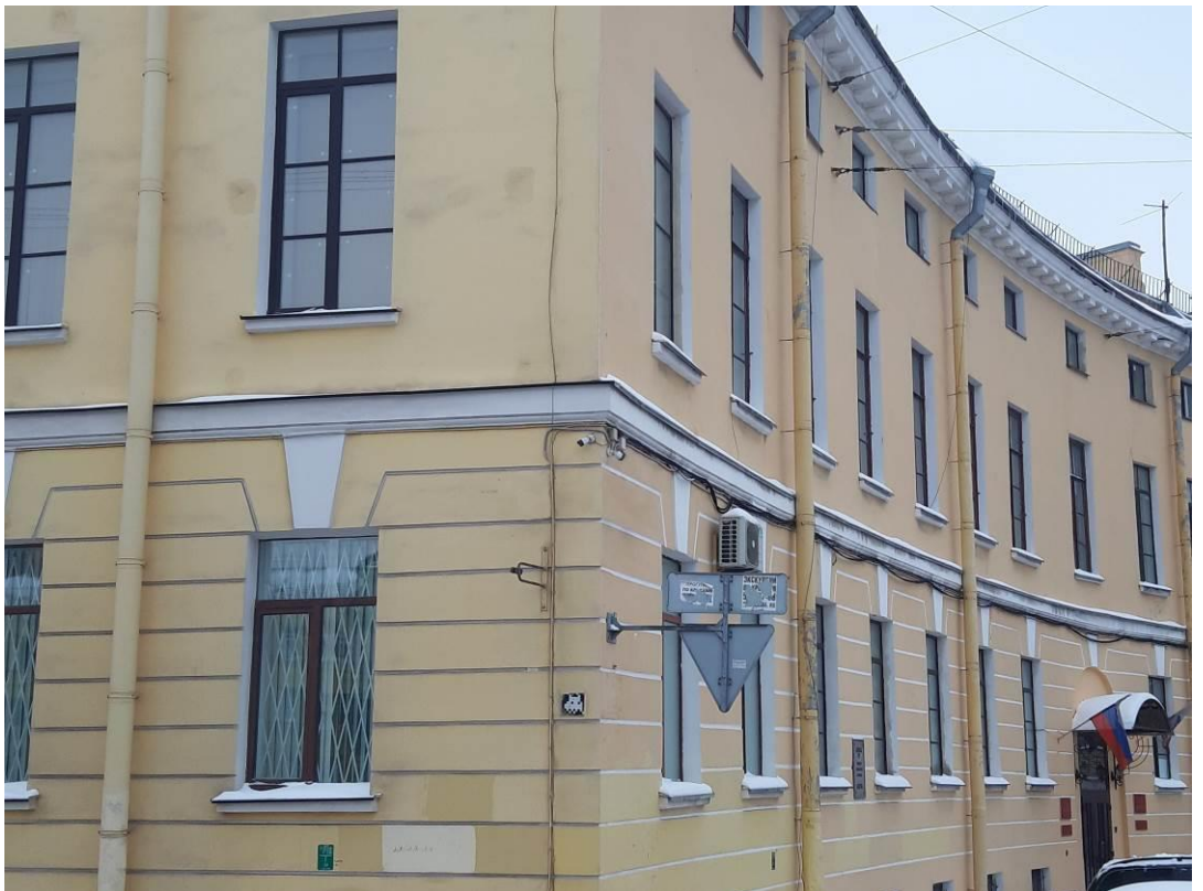
10. Казармы местных войск. Главный корпус. Наб. реки Фонтанки, д. 90, корп. 1, лит. А. Фото мест установки оборудования и кабельных трасс. Штиглиц М.С. 15.12.2022.
