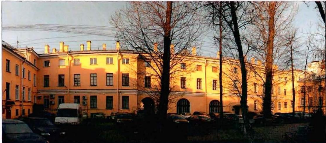
2. Дворовые фасады. Вид с юго-востока.
