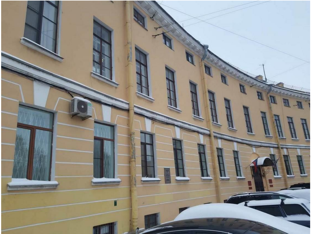
11. Казармы местных войск. Главный корпус. Наб. реки Фонтанки, д. 90, корп. 1, лит. А. Фото мест установки оборудования и кабельных трасс. Штиглиц М.С. 15.12.2022.
