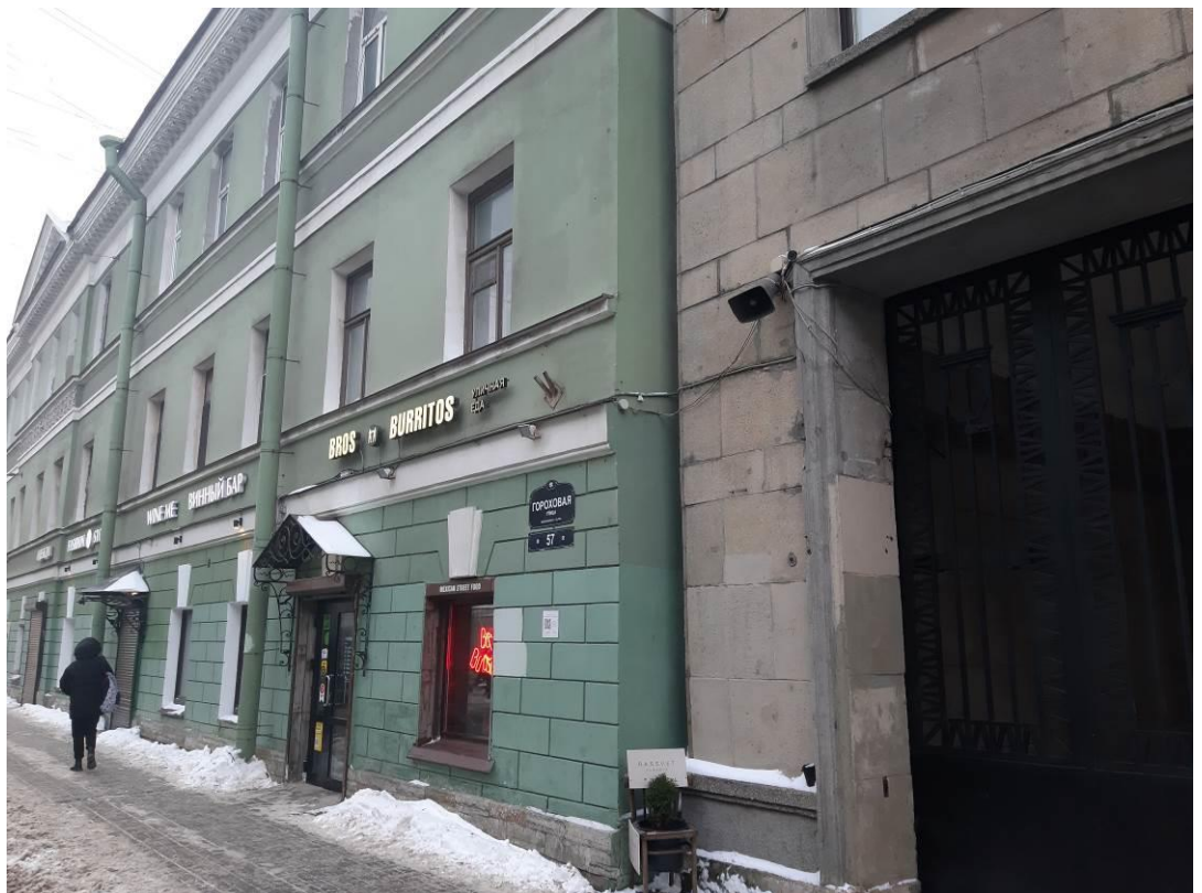
6. Дом Яковлевых (Евментьева А.Ф.). Гороховая ул., д. 57, лит. А. Фото мест установки оборудования и кабельных трасс. Штиглиц М.С. 15.12.2022.
