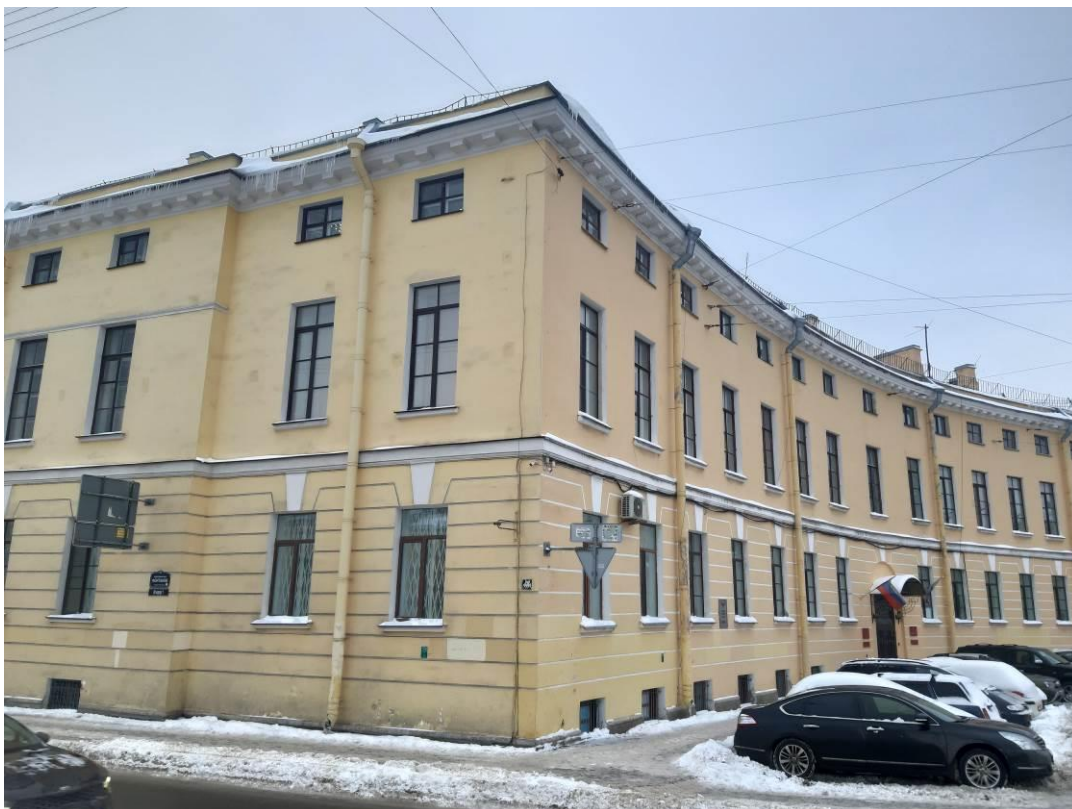
9. Казармы местных войск. Главный корпус. Наб. реки Фонтанки, д. 90, корп. 1, лит. А. Фото мест установки оборудования и кабельных трасс. Штиглиц М.С. 15.12.2022.
