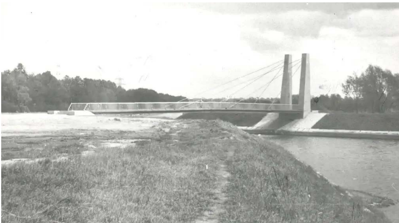
Илл.13. Пешеходный вантовый мост по «аллее Славы» (Мост сооружен в 1986- 1988 годах по проекту инженера Ленгипроинжпроекта А.А. Соколова и архитектора Ю. Шиндина. Мост пешеходный, однопролетный, металлический, вантовой системы.
