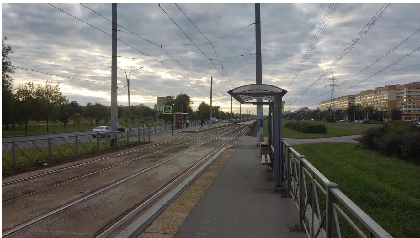
7. Территория проектирования, существующие трамвайные остановки, вид на запад в сторону Кронштадтской площади
