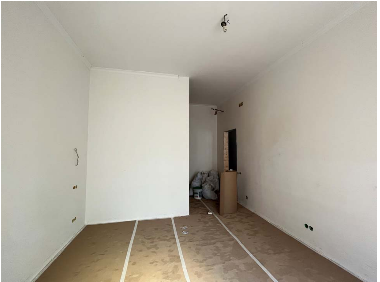
Фото №7. Квартира 31, пом. 6.
