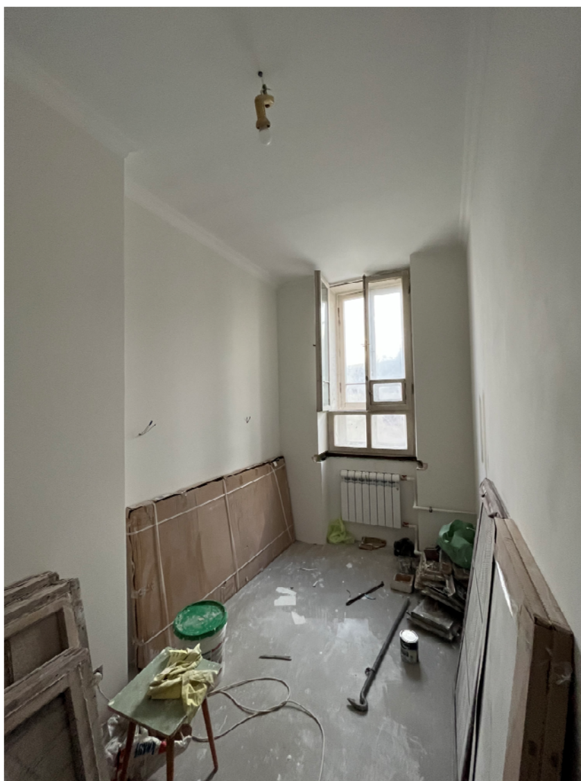
Фото №12. Квартира 31, пом. 4.
