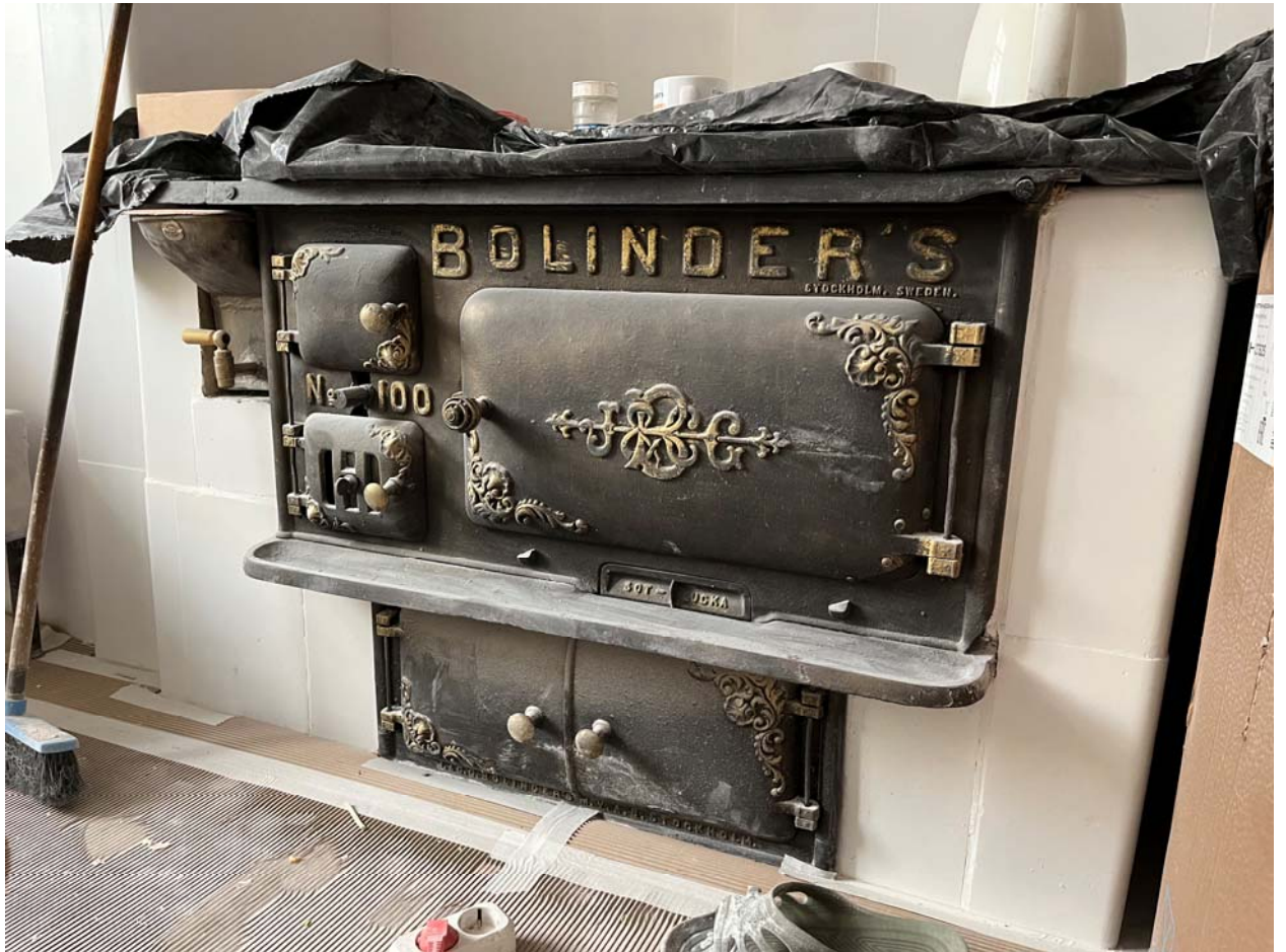
Фото №11. Квартира 31, пом. 3, плита.
