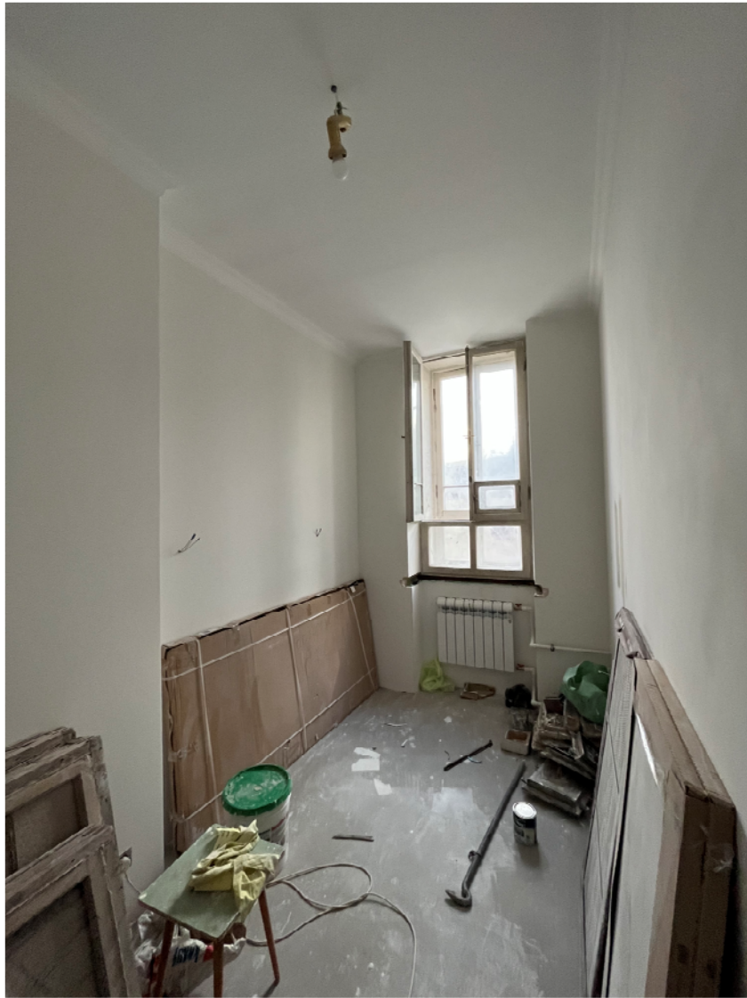
Фото №12. Квартира 31, пом. 4.
