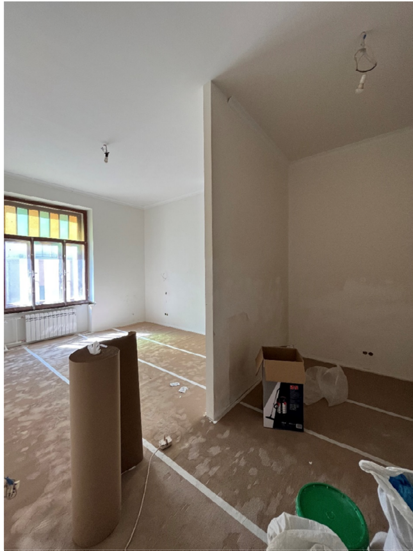
Фото №6. Квартира 31, пом. 6.
