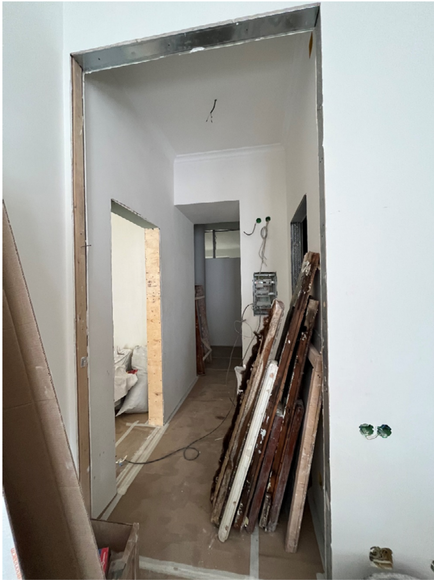
Фото №5. Квартира 31, пом. 7.
