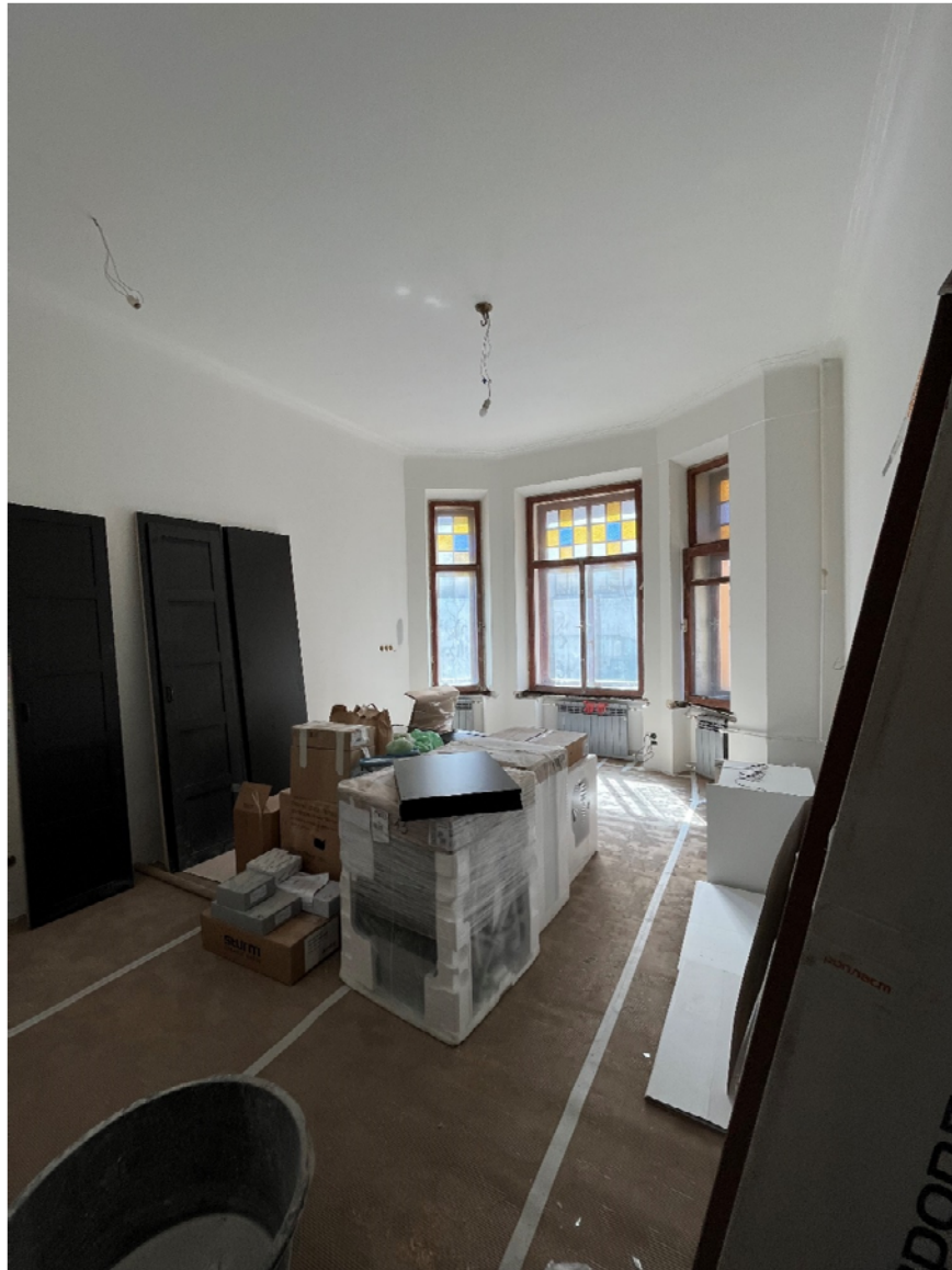
Фото №4. Квартира 31, пом. 7.
