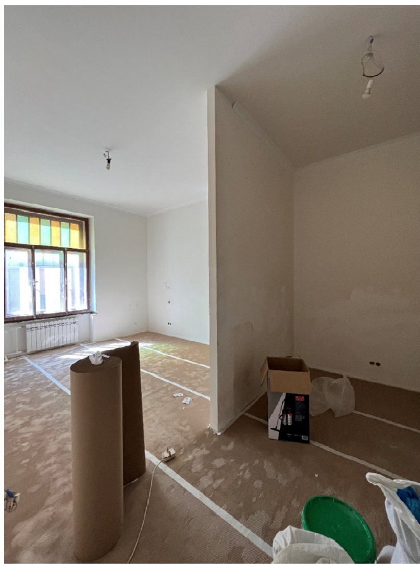
Фото №6. Квартира 31, пом. 6.
