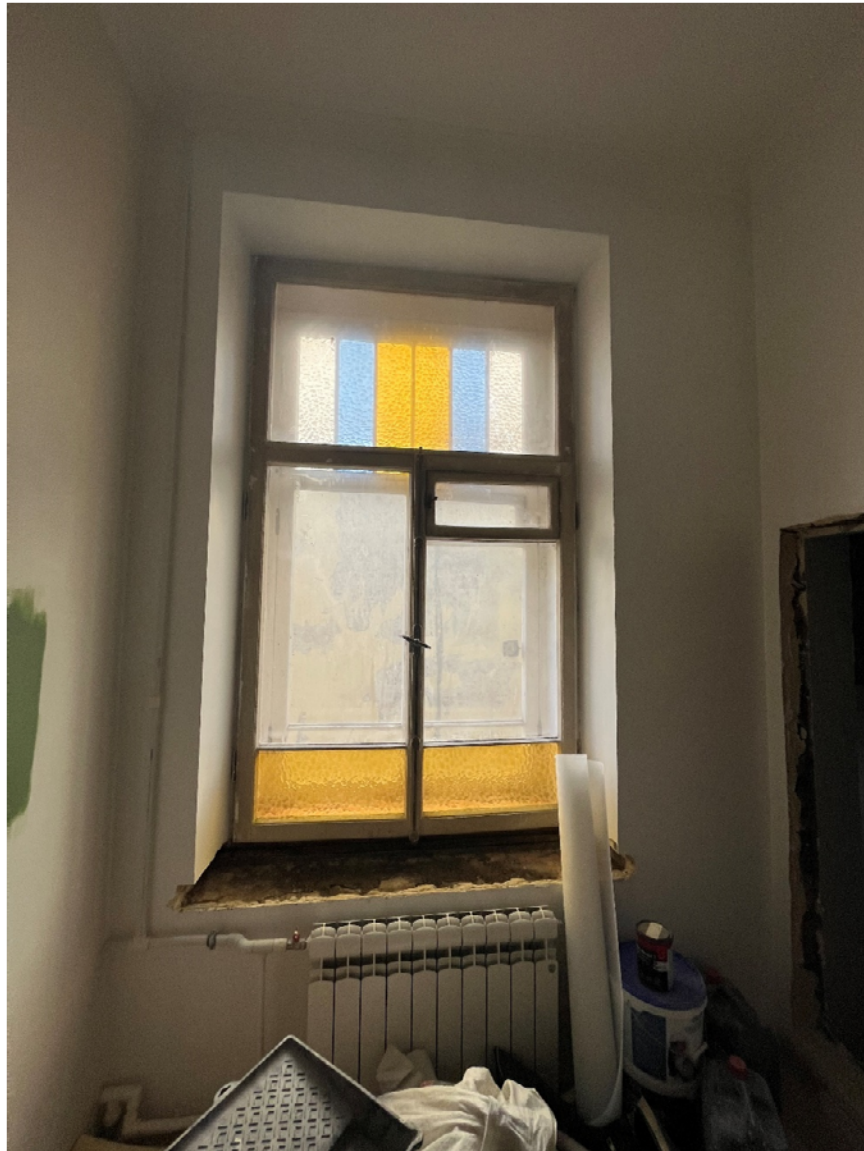
Фото №8. Квартира 31, пом. 3.
