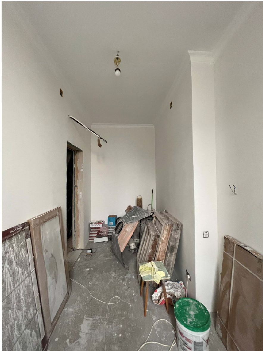
Фото №13. Квартира 31, пом. 4.
