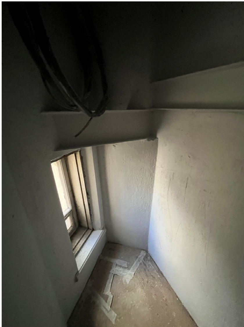
Фото №9. Квартира 31, пом. 9.
