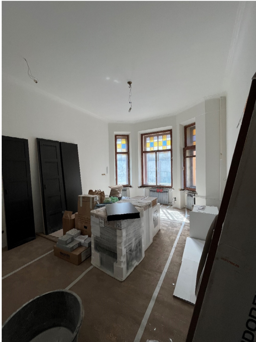
Фото №4. Квартира 31, пом. 7.
