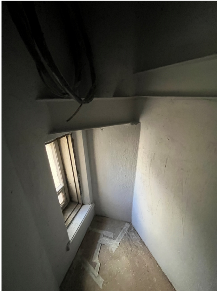
Фото №9. Квартира 31, пом. 9.
