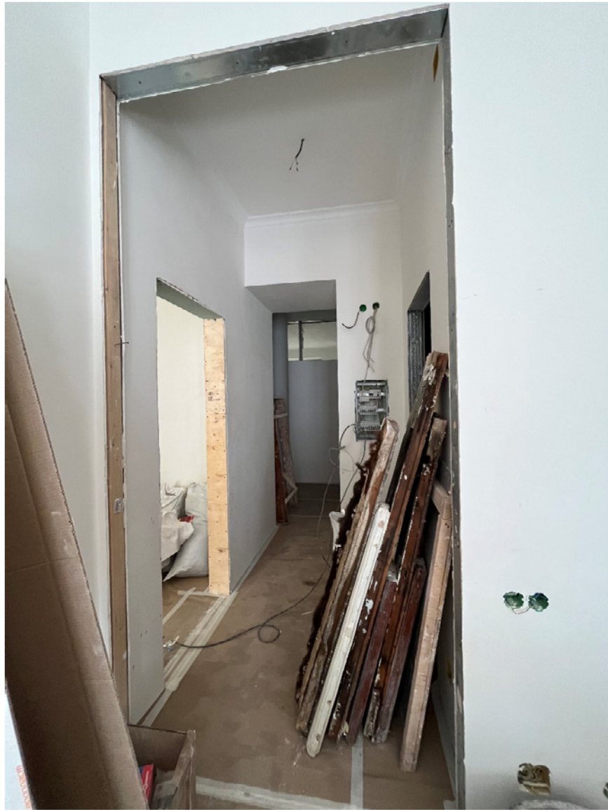
Фото №5. Квартира 31, пом. 7.
