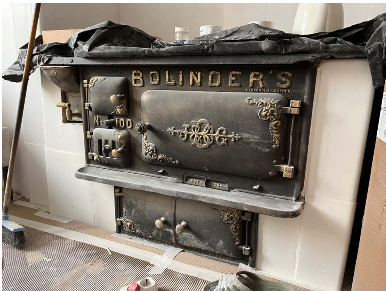
Фото №11. Квартира 31, пом. 3, плита.
