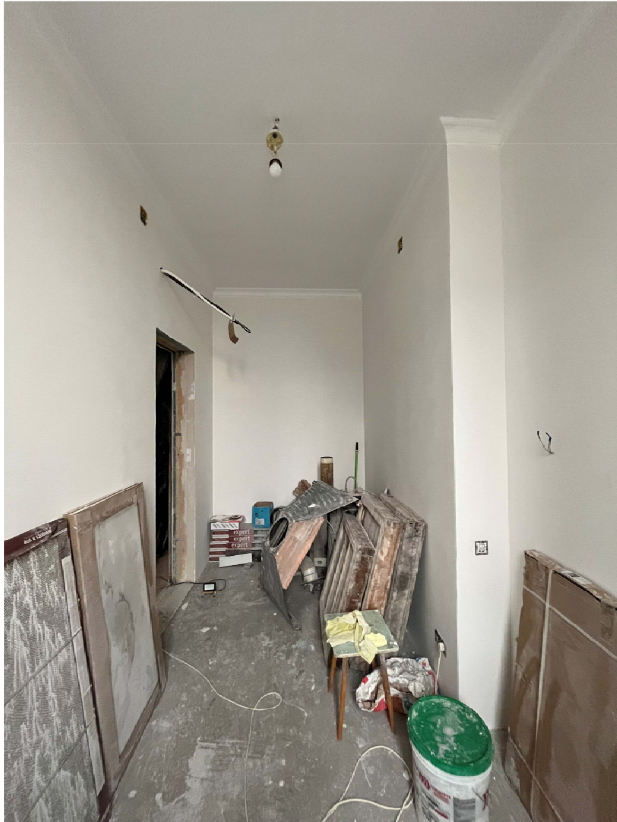
Фото №13. Квартира 31, пом. 4.
