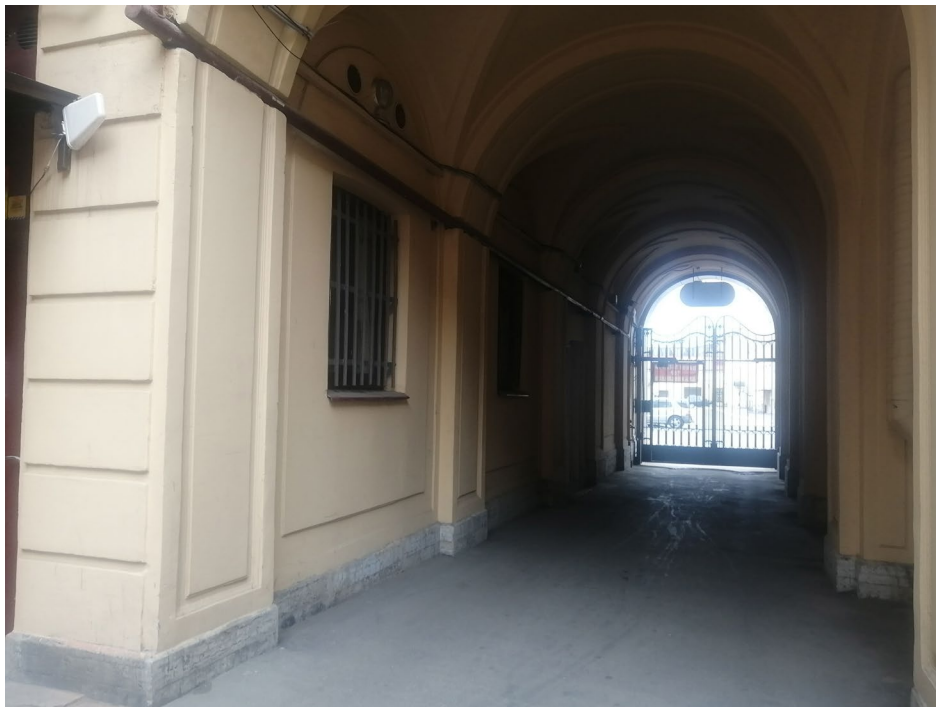
Фото 26. Выявленный объект культурного наследия «Дом М.А. Стенбок-Фермор». Арочный проезд во внутренний двор.
