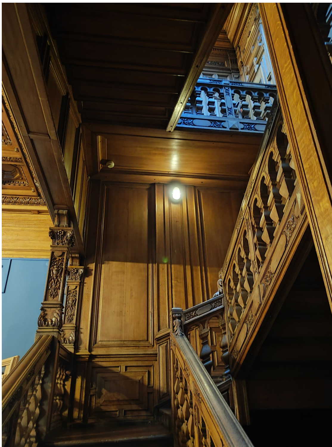
21. Вид дубовой лестницы в уровне 2-го этажа (пом. № 52). Направление съемки север (в сторону Невы).
