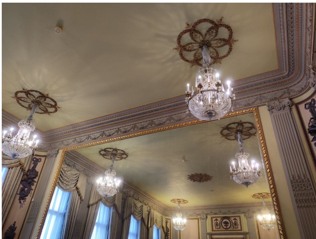
27. Вид пом. № 50 во 2-м этаже лицевого корпуса по Английской наб. Направление съемки восток (Нева слева).
