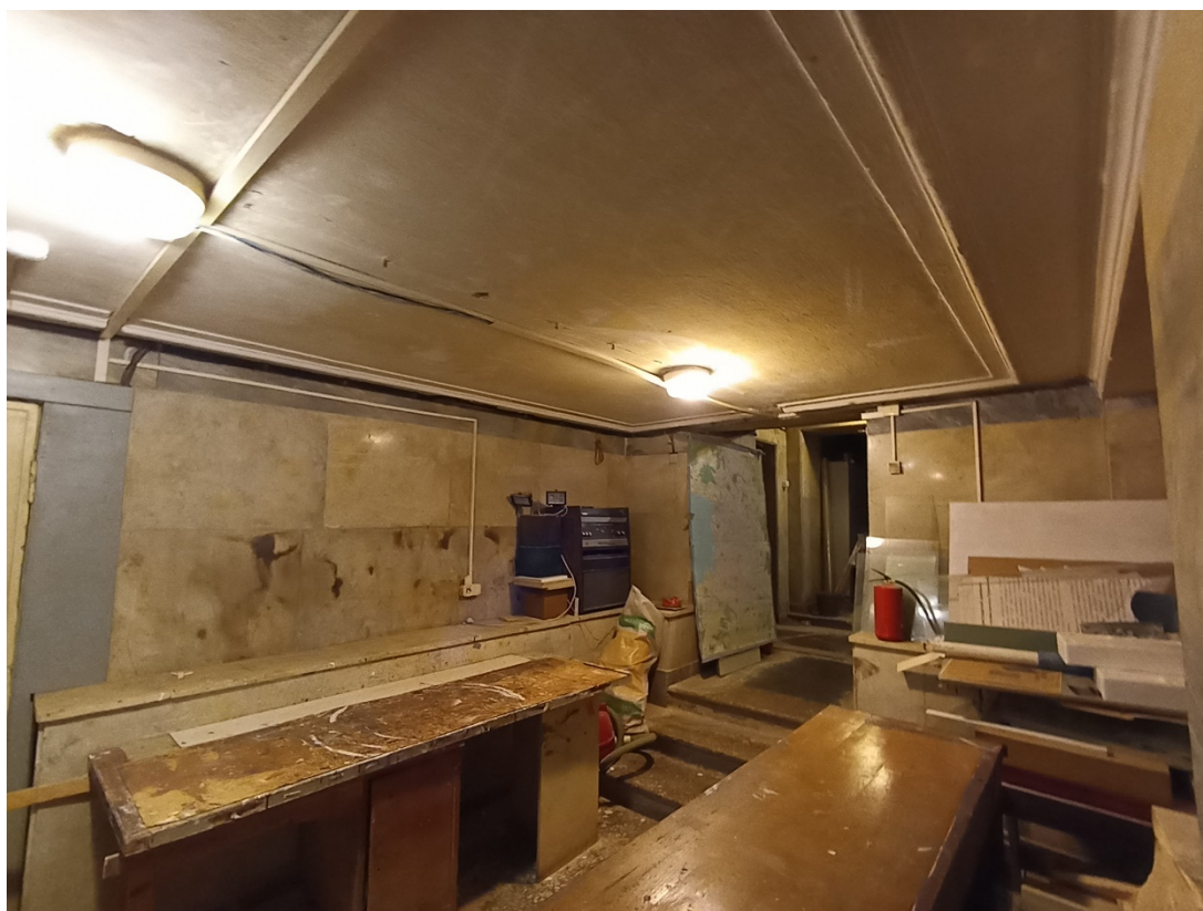
37. Вид помещения № 81 в подвале лицевого корпуса по Английской наб.
