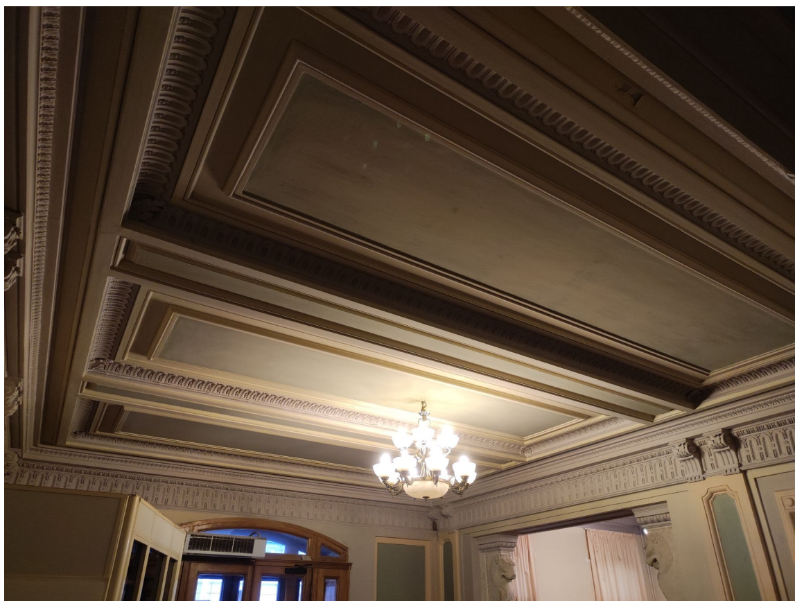
5. Потолок вестибюля корпуса по Галерной улице (пом. № 1).
