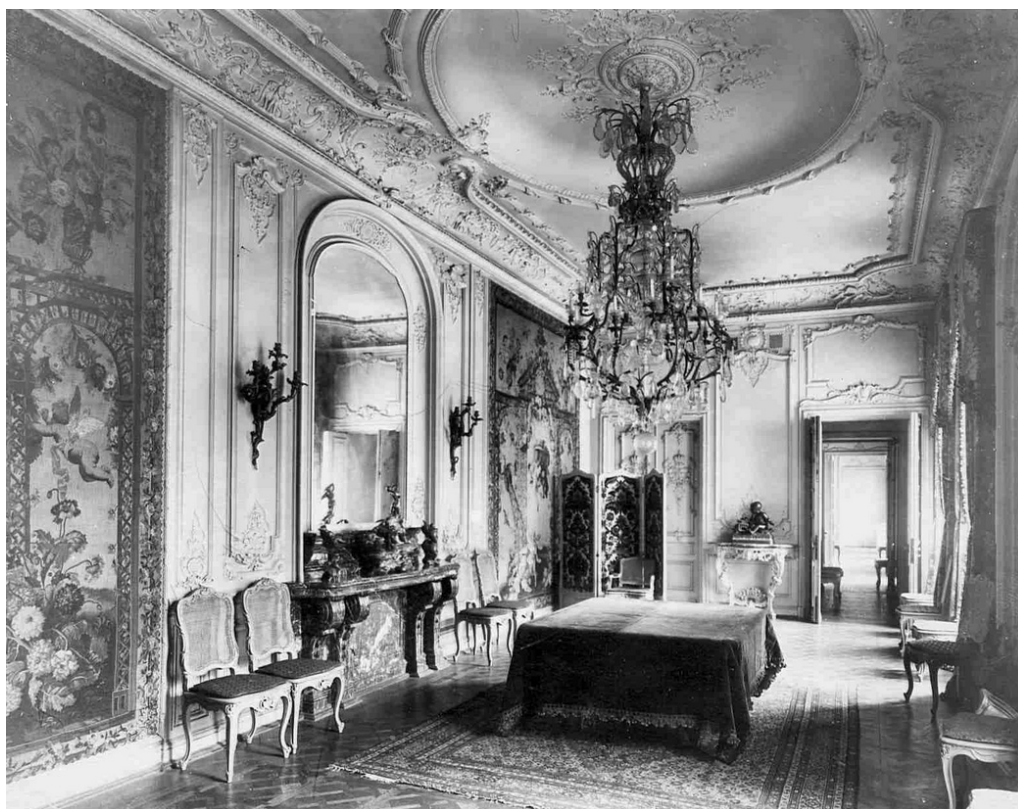
34. 1906 г. Зал восточной анфилады. К. К. Булла. ЦГАКФФД СПб № Е-271. В настоящее время стены и потолок зала зашиты.
