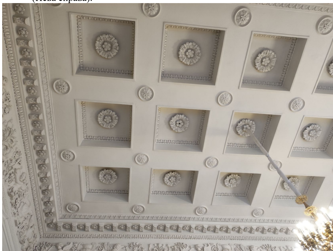
32. Вид кессонов потолка в пом. № 57 во 2-м этаже поперечного дворового флигеля.
