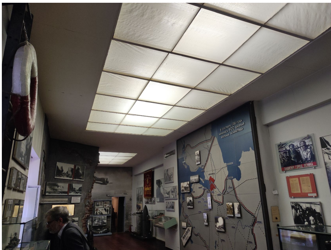
23. Вид пом. № 45 во 2-м этаже западного дворового флигеля. Направление съемки юг (Нева сзади). Стены и потолок зашиты для устройства экспозиции.
