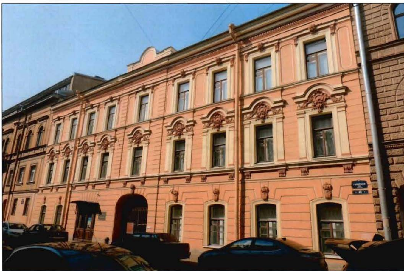
5. Общий вид лицевого фасада объекта культурного наследия по Галерной ул. с юго-востока.
