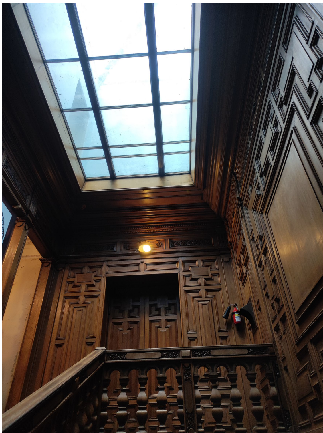
22. Вид дубовой лестницы в уровне 3-го этажа (пом. № 67). Направление съемки север (в сторону Невы).
