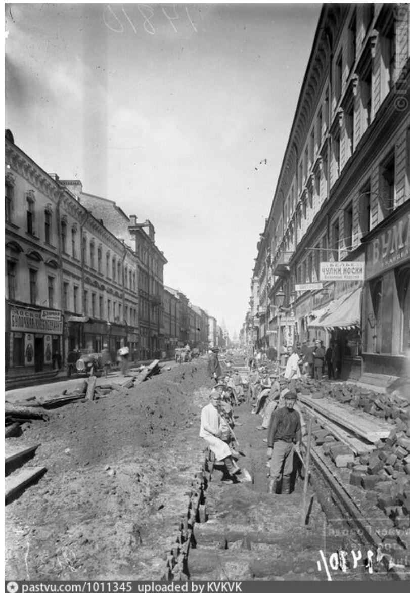
Илл. 8. Фото 1920-1929 год. Канализационные работы на улице Дзержинского во время завершающего этапа. Вид на часть дома №41 и Гороховую улицу // pastvu.com
