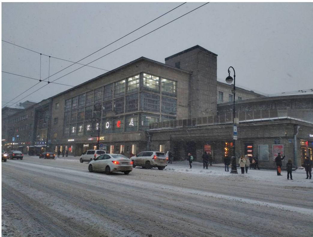
Фото 3. Фрагмент лицевого фасада объекта культурного наследия регионального значения «Дом культуры Промкооперации (быв. «Спортинг-Палас» А.И. Башкирова)» (Дворец культуры имени Ленсовета)
