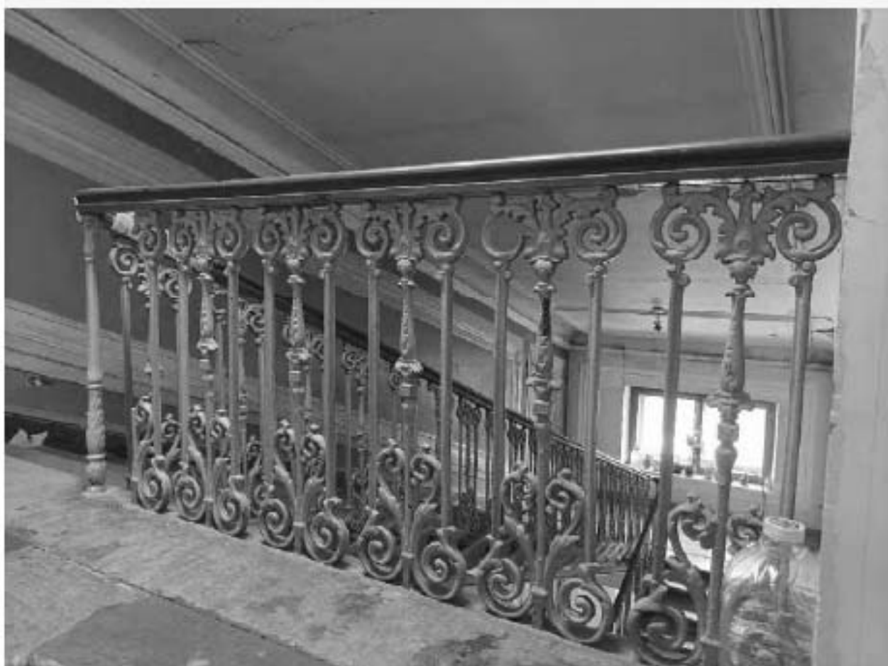
26. Объект культурного наследия федерального значения «Кунсткамера», по адресу: Санкт-Петербург, Университетская набережная, дом № 3, литера Б (Университетская наб., 3). Ограждение лестницы в уровне 4 этажа. Дата съемки: 12.08.2022г.
