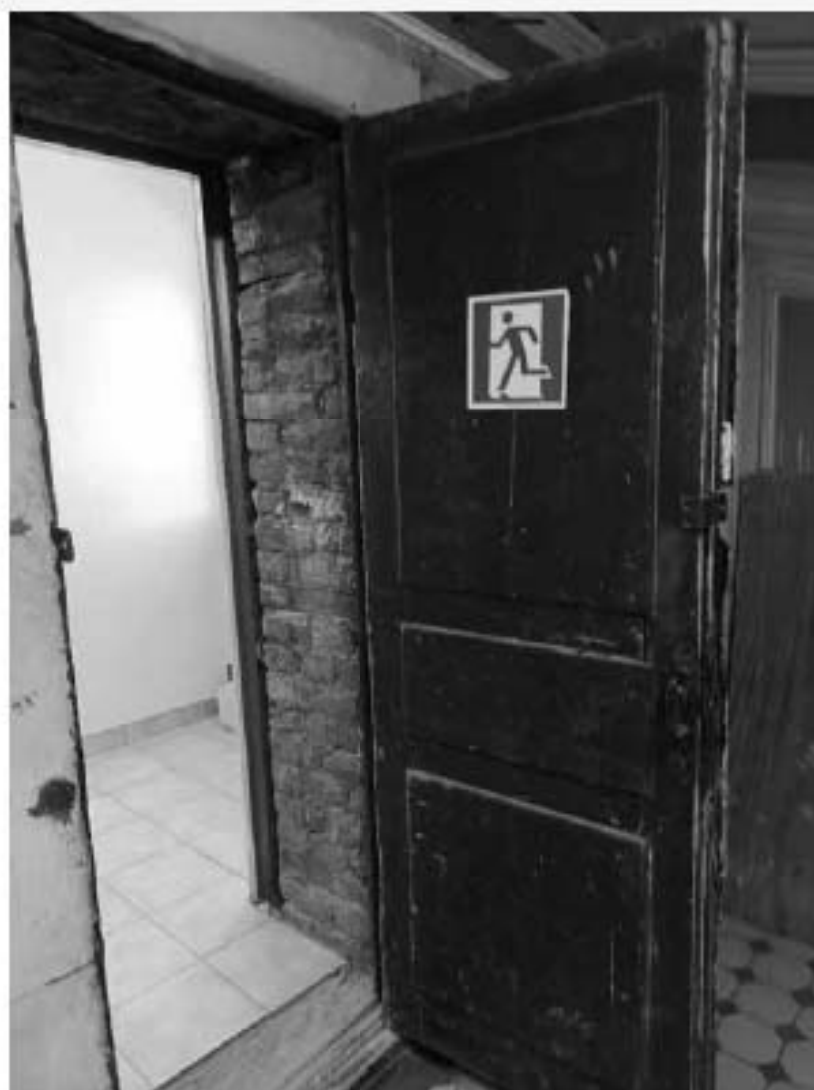
24. Объект культурного наследия федерального значения «Кунсткамера», по адресу: Санкт-Петербург, Университетская набережная, дом № 3, литера Б (Университетская наб., 3). Дверь, вход на 4 этаж. Дата съемки: 12.08.2022г.
