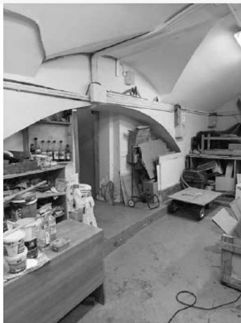
4. Объект культурного наследия федерального значения «Кунсткамера», по адресу: Санкт-Петербург, Университетская набережная, дом № 3, литера Б (Университетская наб., 3). Подвал. Дата съемки: 12.08.2022г.
