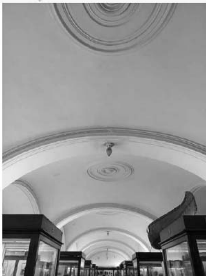
53. Объект культурного наследия федерального значения «Кунсткамера», по адресу: Санкт-Петербург, Университетская набережная, дом № 3, литера Б (Университетская наб., 3). Экспозиционный зал 1 этажа. Дата съемки: 12.08.2022г.
