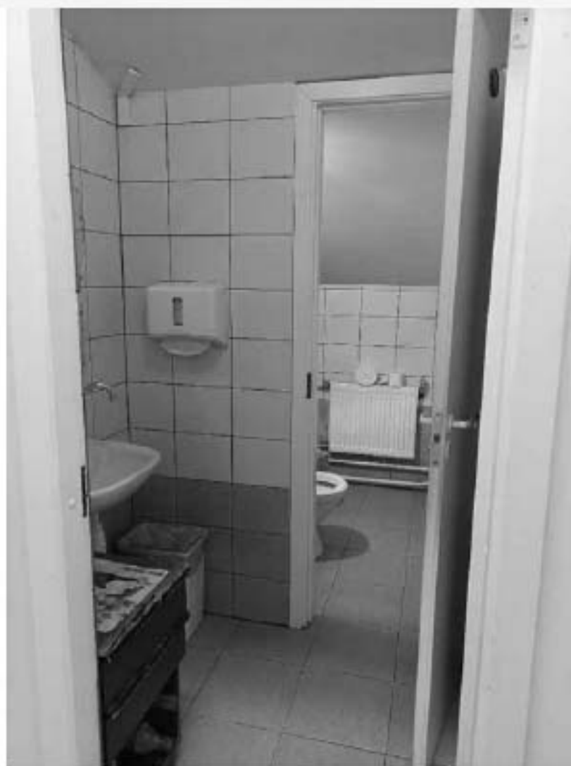
34. Объект культурного наследия федерального значения «Кунсткамера», по адресу: Санкт-Петербург, Университетская набережная, дом № 3, литера Б (Университетская наб., 3). Сан. узел 4 этажа. Дата съемки: 12.08.2022г.
