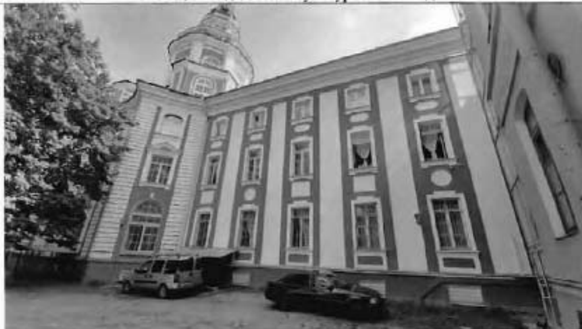
2. Фрагмент дворового фасада корпуса по Университетской набережной
