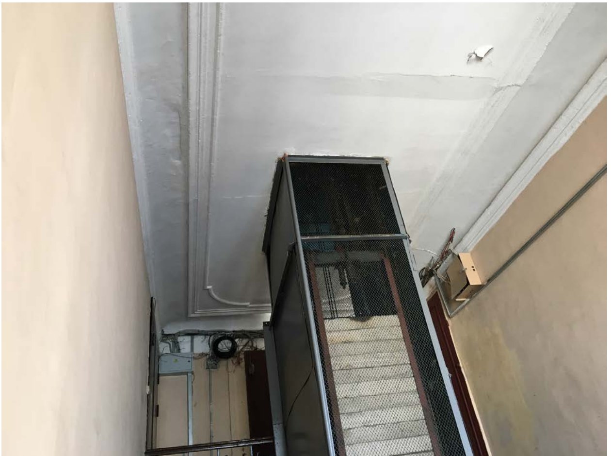
27. Парадная лестница Л-1. Оформление перекрытия лестничного объема.
