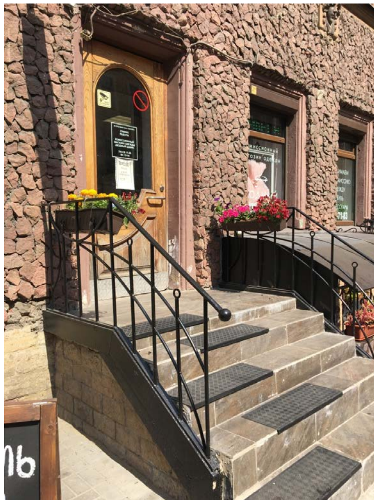
7. Лицевой фасад выявленного объекта культурного наследия «Дом Потаповой (Н.В. Иванова)», расположенного по адресу: г. Санкт-Петербург, Некрасова ул., д. 36. Фрагмент.
