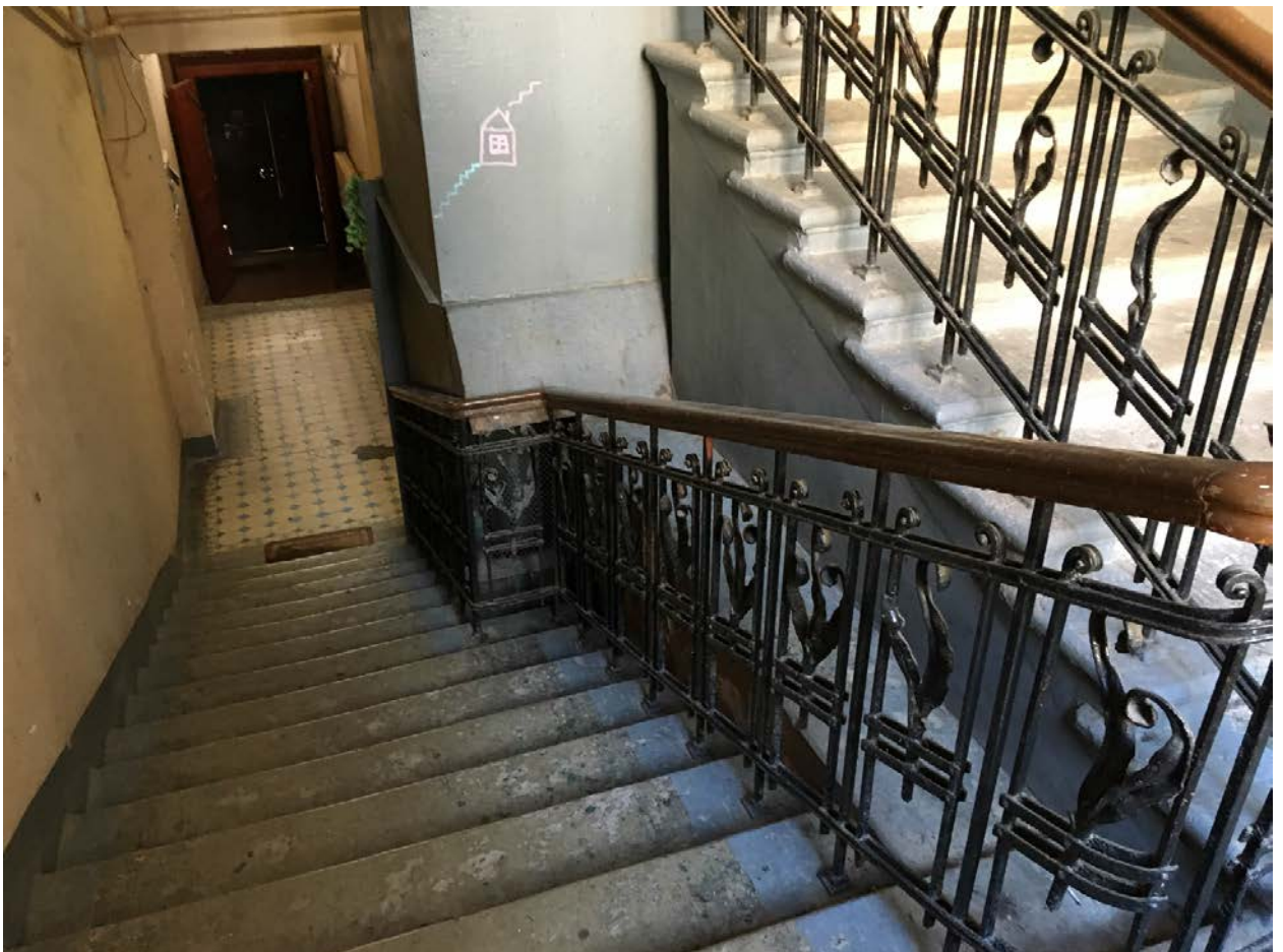
22. Парадная лестница Л-1. Ограждение лестницы.
