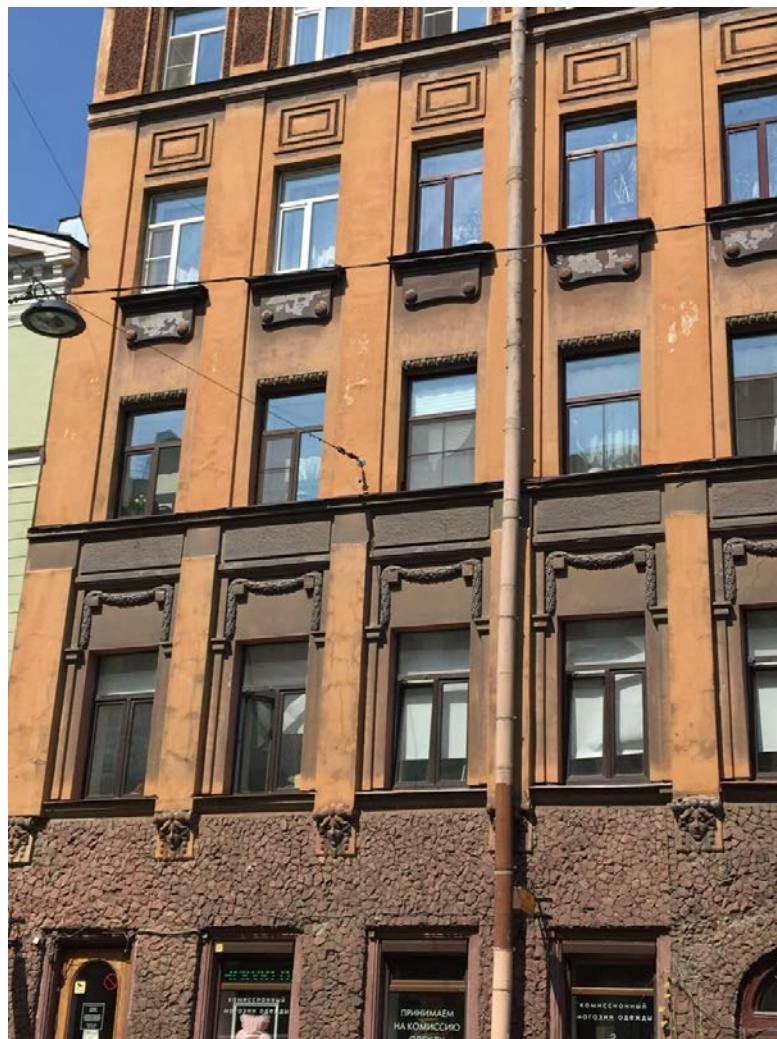
6. Лицевой фасад выявленного объекта культурного наследия «Дом Потаповой (Н.В. Иванова)», расположенного по адресу: г. Санкт-Петербург, Некрасова ул., д. 36. Фрагмент.
