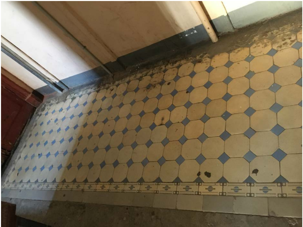
25. Парадная лестница Л-1. Покрытие пола площадки 3 этажа.
