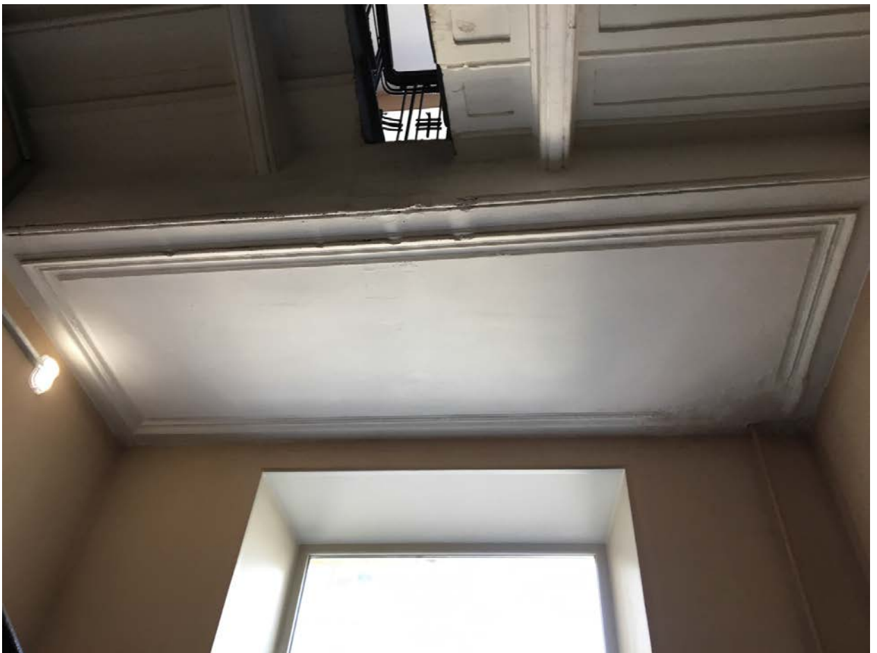
26. Парадная лестница Л-1. Оформление основания площадки между 5 и 6 этажами.
