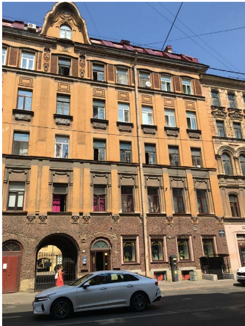
11. Лицевой фасад выявленного объекта культурного наследия «Дом Потаповой (Н.В. Иванова)», расположенного по адресу: г. Санкт-Петербург, Некрасова ул., д. 36. Фрагмент.
