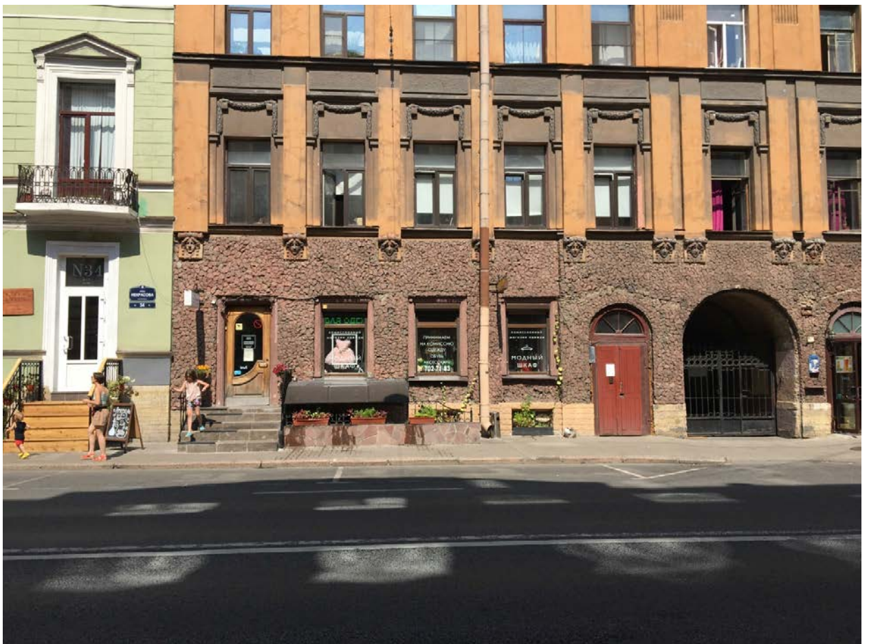
5. Лицевой фасад выявленного объекта культурного наследия «Дом Потаповой (Н.В. Иванова)», расположенного по адресу: г. Санкт-Петербург, Некрасова ул., д. 36. Фрагмент.
