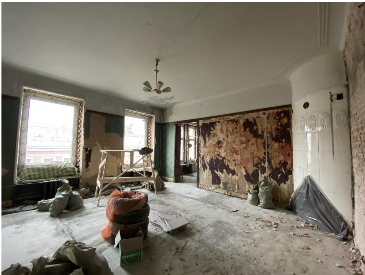
Фото 21. Помещение № 11. Комната. Вид с юго-востока.
