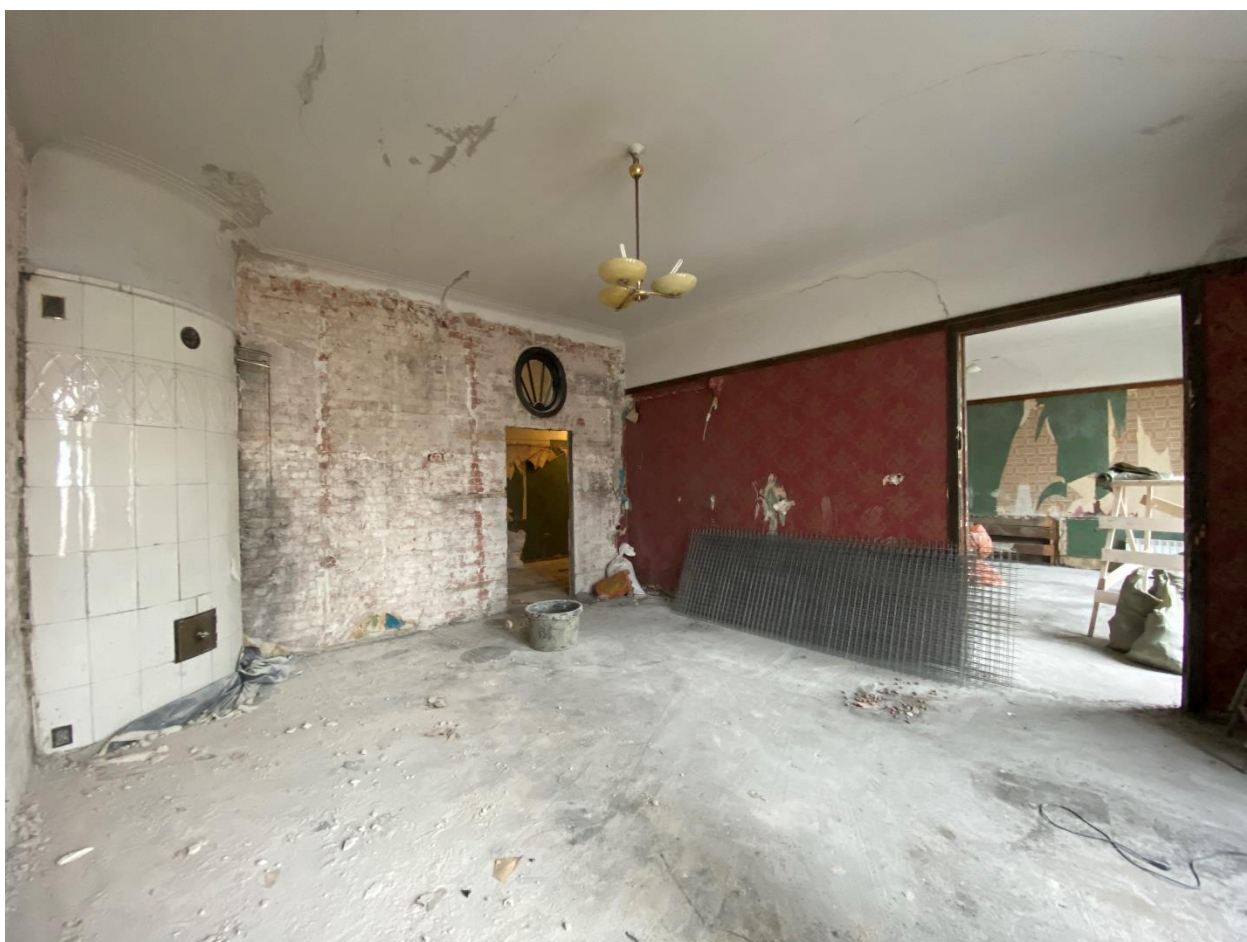
Фото 18. Помещение № 10. Комната. Вид с северо-запада.
