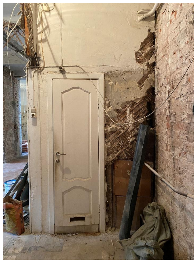
Фото 6. Помещение № 1. Коридор (нумерация и экспликация помещений указана в соответствии в техническом паспорте по состоянию на 09.01.2013 г.). Вид с востока.
