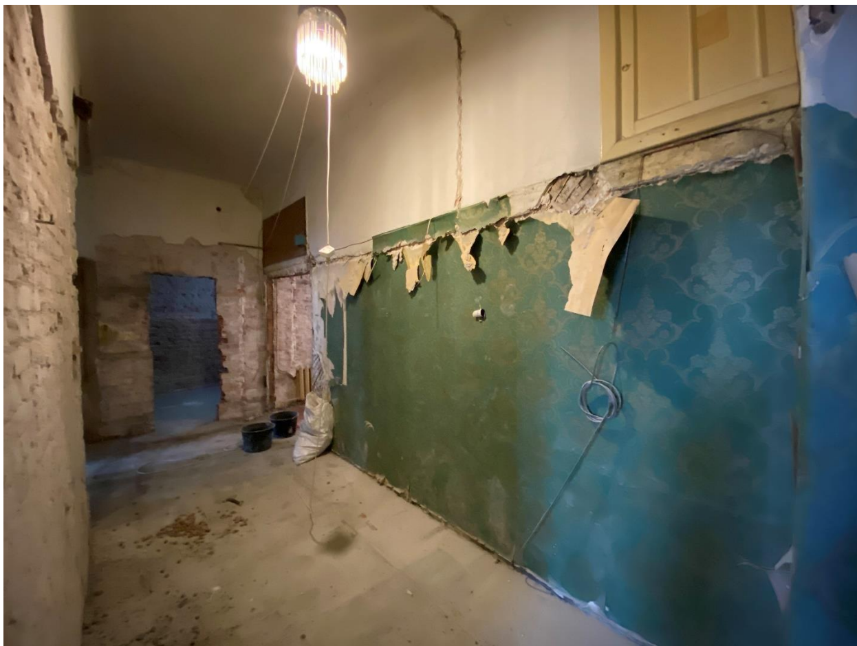
Фото 15. Помещение № 7. Коридор. Вид с юго-запада.
