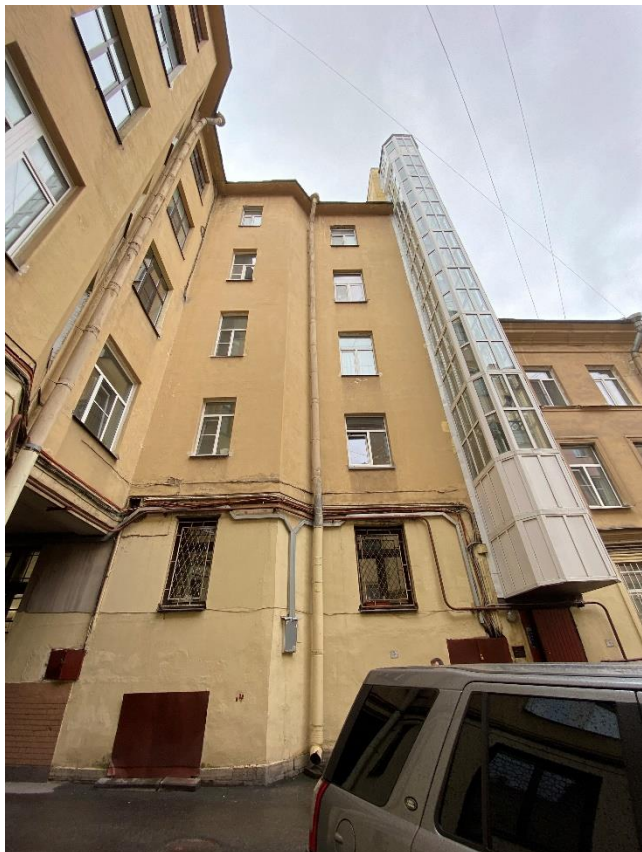
Фото 3. Южный дворовый фасад. .
