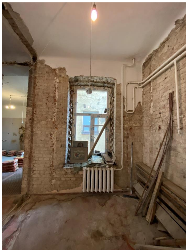
Фото 8. Помещение № 3. Кухня. Вид с востока.
