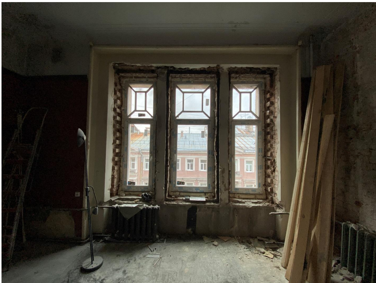
Фото 19. Помещение № 10. Комната. Современные металлопластиковые оконные заполнения с сохранением исторического рисунка расстекловки в помещении № 10. Вид с востока.
