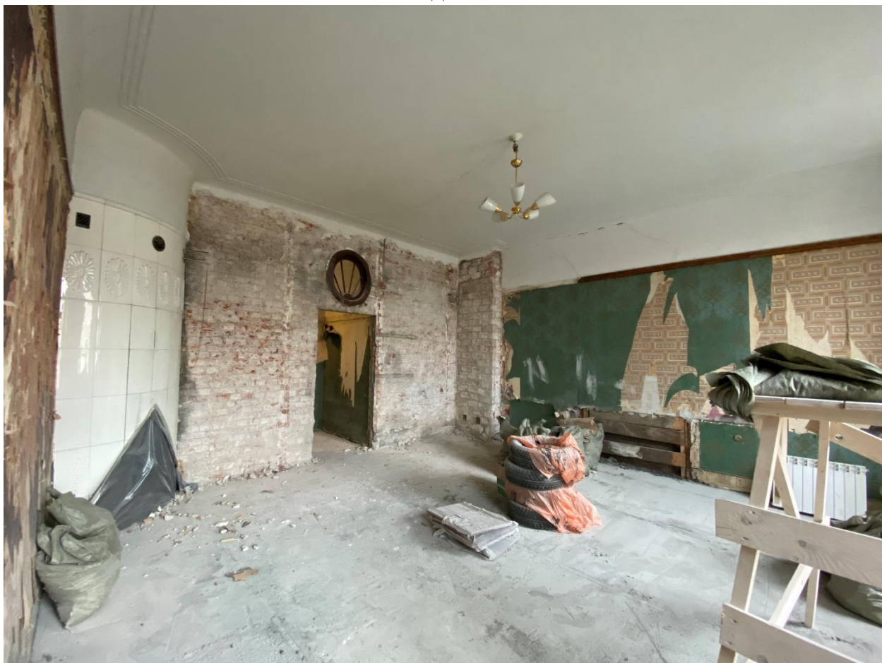
Фото 20. Помещение № 11. Комната. Вид с северо-запада.
