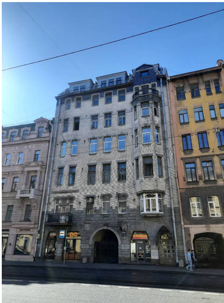
Фото 1. Лицевой фасад выявленного объекта культурного наследия «Дом С.М. Дейчмана»
