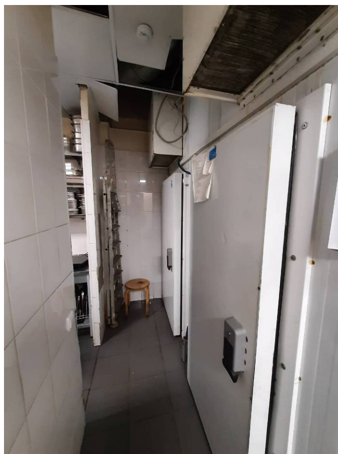
Фото 10. Интерьер помещения 2-Н выявленного объекта культурного наследия «Дом С.М. Дейчмана»
