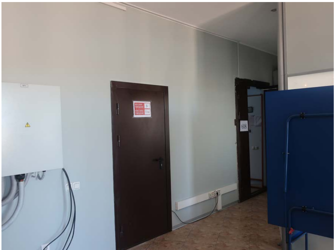
11. Помещение №10 (23-Н) выявленного объекта культурного наследия «Дом Ш.З. Иоффа», расположенного по адресу: г. Санкт-Петербург, ул. Белинского, д. 13, литера А. 03.03.2022
