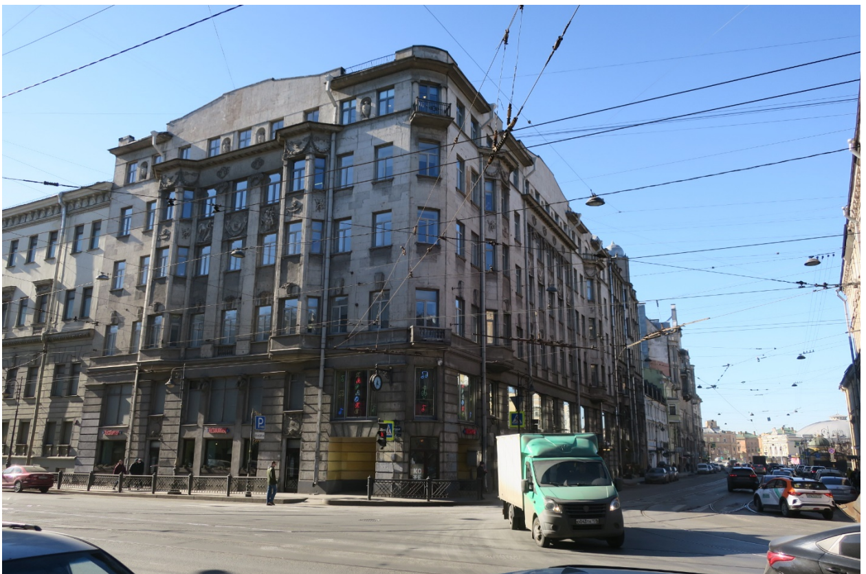
1. Северный и восточный лицевые фасады выявленного объекта культурного наследия «Дом Ш.З. Иоффа», расположенного по адресу: г. Санкт-Петербург, ул. Белинского, д. 13, литера А. 03.03.2022
