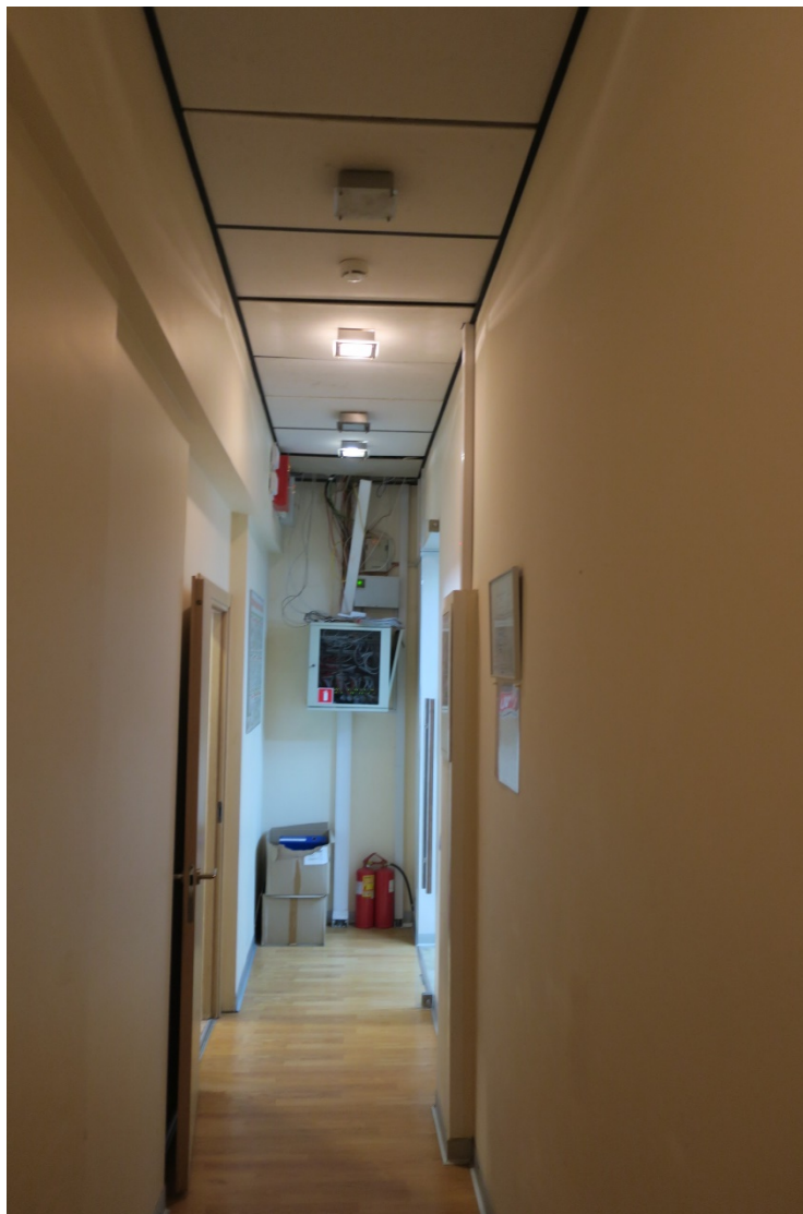
24. Помещение №6 (25-Н) выявленного объекта культурного наследия «Дом Ш.З. Иоффа», расположенного по адресу: г. Санкт-Петербург, ул. Белинского, д. 13, литера А. 03.03.2022 (это помещение №6 на 6 этаже, схема приложена 5 этажа)
