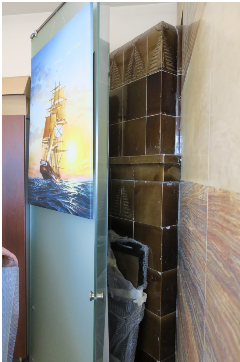
17. Защитная печь в помещении №7 (25-Н) выявленного объекта культурного наследия «Дом Ш.З. Иоффа», расположенного по адресу: г. Санкт-Петербург, ул. Белинского, д. 13, литера А. 03.03.2022
