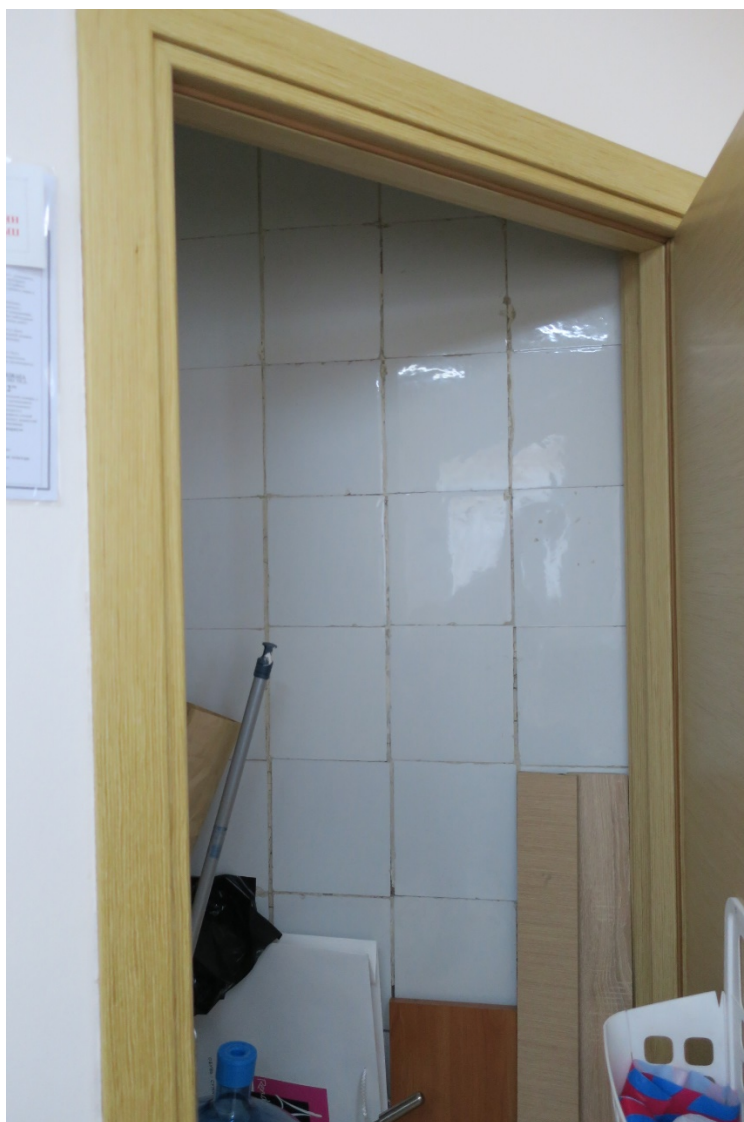
7. Защищенная печь в помещении №13 (20-Н) выявленного объекта культурного наследия «Дом Ш.З. Иоффа», расположенного по адресу: г. Санкт-Петербург, ул. Белинского, д. 13, литера А. 03.03.2022
