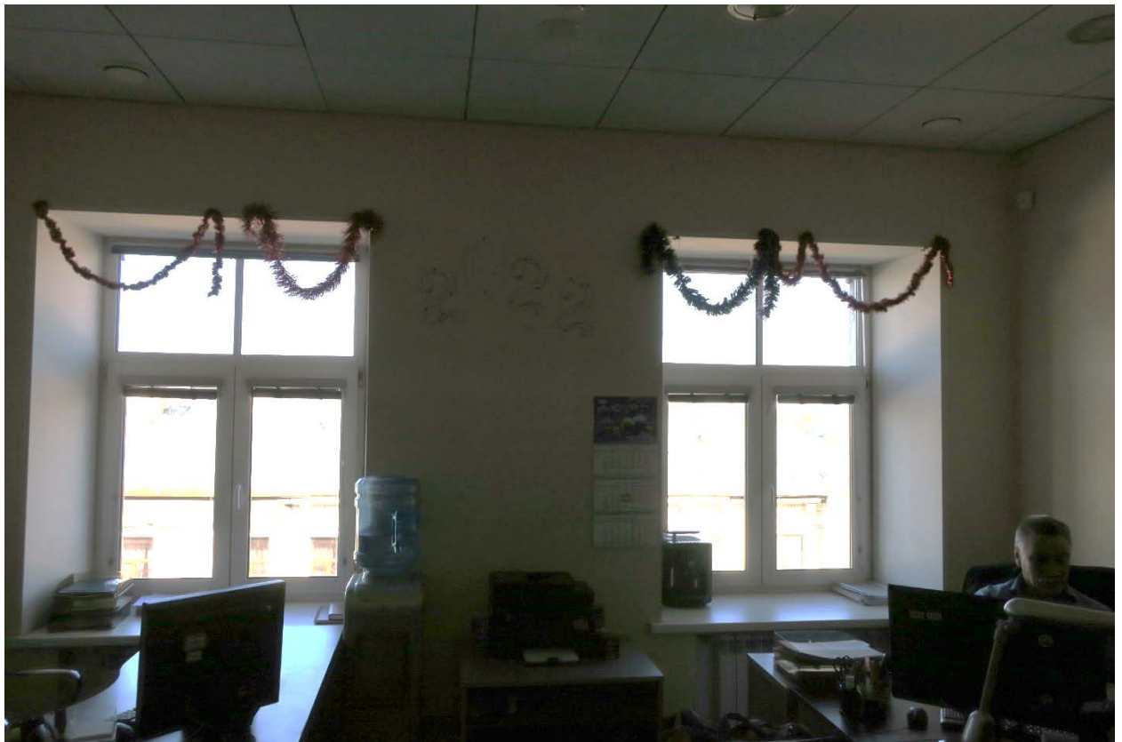
9. Помещение №4 (20-Н) выявленного объекта культурного наследия «Дом Ш.З. Иоффа», расположенного по адресу: г. Санкт-Петербург, ул. Белинского, д. 13, литера А. 03.03.2022
