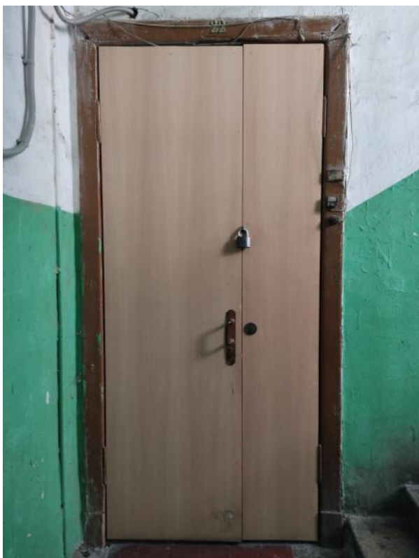
Фото 28. Дверное заполнение кв. № 22, вид с лестничной клетки
