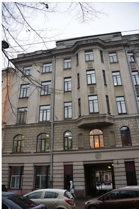
Фото 6. Въездной проезд во двор выявленного объекта культурного наследия «Доходный дом»
