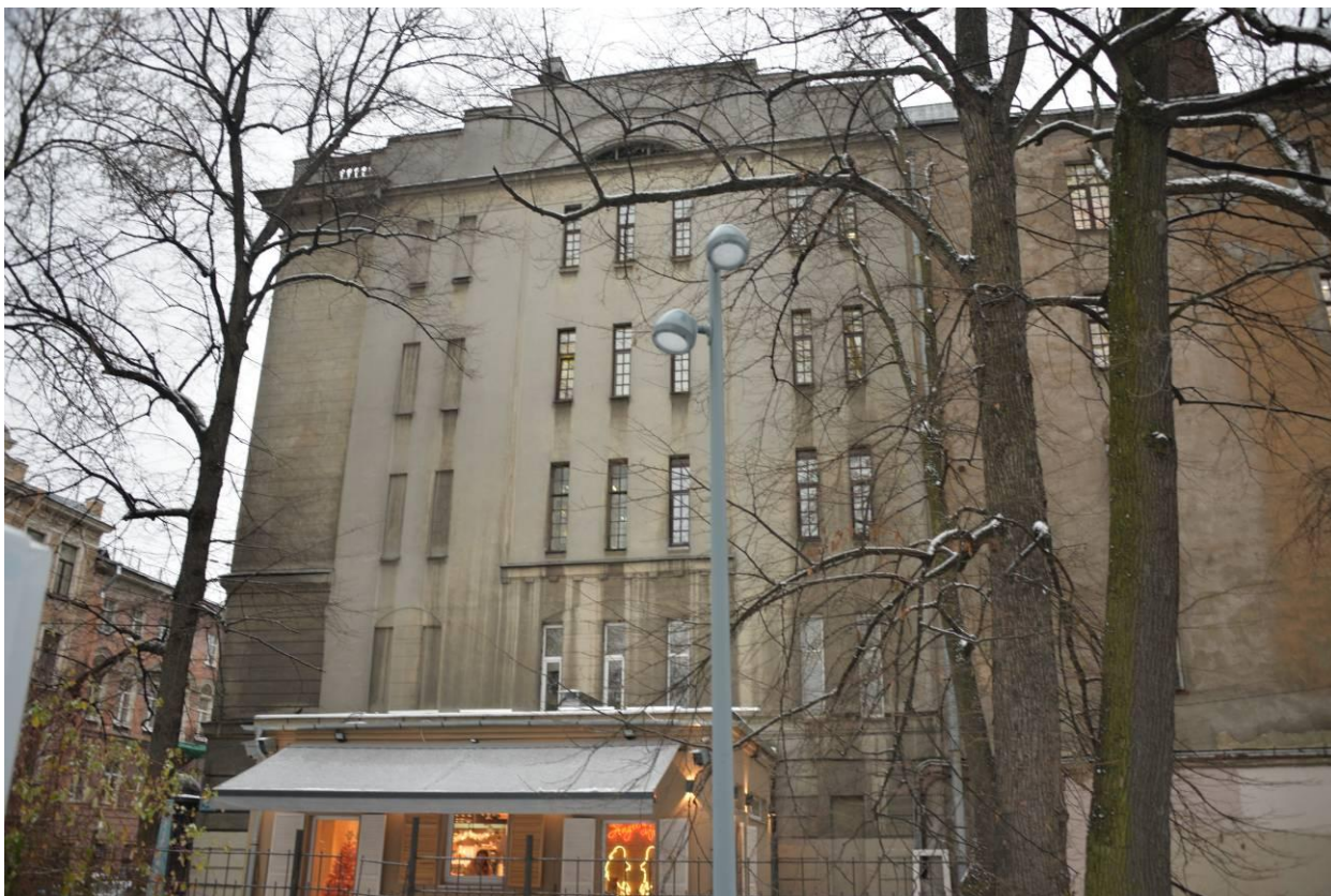
Фото 7. Фрагмент торцевого (западного) фасада выявленного объекта культурного наследия «Доходный дом»
