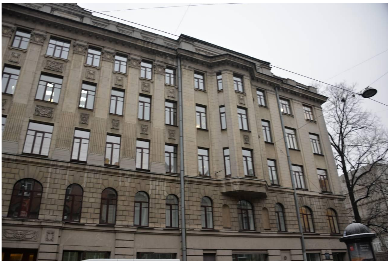
Фото 5. Фрагмент лицевого фасада выявленного объекта культурного наследия «Доходный дом»
