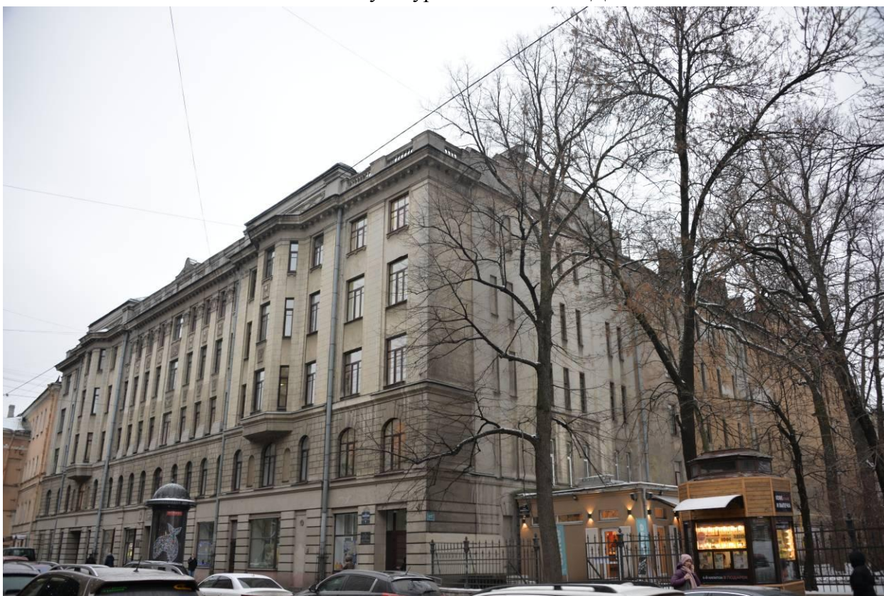
Фото 4. Фрагмент лицевого фасада выявленного объекта культурного наследия «Доходный дом» вдоль улицы Ломоносова
