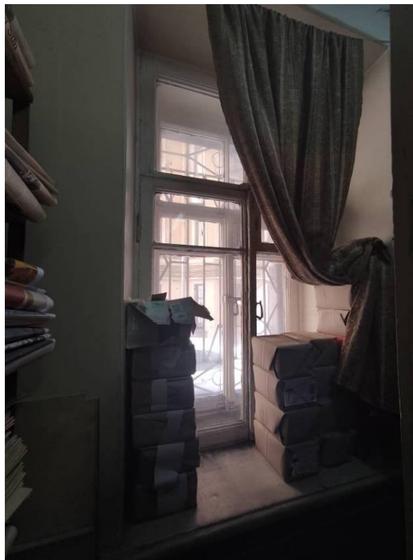
Фото 20. Оконное заполнение помещения №4 (пом.17-Н)
