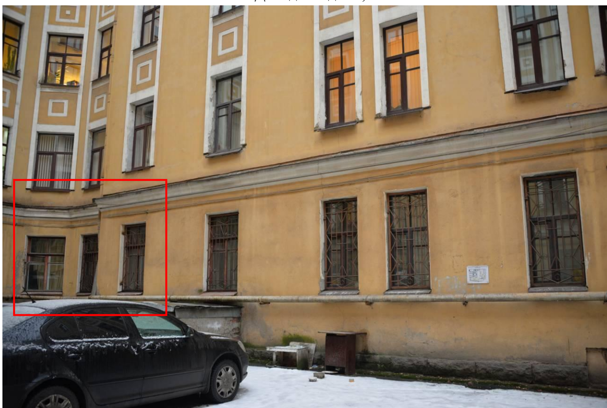
Фото 12. Оконные заполнения квартиры №22 дворового фасада выявленного объекта культурного наследия «Доходный дом»
