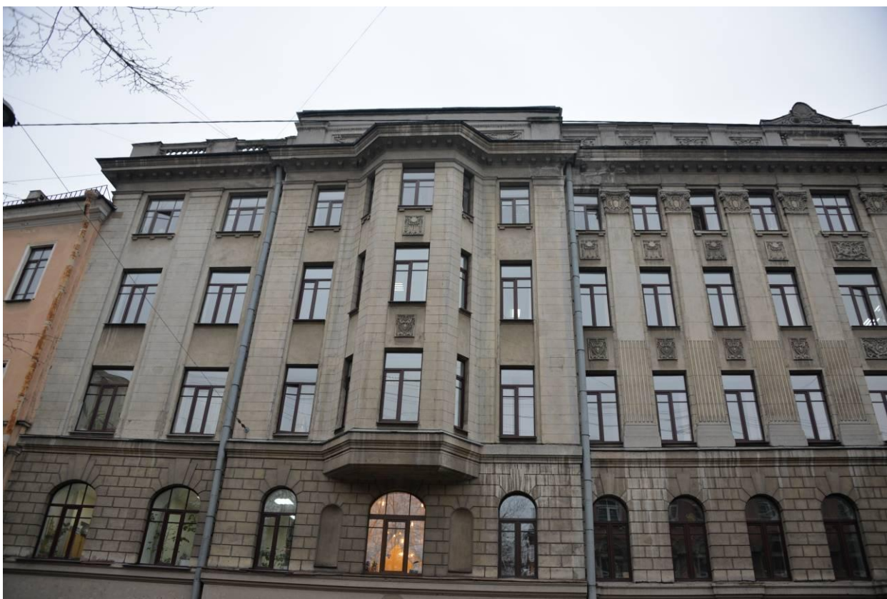
Фото 2. Фрагмент лицевого фасада выявленного объекта культурного наследия «Доходный дом»
