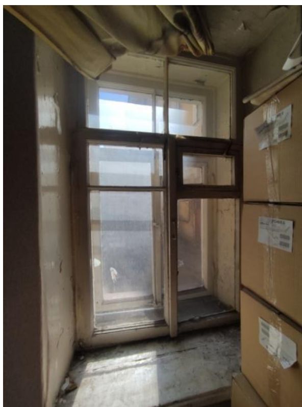
Фото 42. Оконное заполнение помещения №9 (кв.№22)
