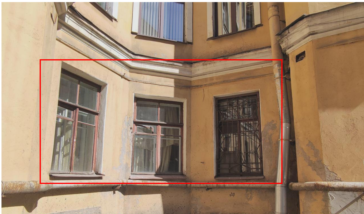
Фото 13. Оконные заполнения квартиры №22 дворового фасада выявленного объекта культурного наследия «Доходный дом»
