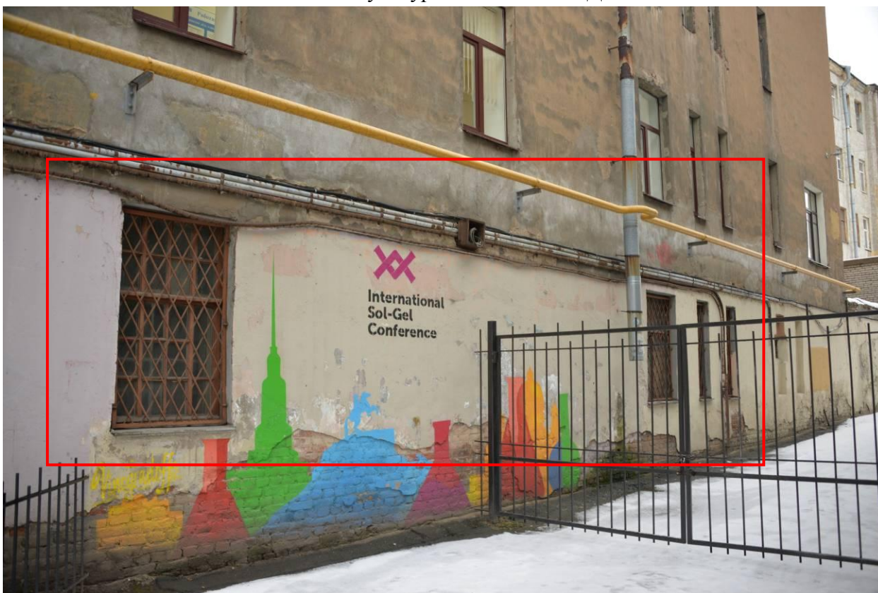
Фото 10. Оконные заполнения квартиры №22 торцевого (западного) фасада выявленного объекта культурного наследия «Доходный дом»
