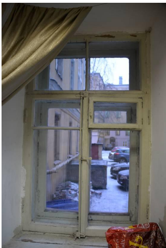
Фото 41. Оконное заполнение помещения №8 (кв.№22)
