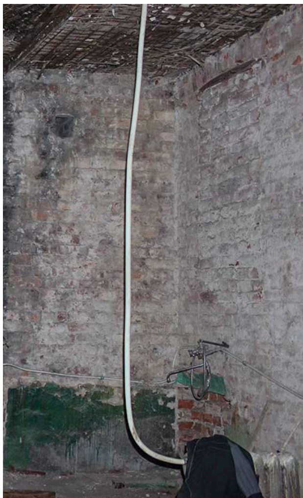
10. Внутреннее пространство квартиры № 40. На фото справа – заложённый кирпичом проем.
