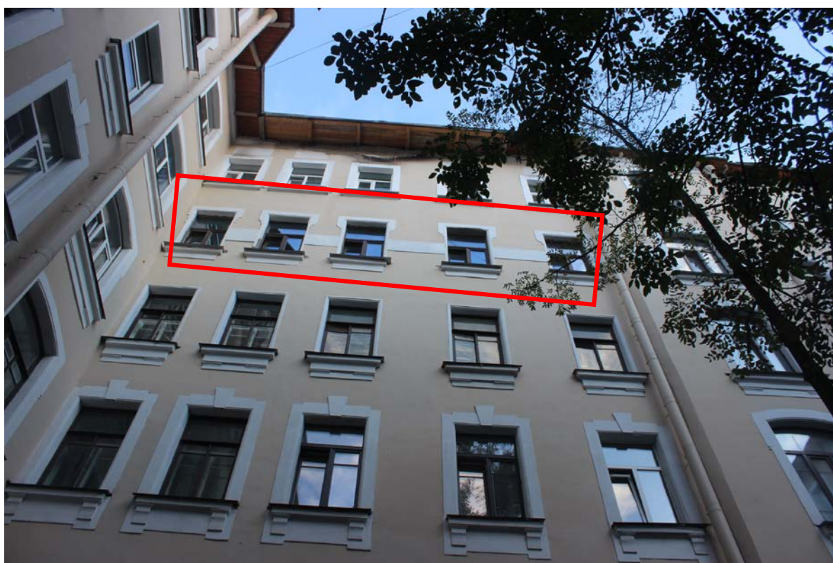
4. Вид дворового фасада здания по адресу: Санкт-Петербург, улица Большая Зеленина, д., 28. Окна квартиры №40
