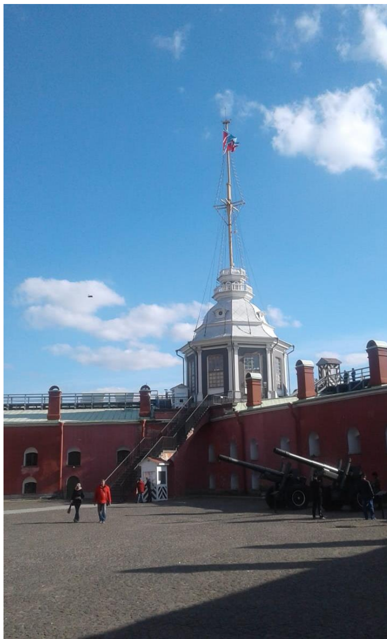
4. Объект культурного наследия федерального значения «Бастион Нарышкин» в составе объекта культурного наследия федерального значения «Петропавловская крепость» по адресу: г. Санкт-Петербург, Петропавловская крепость, дом 3, литера Д (о. Заячий, Петропавловская крепость). Вид со стороны территории Петропавловской крепости. «Башня флажная» (общий вид).
