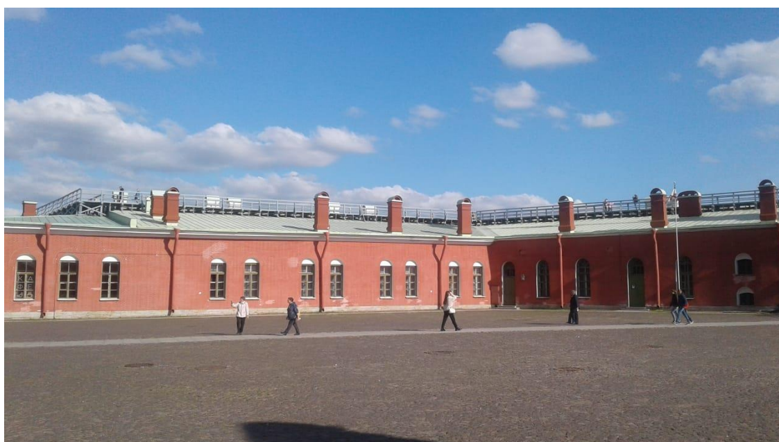
2. Объект культурного наследия федерального значения «Бастион Нарышкин» в составе объекта культурного наследия федерального значения «Петропавловская крепость» по адресу: г. Санкт-Петербург, Петропавловская крепость, дом 3, литера Д (о. Заячий, Петропавловская крепость). Вид со стороны территории Петропавловской крепости в юго-восточном направлении.
