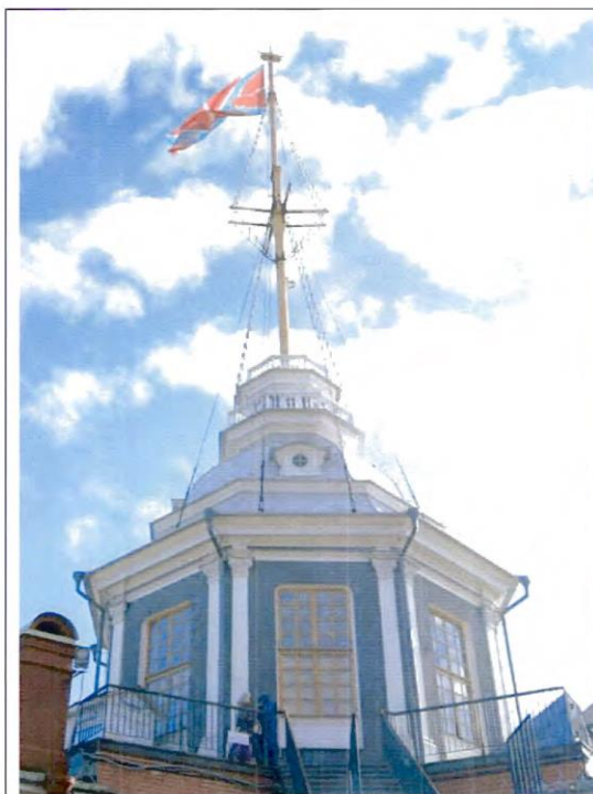
1. Общий вид со стороны северного фасада
