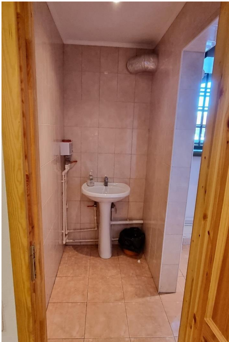
36. Объект культурного наследия федерального значения «Бастион Нарышкин» в составе объекта культурного наследия федерального значения «Петропавловская крепость» по адресу: г. Санкт-Петербург, Петропавловская крепость, дом 3, литера Д (о. Заячий, Петропавловская крепость). Каземат №8. Санузел. Фрагмент интерьера.
