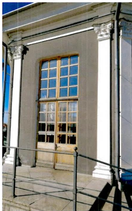
2. Фрагмент южного фасада
