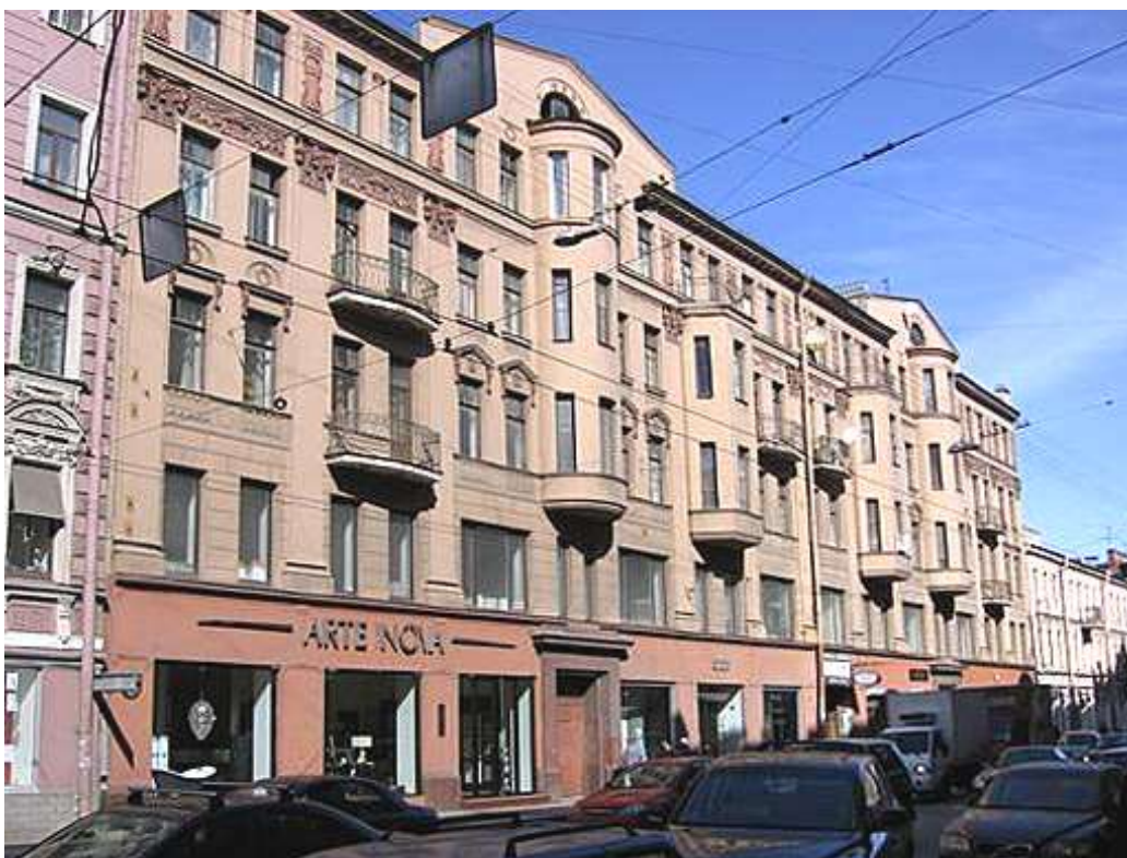
20. Большой пр. П.С., дом 22-24. Главный фасад. Фотоснимок 2009 г.
