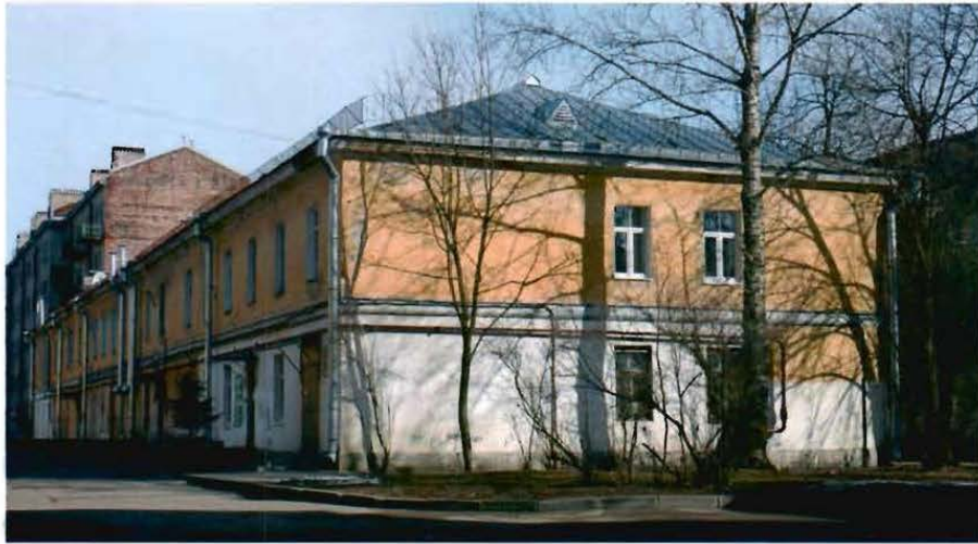
Фото №3. Вид на торцевой (южный) и дворовой (западный) фасад со стороны сада.
