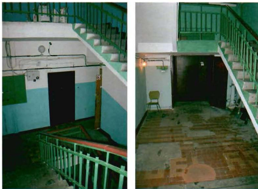
Фото №5, 6. Лестничные клетки.
