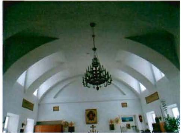
16. Полуциркульный свод с распалубками. Домовая церковь.
