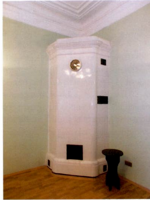
4. Угловая печь в помещении 2-го этажа.
