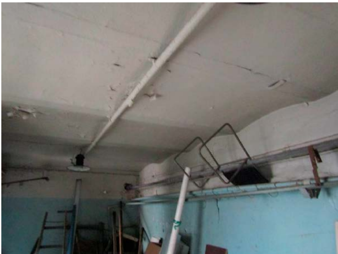
7. Пом. №1 (14-Н) в уровне цокольного этажа объекта культурного наследия федерального значения «Лицей Императорский Александровский. Главное здание. Здесь учился писатель Салтыков-Щедрин М.Е.», расположенного по адресу: г. Санкт-Петербург, Каменноостровский пр., д. 21, литера А, пом 13-Н,14-Н,15-Н,16-Н,17-Н,18-Н. 12.05.2022
