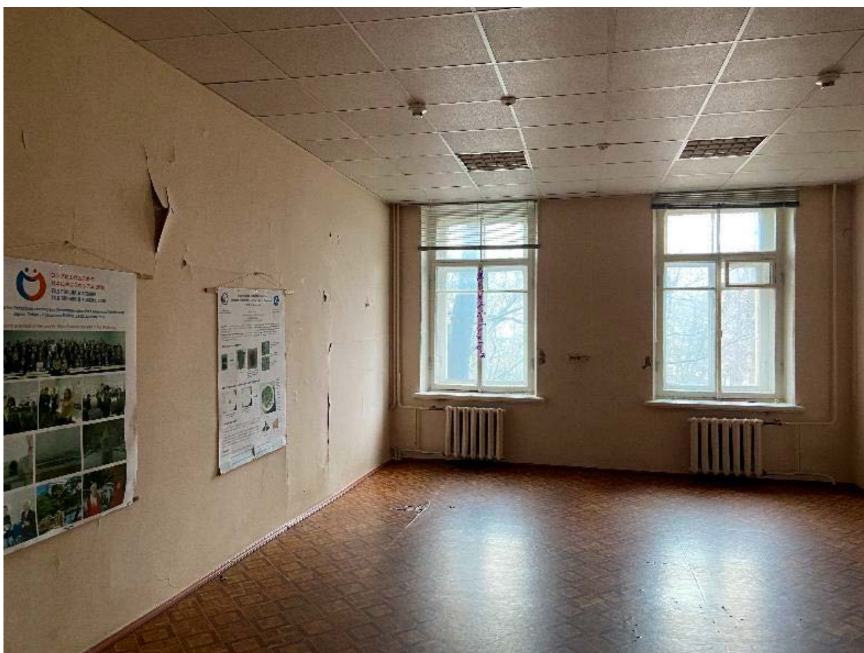
35. Пом. №98 (1-Н) в уровне 3-го этажа объекта культурного наследия федерального значения «Лицей Императорский Александровский. Корпус воспитателей. Здесь в Радиевом институте работали: в 1922-1938 гг. – Вернадский В.И., в 1922-1950 гг. – радиохимик Хлопин В.С.», расположенного по адресу: г. Санкт-Петербург, ул. Рентгена, д. 1, литера А. 12.05.2022
