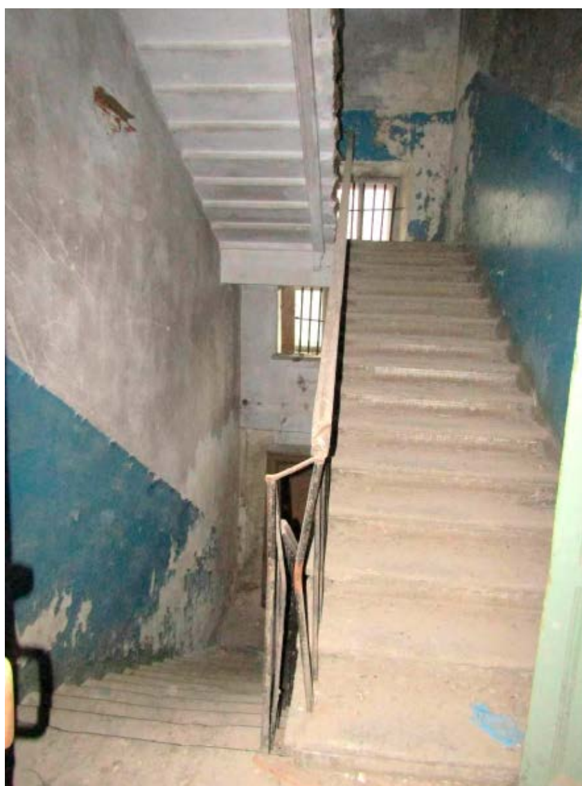
12. Пом. №1 (17-Н) в уровне 1-го этажа объекта культурного наследия федерального значения «Лицей Императорский Александровский. Главное здание. Здесь учился писатель Салтыков-Щедрин М.Е.», расположенного по адресу: г. Санкт-Петербург, Каменноостровский пр., д. 21, литера А, пом 13-Н,14-Н,15-Н,16-Н,17-Н,18-Н. 12.05.2022
