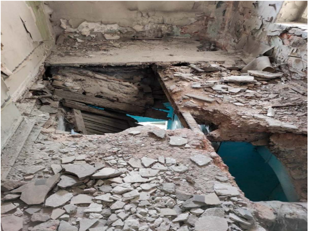
14. Пом. №35 (17-Н) в уровне 2-го этажа объекта культурного наследия федерального значения «Лицей Императорский Александровский. Главное здание. Здесь учился писатель Салтыков-Щедрин М.Е.», расположенного по адресу: г. Санкт-Петербург, Каменноостровский пр., д. 21, литера А, пом 13-Н,14-Н,15-Н,16-Н,17-Н,18-Н. 12.05.2022
