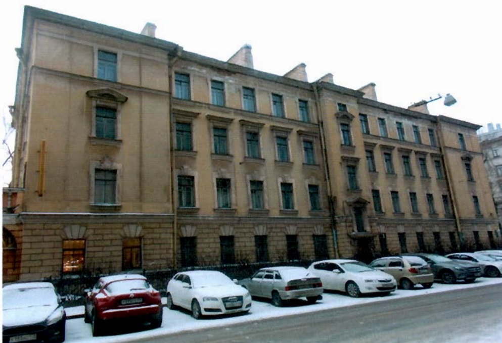
2. Северный фасад здания.
