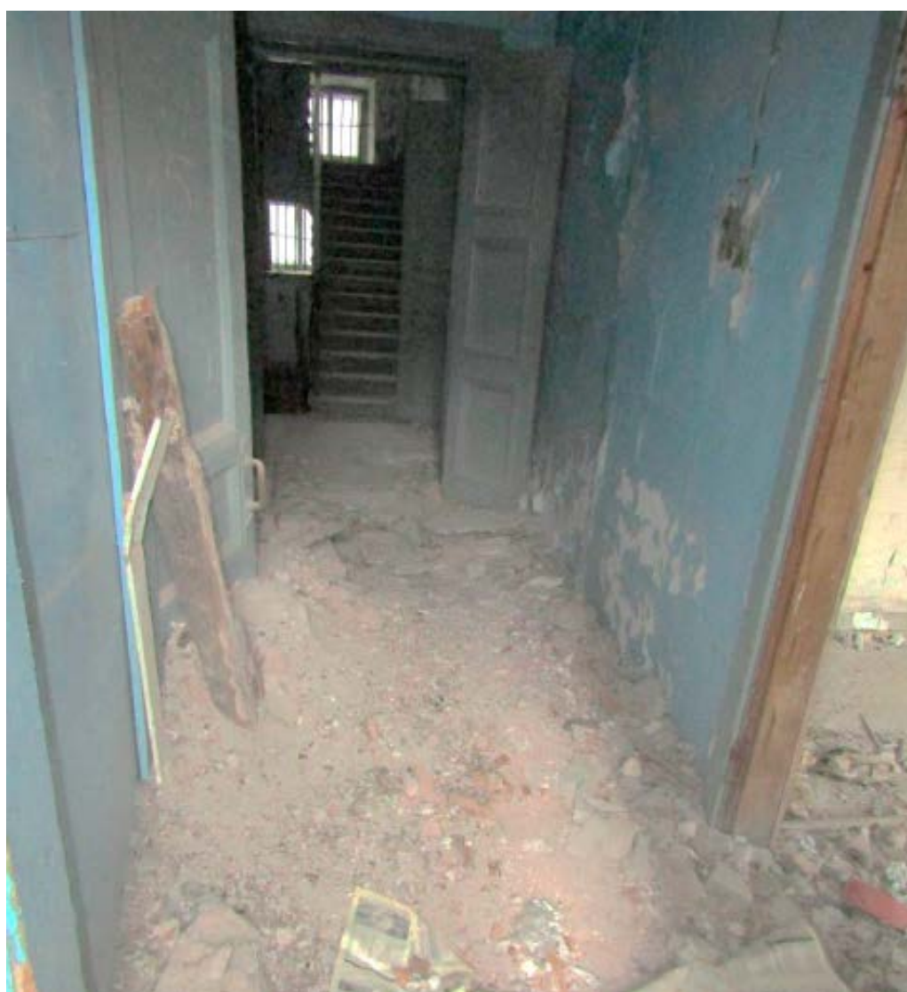
11. Пом. №15 (17-Н) в уровне 1-го этажа объекта культурного наследия федерального значения «Лицей Императорский Александровский. Главное здание. Здесь учился писатель Салтыков-Щедрин М.Е.», расположенного по адресу: г. Санкт-Петербург, Каменноостровский пр., д. 21, литера А, пом 13-Н,14-Н,15-Н,16-Н,17-Н,18-Н. 12.05.2022
