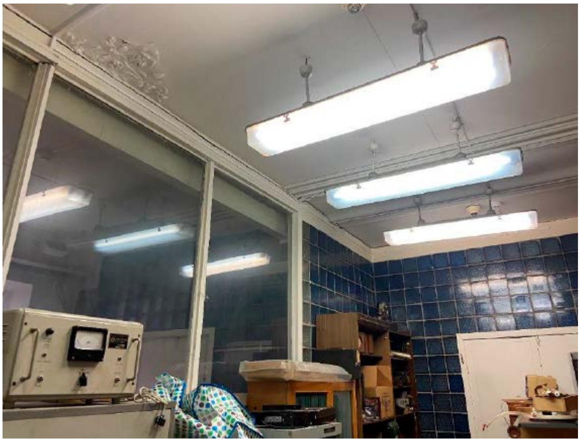
28. Пом. №19 (1-Н) в уровне 2-го этажа объекта культурного наследия федерального значения «Лицей Императорский Александровский. Корпус воспитателей. Здесь в Радиевом институте работали: в 1922-1938 гг. – Вернадский В.И., в 1922-1950 гг. – радиохимик Хлопин В.С.», расположенного по адресу: г. Санкт-Петербург, ул. Рентгена, д. 1, литера А. 12.05.2022
