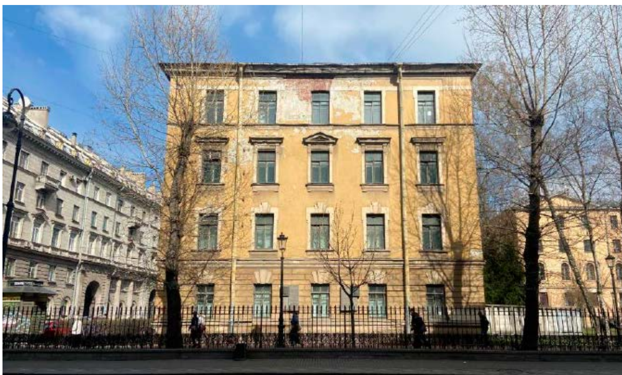
26. Юго-западный лицевой фасад объекта культурного наследия федерального значения «Лицей Императорский Александровский. Корпус воспитателей. Здесь в Радиевом институте работали: в 1922-1938 гг. – Вернадский В.И., в 1922-1950 гг. – радиохимик Хлопин В.С.», расположенного по адресу: г. Санкт-Петербург, ул. Рентгена, д. 1, литера А. 12.05.2022
