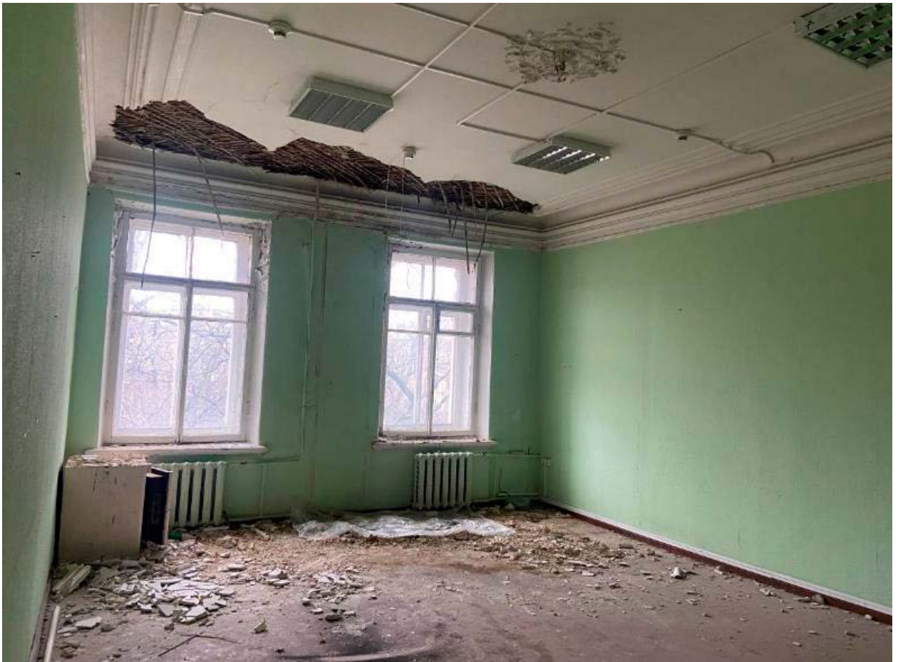
37. Пом. №128 (1-Н) в уровне 4-го этажа объекта культурного наследия федерального значения «Лицей Императорский Александровский. Корпус воспитателей. Здесь в Радиевом институте работали: в 1922-1938 гг. – Вернадский В.И., в 1922-1950 гг. – радиохимик Хлопин В.С.», расположенного по адресу: г. Санкт-Петербург, ул. Рентгена, д. 1, литера А. 12.05.2022
