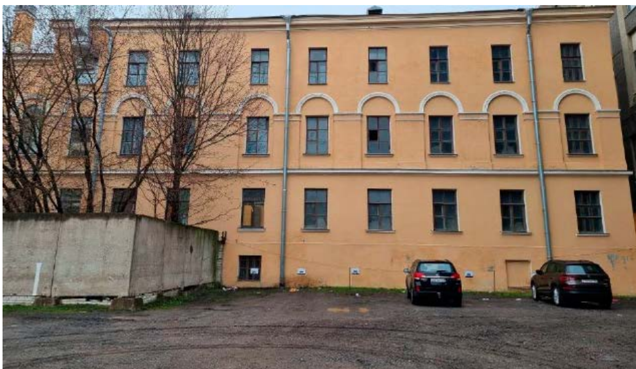
1. Юго-восточный дворовый фасад объекта культурного наследия федерального значения «Лицей Императорский Александровский. Главное здание. Здесь учился писатель Салтыков-Щедрин М.Е.», расположенного по адресу: г. Санкт-Петербург, Каменноостровский пр., д. 21, литера А. 12.05.2022
