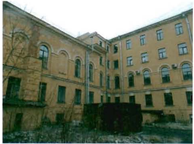
4. Фрагмент северного фасада внутреннего двора.
