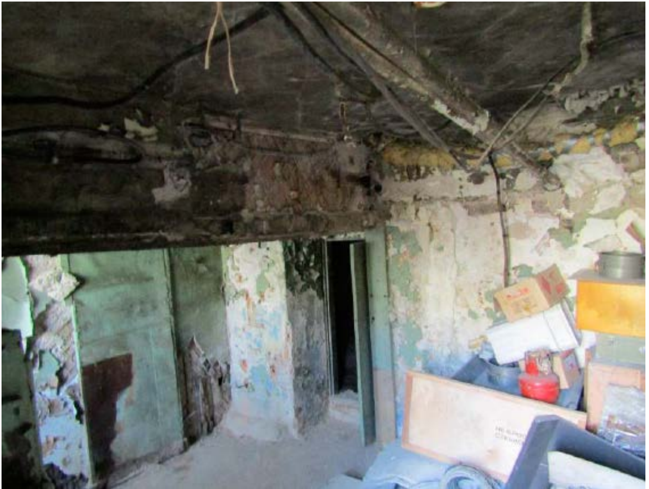
5. Пом. №15 (16-Н) в уровне цокольного этажа объекта культурного наследия федерального значения «Лицей Императорский Александровский. Главное здание. Здесь учился писатель Салтыков-Щедрин М.Е.», расположенного по адресу: г. Санкт-Петербург, Каменноостровский пр., д. 21, литера А, пом 13-Н,14-Н,15-Н,16-Н,17-Н,18-Н. 12.05.2022
