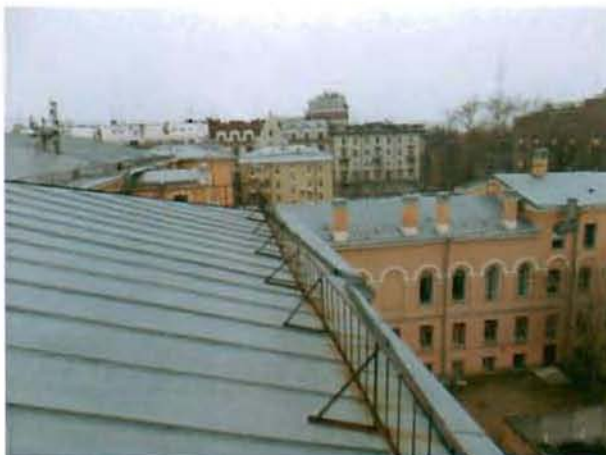
7. Фрагмент двускатной крыши.
