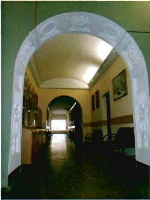
15. Арочные проемы с лепными композициями. Второй этаж.
