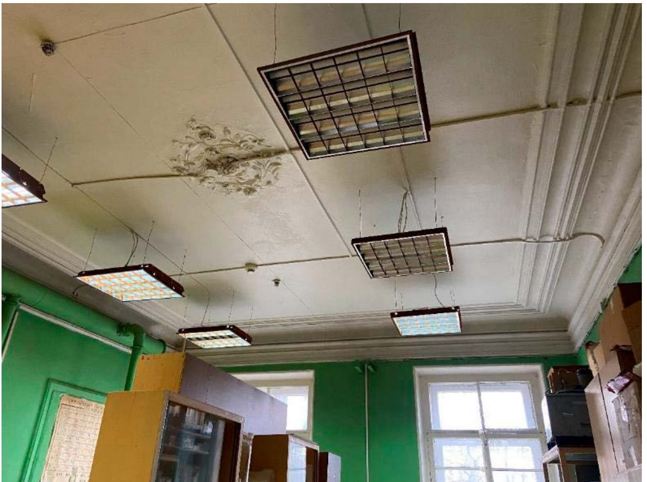
31. Пом. №43 (1-Н) в уровне 2-го этажа объекта культурного наследия федерального значения «Лицей Императорский Александровский. Корпус воспитателей. Здесь в Радиевом институте работали: в 1922-1938 гг. – Вернадский В.И., в 1922-1950 гг. – радиохимик Хлопин В.С.», расположенного по адресу: г. Санкт-Петербург, ул. Рентгена, д. 1, литера А. 12.05.2022
