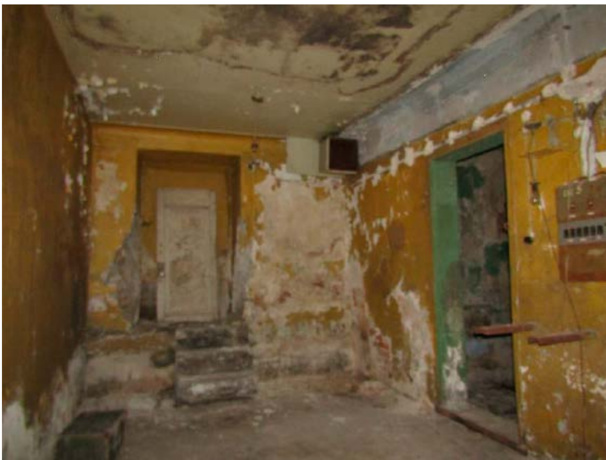
6. Пом. №13 (16-Н) в уровне цокольного этажа объекта культурного наследия федерального значения «Лицей Императорский Александровский. Главное здание. Здесь учился писатель Салтыков-Щедрин М.Е.», расположенного по адресу: г. Санкт-Петербург, Каменноостровский пр., д. 21, литера А, пом 13-Н,14-Н,15-Н,16-Н,17-Н,18-Н. 12.05.2022
