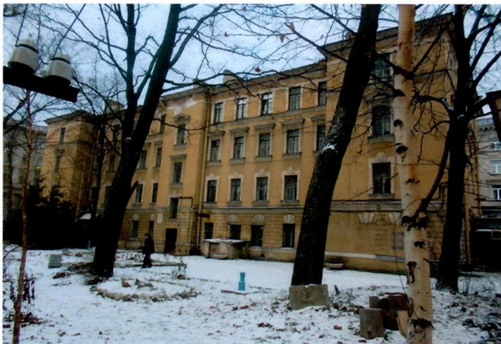
1. Южный фасад здания.
