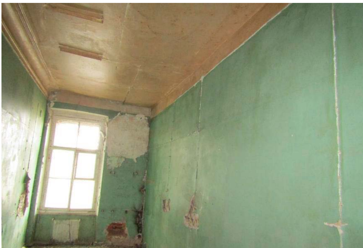
13. Пом. №26 (17-Н) в уровне 2-го этажа объекта культурного наследия федерального значения «Лицей Императорский Александровский. Главное здание. Здесь учился писатель Салтыков-Щедрин М.Е.», расположенного по адресу: г. Санкт-Петербург, Каменноостровский пр., д. 21, литера А, пом 13-Н,14-Н,15-Н,16-Н,17-Н,18-Н. 12.05.2022
