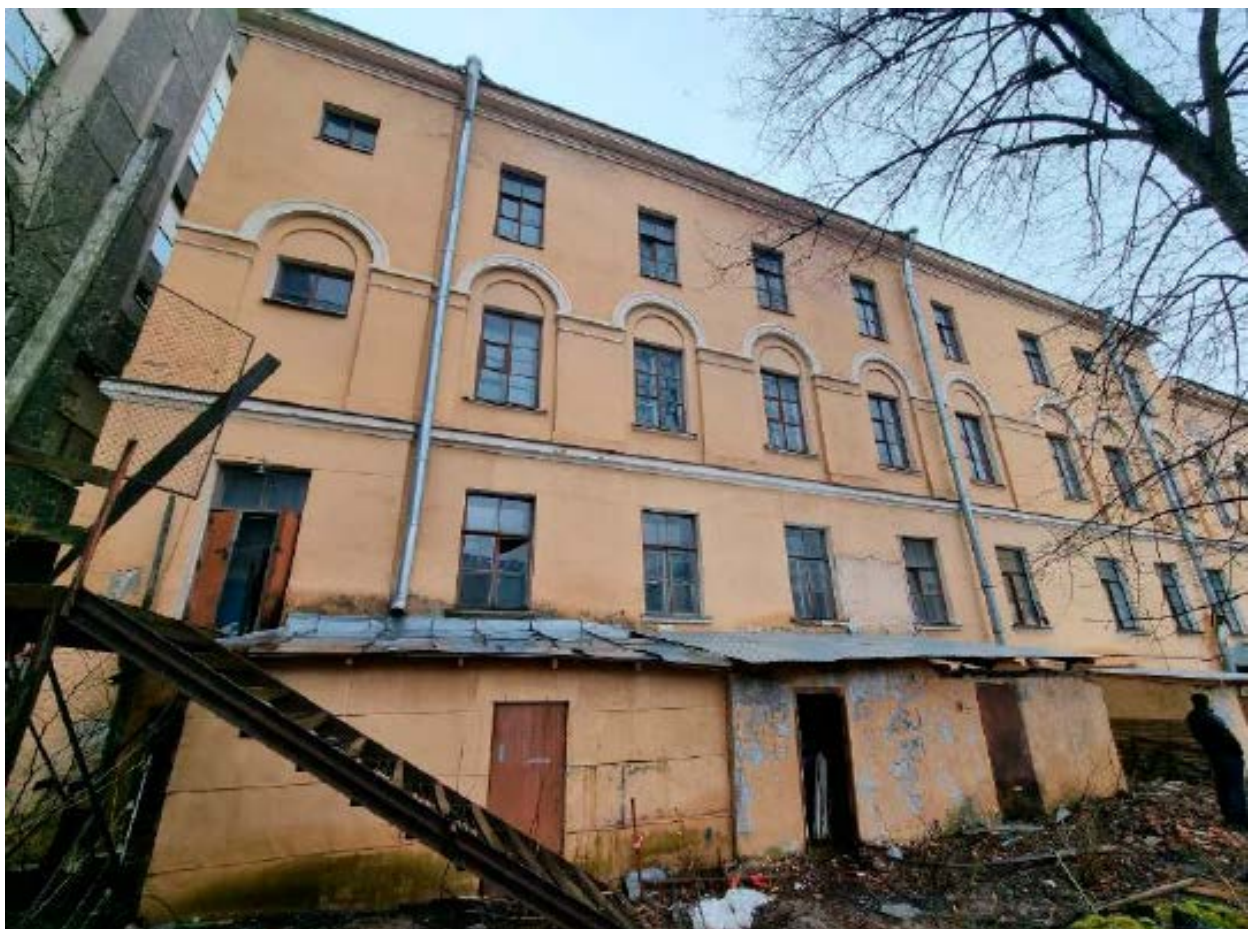
2. Северо-западный дворовый фасад объекта культурного наследия федерального значения «Лицей Императорский Александровский. Главное здание. Здесь учился писатель Салтыков-Щедрин М.Е.», расположенного по адресу: г. Санкт-Петербург, Каменноостровский пр., д. 21, литера А. 12.05.2022
