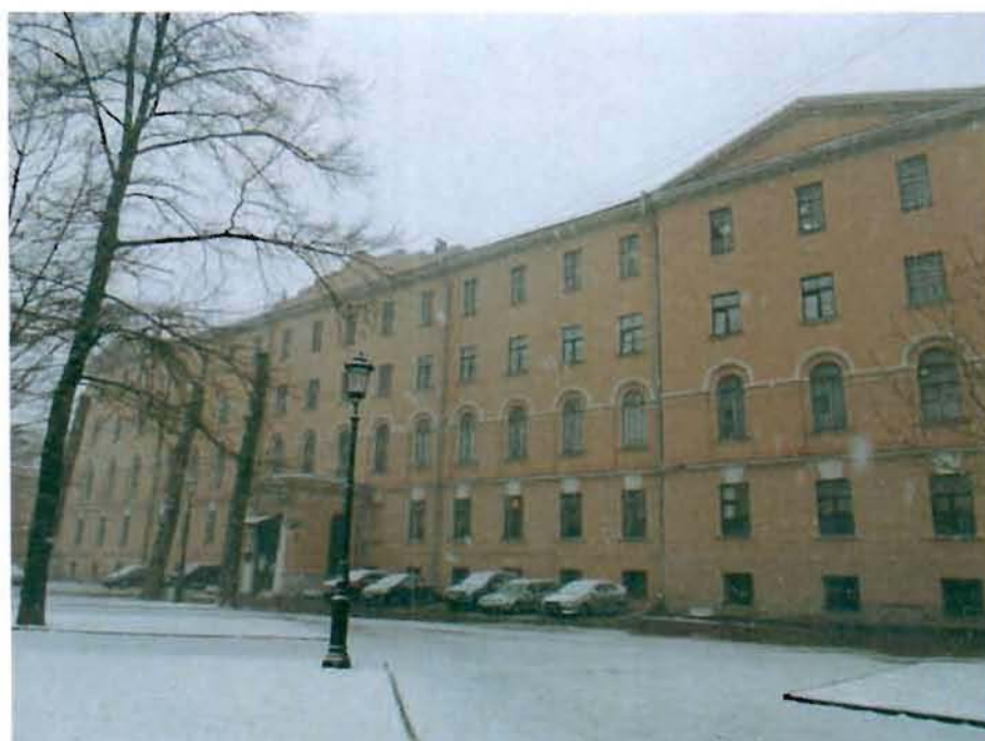
2. Западный фасад здания. Вид с юга.
