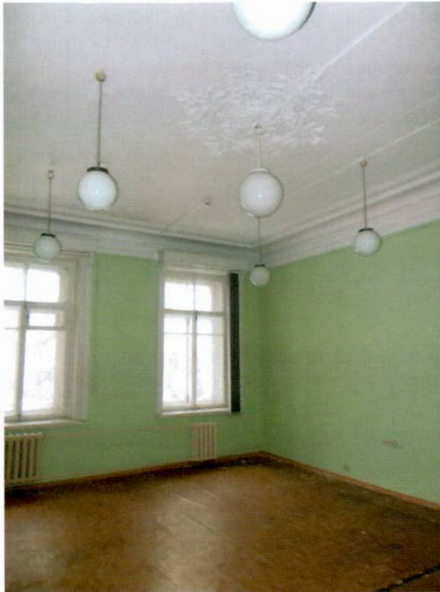
7. Интерьер помещения 3-го этажа.
