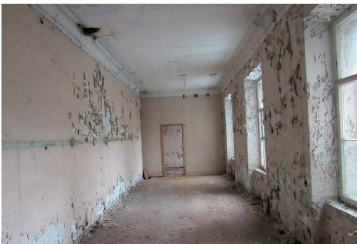
10. Пом. №14 (17-Н) в уровне 1-го этажа объекта культурного наследия федерального значения «Лицей Императорский Александровский. Главное здание. Здесь учился писатель Салтыков-Щедрин М.Е.», расположенного по адресу: г. Санкт-Петербург, Каменноостровский пр., д. 21, литера А, пом 13-Н,14-Н,15-Н,16-Н,17-Н,18-Н. 12.05.2022
