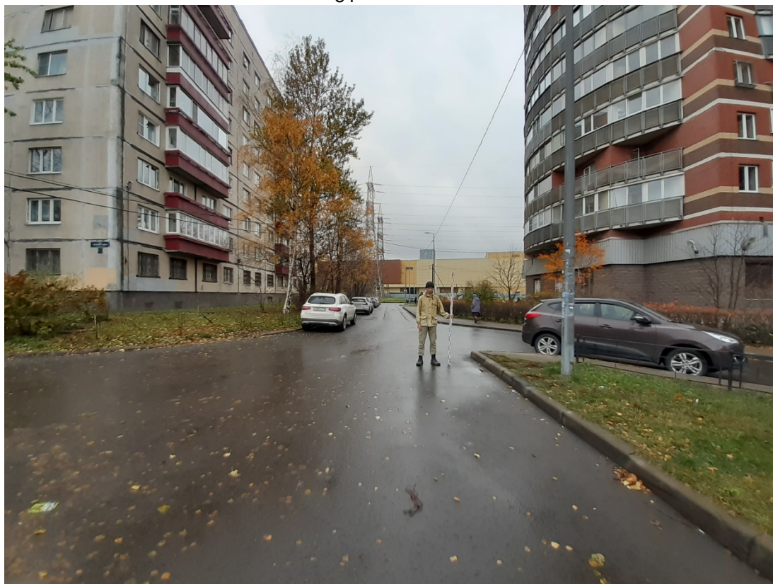
Рис. 27. Санкт-Петербург, «проектирование водопроводных и канализационных сетей для подключения к храму в честь святителя Алексия, митрополита Московского на земельном участке с кадастровым номером 78:13:0007457:20». Общий вид Трассы. Точка съемки 7. Вид на запад.
