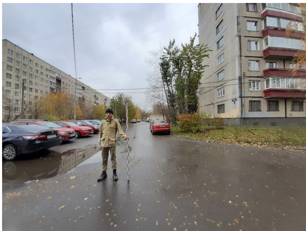
Рис. 28. Санкт-Петербург, «проектирование водопроводных и канализационных сетей для подключения к храму в честь святителя Алексия, митрополита Московского на земельном участке с кадастровым номером 78:13:0007457:20». Общий вид Трассы. Точка съемки 7. Вид на юг.
