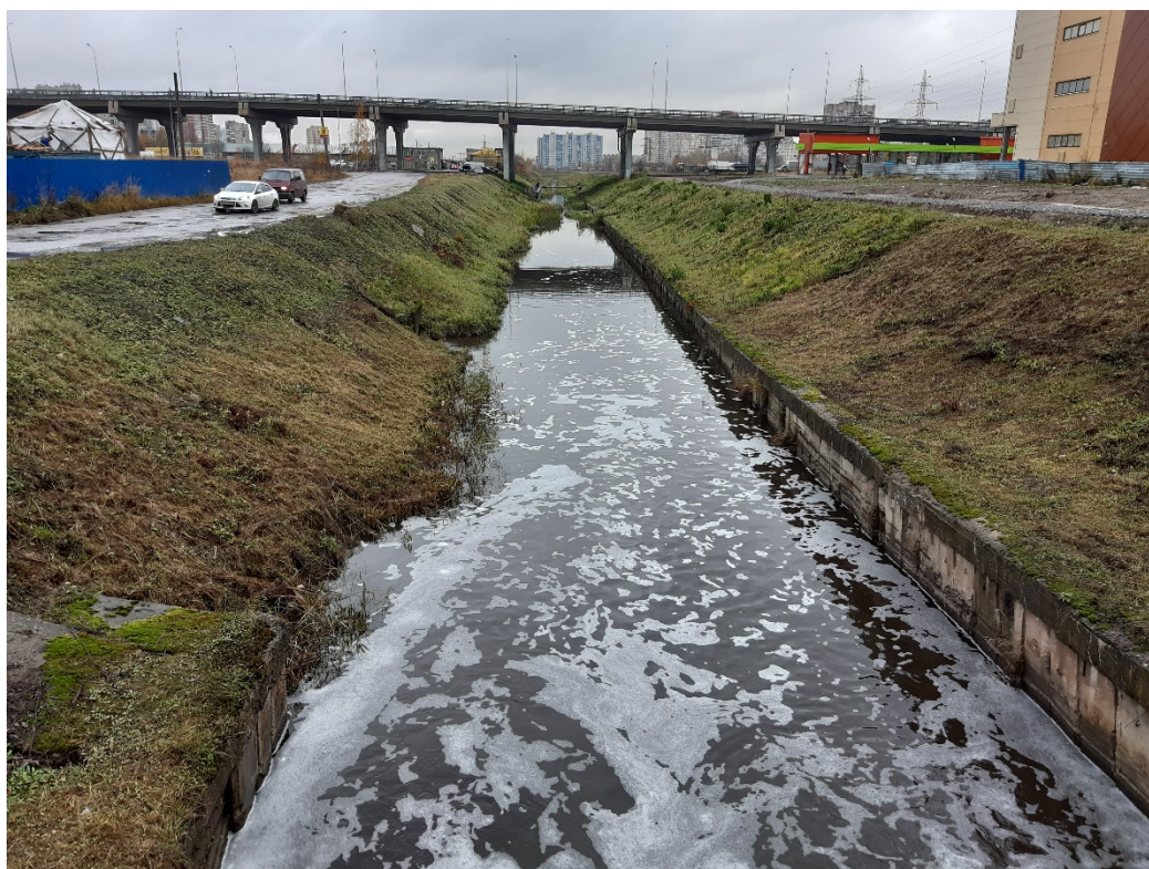
Рис. 20. Санкт-Петербург, «проектирование водопроводных и канализационных сетей для подключения к храму в честь святителя Алексия, митрополита Московского на земельном участке с кадастровым номером 78:13:0007457:20». Общий вид Трассы. Точка съемки 3. Вид на север.
