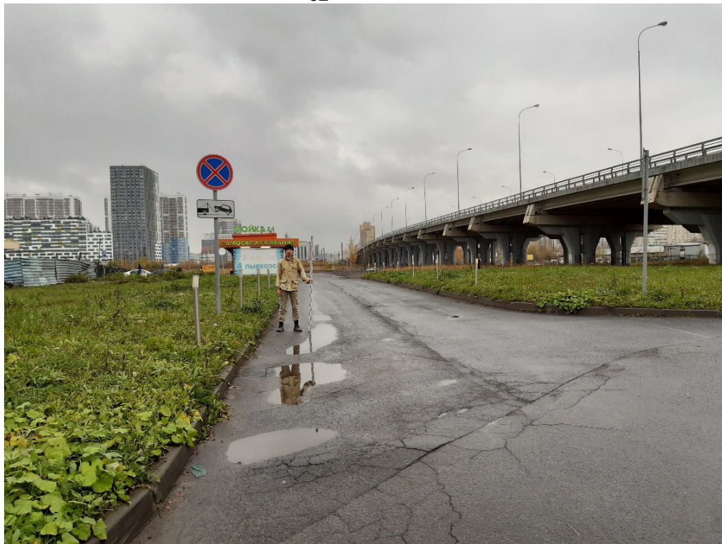
Рис. 23. Санкт-Петербург, «проектирование водопроводных и канализационных сетей для подключения к храму в честь святителя Алексия, митрополита Московского на земельном участке с кадастровым номером 78:13:0007457:20». Общий вид Трассы. Точка съемки 5. Вид на запад.
