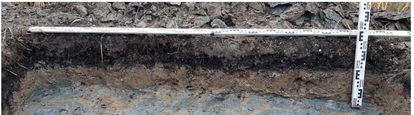
Рис. 35. Санкт-Петербург, «проектирование водопроводных и канализационных сетей для подключения к храму в честь святителя Алексия, митрополита Московского на земельном участке с кадастровым номером 78:13:0007457:20». Шурф 1. Фотофиксация стратиграфии южной стенки.
