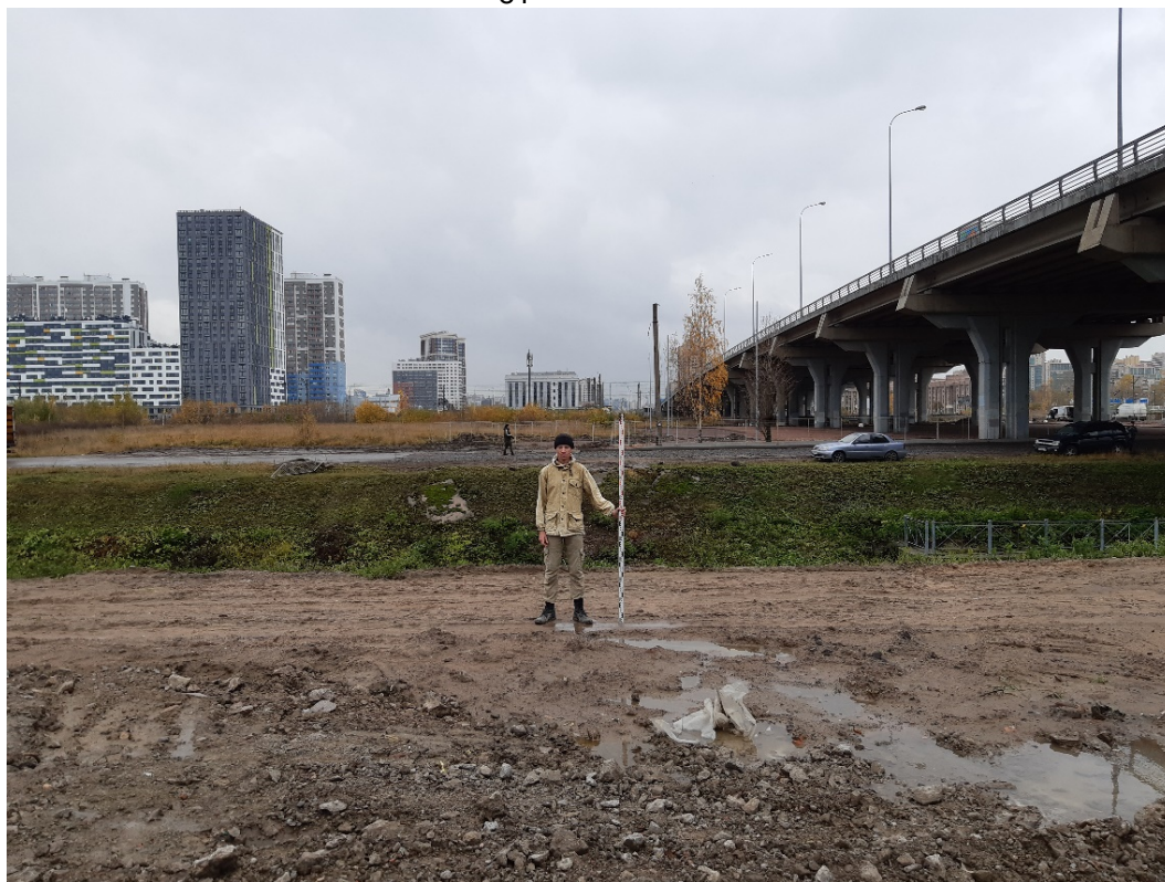
Рис. 21. Санкт-Петербург, «проектирование водопроводных и канализационных сетей для подключения к храму в честь святителя Алексия, митрополита Московского на земельном участке с кадастровым номером 78:13:0007457:20». Общий вид Трассы. Точка съемки 4. Вид на запад.
