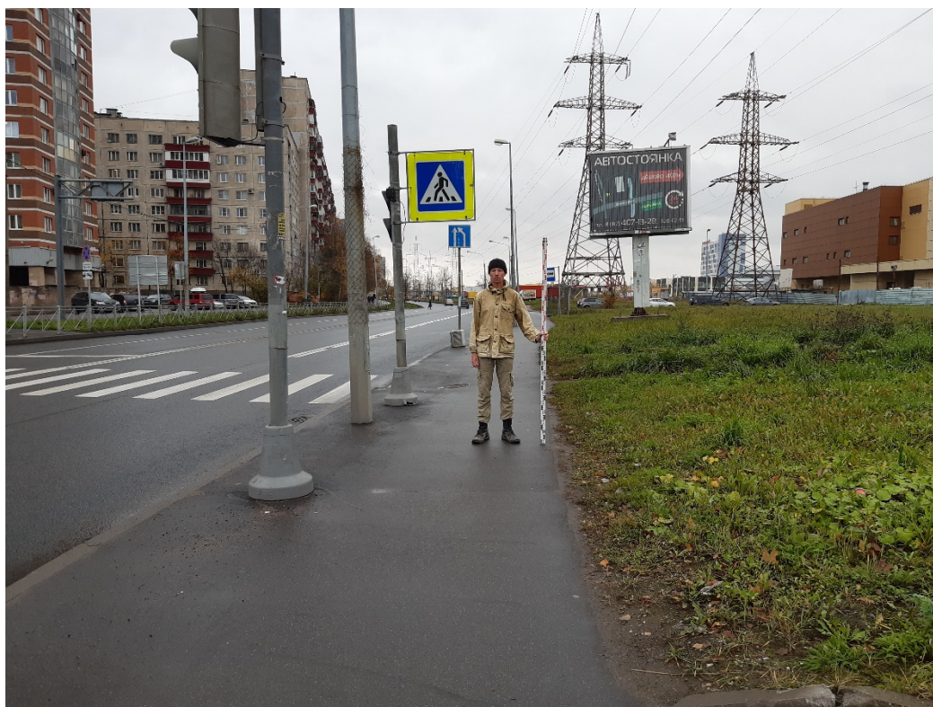
Рис. 24. Санкт-Петербург, «проектирование водопроводных и канализационных сетей для подключения к храму в честь святителя Алексия, митрополита Московского на земельном участке с кадастровым номером 78:13:0007457:20». Общий вид Трассы. Точка съемки 5. Вид на юг.
