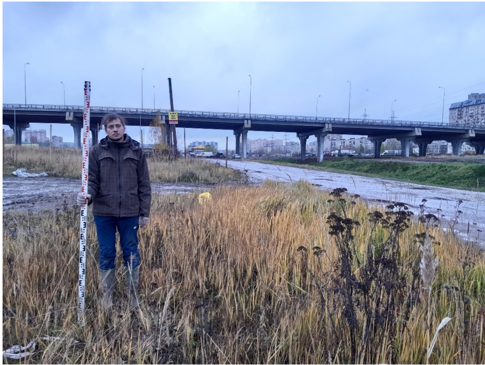
Рис. 29. Санкт-Петербург, «проектирование водопроводных и канализационных сетей для подключения к храму в честь святителя Алексия, митрополита Московского на земельном участке с кадастровым номером 78:13:0007457:20». Шурф 1. Общий вид до начала работ. Вид на север.
