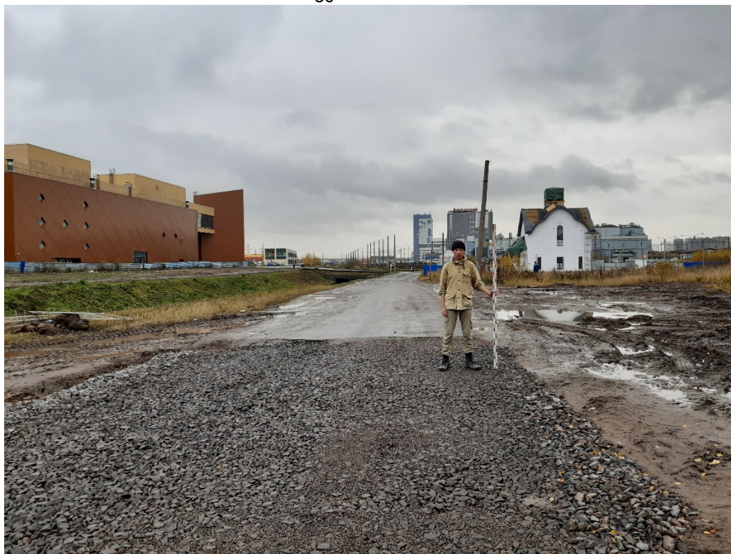
Рис. 19. Санкт-Петербург, «проектирование водопроводных и канализационных сетей для подключения к храму в честь святителя Алексия, митрополита Московского на земельном участке с кадастровым номером 78:13:0007457:20». Общий вид Трассы. Точка съемки.2. Вид на юг.
