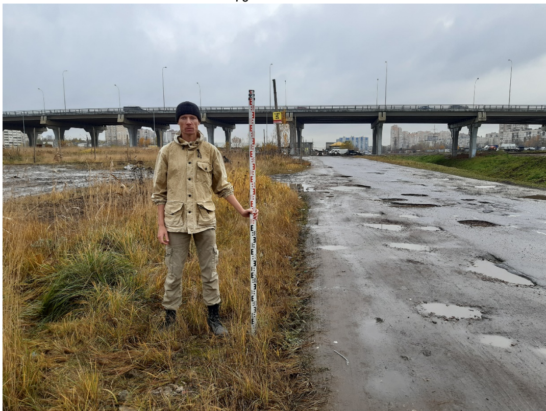
Рис. 17. Санкт-Петербург, «проектирование водопроводных и канализационных сетей для подключения к храму в честь святителя Алексия, митрополита Московского на земельном участке с кадастровым номером 78:13:0007457:20». Общий вид Трассы. Точка съемки 1. Вид на север.
