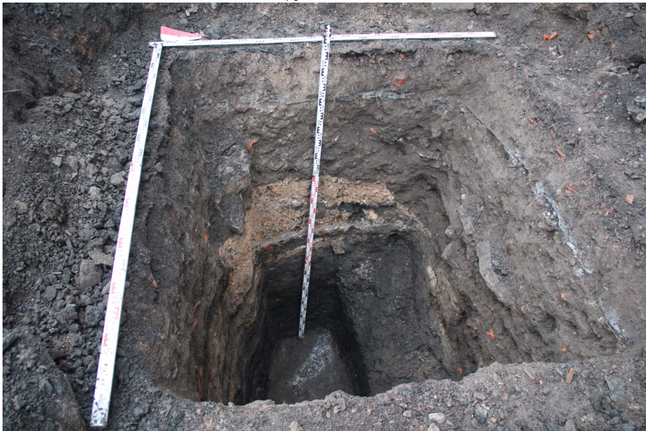
Рис. 23. Санкт-Петербург, Адмиралтейский район. Общий вид Шурфа 1. Вид на Ю.
