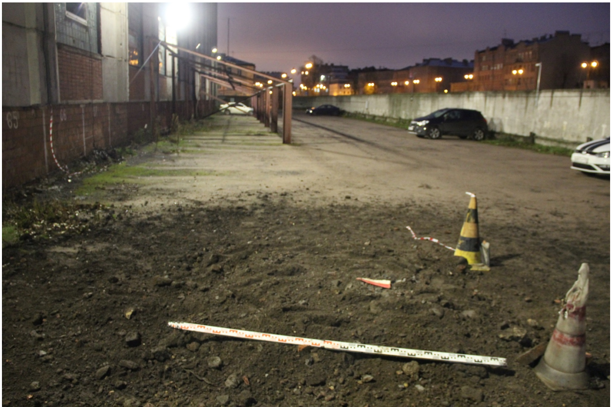
Рис. 26. Санкт-Петербург, Адмиралтейский район. Шурф 1. После рекультивации. Вид на В.
