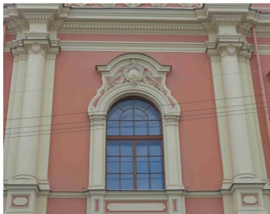
раскрепованные профилированные межэтажный и подоконный карнизы; раскрепованный антаблемент с гладким фризом и карнизом с дентикулами; аттиковая стенка с тумбами, завершенными вазонами, по осям колонн и пилястр; (общее количество вазонов на аттиковых стенках лицевого и дворовых фасадов - 25);
