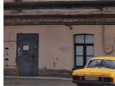
на уровне 2-го и 3-го этажа - местоположение, конфигурация (прямоугольные с лучковыми перемычками), габариты; оформление оконных проемов: профилированные наличники, в уровне 2-го этажа; профилированный межэтажный карниз (бывший венчающий);
