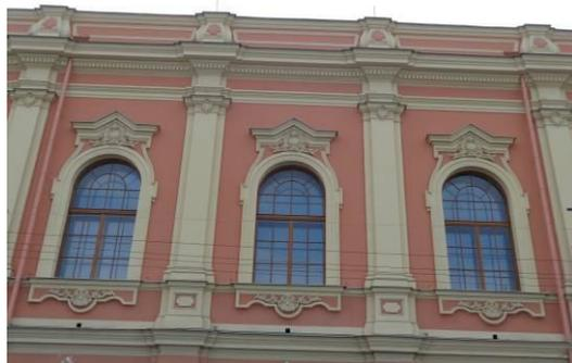
по 2-ой и 12-ой световым осям - трехчетвертные колонны композитного ордера, стилизованные пилястры, несущие профилированные архивольты, лучковые сандрики с лепными картушами в тимпане; фартуки с фигурными филенками; заполнения оконных проемов - материал (дерево), цвет (по результатам расчисток и архивных исследований), исторический рисунок расстекловки;
