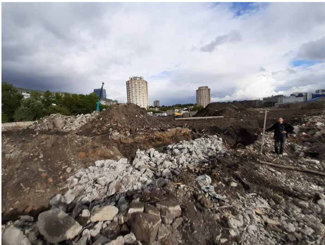
Рис. 22. Санкт-Петербург, Кубинская улица. Земельный участок с кадастровым номером 78:14:0007558:8107. Общий вид участка обследования. Точка съемки 7. Вид на восток
