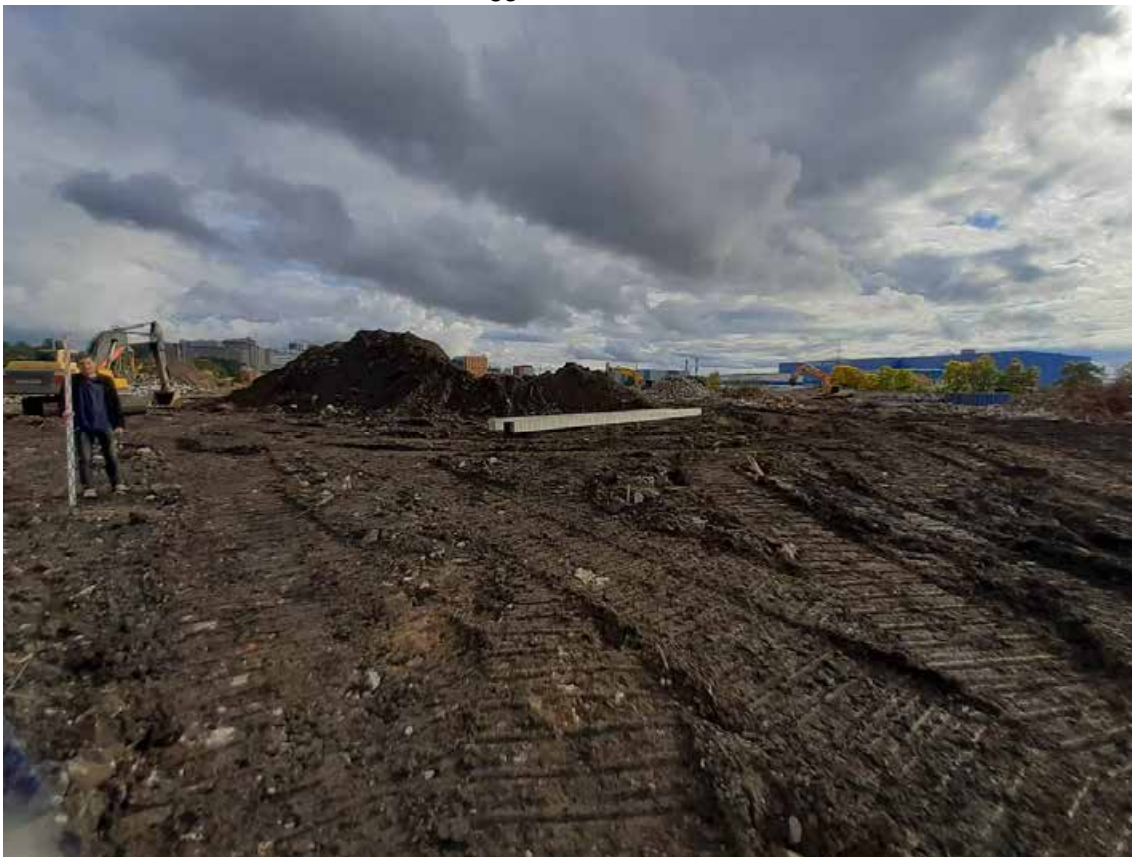
Рис. 23. Санкт-Петербург, Кубинская улица. Земельный участок с кадастровым номером 78:14:0007558:8107. Общий вид участка обследования. Точка съемки 8. Вид на юг
