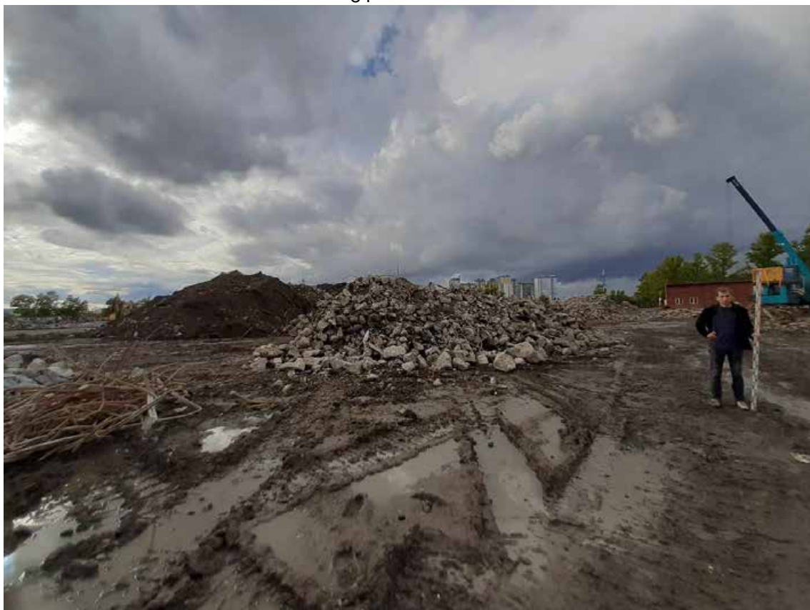
Рис. 25. Санкт-Петербург, Кубинская улица. Земельный участок с кадастровым номером 78:14:0007558:8107. Общий вид участка обследования. Точка съемки 9. Вид на северо-запад
