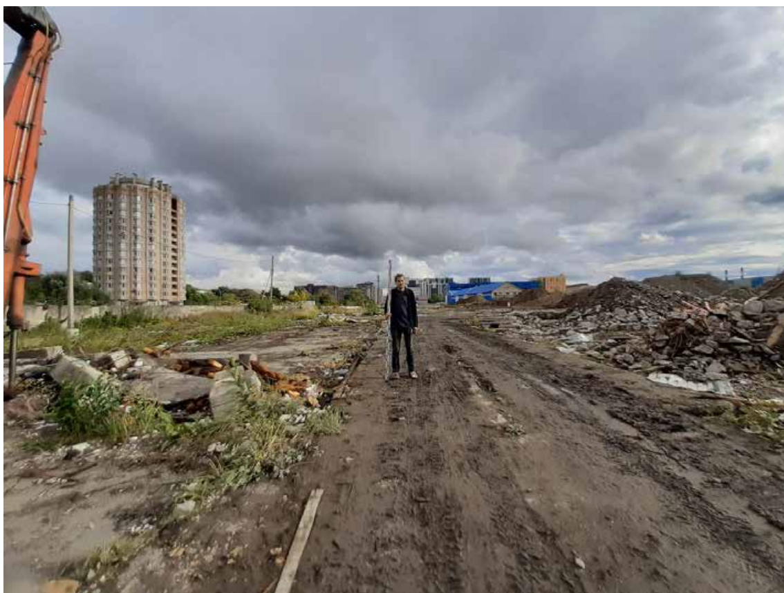
Рис. 26. Санкт-Петербург, Кубинская улица. Земельный участок с кадастровым номером 78:14:0007558:8107. Общий вид участка обследования. Точка съемки 10. Вид на юго-восток
