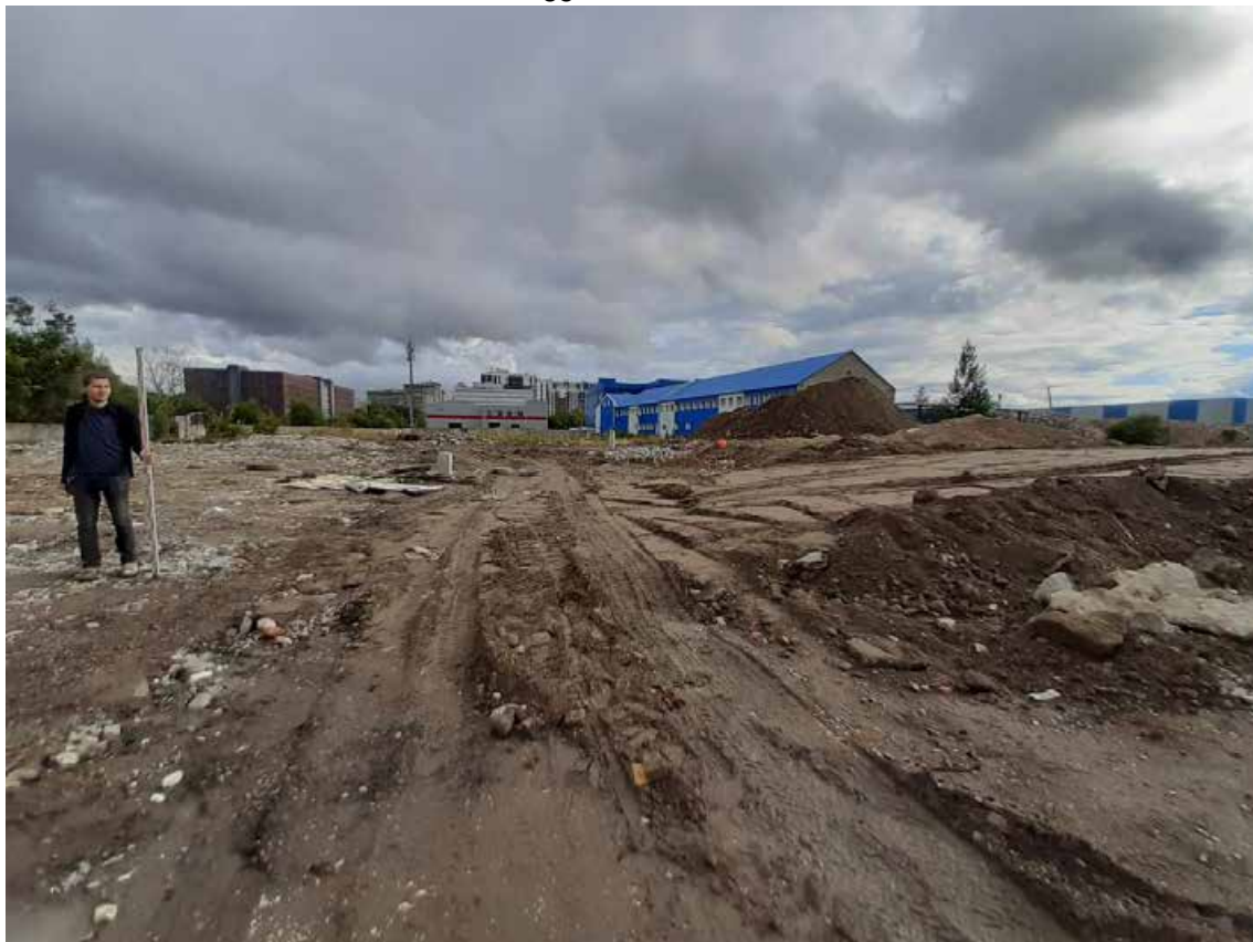
Рис. 27. Санкт-Петербург, Кубинская улица. Земельный участок с кадастровым номером 78:14:0007558:8107. Общий вид участка обследования. Точка съемки 11. Вид на юго-восток
