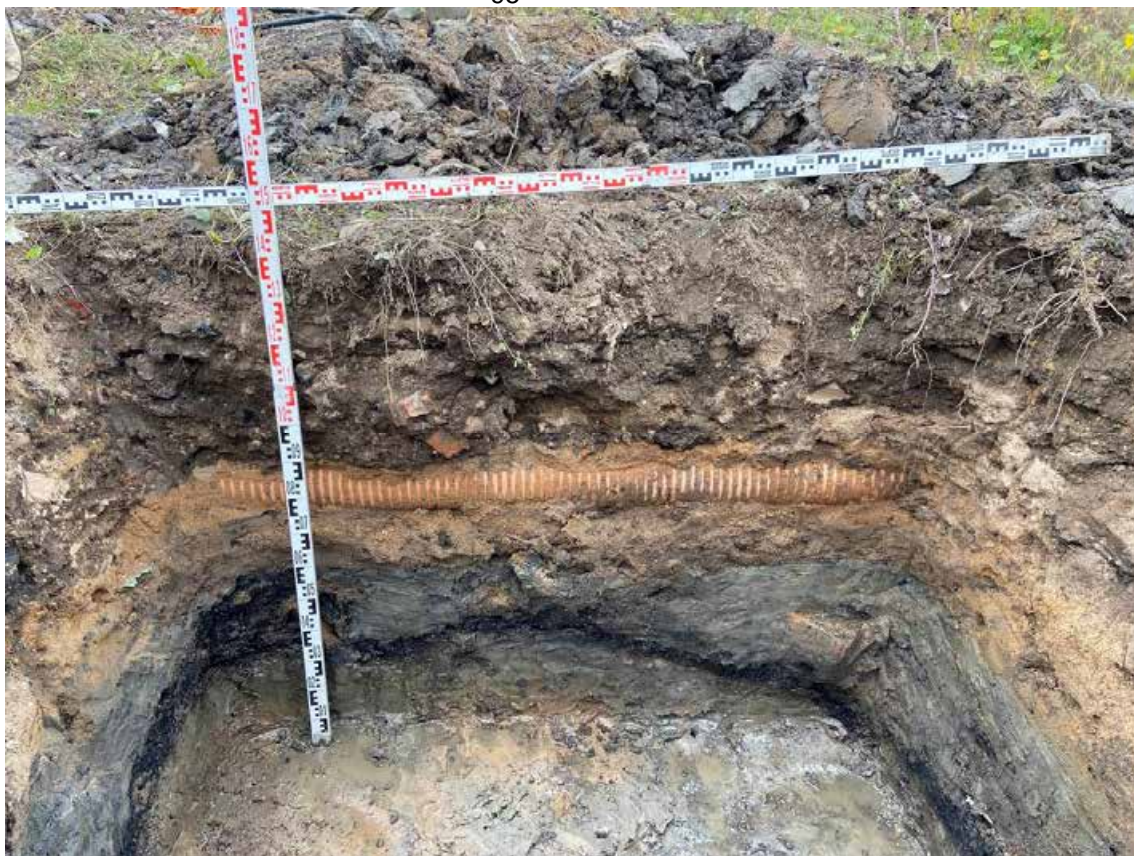
Рис. 43. Санкт-Петербург, Кубинская улица. Земельный участок с кадастровым номером 78:14:0007558:8107. Шурф 2. Фотофиксация стратиграфии восточной стенки
