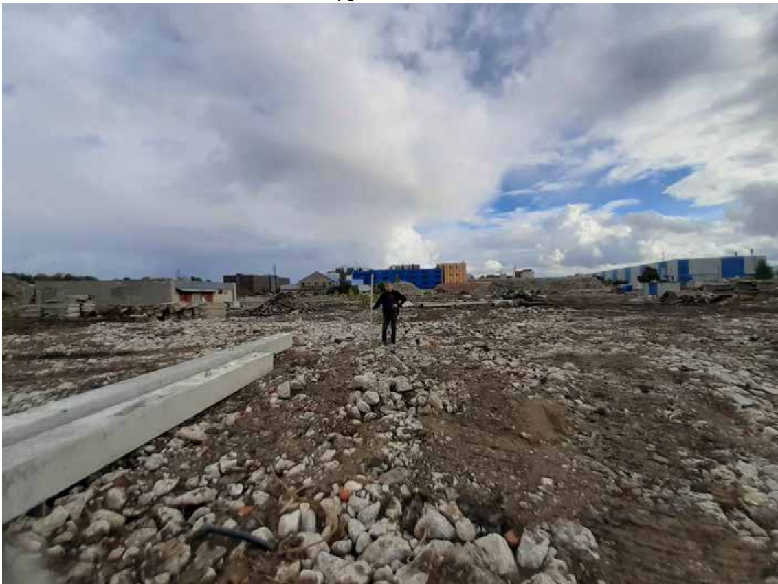
Рис. 15. Санкт-Петербург, Кубинская улица. Земельный участок с кадастровым номером 78:14:0007558:8107. Общий вид участка обследования. Точка съемки 4. Вид на юго-восток
