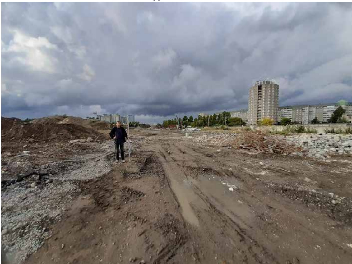
Рис. 29. Санкт-Петербург, Кубинская улица. Земельный участок с кадастровым номером 78:14:0007558:8107. Общий вид участка обследования. Точка съемки 11. Вид на северо-запад
