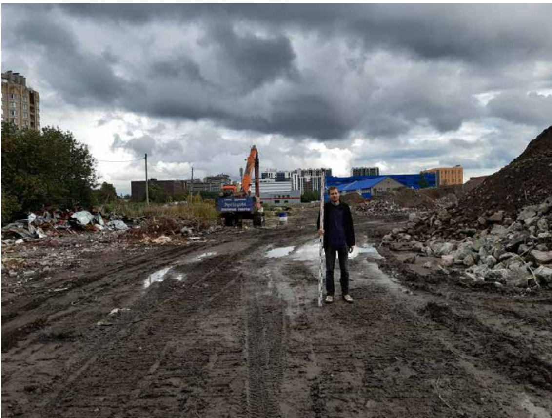
Рис. 24. Санкт-Петербург, Кубинская улица. Земельный участок с кадастровым номером 78:14:0007558:8107. Общий вид участка обследования. Точка съемки 9. Вид на юго-восток
