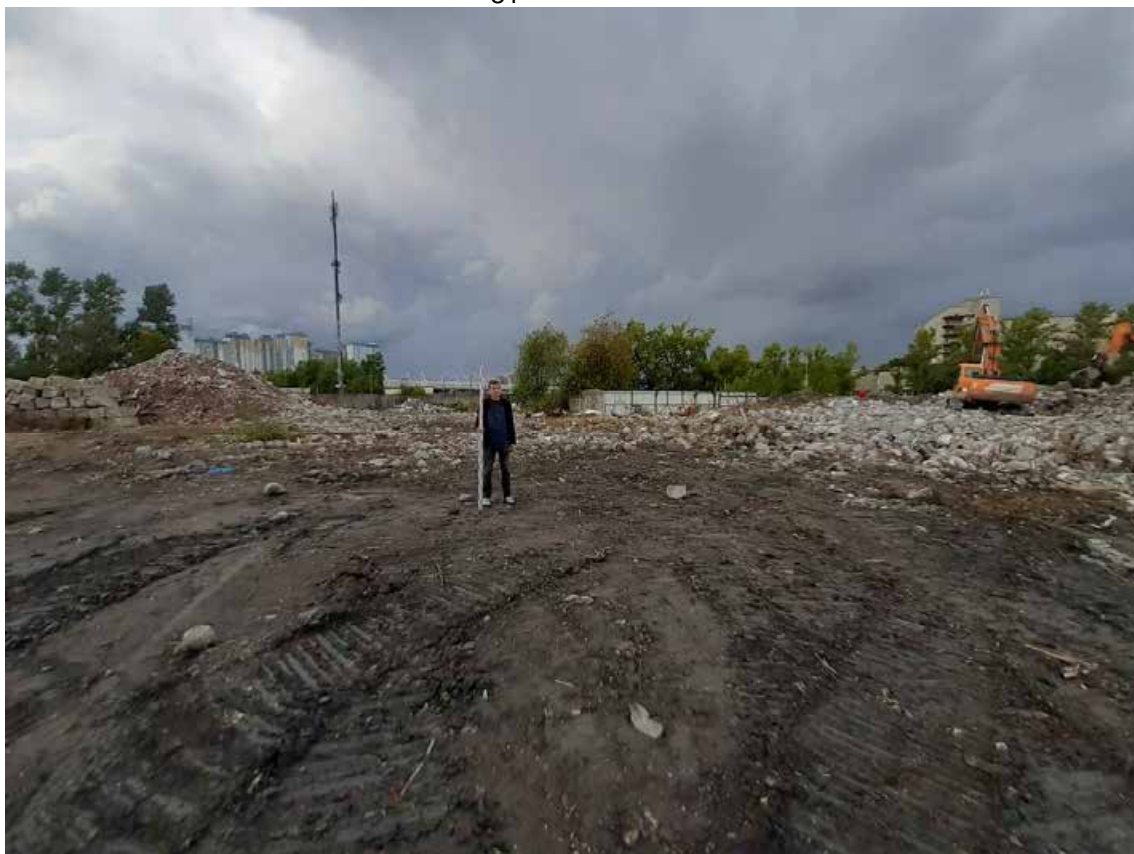
Рис. 19. Санкт-Петербург, Кубинская улица. Земельный участок с кадастровым номером 78:14:0007558:8107. Общий вид участка обследования. Точка съемки 6. Вид на северо-запад
