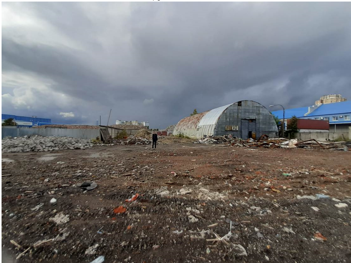
Рис. 17. Санкт-Петербург, Кубинская улица. Земельный участок с кадастровым номером 78:14:0007558:8108. Общий вид участка обследования. Точка съемки 7. Вид на северо-запад
