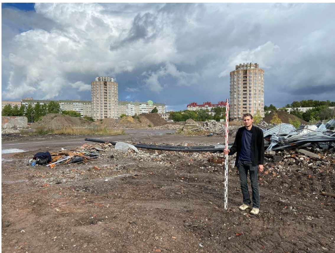
Рис. 18. Санкт-Петербург, Кубинская улица. Земельный участок с кадастровым номером 78:14:0007558:8108. Шурф 1. Фотофиксация до начала работ. Вид на север
