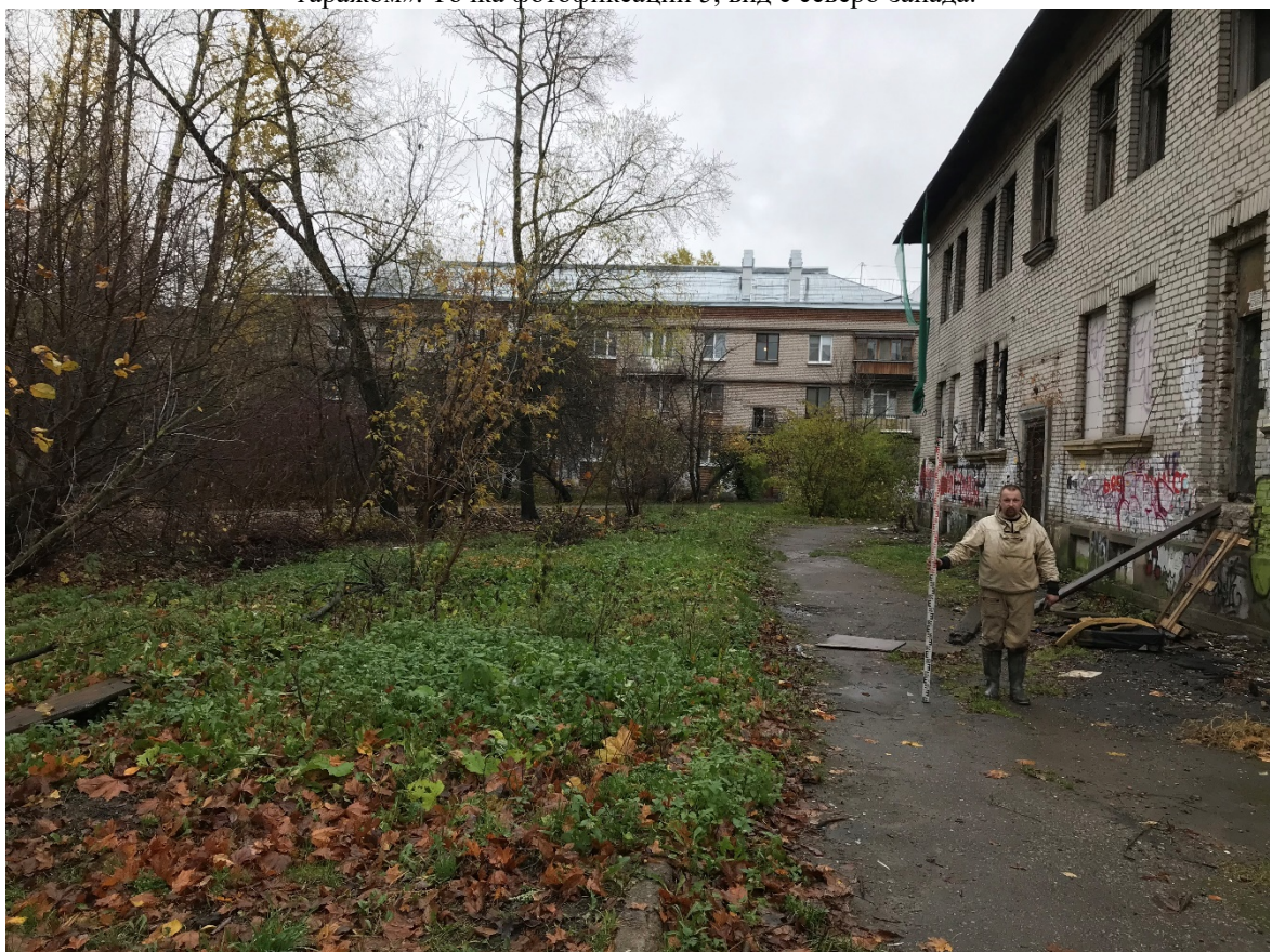
Рис.18. г.Санкт-Петербург. ул. Танкиста Хрустицкого, д. 10, литера А. Земельный участок с кадастровым номером 78:15:0008436:5 под объект «Амбулаторно-поликлиническое учреждение со встроенным гаражом». Точка фотофиксации 6, вид с юго-запада.
