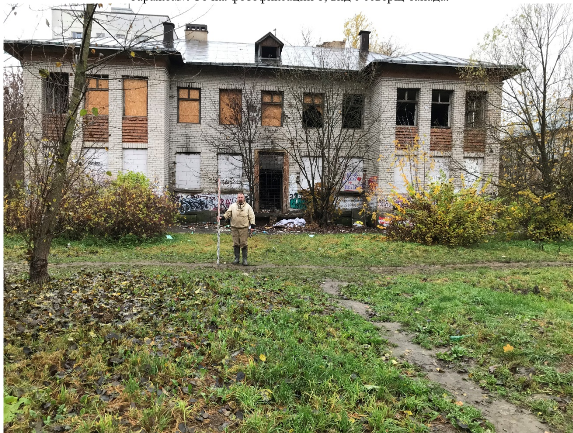
Рис.14. г.Санкт-Петербург. ул. Танкиста Хрустицкого, д. 10, литера А. Земельный участок с кадастровым номером 78:15:0008436:5 под объект «Амбулаторно-поликлиническое учреждение со встроенным гаражом». Точка фотофиксации 2, вид с юго-востока.
