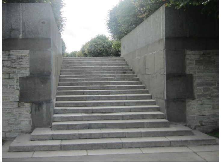
Художественно-обособленный участок «Вечный огонь». Боковые лестницы подпорной стенки террасы. Съёмка 20.08.2012, К.С. Евтеев.
