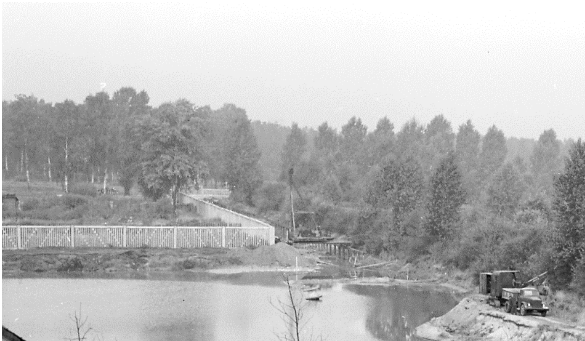
11. Ограждение западной стороны территории мемориального кладбища. 1960 // ЦГА КФФД СПб. Шифр: Бр 67271
