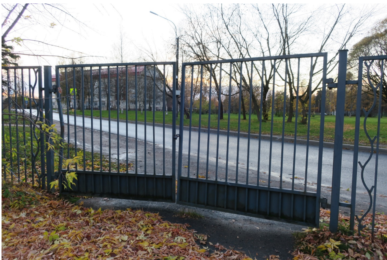
13. Южная часть ограды объекта культурного наследия федерального значения «Кладбище Пискаревское», расположенного по адресу: г. Санкт-Петербург, пр. Непокоренных, д. 72 литера А. Ворота (въезд – вход №2). 15.10.2021
