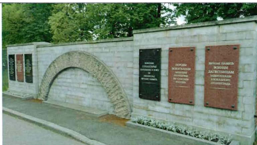
19. Фрагмент восточной стены.
