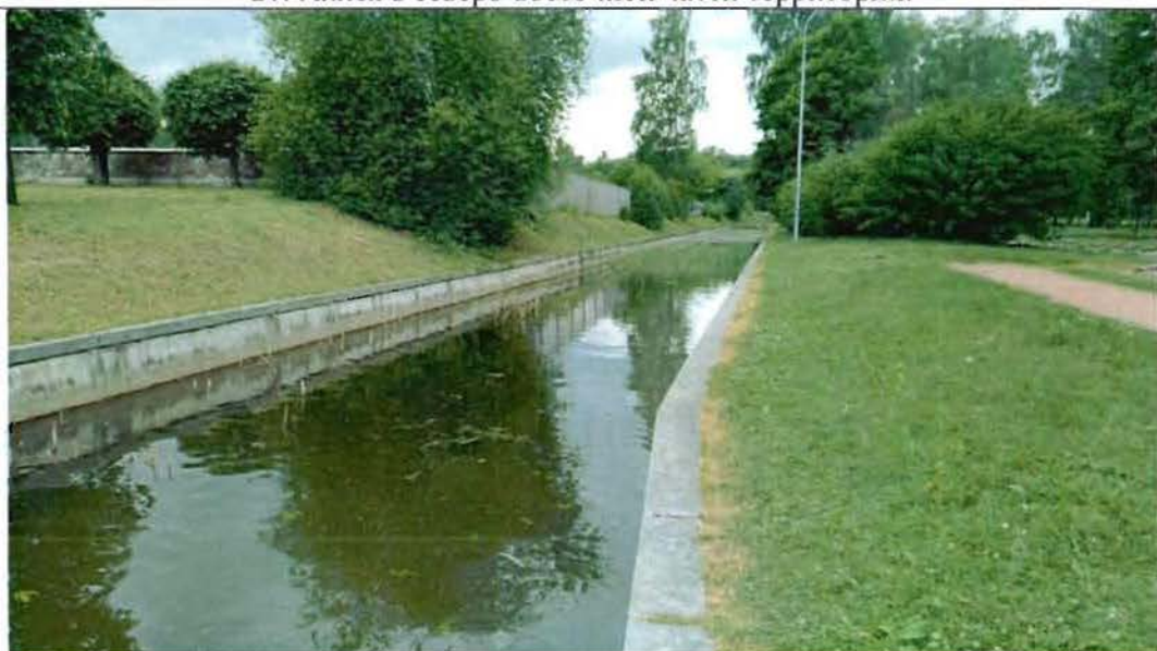
22. Водоотводной канал в юго-западной части территории.
