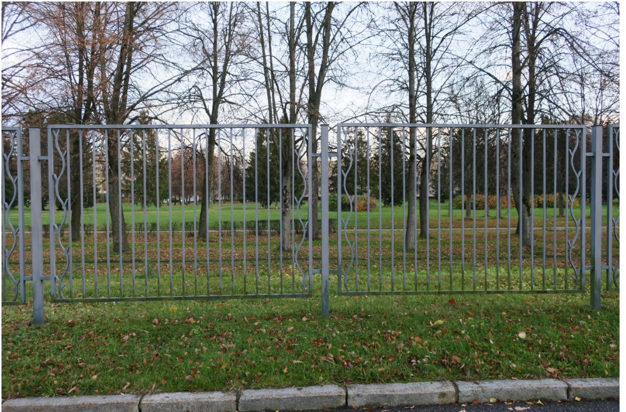
20. Восточная ограда вдоль аллеи Памяти объекта культурного наследия федерального значения «Кладбище Пискаревское», расположенного по адресу: г. Санкт-Петербург, пр. Непокоренных, д. 72 литера А. Фрагмент. 15.10.2021
