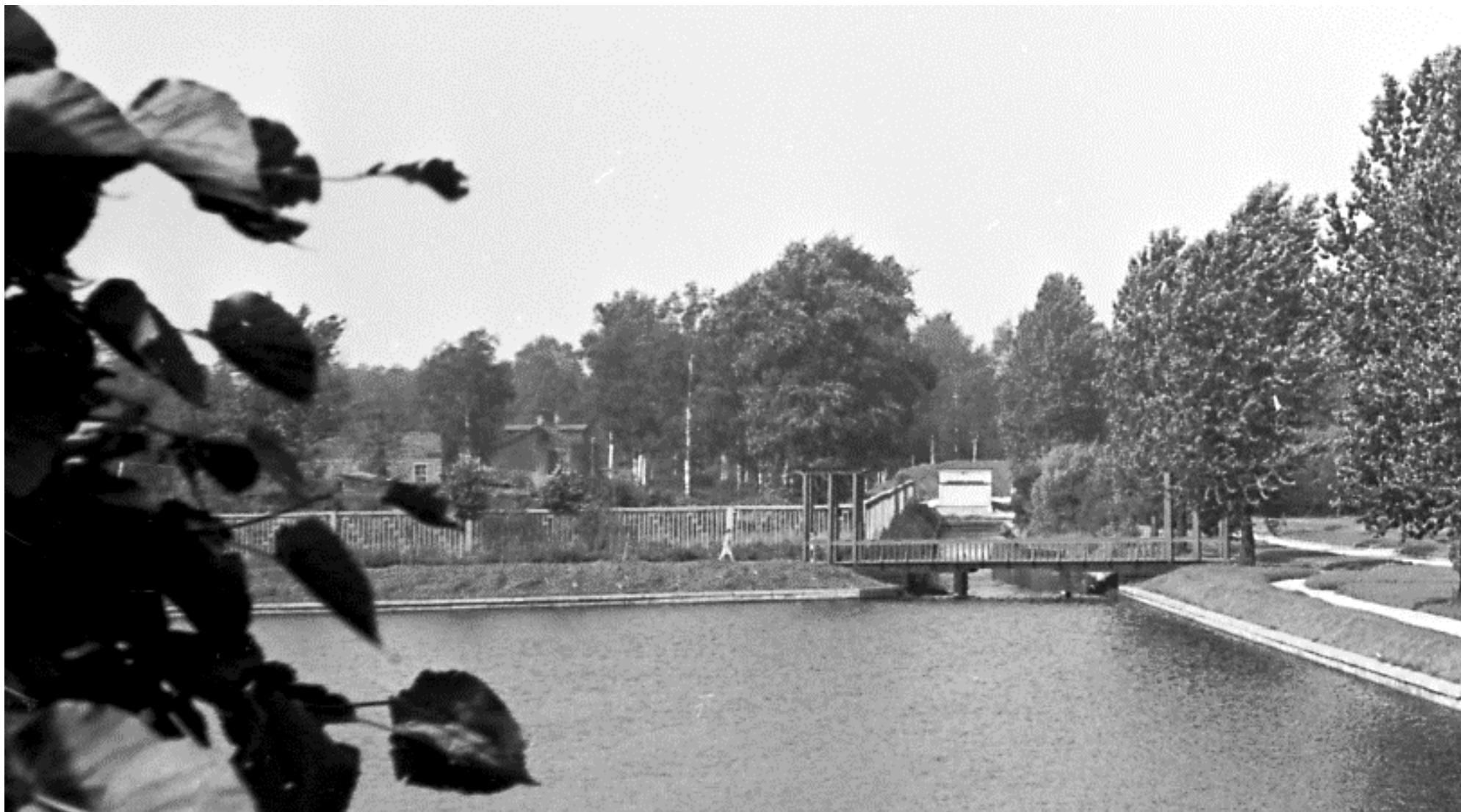
15. Ограждение западной стороны территории мемориального кладбища. 1967-1968 // ЦГА КФФД СПб. Шифр: Бр 67345
