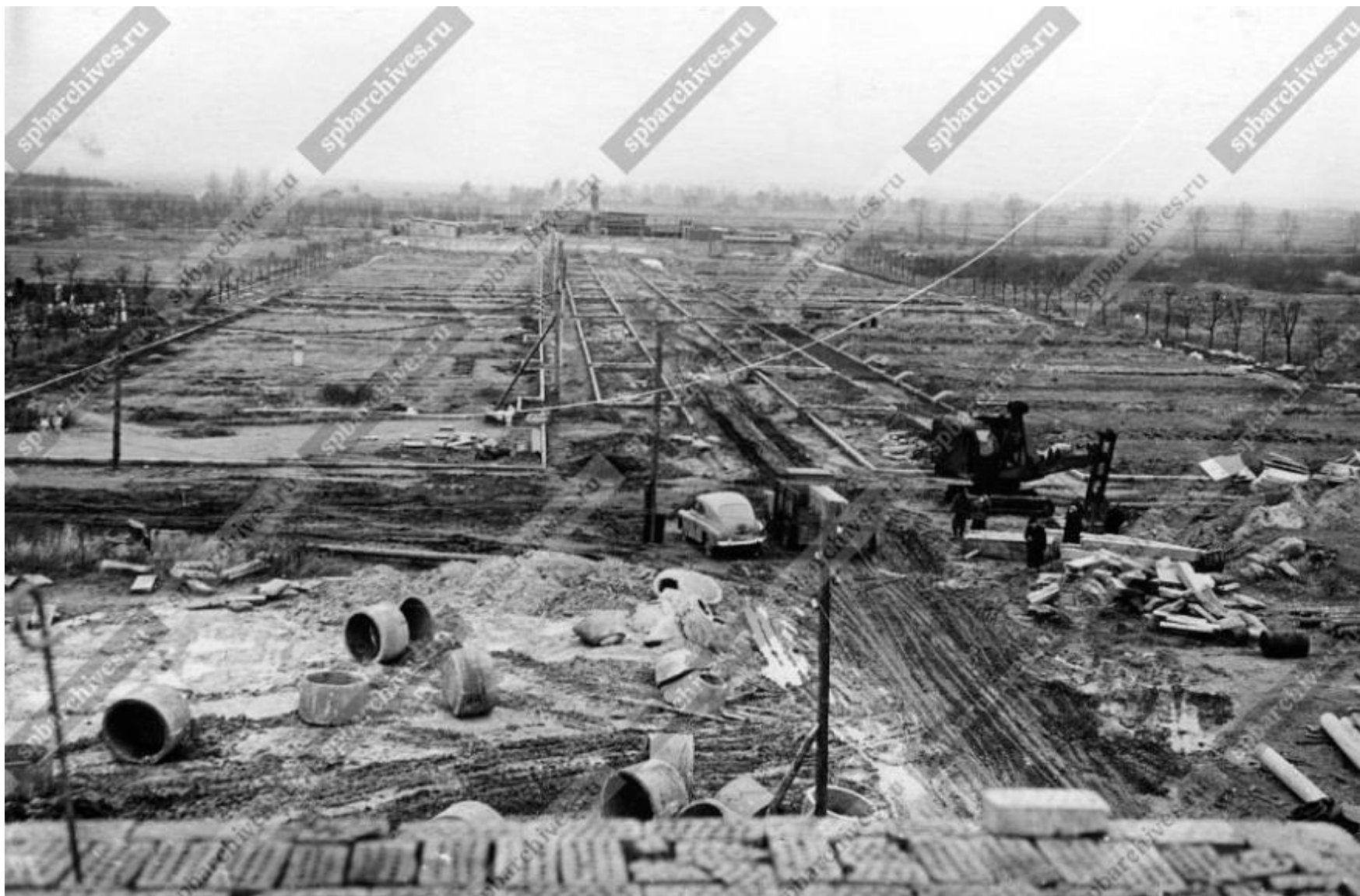
7. Строительство мемориального комплекса. Общий вид территории кладбища во время работ по формированию холмов братских могил. 1957 // ЦГА КФД СПб. Шифр: Бр 67239
