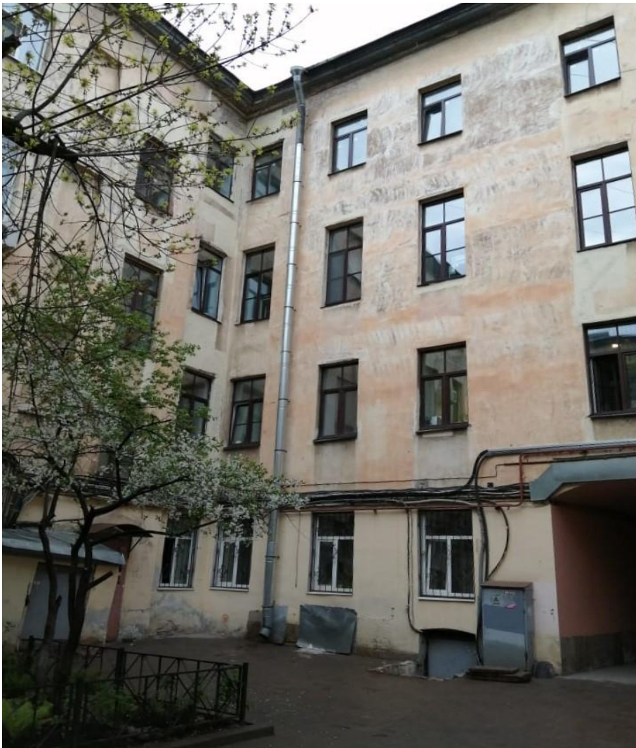
Фото 5. Объект культурного наследия федерального значения «Дом, где жили: в 1877-1916 гг. - композитор Направник Э.Ф., в 1882-1908 гг. - композитор Стравинский И.Ф., в 1946-1982 гг. - геолог Наливкин Д.В.», расположенного по адресу: Санкт-Петербург, улица Глинки, дом 3-5-7, литера А. Восточный дворовый фасад. Фрагмент.
