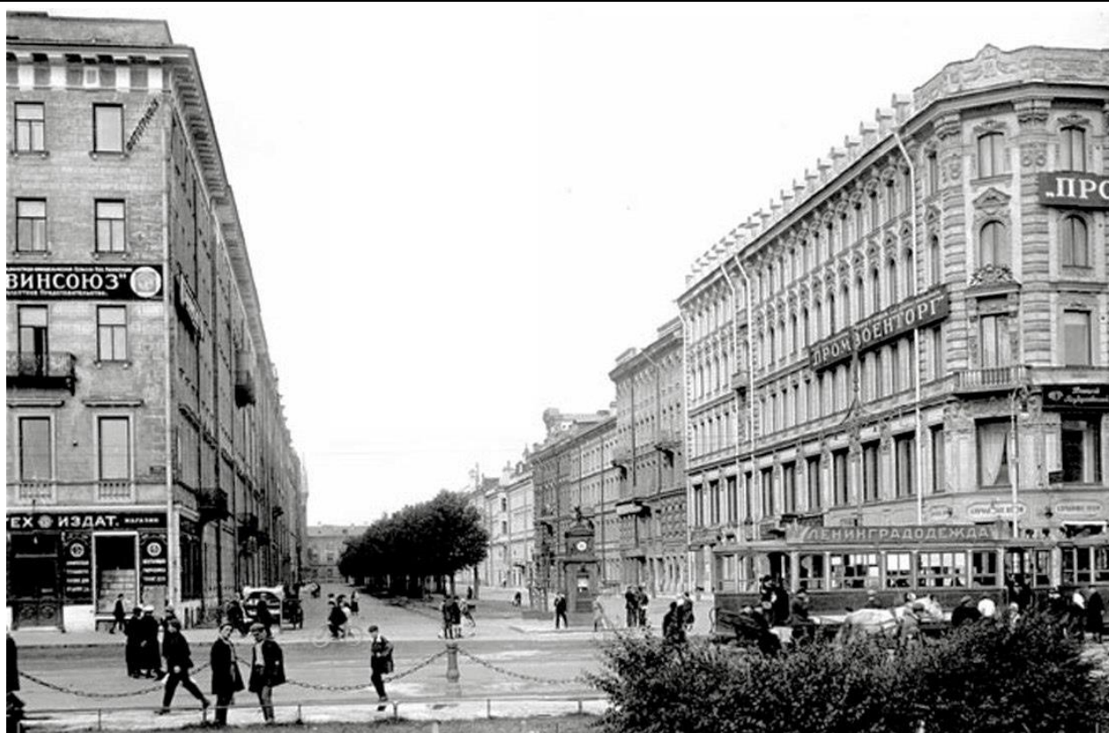
11. 1926 г. Перспектива улицы Софьи Перовской от Невского Проспекта в сторону Конюшенной площади (ЦГАКФД, Гр 65266).
