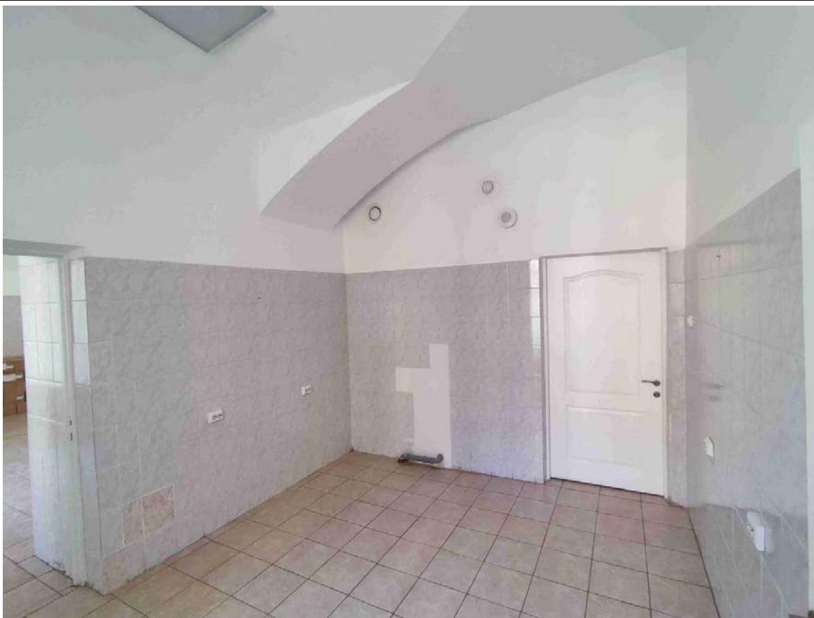
17. Общий вид пом. 6-Н (42) в уровне 1-го этажа.
