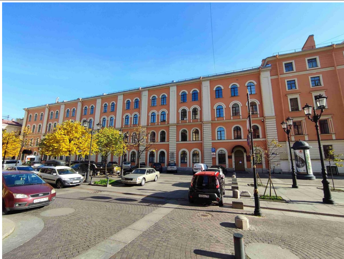
2. Общий вид западного лицевого фасада выявленного объекта культурного наследия «Здание госпиталя».
