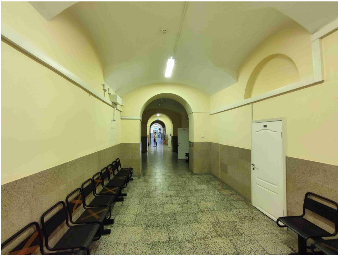
20. Общий вид пом. 6-Н (8) в уровне 1-го этажа.
