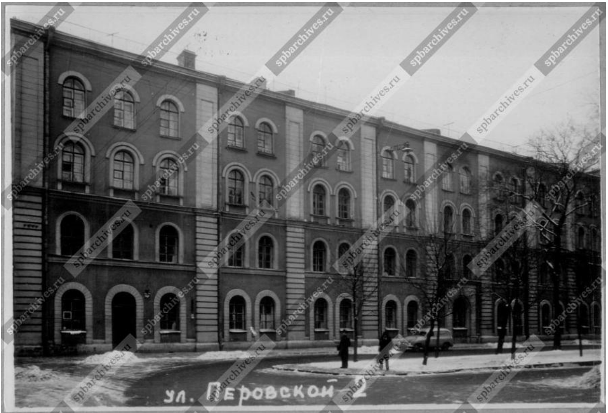
13. 1960 г. Вид фасада дома № 2 по улице Софьи Перовской (ЦГАКФФД Гр 75600).
