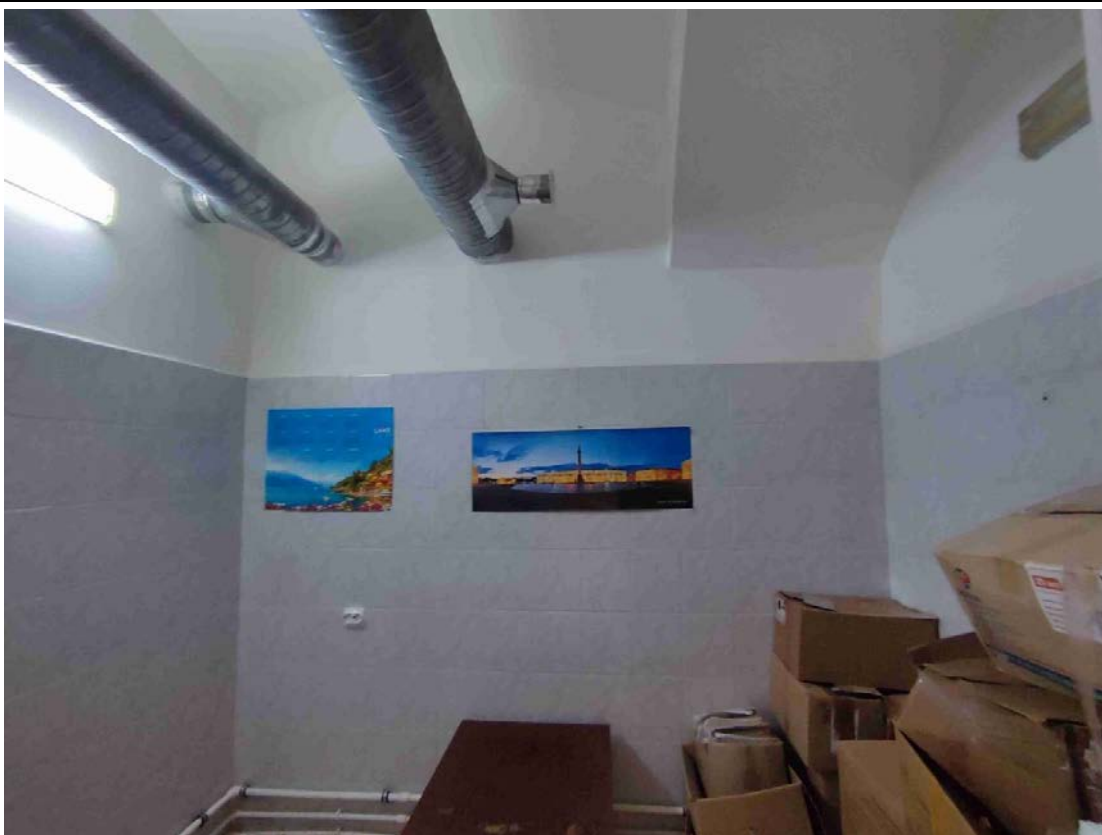
12. Общий вид пом. 6-Н (41) в уровне 1-го этажа. Проектными решениями предполагается объединение данного помещения с пом. 6-Н (40) для размещения регистратуры кабинета компьютерной томографии.
