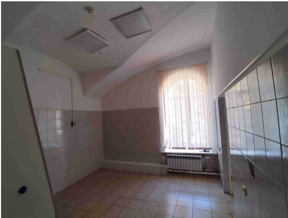
14. Общий вид пом. 6-Н (43) в уровне 1-го этажа. В данном помещении проектными решениями предполагается размещение комнаты управления кабинета компьютерной томографии.
