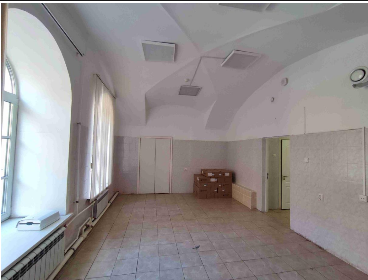
18. Общий вид пом. 6-Н (38) в уровне 1-го этажа.
