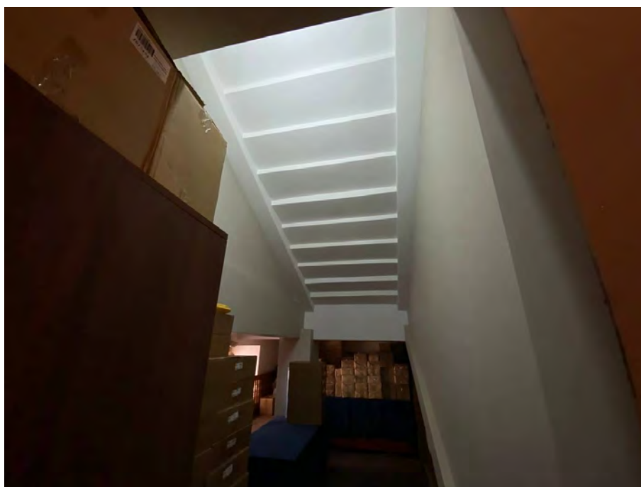
Фото №28. 1 этаж, помещение 110.
