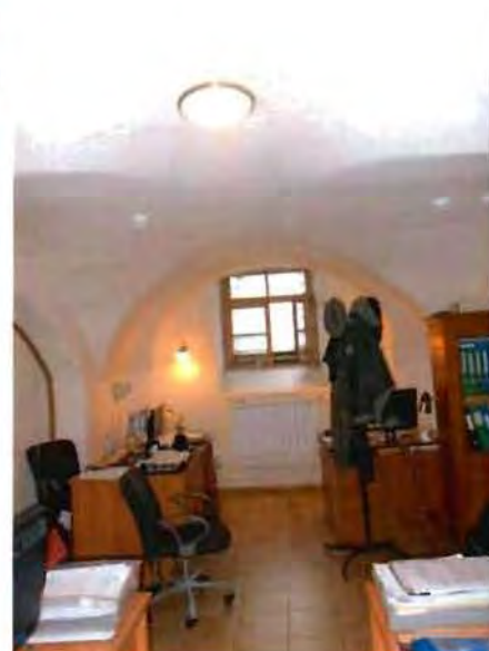
4. Свод цокольного этажа.
