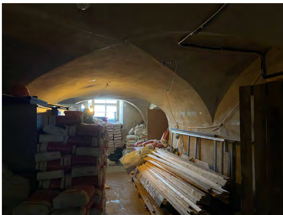
Фото №6. Подвал, помещение 0.5.
