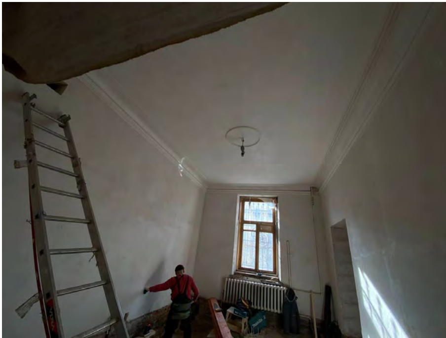
Фото №29. 1 этаж, помещение 103.
