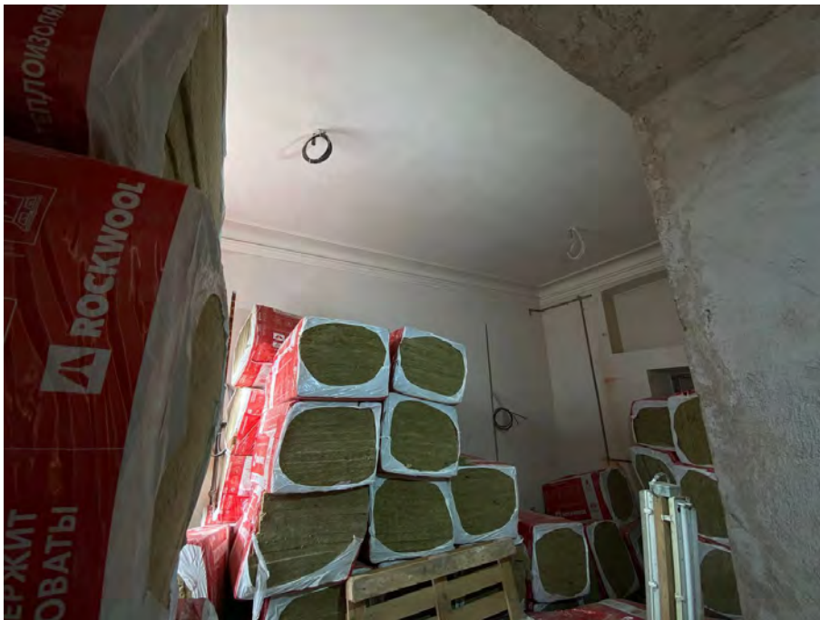
Фото №30. 1 этаж, помещение 102.
