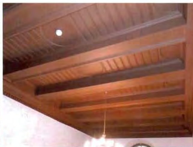
8. Оформление потолка над лестничной клеткой.
