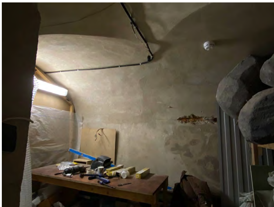
Фото №7. Подвал, помещение 0.18.
