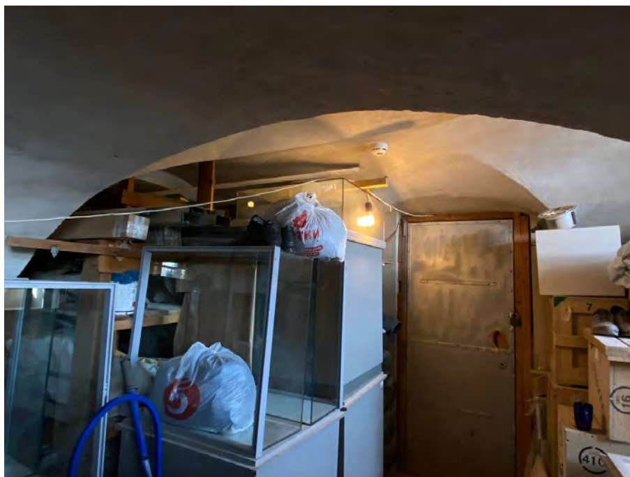
Фото №9. Подвал, помещение 0.5, дверь в помещение 0.1.
