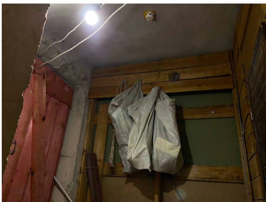
Фото №10. Подвал, помещение 0.19.
