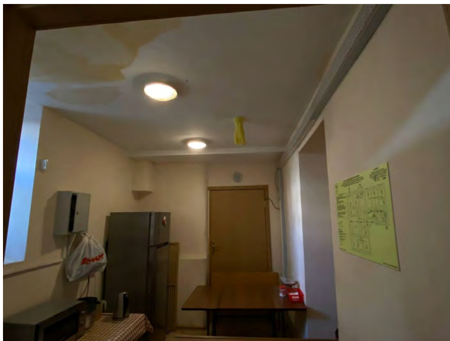
Фото №15. Подвал, помещение 0.14, дверь в помещение 0.16.
