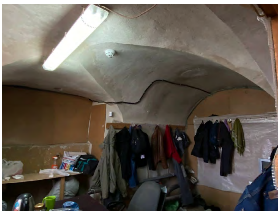
Фото №8. Подвал, помещение 0.6.
