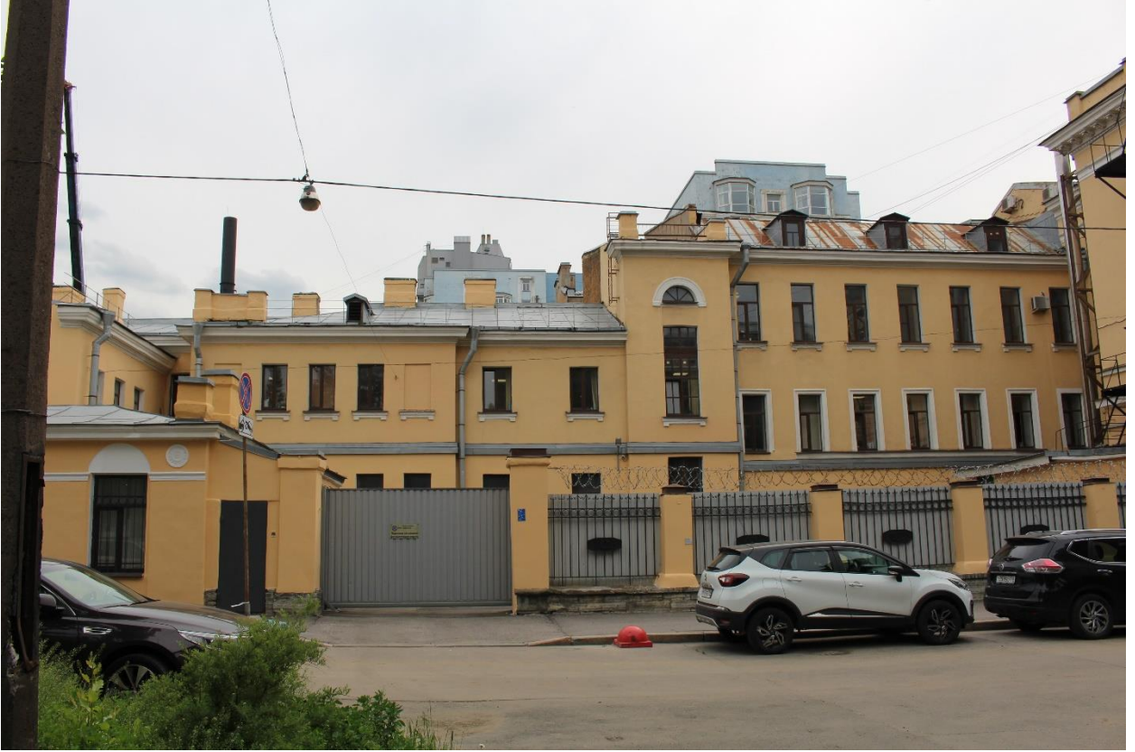
Фото 5. Вид на северный фасад дворовых корпусов.
