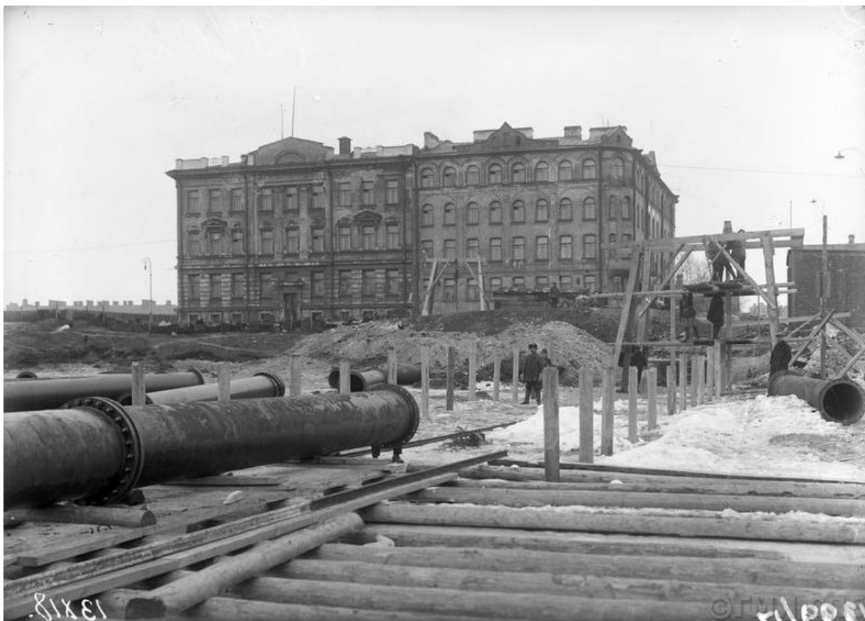
Илл. 11. Водопроводные работы. Переход через Неву. Вид на береговую часть работ. 1928 г. (источник: Государственный музей истории Санкт-Петербурга. ГМИ СПб 221781).
