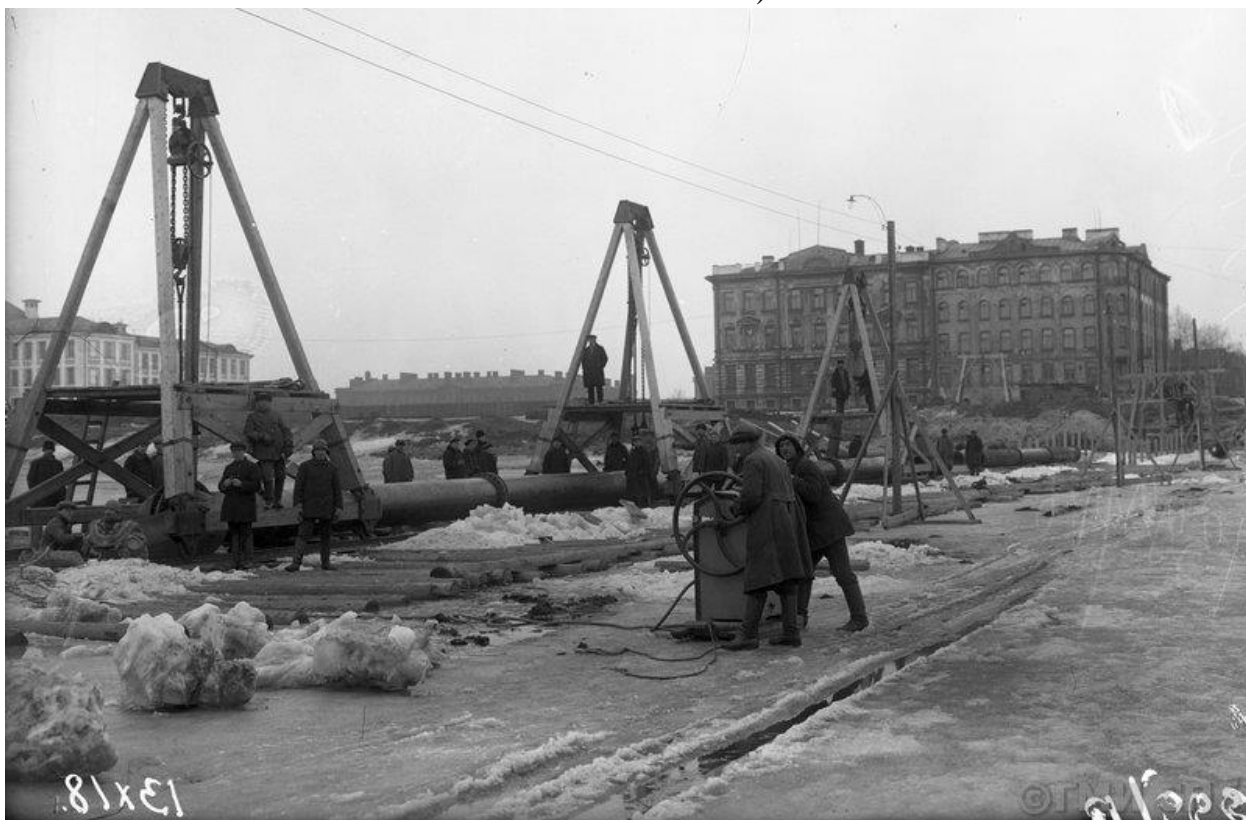
Илл. 12. Водопроводные работы. Переход через Неву. Подготовка водолаза к спуску в воду. 1928 г. (источник: Государственный музей истории Санкт-Петербурга. ГМИ СПб 221780).
