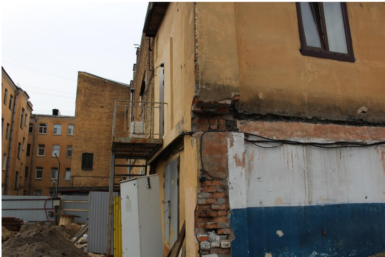
Фото 11. Вид на юго-восточный угол пристройки (литера А1).
