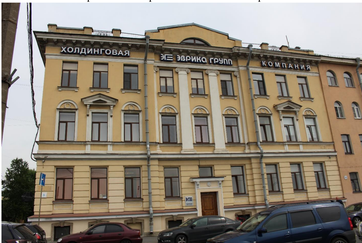
Фото 2. Вид на западный фасад лицевого корпуса.
