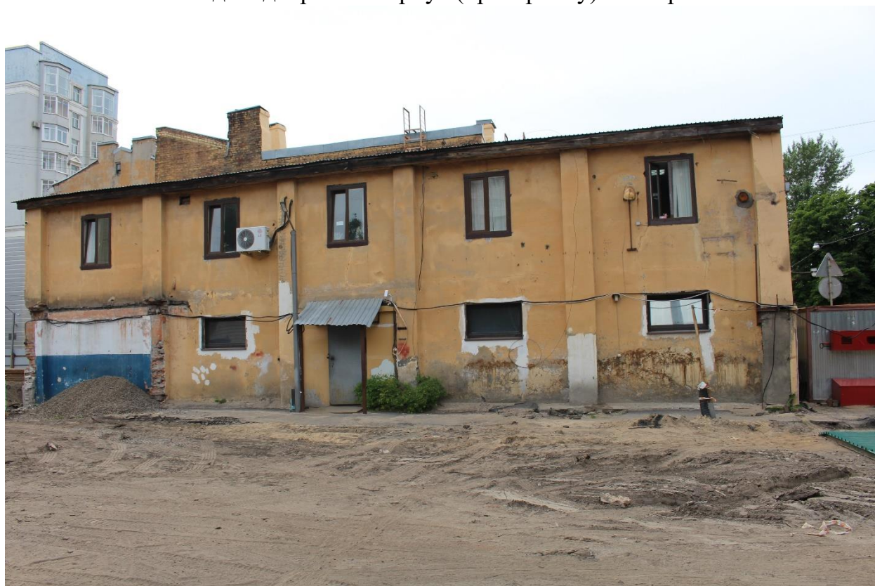
Фото 10. Вид на восточный фасад пристройки (литера А1).
