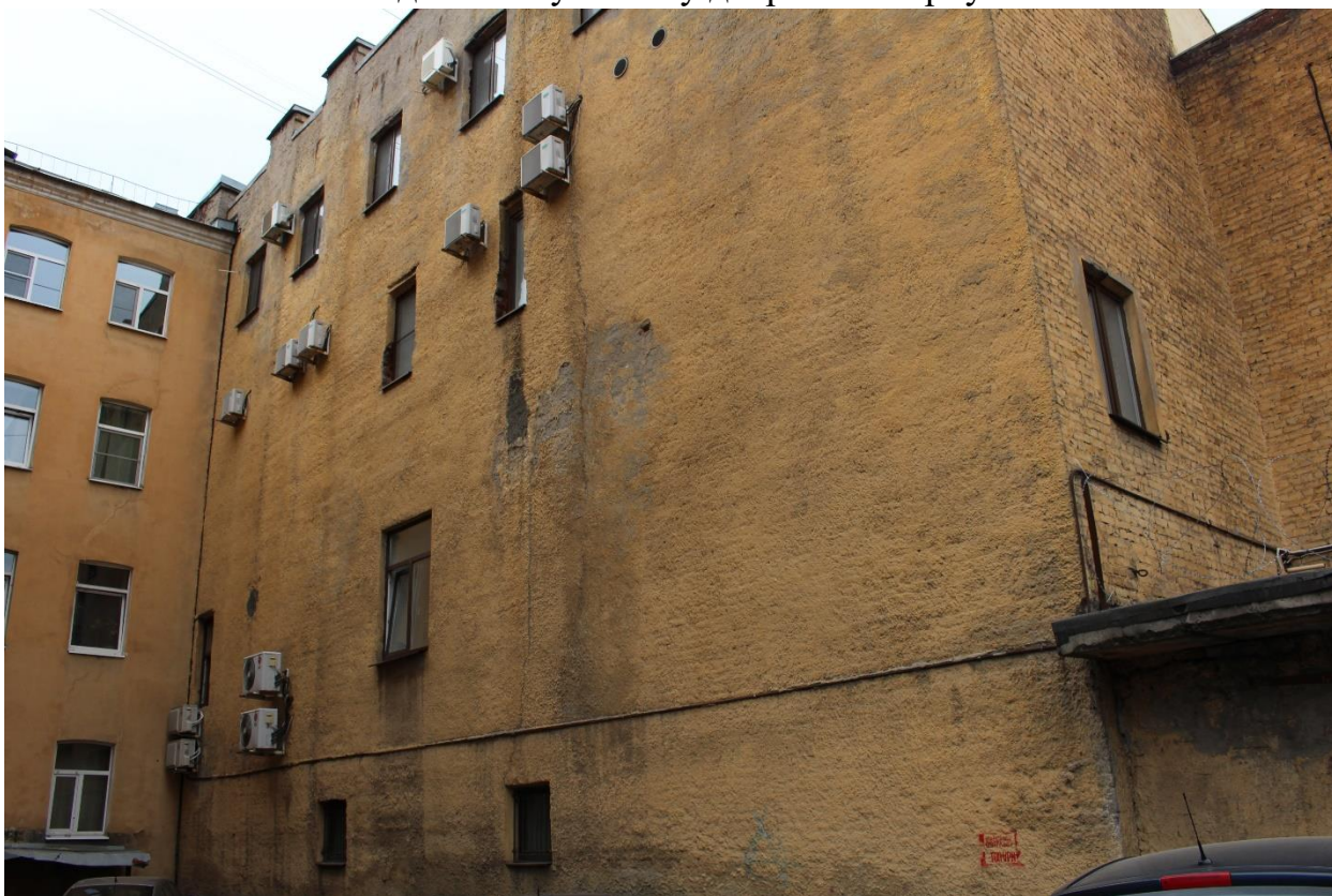
Фото 8. Вид на южную стену лицевого корпуса.
