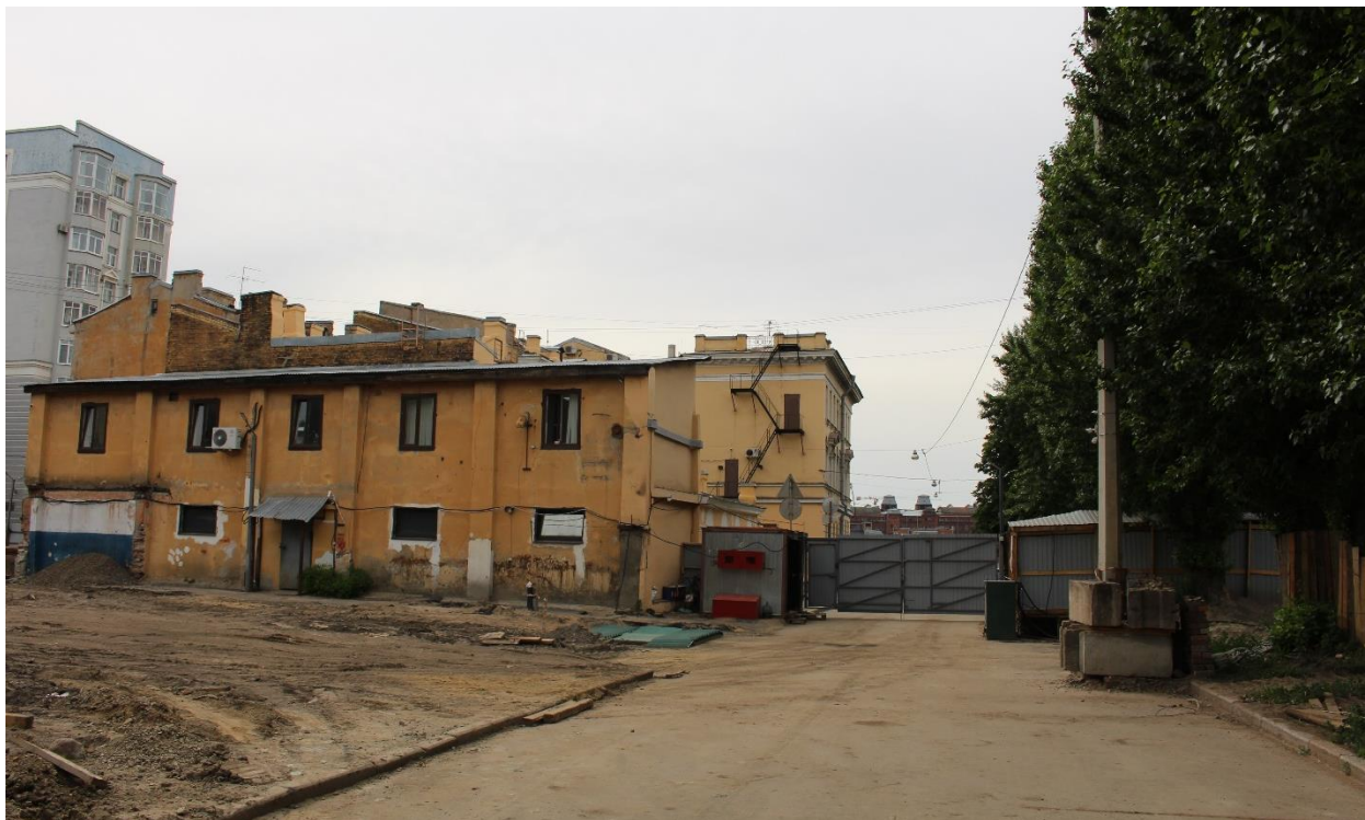
Фото 9. Вид на дворовый корпус (пристройку) с северо-востока.
