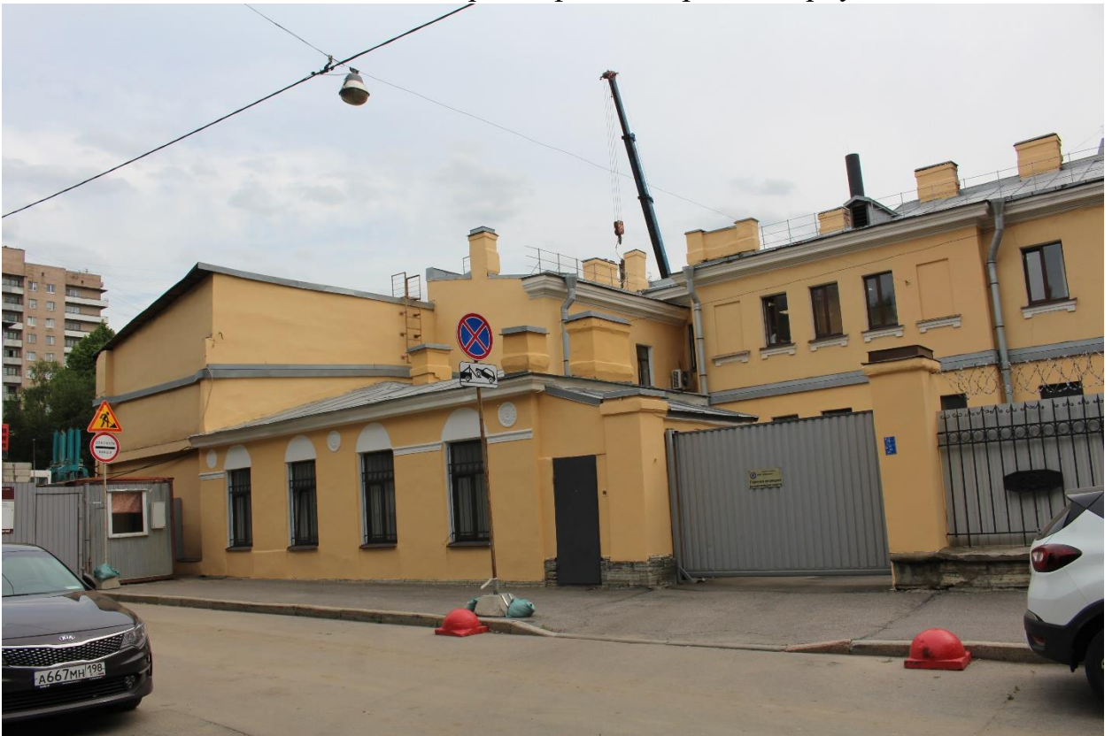
Фото 6. Вид на северный фасад дворовых корпусов.
