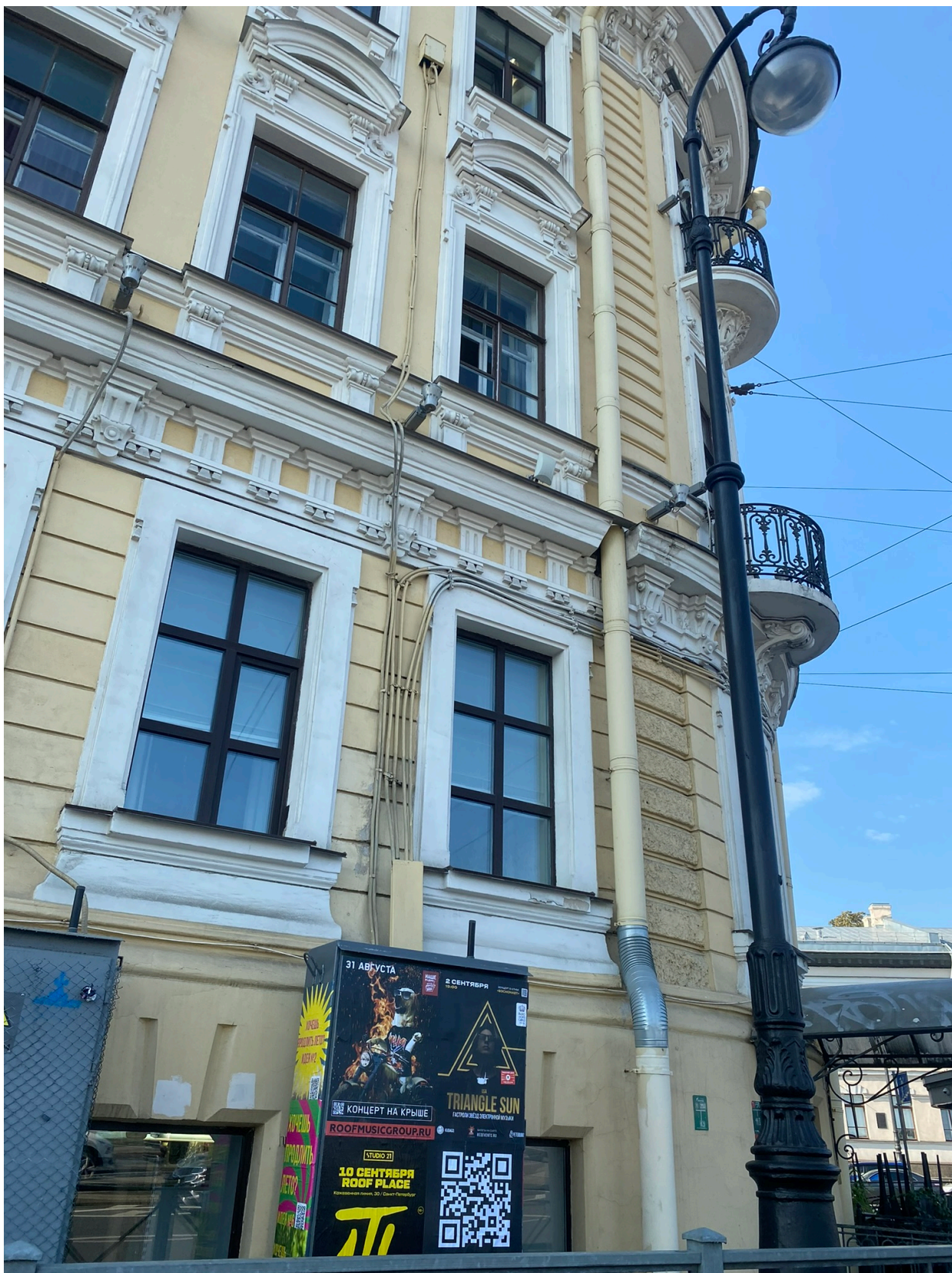
6. Вид на главный фасад здания с набережной Макарова; (Дата фотофиксации 16.06.2022 г.).
