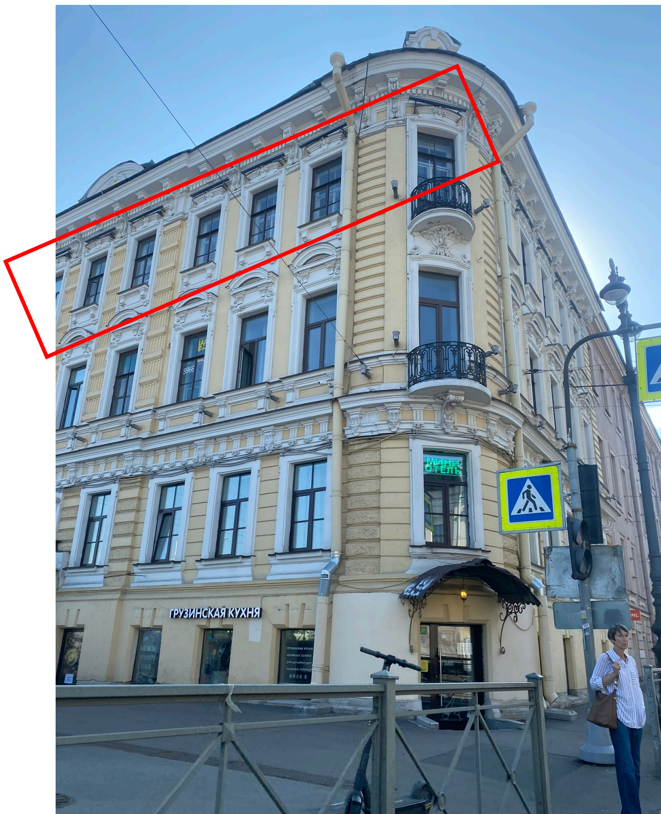
4. Вид на главный фасад здания с Кадетской линии; (Дата фотофиксации 16.06.2022 г.).
