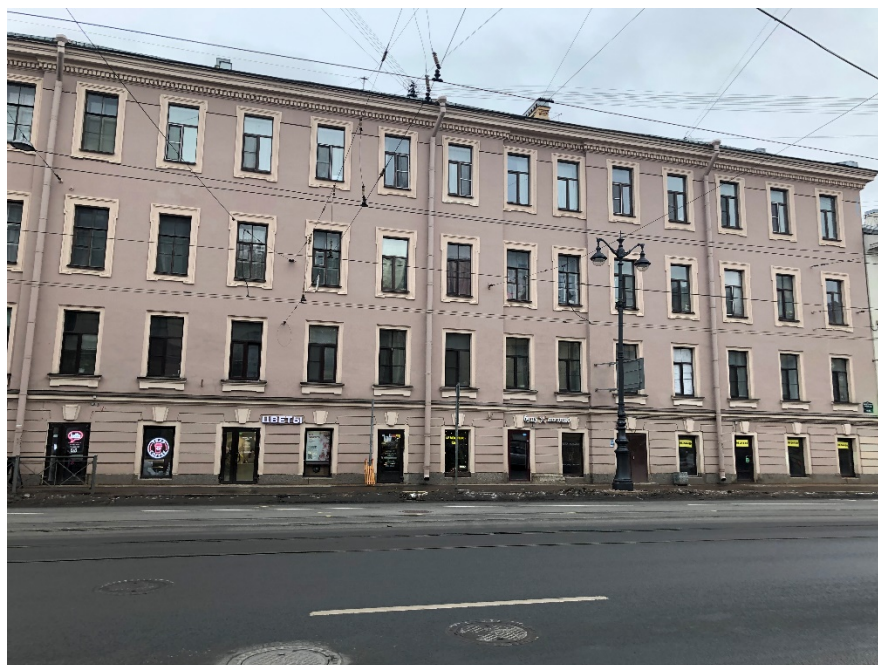
1. Вид на главный фасад здания с Кадетской линии;
