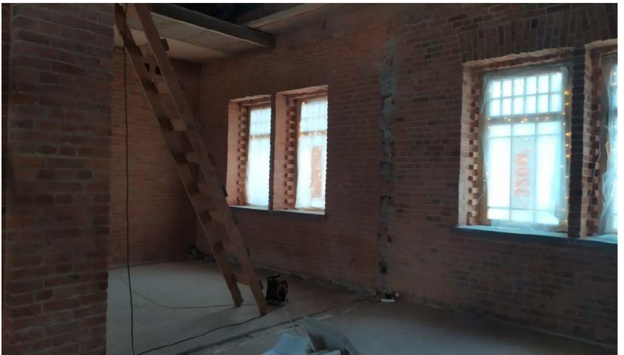
10. Помещение №1 (2-Н и 3-Н) в уровне 1-го этажа объекта культурного наследия регионального значения «Службы при дворце О.В. Гогенфельзен (Палей)», расположенного по адресу: Санкт-Петербург, г. Пушкин, Московский пер. д. 7/20, литера А. 04.11.2022.
