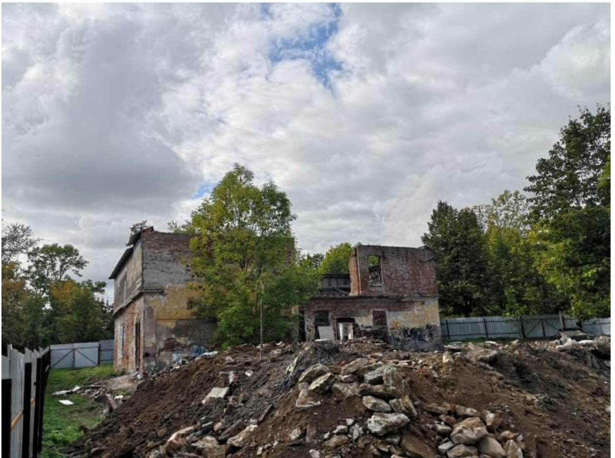
Фото 9. Территория проектирования. Участок №7 по адресу: Санкт-Петербург, Павловское шоссе, д.40 литера А. Вид с северо-востока.
