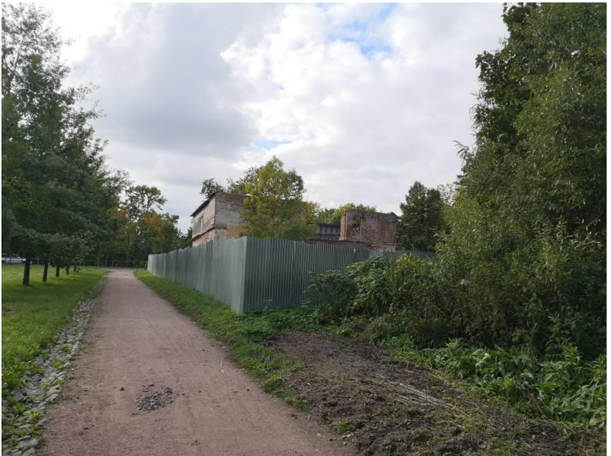
Фото 5. Вид на участок №7 по адресу: Санкт-Петербург, Павловское шоссе, д.40 литера А с северо-востока.
