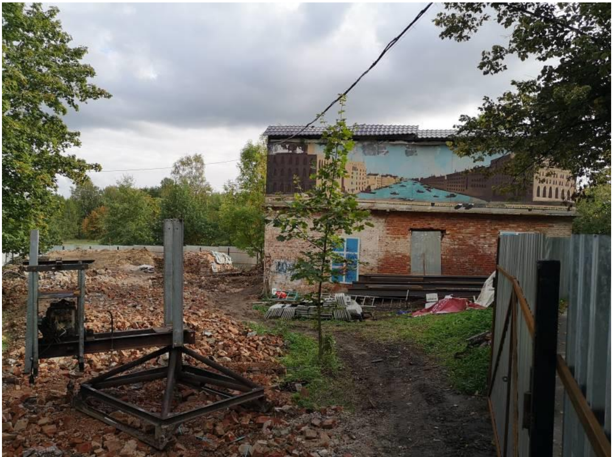
Фото 12. Территория проектирования. Участок №7 по адресу: Санкт-Петербург, Павловское шоссе, д.40 литер А. Вид с северо-запада.
