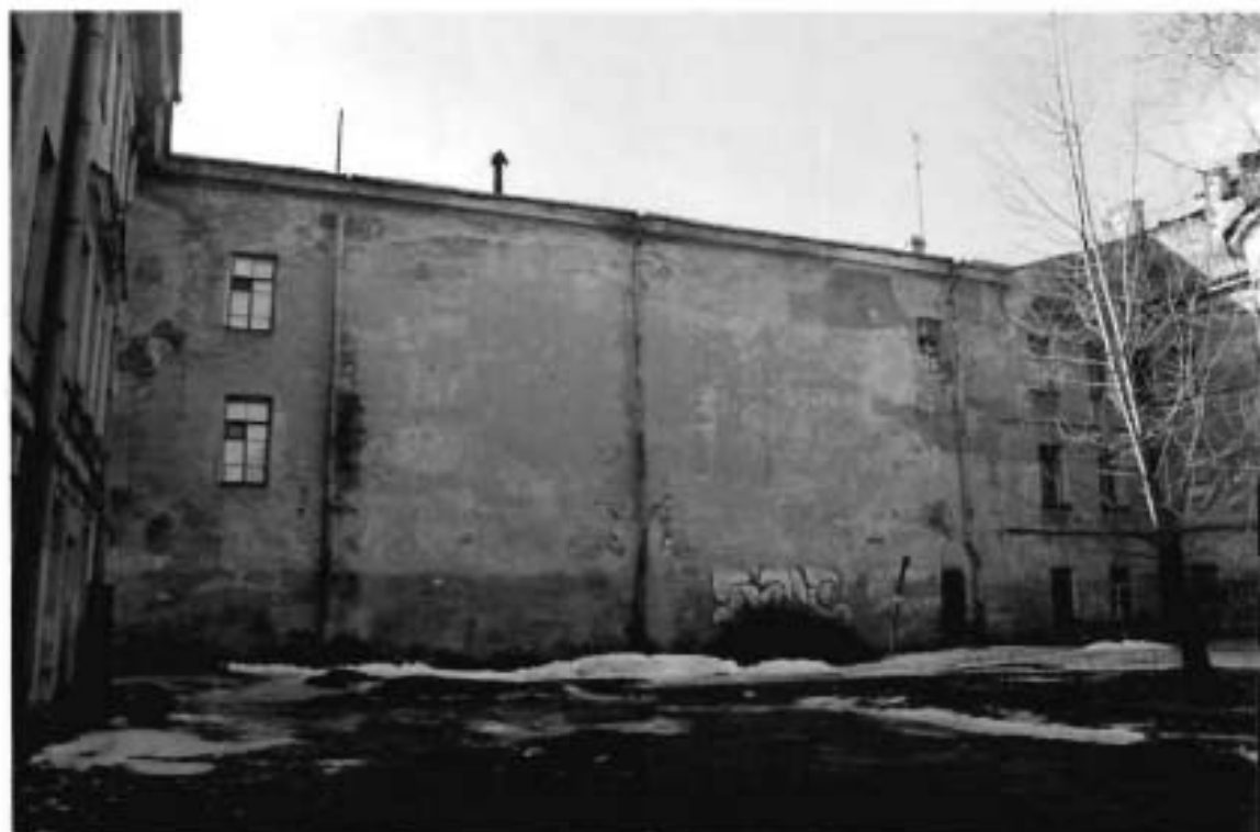
Фото №4. Вид на северный фасад со стороны сада.
