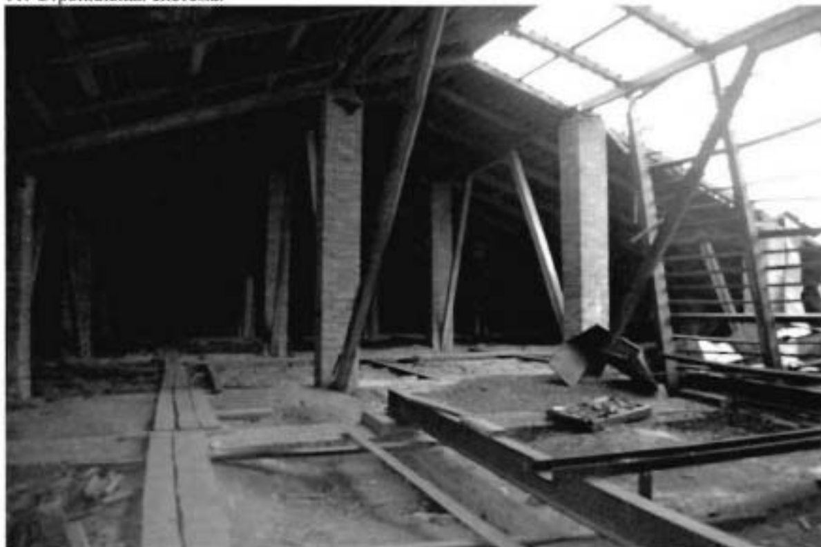
12. Стропильная система.
