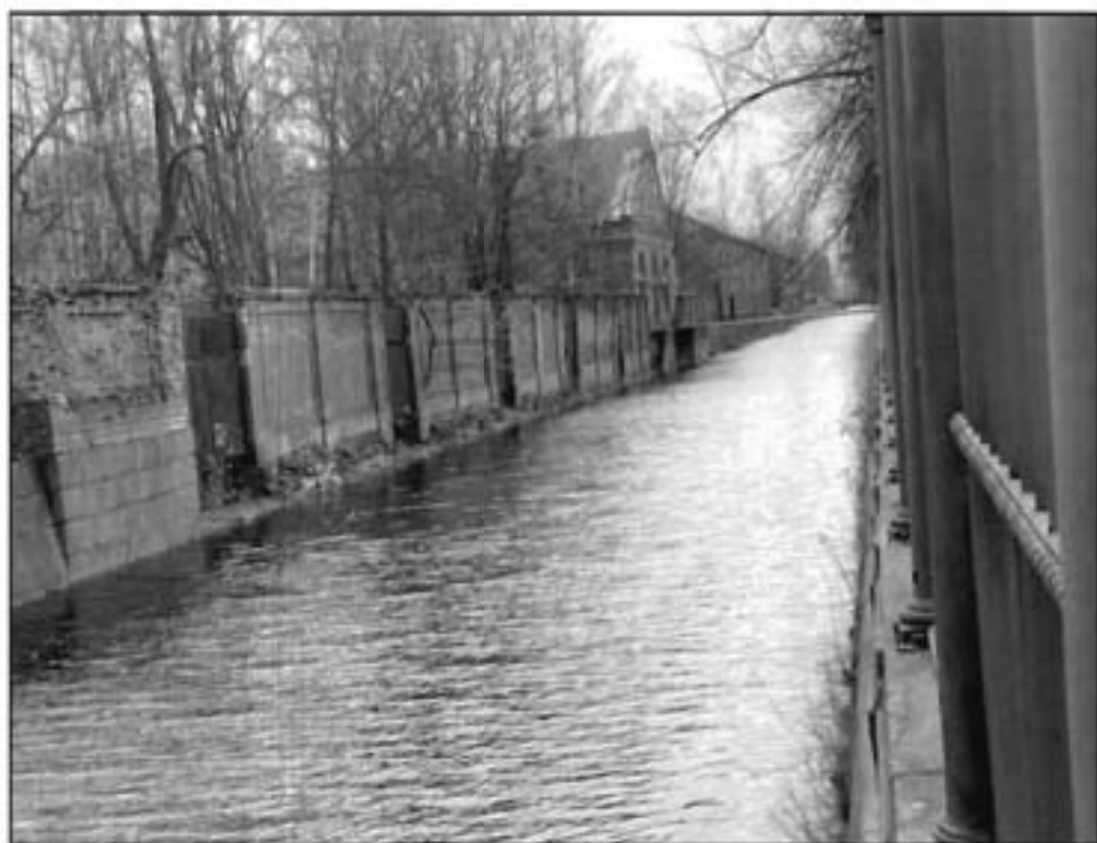
10. Северо-западная часть объекта культурного наследия по ул. Карла Маркса, общий вид.
