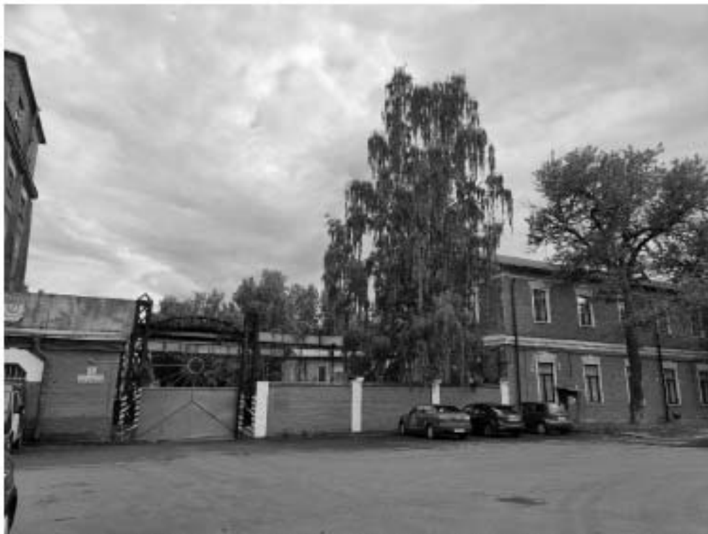
33. Вид на выявленный объект культурного наследия «Комплекс заводских построек по Макаровской улице». Направление съемки юг.
