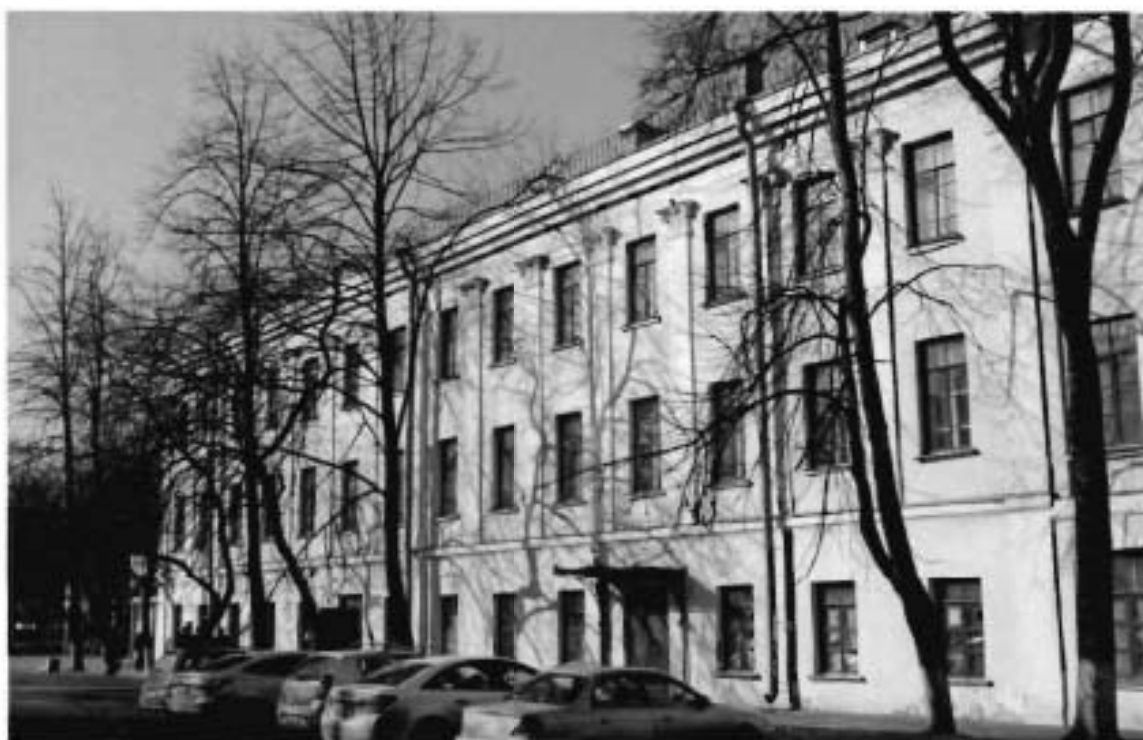
Фото №2. Вид на восточный фасад со стороны Коммунистической ул.
