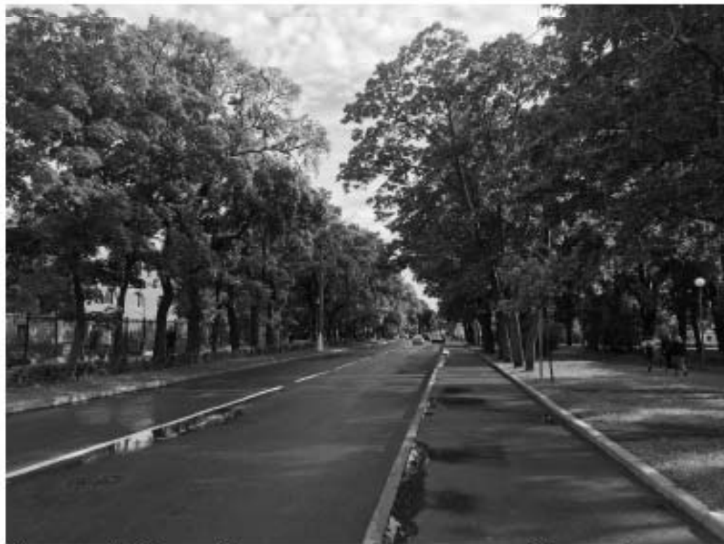
2. Общий вид ул. К. Маркса. Направление съемки юго-запад. Слева – объект культурного наследия федерального значения «Канал Обводной (проводной) с чугунной оградой»
