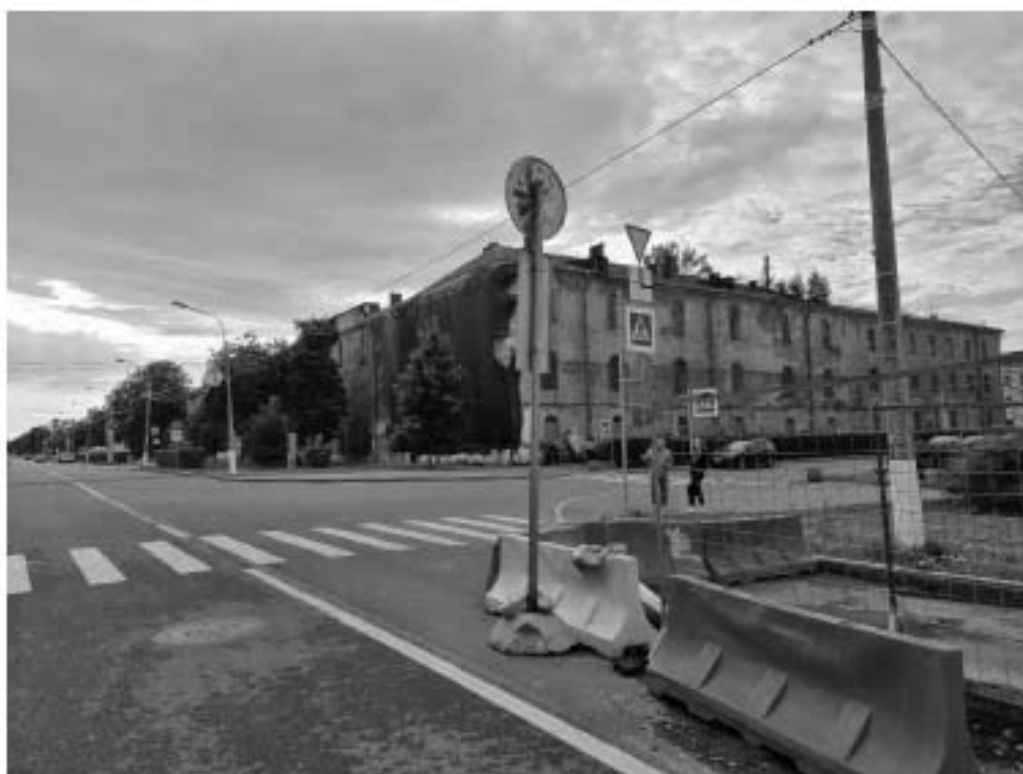
27. Вид на объект культурного наследия федерального значения «Образцовая казарма». Направление съемки северо-запад.
