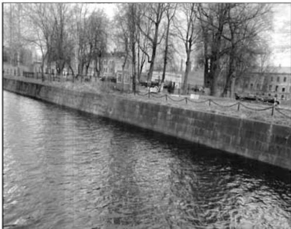
8. Общий вид на объект культурного наследия со стороны ул. Карла Маркса.
