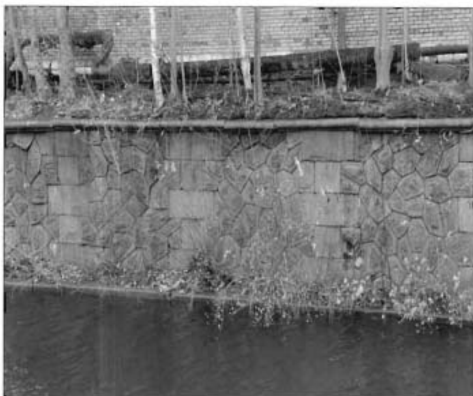
3. Фрагмент Объекта культурного наследия, подпорные стенки облицованы прямоугольными гранитными блоками, в восточной части канала локально облицовка выполнена из гладких и фактурных гранитных блоков в форме многогранника.
