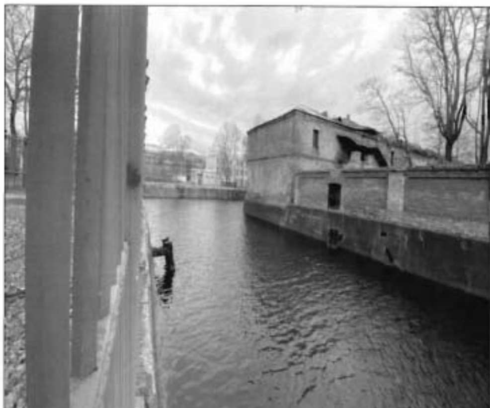
9. Северо-западная часть объекта культурного наследия по ул. Карла Маркса, общий вид.
