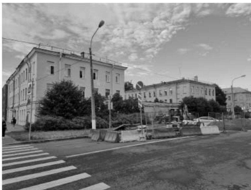
28. Вид на объекты культурного наследия федерального значения «Дом губернский 6-й», «Дом губернский 5-й», «Дом губернский 4-й». Направление съемки восток.
