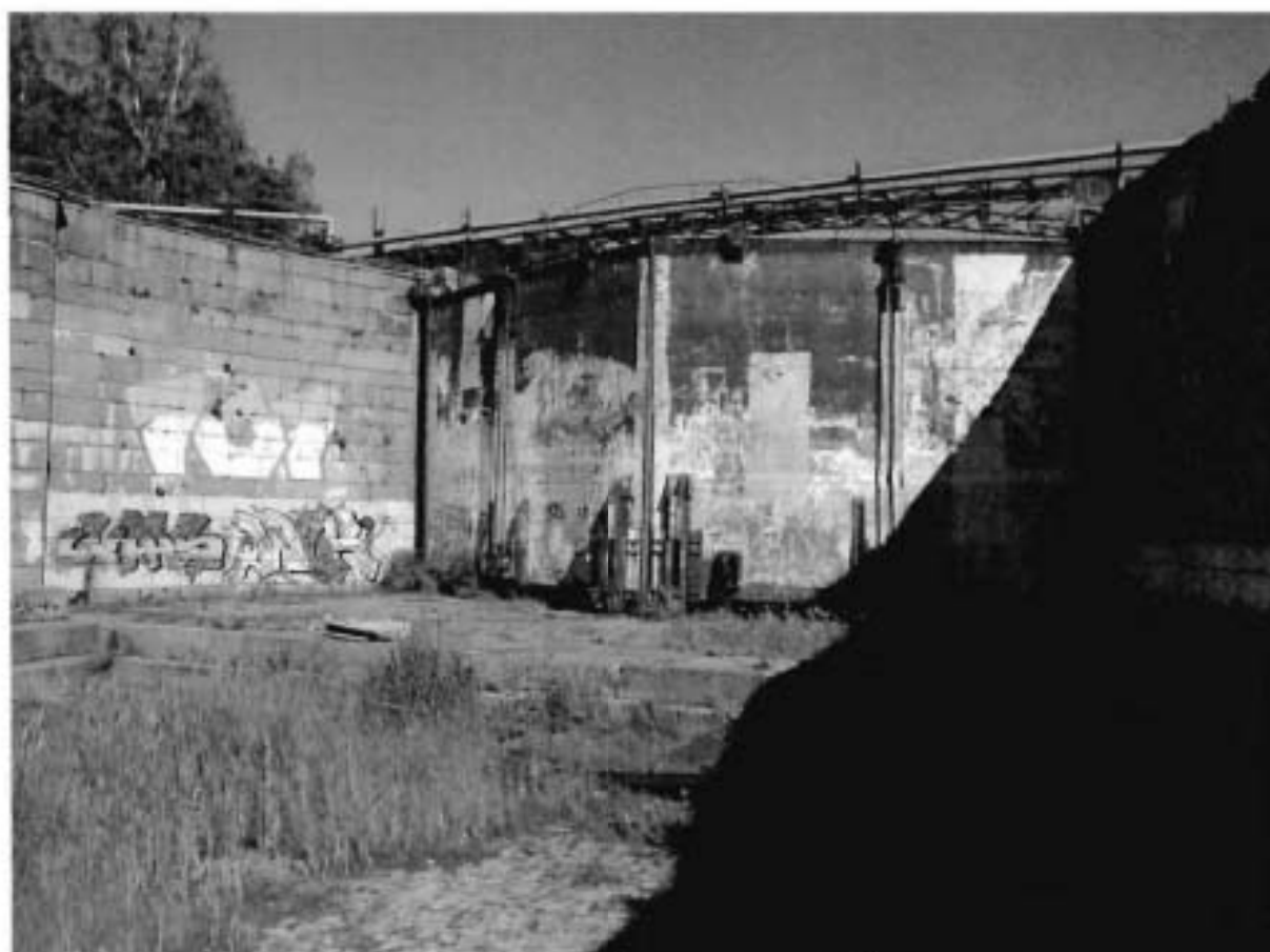
6. Вид на двустворчатые ворота и переходной мост в северной части дока со стороны камеры
