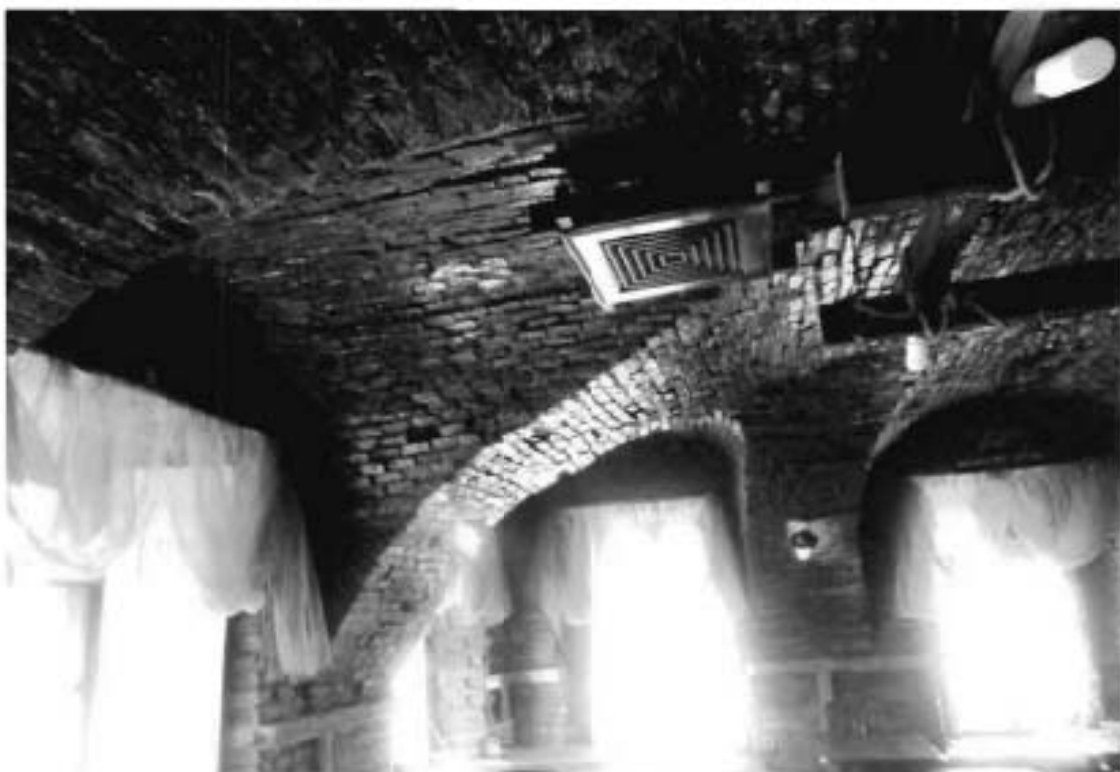
Фото №11. Помещение 1-Н 1-го этажа.
