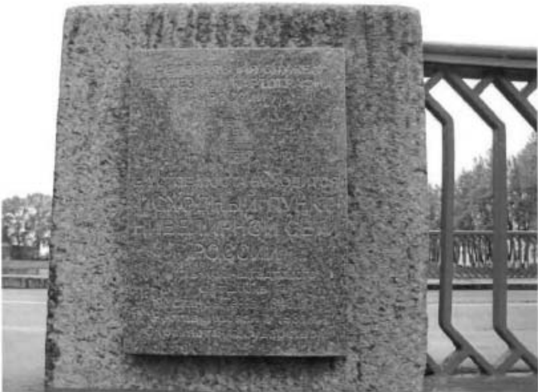
6. Доска с указанием местонахождения исходного пункта нивелирной сети России. Правобережная тумба перильного ограждения со стороны низового фасада
