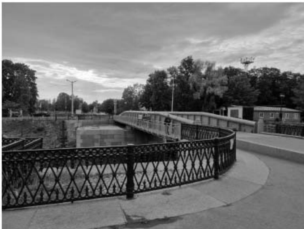
16. Вид на объект культурного наследия федерального значения «Доковый мост», входящий в состав объекта культурного наследия федерального значения «Канал им. Петра Великого с гидротехническими сооружениями». Направление съемки северо-запад.
