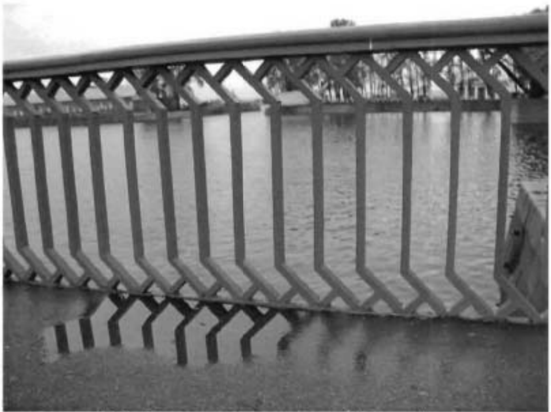
5. Решётка перильного ограждения (фрагмент)
