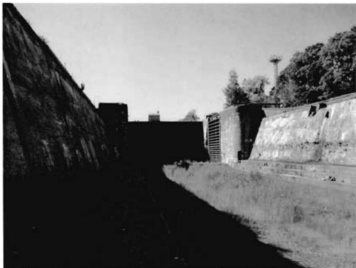
4. Вид на батопорт и двустворчатые ворота в южной части дока со стороны камеры
