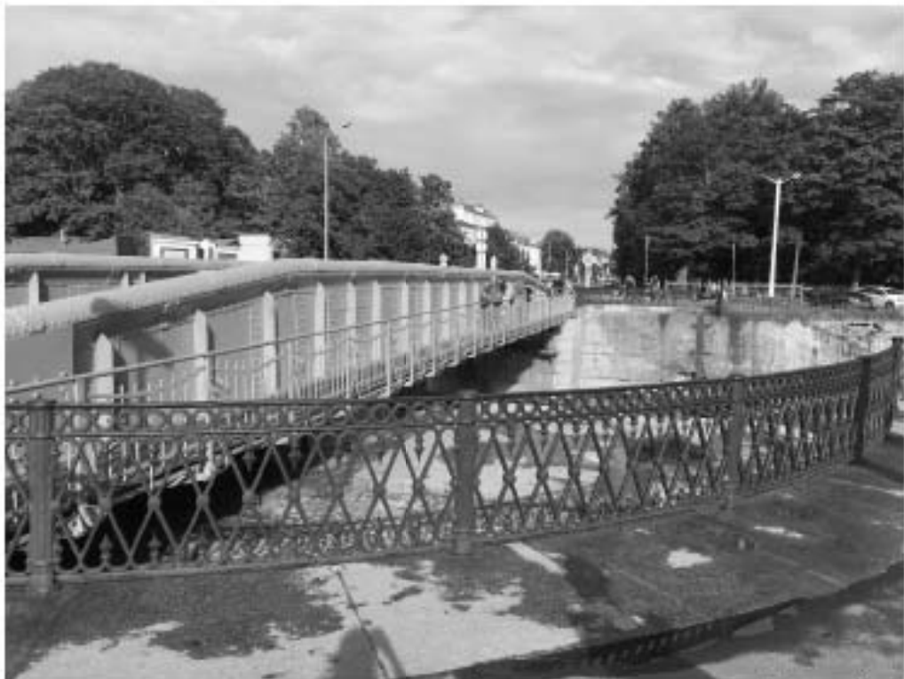
14. Вид на объект культурного наследия федерального значения «Доковый мост», входящий в состав объекта культурного наследия федерального значения «Канал им. Петра Великого с гидротехническими сооружениями». Направление съемки юго-восток.
