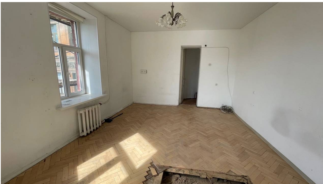
26. Фрагмент интерьера комнаты (помещение №5);
