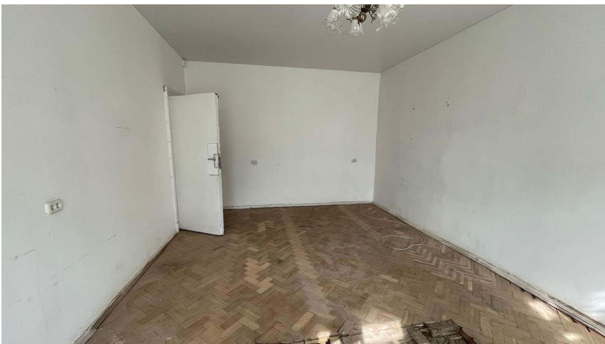
11. Фрагмент интерьера комнаты (помещение №2);
