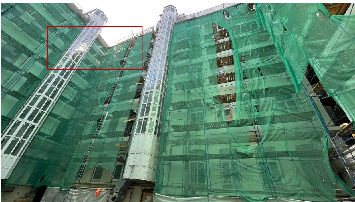
4. Вид на дворовой фасад и окна квартиры;
