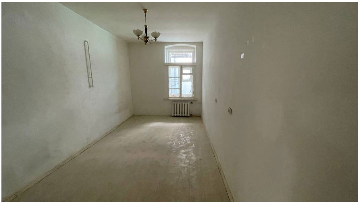
18. Фрагмент интерьера комнаты (помещение №7);
