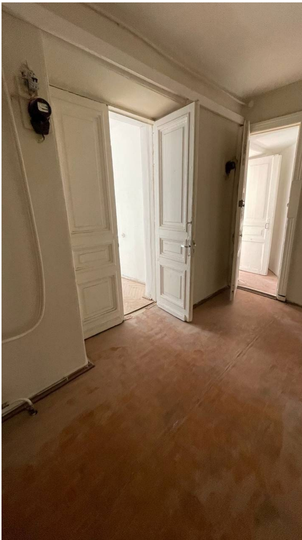
20. Фрагмент интерьера коридора, вход в помещение №4;
