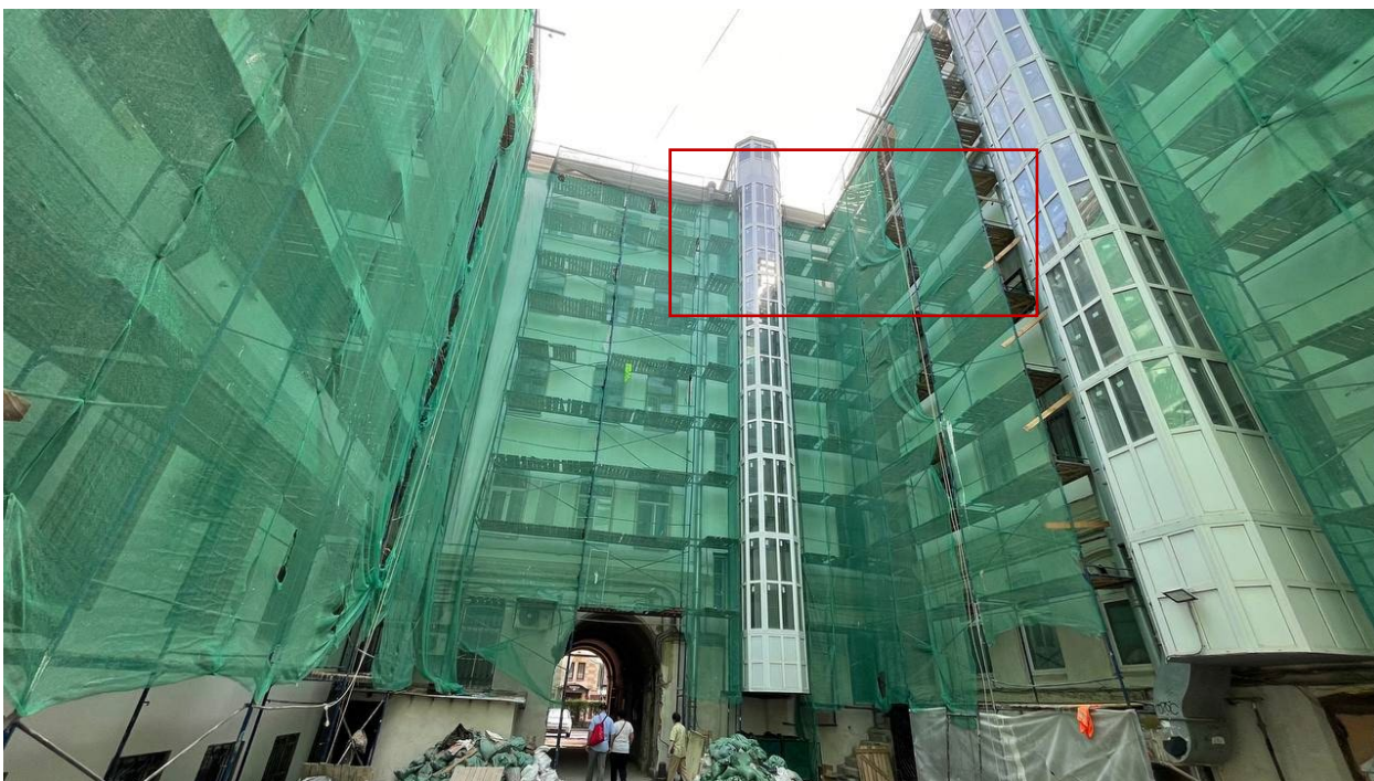
3. Вид на дворовой фасад и окна квартиры;
