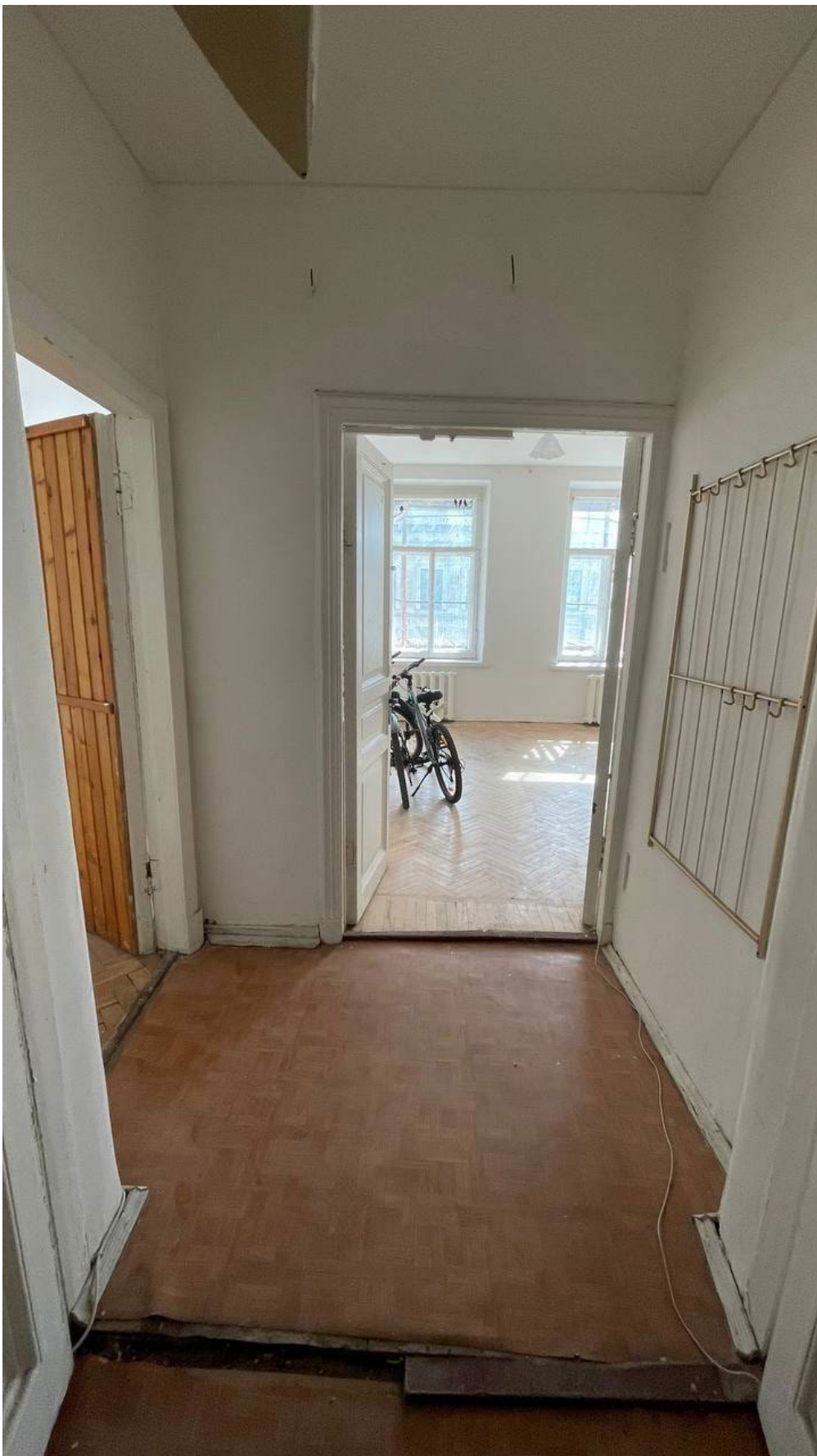
9. Вид на коридор (помещение №10);
