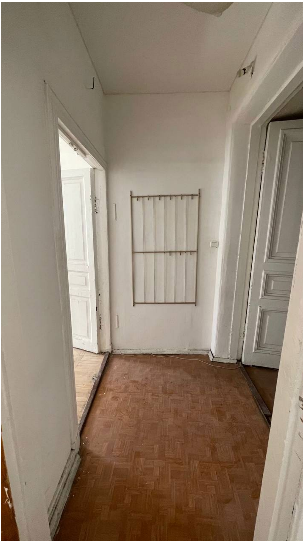
12. Вид на коридор (помещение №10);
