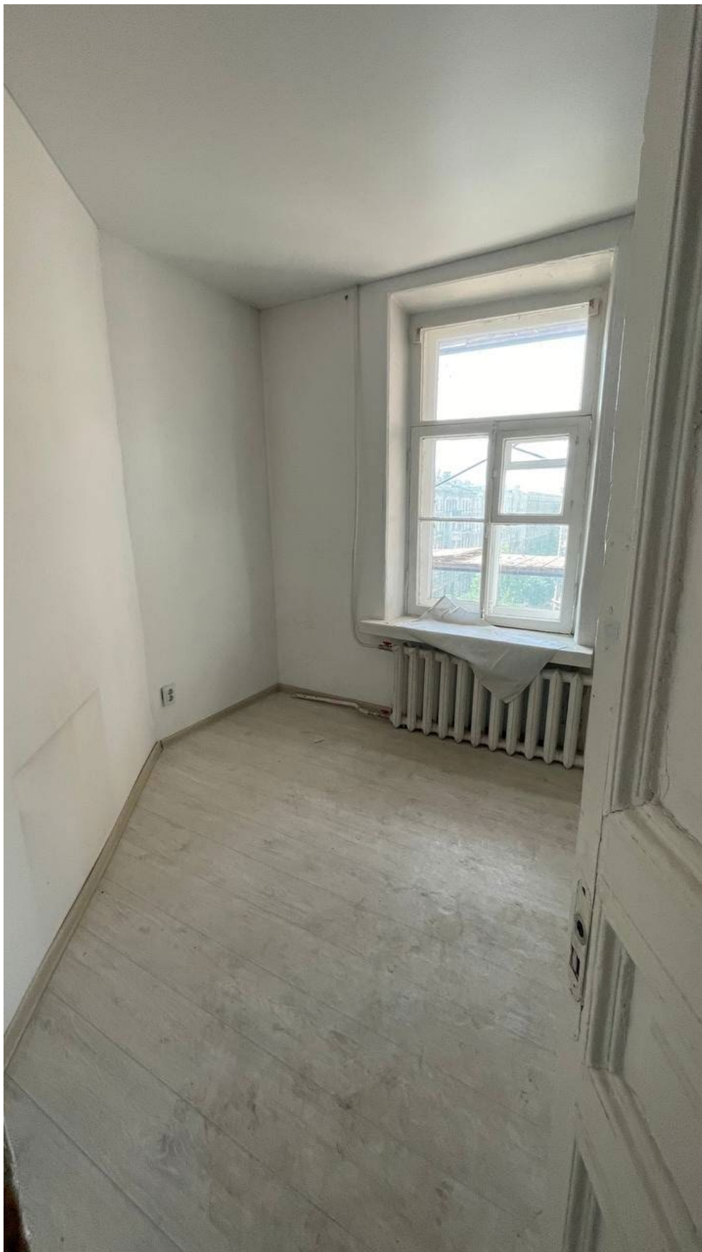
28. Фрагмент интерьера комнаты (помещение №6);
