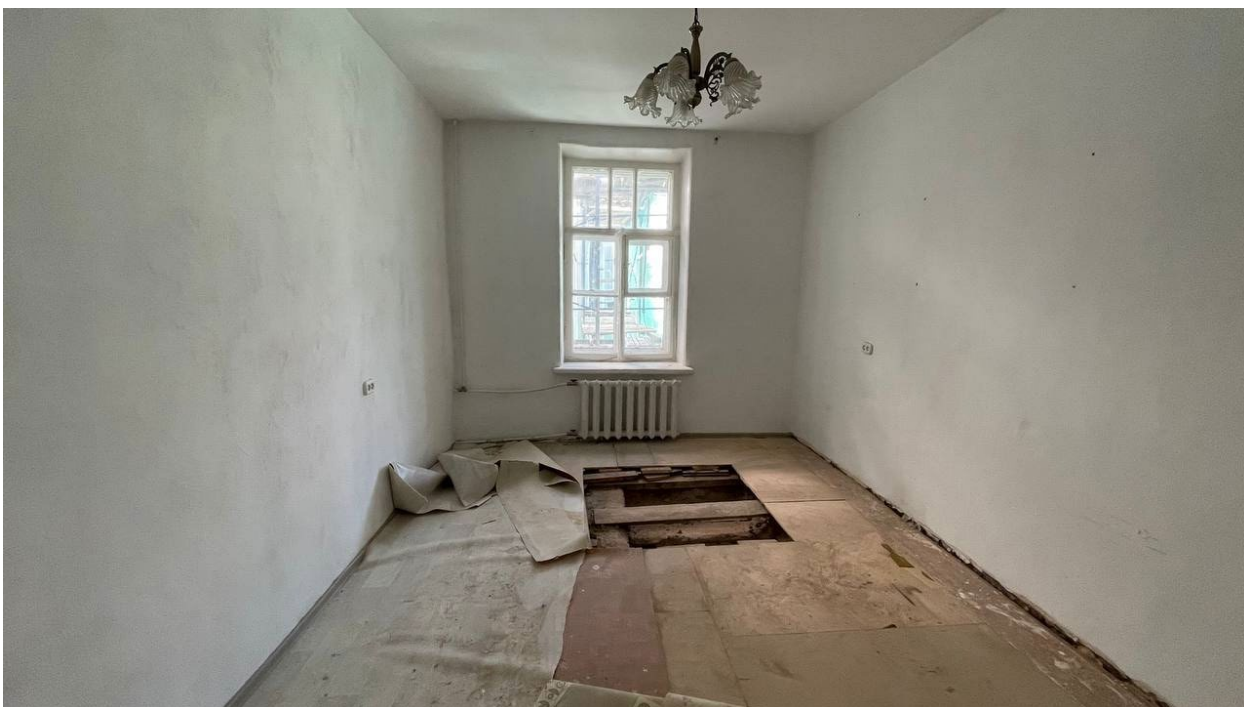
16. Фрагмент интерьера комнаты (помещение №8);
