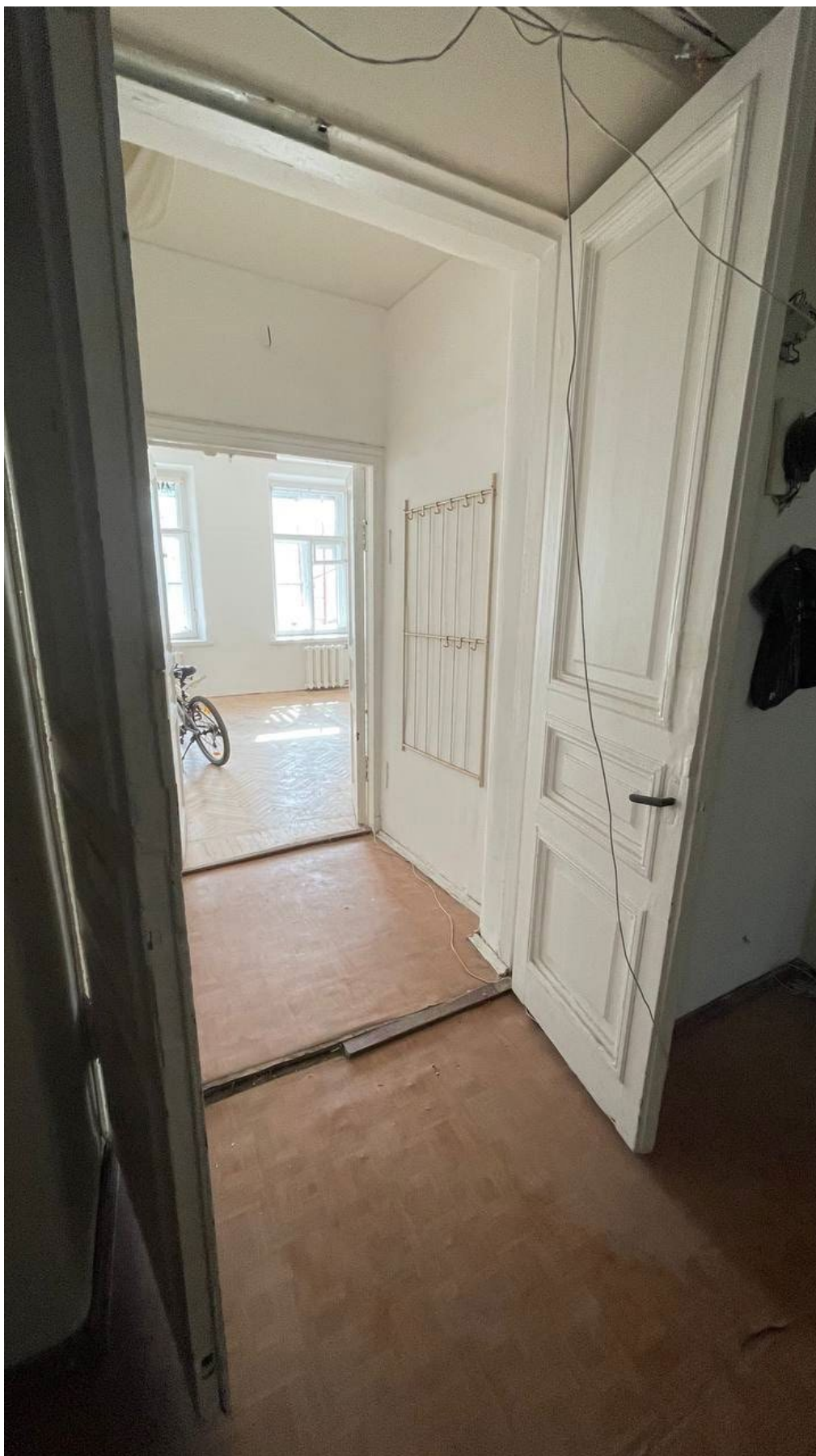
8. Вид на коридор (помещение №10);
