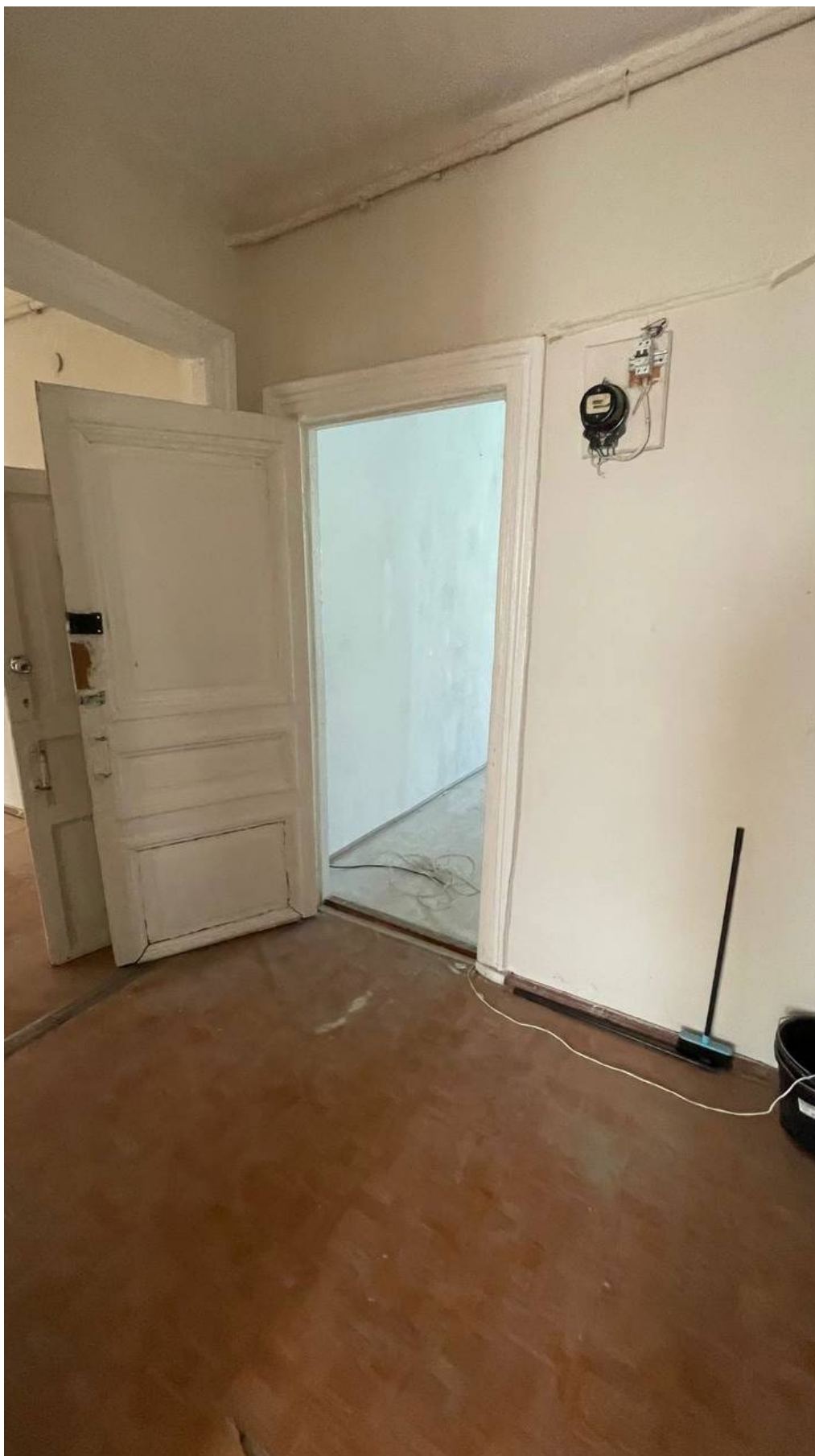
15. Фрагмент интерьера коридора, вход в помещение №8;
