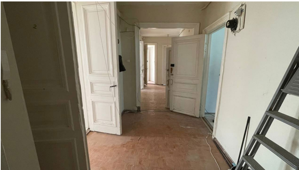
7. Вид на коридор (помещение №1);
