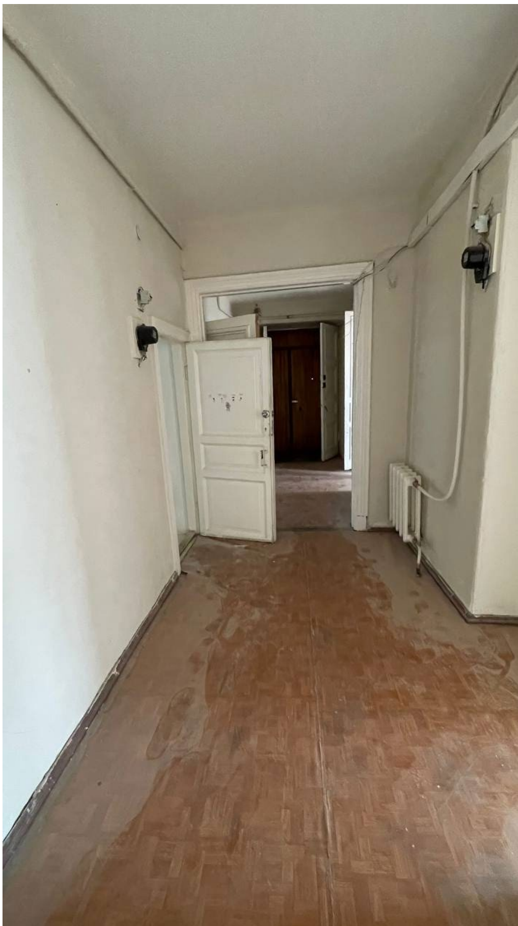
37. Вид на коридор (помещение №1).
