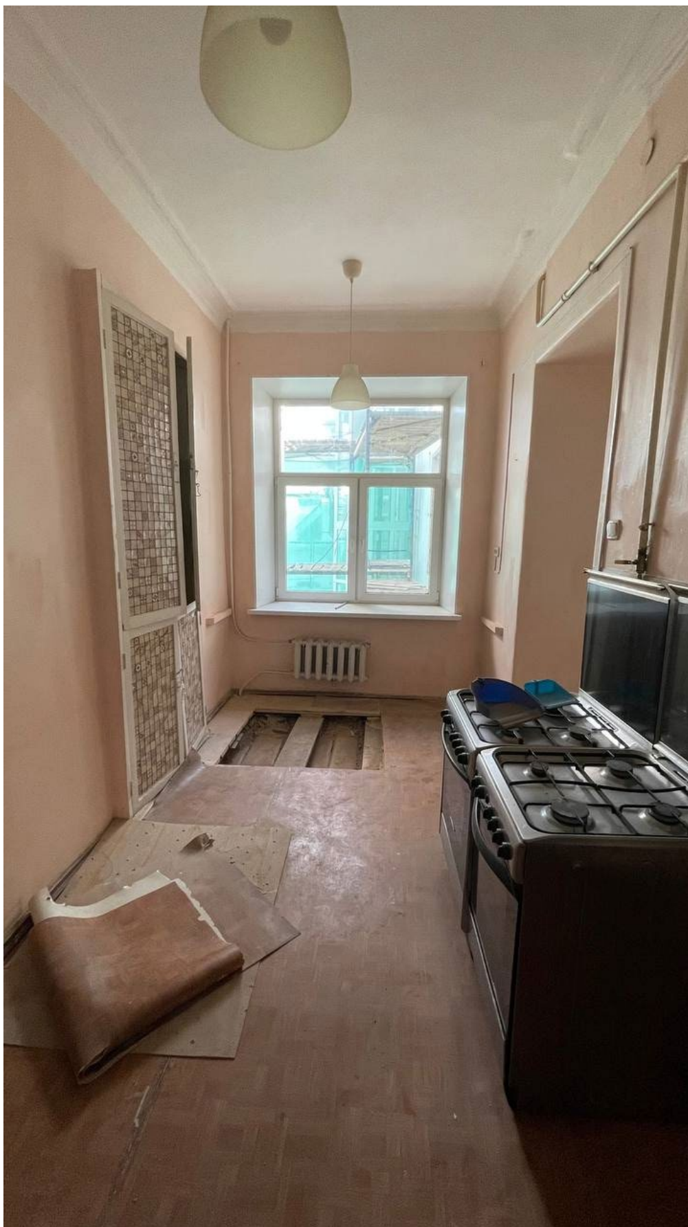
34. Фрагмент интерьера кухни (помещение №11);
