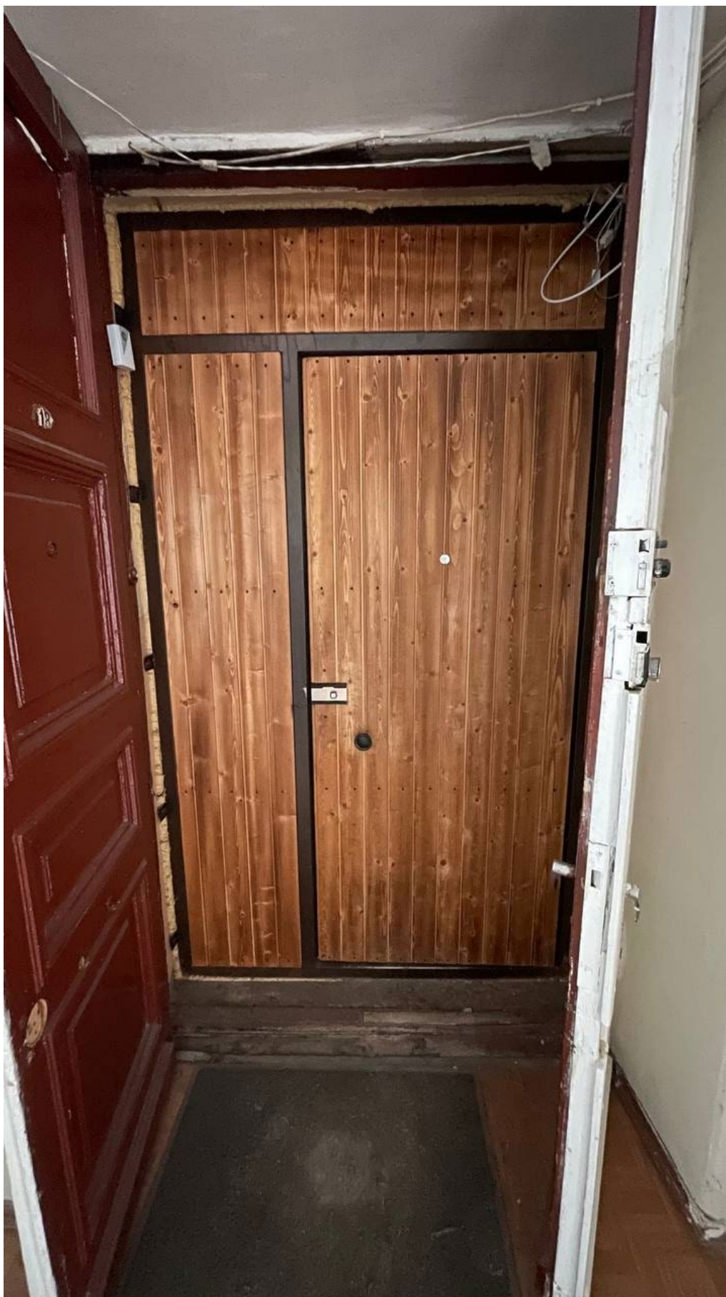
6. Вид на входную дверь в квартире;
