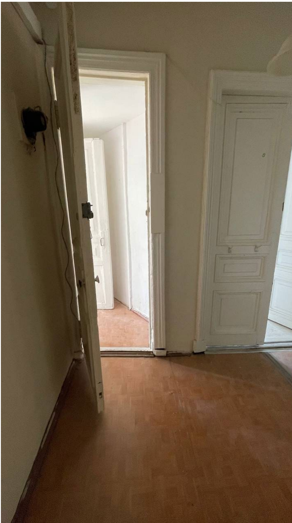
23. Фрагмент интеръера коридора (помещение №15);
