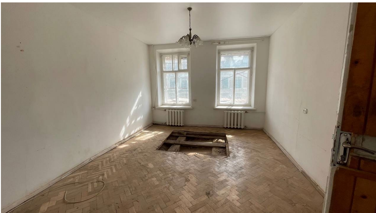
10. Фрагмент интерьера комнаты (помещение №2);
