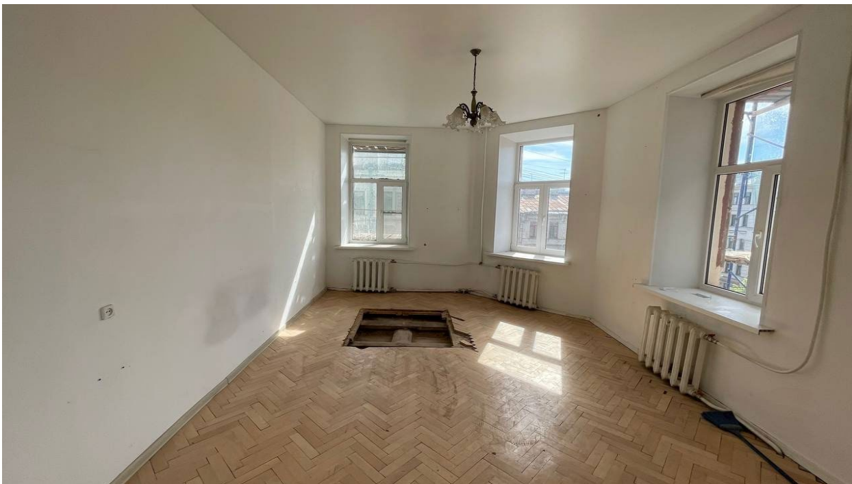
25. Фрагмент интерьера комнаты (помещение №5);
